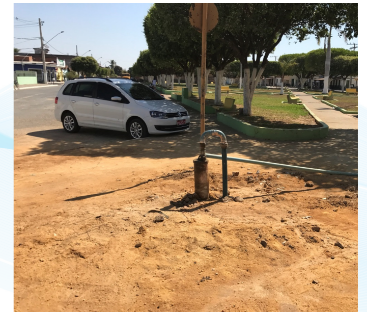
Figura 36 – Poço Praça Tubular – Operação Prefeitura de Ponto Chique Fonte: GESOIS, 2017
