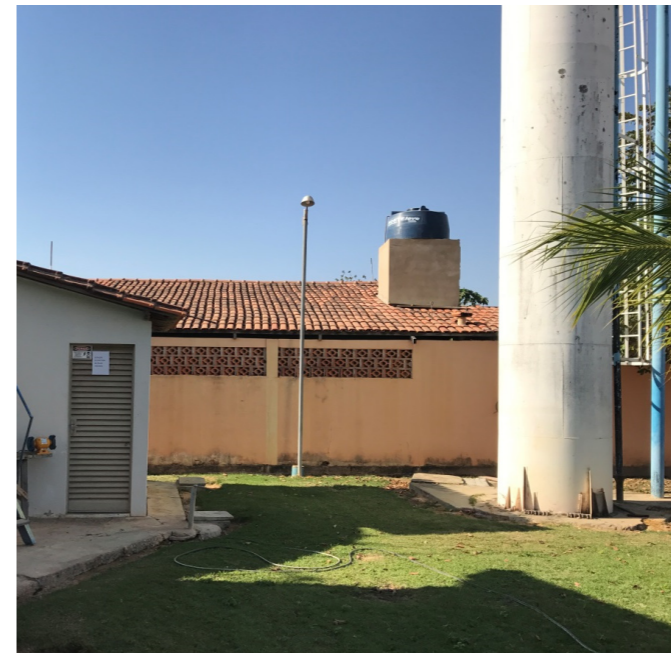
Figura 35 – Reservatório ETA na Sede Urbana de Ponto Chique Fonte: GESOIS, 2017
