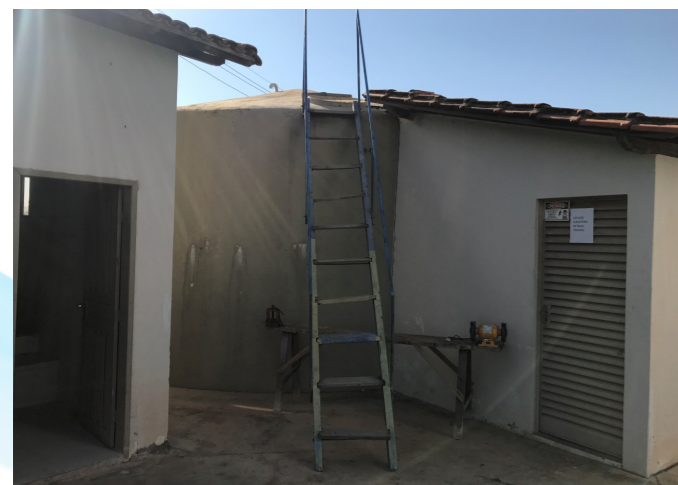
Figura 34 – Estação Elevatória de Água Tratada na Sede Urbana de Ponto Chique Fonte: GESOIS, 2017
