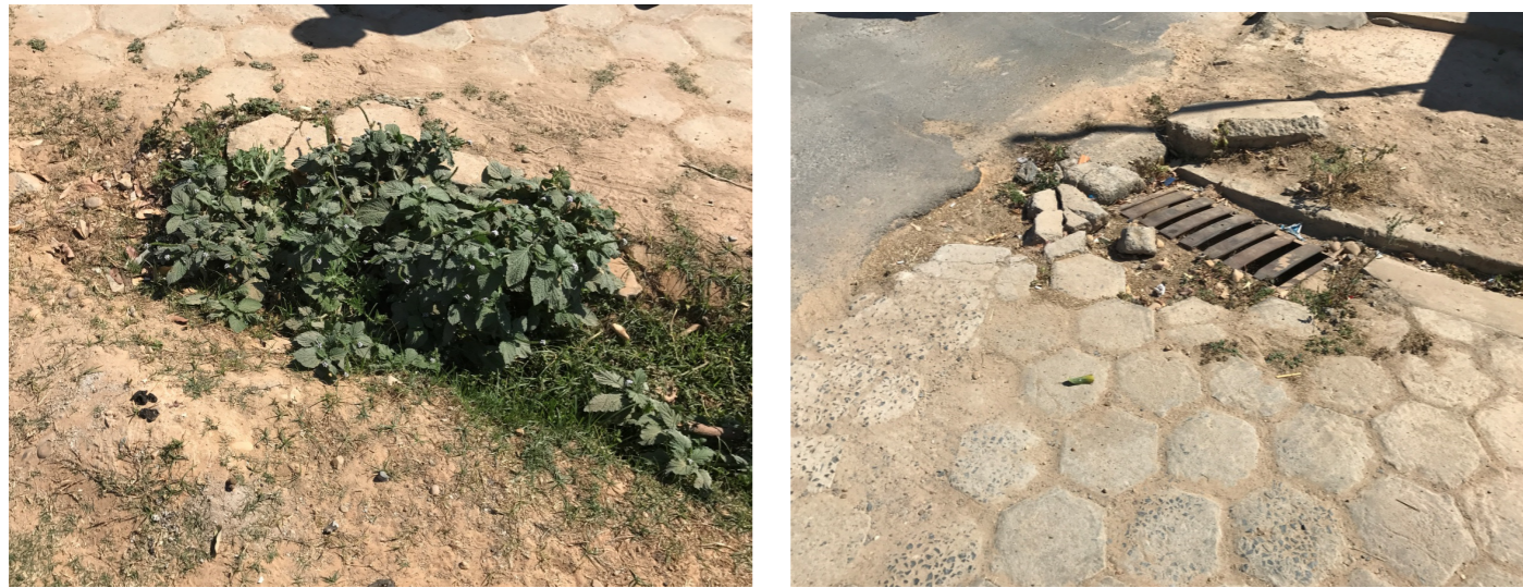
Figura 48 – Locais Necessitando de Capina em Ponto Chique Fonte: GESOIS, 2017
