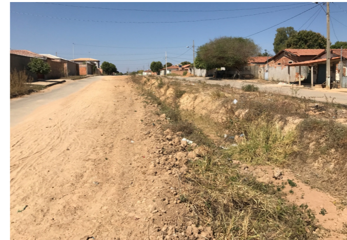
Figura 57 – Foto de Sarjetas sem Nenhuma Boca de Lobo em Ponto Chique Fonte: GESOIS, 2017
