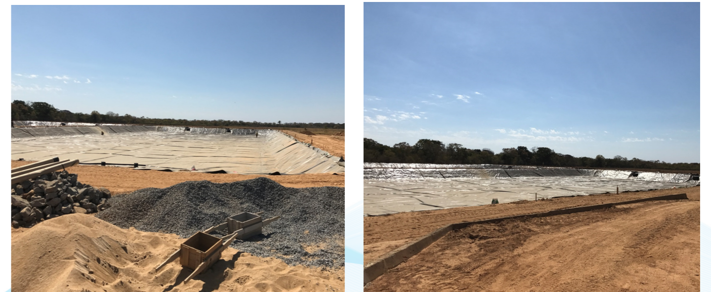
Figura 42 – Construção da Lagoa Facultativa da ETE em Ponto Chique Fonte: GESOIS, 2017
