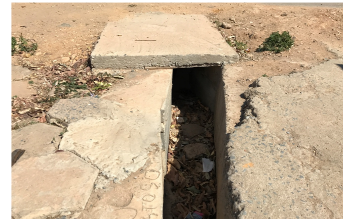
Figura 57 – Foto de Sarjetas sem Nenhuma Boca de Lobo em Ponto Chique Fonte: GESOIS, 2017
