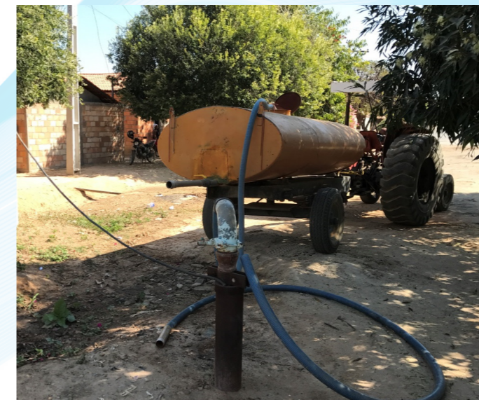
Figura 30 – Poço 05 na Sede Urbana de Ponto Chique Fonte: GESOIS, 2017
