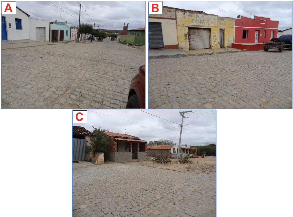
Figura 36 – Vista do sentido do escoamento (A), casas com muros de contenção (B) e área de alagamento (C).
