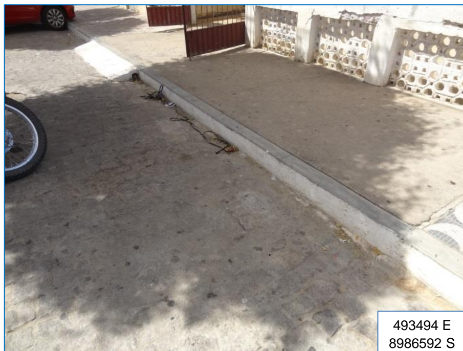
Figura 34 – Meio fio e sarjeta observados em Macururé. Fonte: EnvEx Engenharia e Consultoria (2017).
