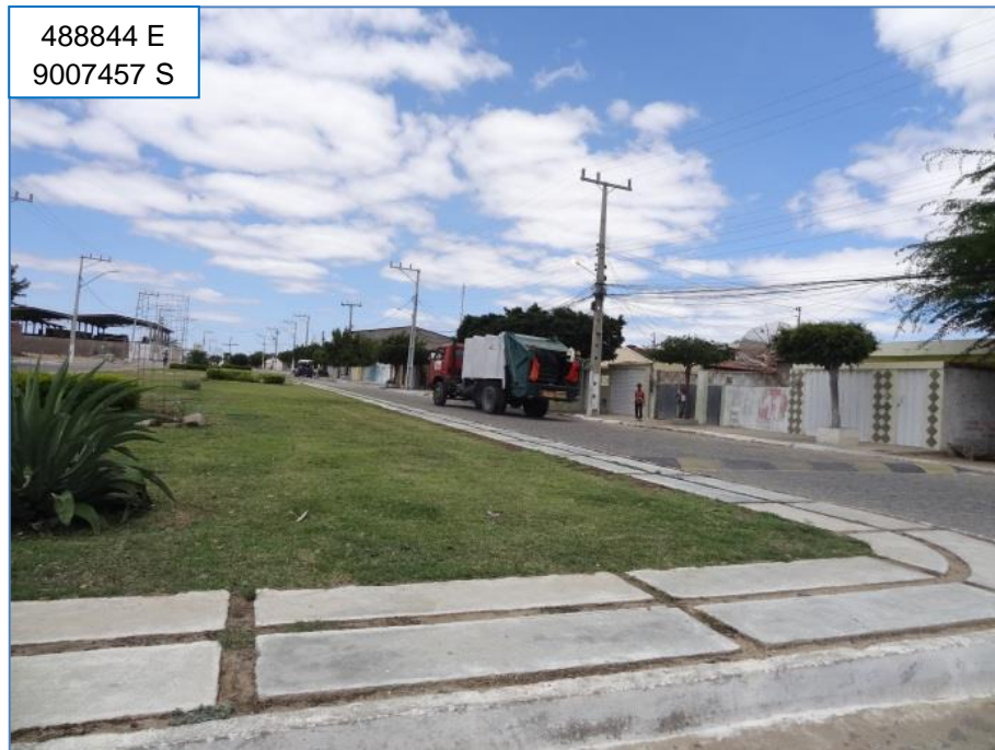
Figura 39 – Meio fio e sarjeta observados em Chorrochó. Fonte: EnvEx Engenharia e Consultoria (2017).
