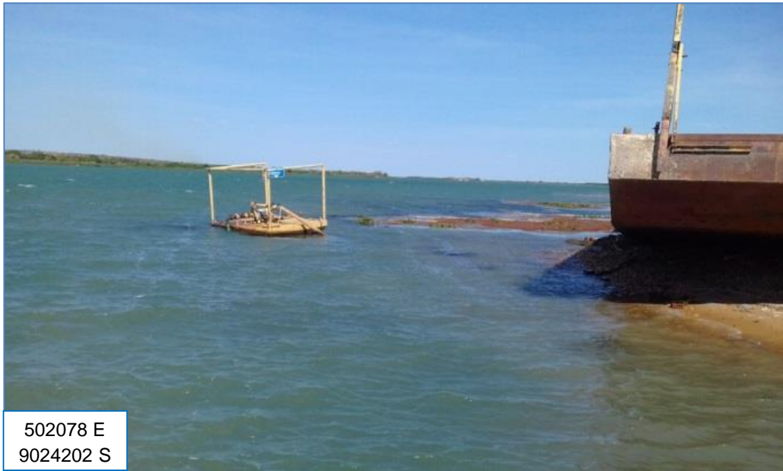
Figura 26 – Captação superficial no rio São Francisco. Fonte: EnvEx Engenharia e Consultoria (2017).
