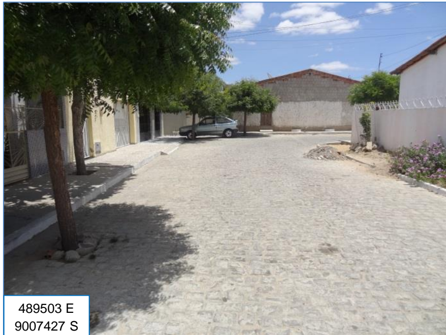
Figura 41 – Local de alagamento na sede municipal. Fonte: EnvEx Engenharia e Consultoria (2017).
