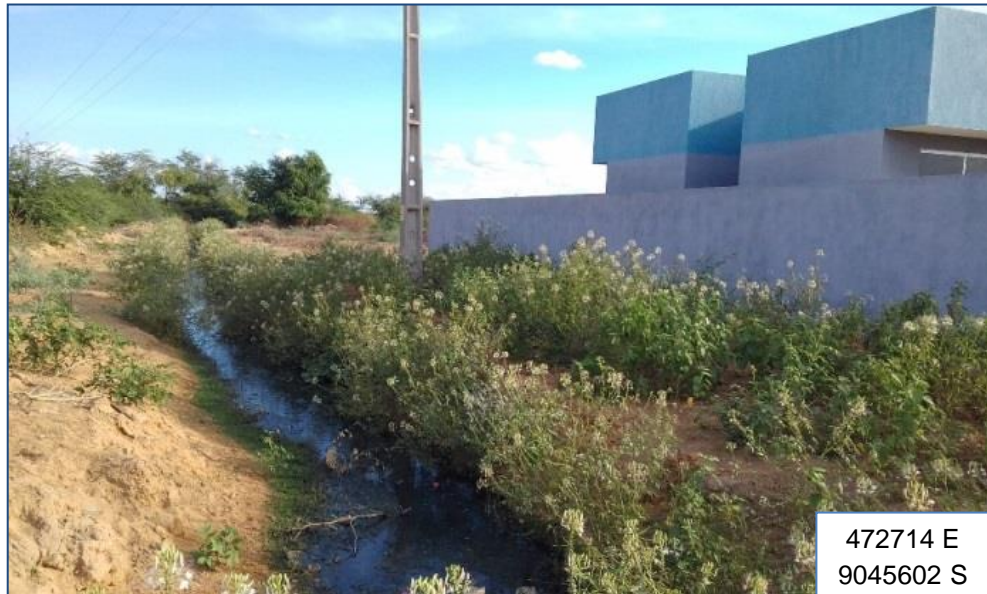
Esgoto lançado a céu aberto
