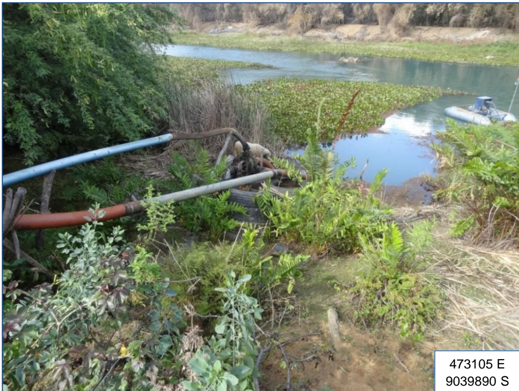
Figura 29 – Captação no rio São Francisco, com bomba equipada com mangote (ao lado da captação do PA Antonio Conselheiro). Fonte: Elaborado por EnvEx Engenharia e Consultoria (2018).
