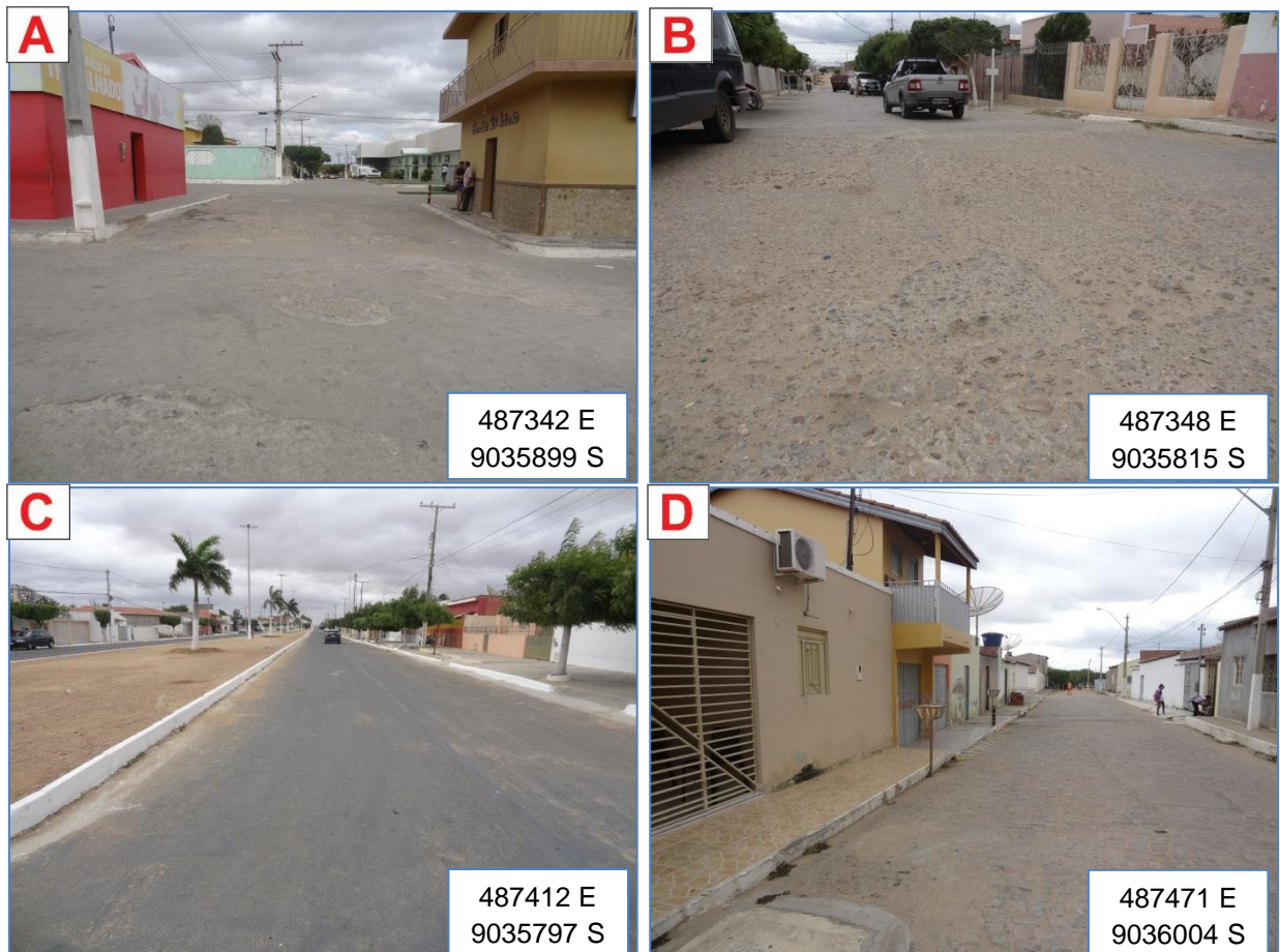
Figura 40 – Tipos de pavimento encontrados na sede. Concreto, rua Ministro Oliveira Brito (A) e rua Cônego Pascoal (B), asfalto, rua Edésio Tolentino (C) e pedra irregular, rua do Campo (D).
