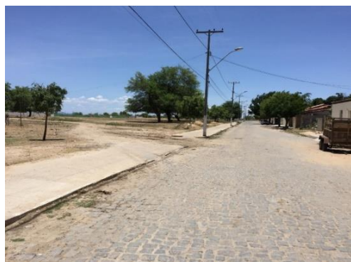
Figura 90 - Ponto de alagamento na Avenida Beira Lago
