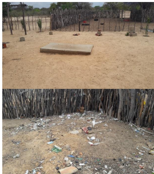
Figura 52 - Fossa rudimentar em moradia de Lagoinha (a); Sumidouro em Estacada (b)
