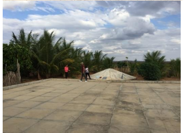
Figura 40 - Cisterna de armazenamento de água de chuva (a) e Cisterna calçada (b)
