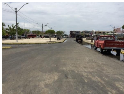
Figura 76 - Área sem dispositivos de microdrenagem, sede municipal
