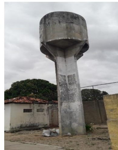
Figura 27 - Reservatório de compensação no centro (a); Reservatório de Novo Marcos
