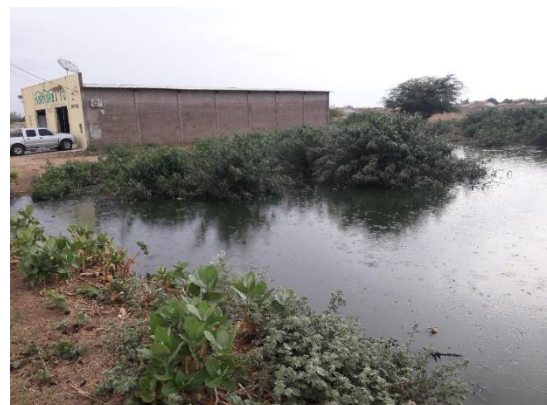
Figura 47 - Lagoa formada devido entupimento da rede que vem da Vila Santana
