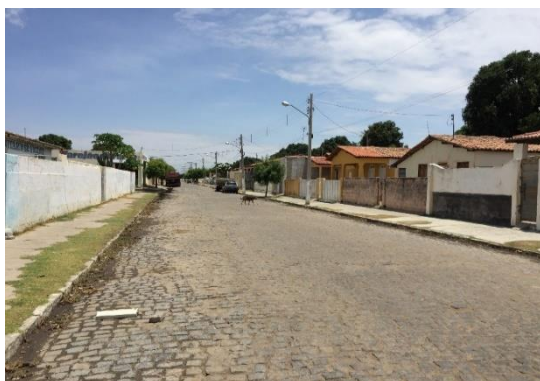
Figura 82 - Inexistência de sistema de microdrenagem na rua Coronel Francisco Leobas
