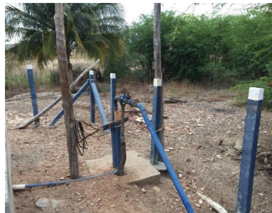
Figura 36 - Poço artesiano na localidade de Tamboril
