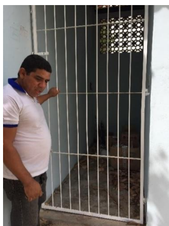
Figura 59 – Local de armazenamento dos RSS na vigilância sanitária
