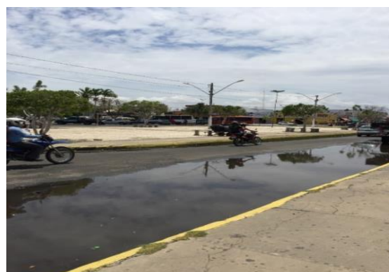
Figura 85 - Ponto de alagamento na rua do mercado (Praça Central) – alagamento em toda via
