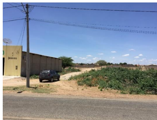
Figura 87 - Ponto de alagamento ao lado da marmoraria, destaque para área com esgoto a céu aberto
