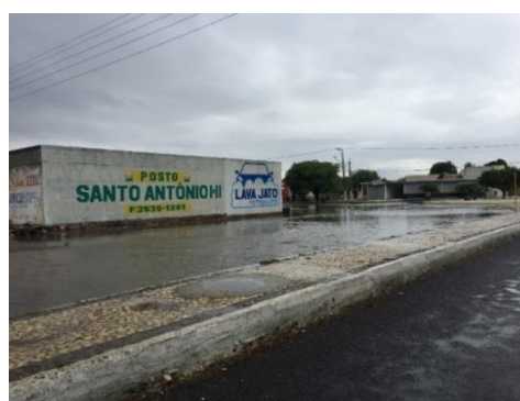
Figura 93 - Ponto de alagamento na Avenida Piauí próximo a rotatória que dá acesso à rodoviária
