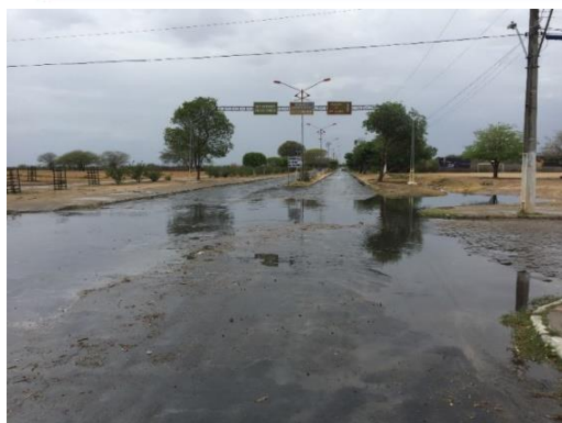
Figura 89 - Ponto de alagamento entre as vias Av. Beira Lago e Av. Manoel Amâncio Coelho
