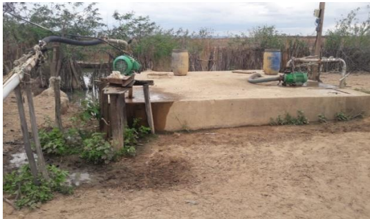
Figura 34- Reservatório semienterrado em Malhadinha
