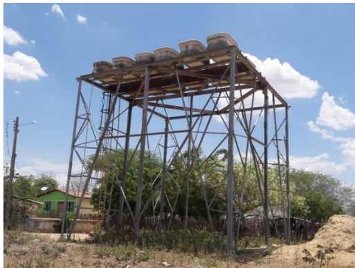
Figura 38- Reservatórios de água tratada na localidade de Vila Aparecida
