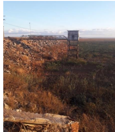
Figura 21 - Vista atual do ponto de captação do cais
