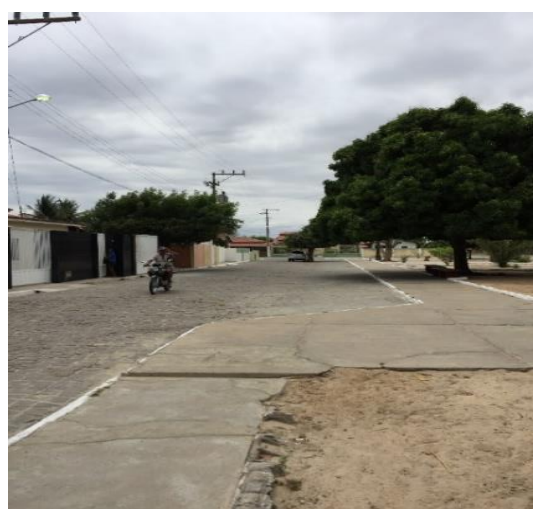
Figura 77 - Área sem dispositivos de microdrenagem em Novo Marcos
