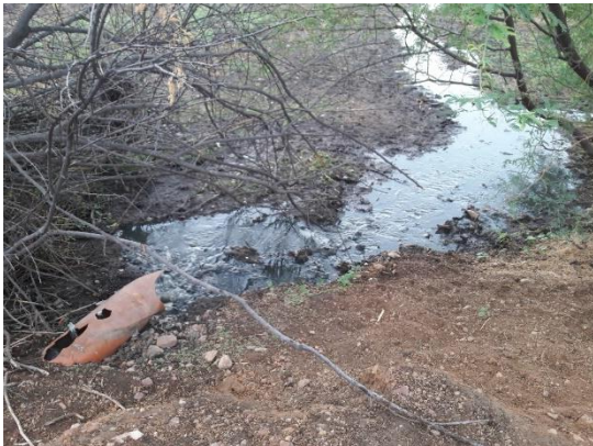
Figura 48 - Chegada do efluente bruto na lagoa de Remanso
