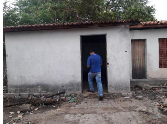
Figura 45- Estação elevatória de esgoto 1 receptora do esgoto das outras duas estações
