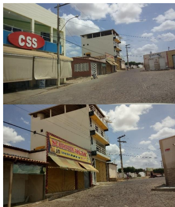
Figura 53 – Grandes geradores de resíduos na sede do município de Presidente Dutra
