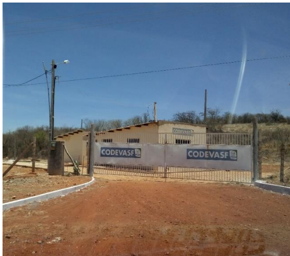
Figura 64 – Entrada principal do aterro sanitário no município de Irecê/BA
