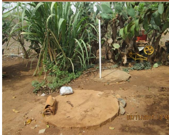
Figura 31 – Fossa rudimentar em domicílio na localidade de Bernardes; Fossa rudimentar e sumidouro em domicílio na localidade de Sapecado
