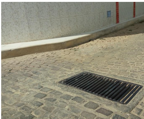
Figura 68 - Bueiro de captação de águas pluviais localizado a jusante do Açude
