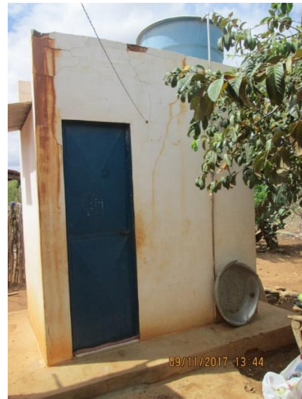
Figura 34 – Banheiro construído pela Associação de Moradores de Queimada e Sapecado, em Sapecado
