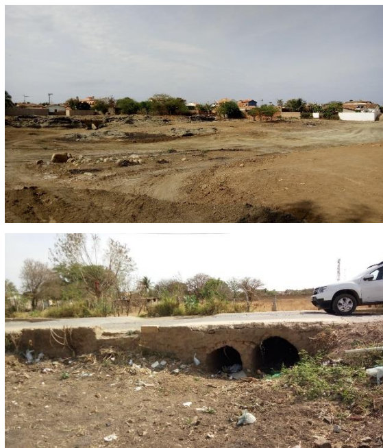
Figura 67 - Área da Lagoa Grande com intenso processo de acumulação de sedimentos; Manilhas de saída das águas pluviais da Lagoa Grande
