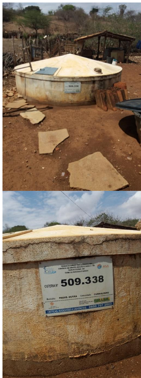
Figura 28 – Cisterna construída pelo P1MC e placa de identificação em Curralinho
