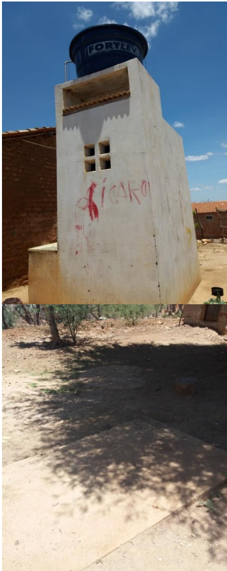
Figura 33 – Banheiro, tanque séptico e sumidouro instalados pela CODEVASF, em Riachinho
