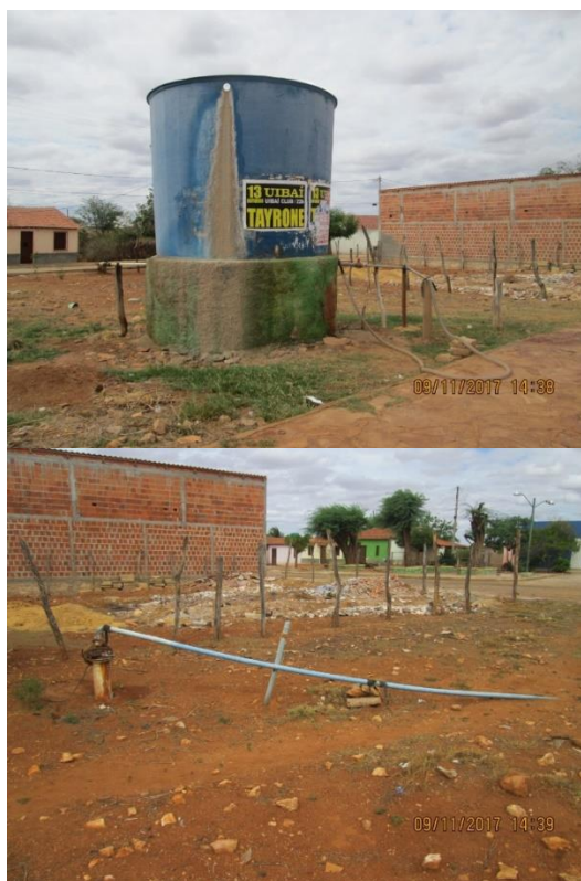
Figura 26 – Reservatório e poço artesiano da Prefeitura em Baixa Verde Fonte: Projeta Engenharia (2017)
