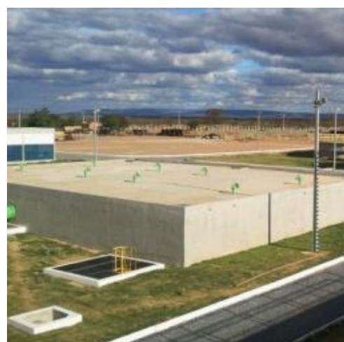
Figura 19 – ETA Ibititá Fonte: EMBASA (2017)
