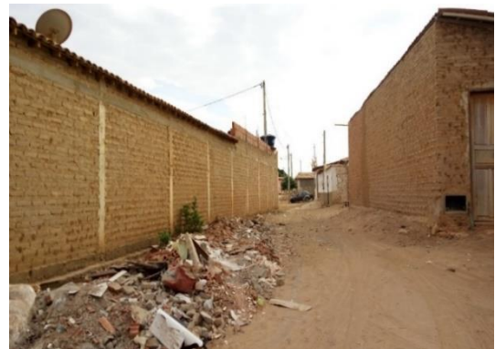
Figura 45 – RCC descartado em via pública na sede do município de Presidente Dutra Fonte: Projeta Engenharia (2017)
