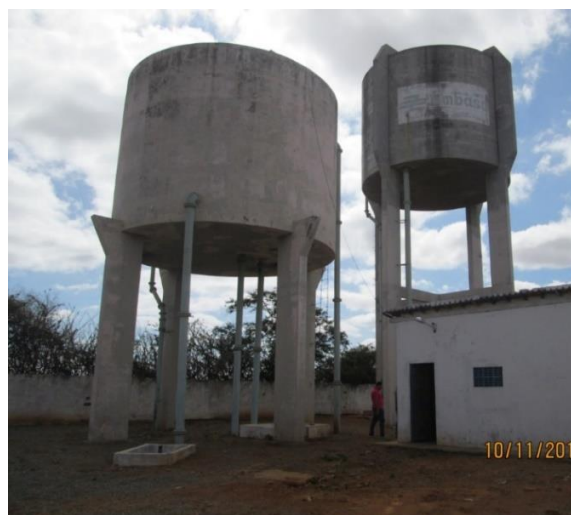
Figura 22 – Reservatório à direita distribui água para a sede e reservatório à esquerda distribui água para o reservatório de Sapecado Fonte: Projeta Engenharia (2017)
