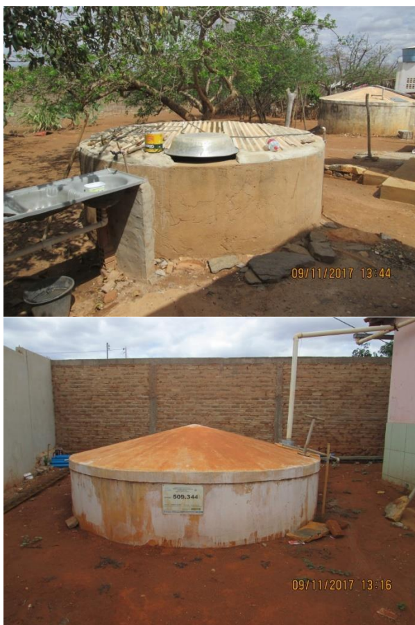
Figura 27 – Cisterna construída por antigo morador em Sapecado e cisterna construída pelo P1MC em Bernardes
