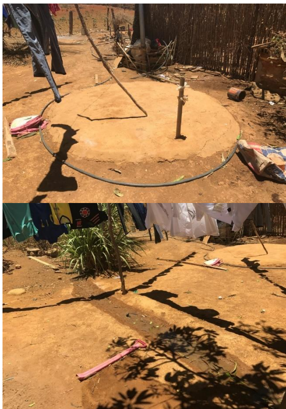
Figura 46 - Fossa negra; águas servidas lançada diretamente no solo
