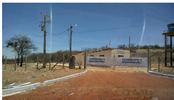
Figura 76 – Entrada principal do aterro sanitário no município de Irecê/BA
