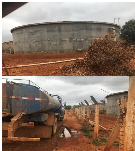
Figura 30 - Reservatório água tratada EMBASA e abastecimento do caminhão pipa
