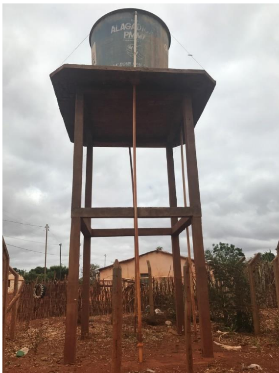
Figura 31 - Reservatório de água salobra do poço – Alagadiço/Mulungu
