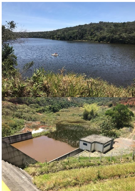
Figura 24 – Captação flutuante (a) e Barragem de nível (b)
