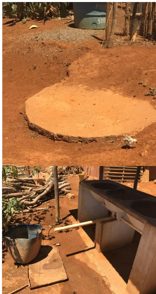
Figura 47 - Fossa negra da residência; Sistema de coleta de águas servidas para reutilização
