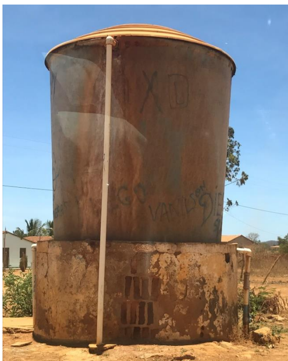
Figura 43– Reservatório de água salobra – Espia/Mulungu
