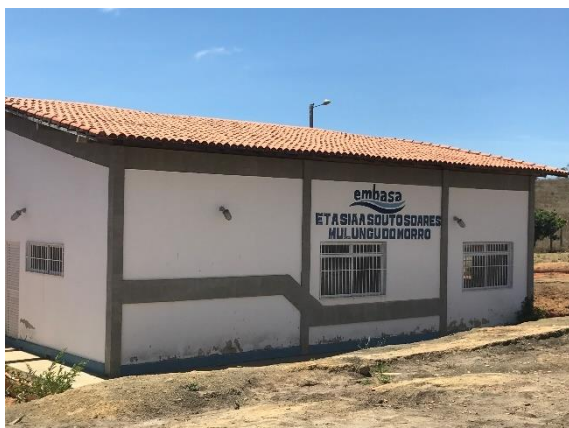
Figura 25– Estação Tratamento de Água Bruta (ETA) Mulungu e Souto Soares
