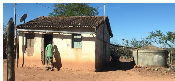
Figura 29 - Sistema de coleta de água do telhado – Mulungu do Morro
