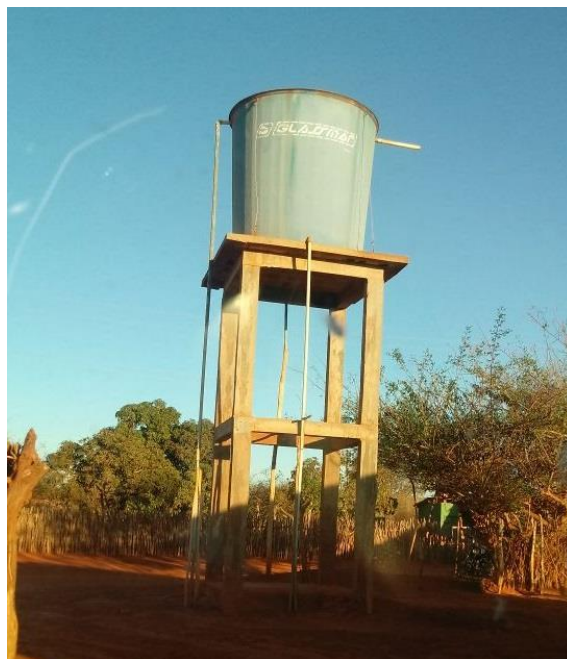
Figura 40 – Reservatório de água salobra - Lagoa Nova/Mulungu
