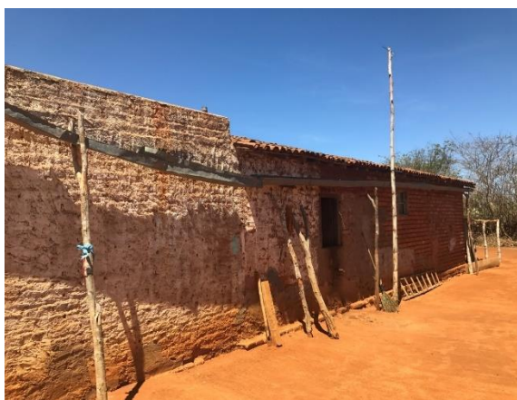
Figura 34 – Sistema rudimentar coleta de água de chuva – Alagadiço/Mulungu
