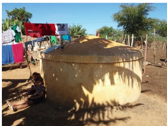
Figura 27 – Cisterna construída pela Prefeitura de Lapão em Aroeira
