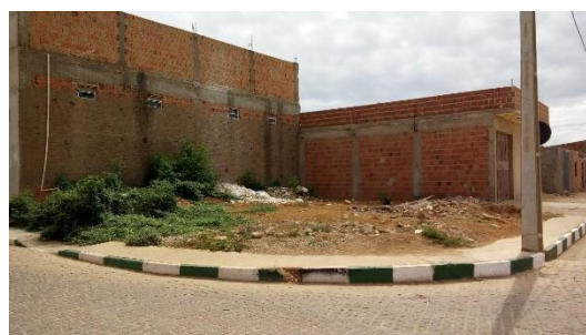
Figura 46 – RCC descartados no Distrito de Aguada Nova Fonte: Projeta Engenharia (2017)
