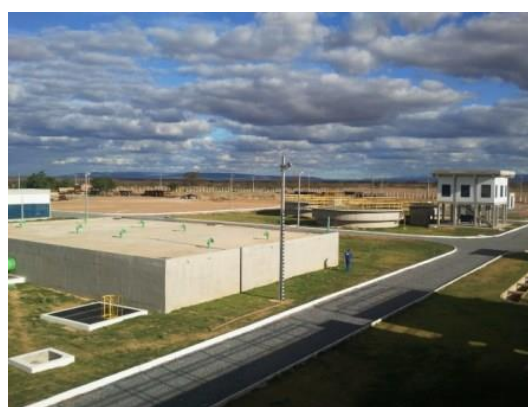
Figura 21 – Estação de Tratamento de Água Ibititá
