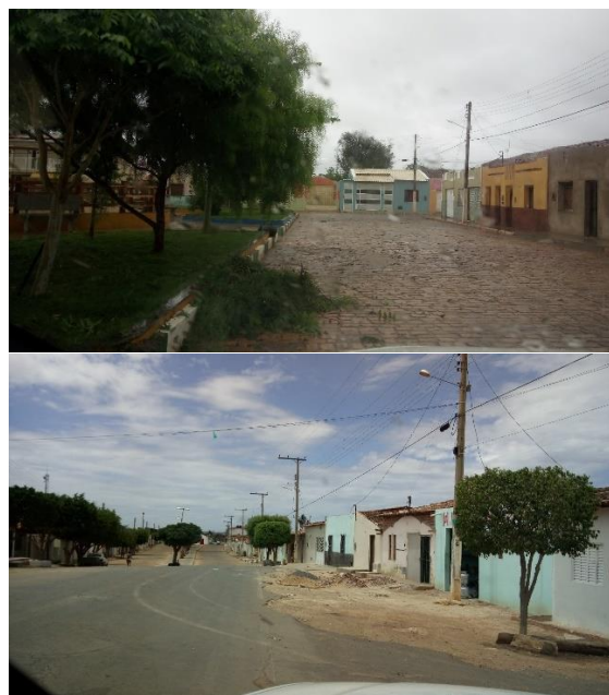
Figura 66 – Tipo de pavimentação no município de Lapão: Calçamento poliédrico (a) e asfalto (b)
