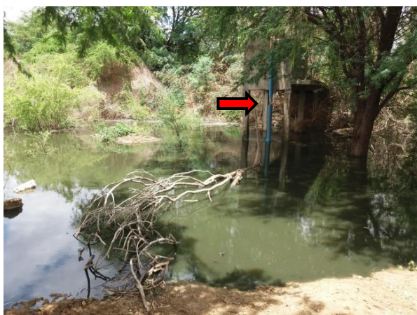
Figura 33 – Emissário rompido na lagoa formada por vazamento dos efluentes (esquerda); Lagoa Facultativa 1 (direita), na ETE da sede de Lapão
