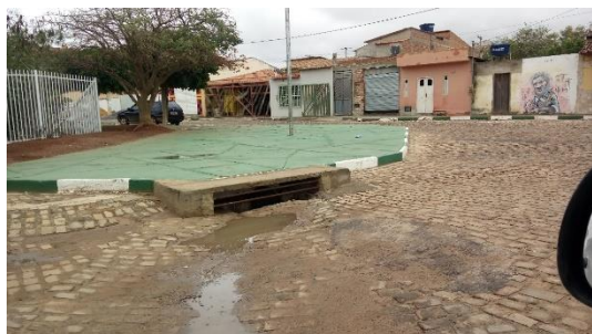
Figura 69 – Boca de lobo Fonte: Projeta Engenharia (2017)
