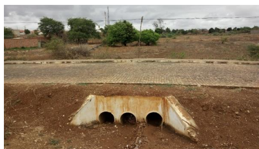
Figura 68 – Bueiro para passagem de água Fonte: Projeta Engenharia (2017)
