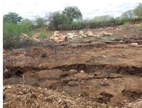
Figura 76 – Área identificada com processo erosivo, na sede municipal Fonte: Projeta Engenharia (2017)
