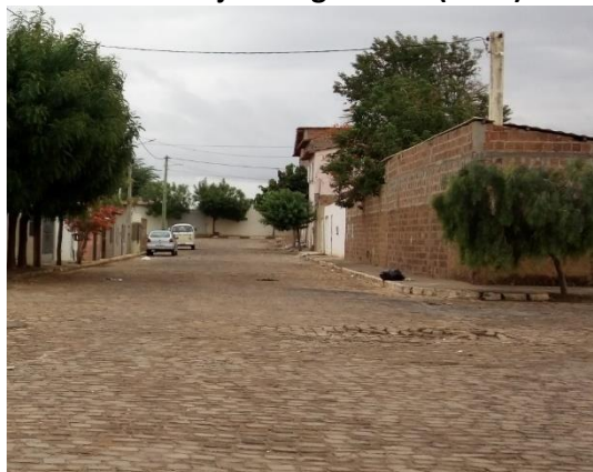
Figura 70 – Rua sem dispositivos de microdrenagem Fonte: Projeta Engenharia (2017)
