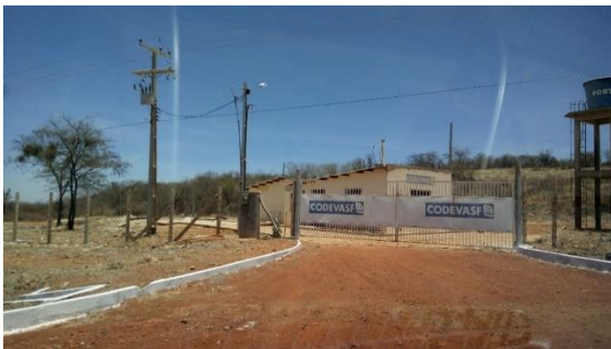
Figura 5-46 – Entrada principal do aterro sanitário no município de Irecê/BA
