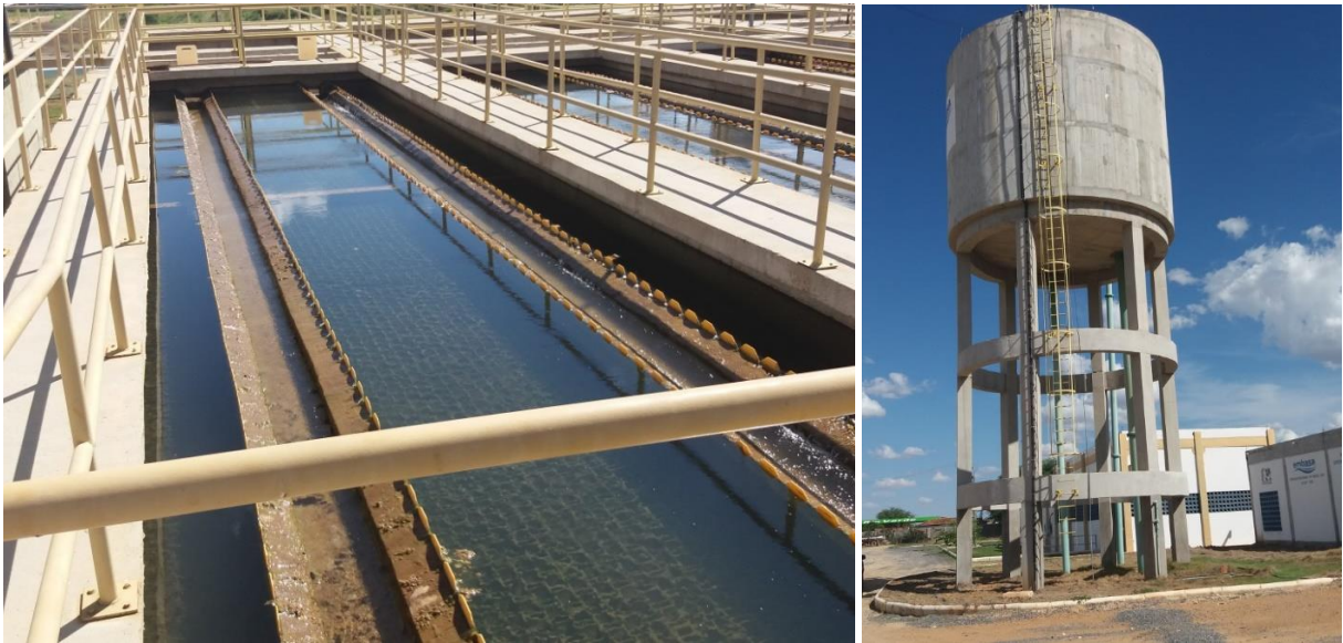
Figura 5-6 – Decantador (à esquerda) e reservatório de uso geral (à direita) da ETA Rio Verde
