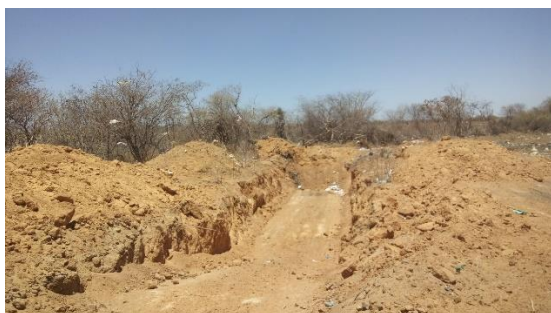
Figura 5-39 – Abertura de nova vala para recobrimento de resíduos no lixão municipal de Itaguaçu da Bahia Fonte: Projeta Engenharia (2017)
