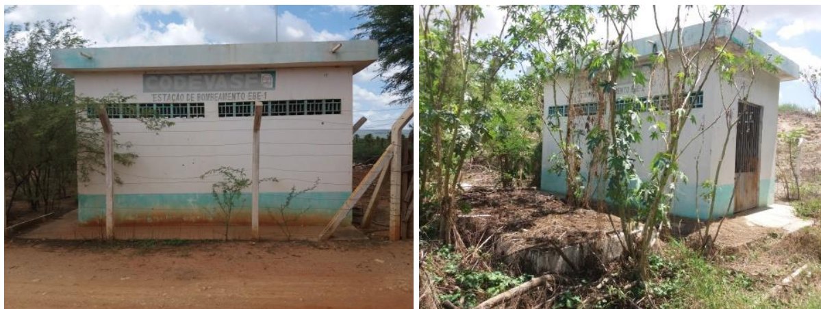
Figura 5-18 – Estação Elevatória EBE-1 (à esquerda) e Estação Elevatória EBE-2 (à direita) na sede de Itaguaçu da Bahia.
