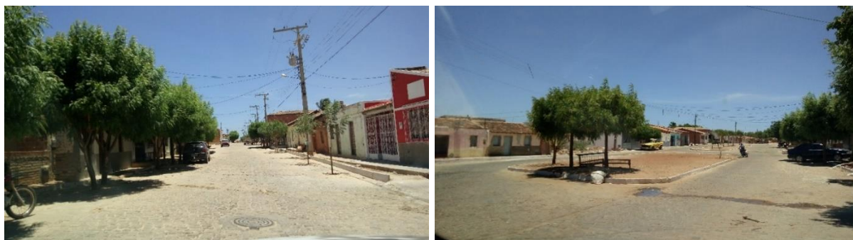
Figura 5-48 - Áreas sem dispositivos de microdrenagem na sede municipal
