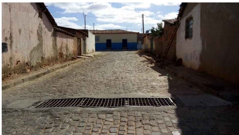
Figura 5-49 - Boca de lobo utilizada no controle da velocidade da água vinda da parte alta do Município
