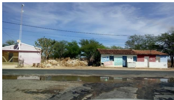
Figura 5-55 - Ponto de Alagamento atrás do posto de gasolina no Distrito de Rio Verde 1
