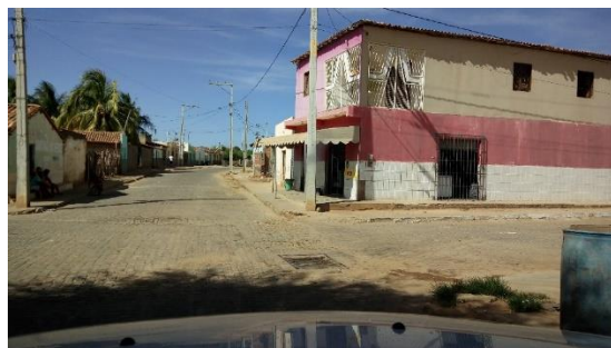
Figura 5-54 – Dispositivo de microdrenagem na localidade de Rio Verde II, próximo à rodovia BA-052.
