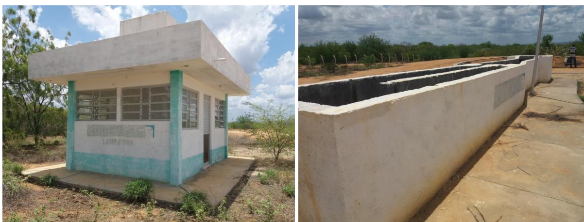
Figura 5-19 – Estrutura do Laboratório do SES (à esquerda) e caixa de areia e calha parshall da ETE (à direita), na sede de Itaguaçu da Bahia
