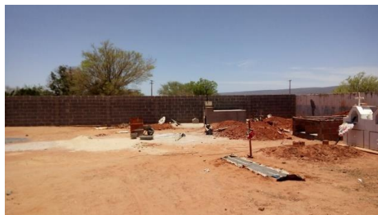
Figura 5-33 – Resíduos gerados no cemitério municipal da sede de Itaguaçu da Bahia
