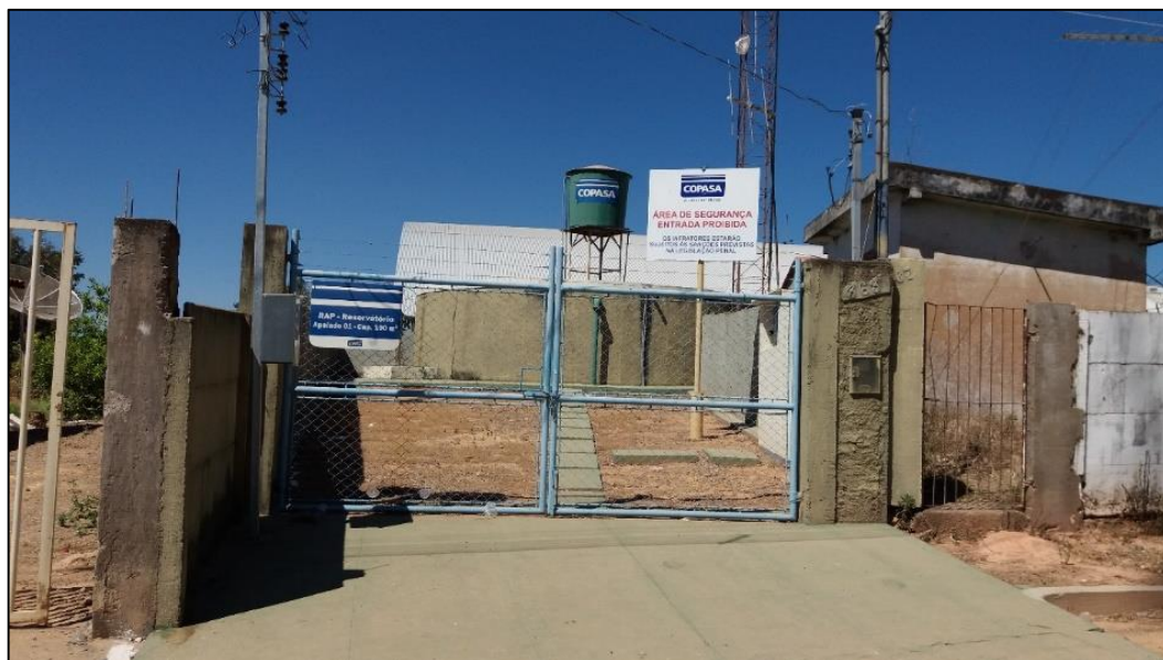
Figura 63: Local dos reservatórios para atender a sede
