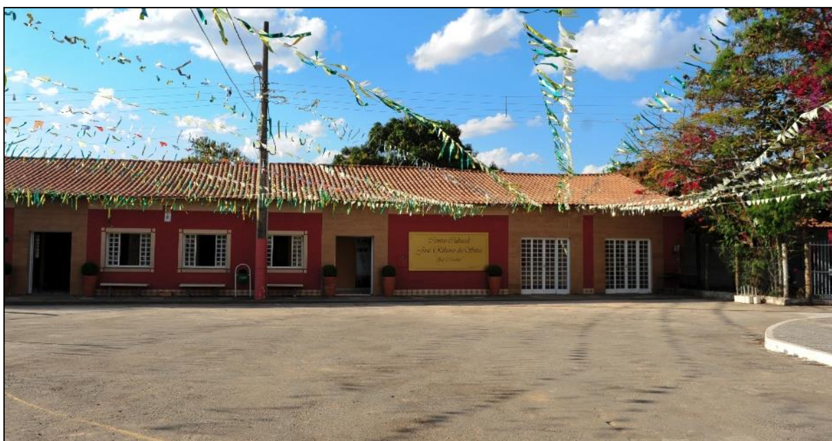
Figura 10: Vista do Centro Cultural
