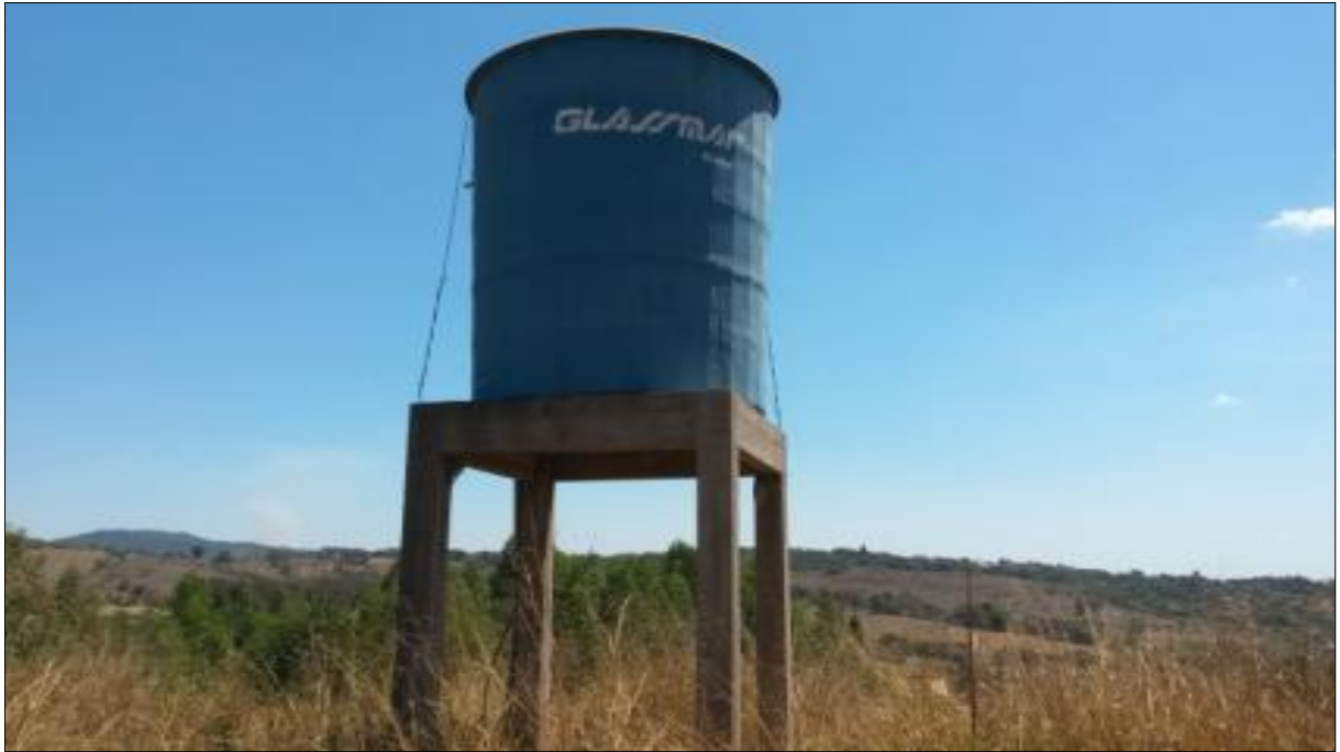
Figura 97: Reservatório de água - comunidade Costas
