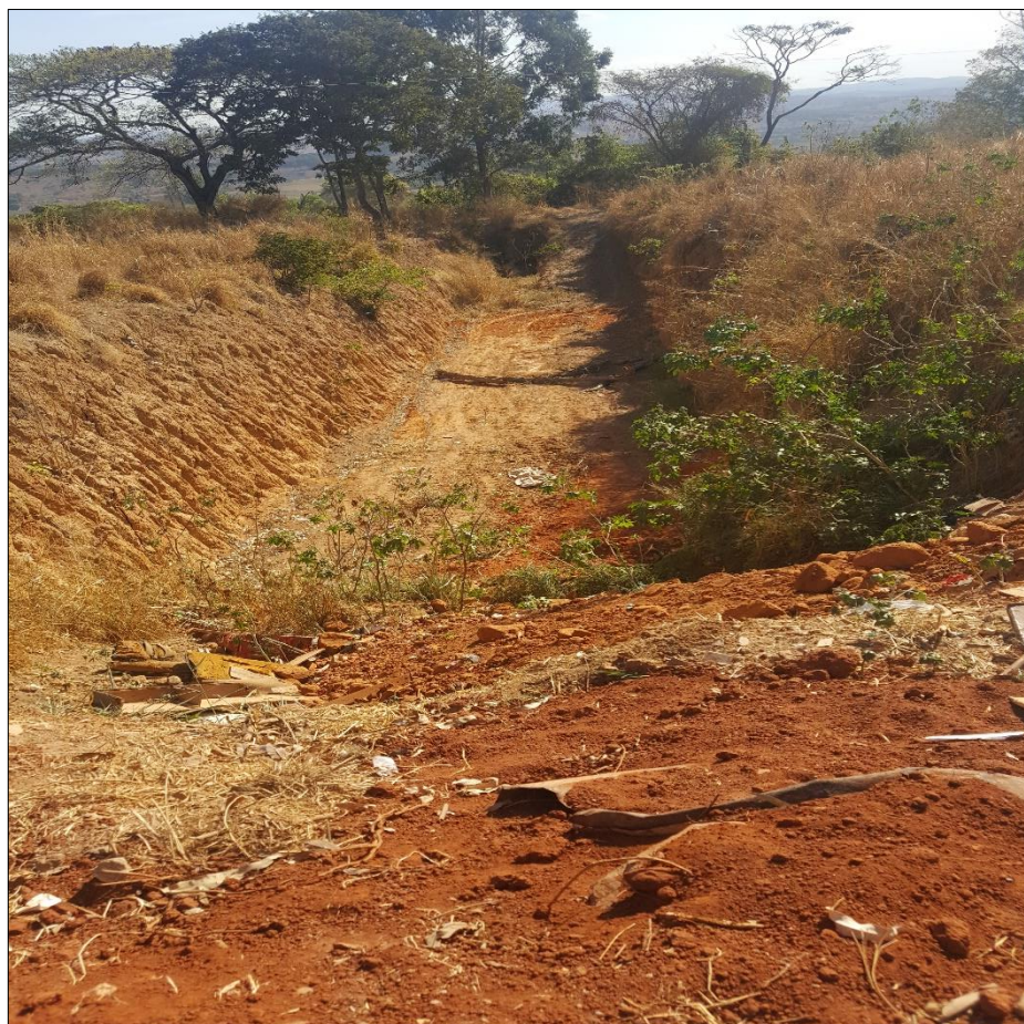
Figura 159: Vala de rejeitos
