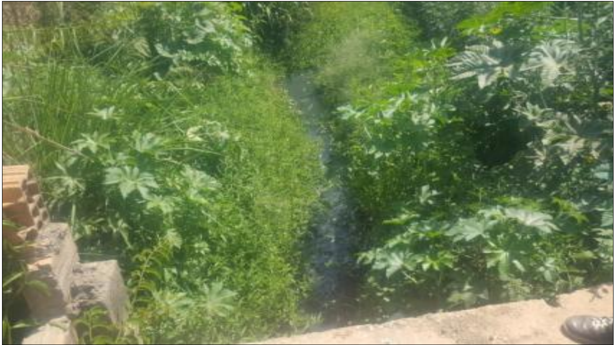
Figura 180: Córrego receptor da drenagem pluvial, passando nos quintais das casas.
