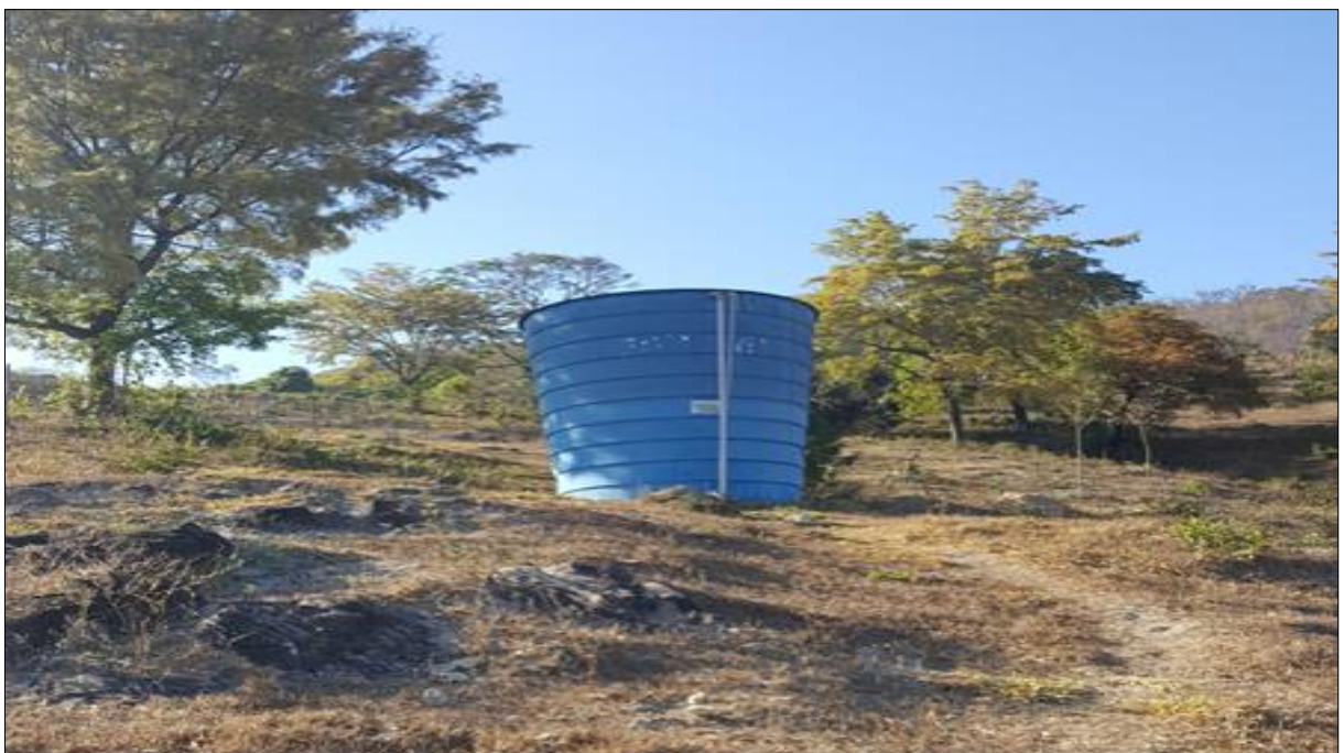
Figura 99: Reservatório de água – comunidade Joaquim Rodrigues 1
