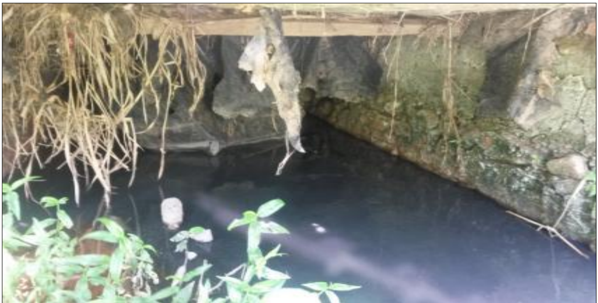
Figura 116: Galeria de drenagem pluvial com esgoto na rua Joaquim Pinto Lara
