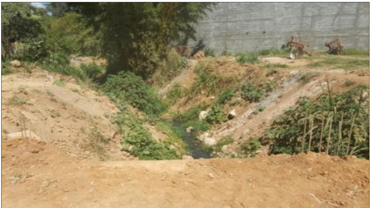
Figura 181: Córrego receptor da drenagem pluvial, passando nos quintais das casas.
