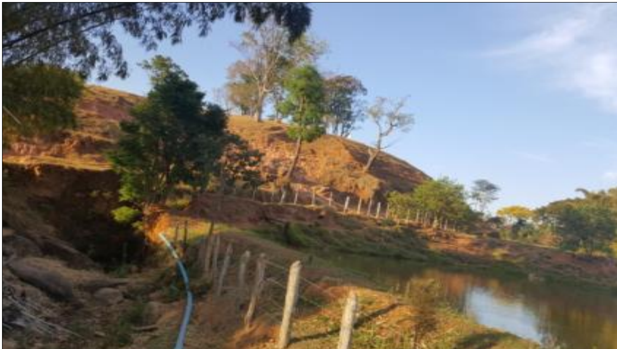
Figura 66: Captação na comunidade Laje – Foto 1
