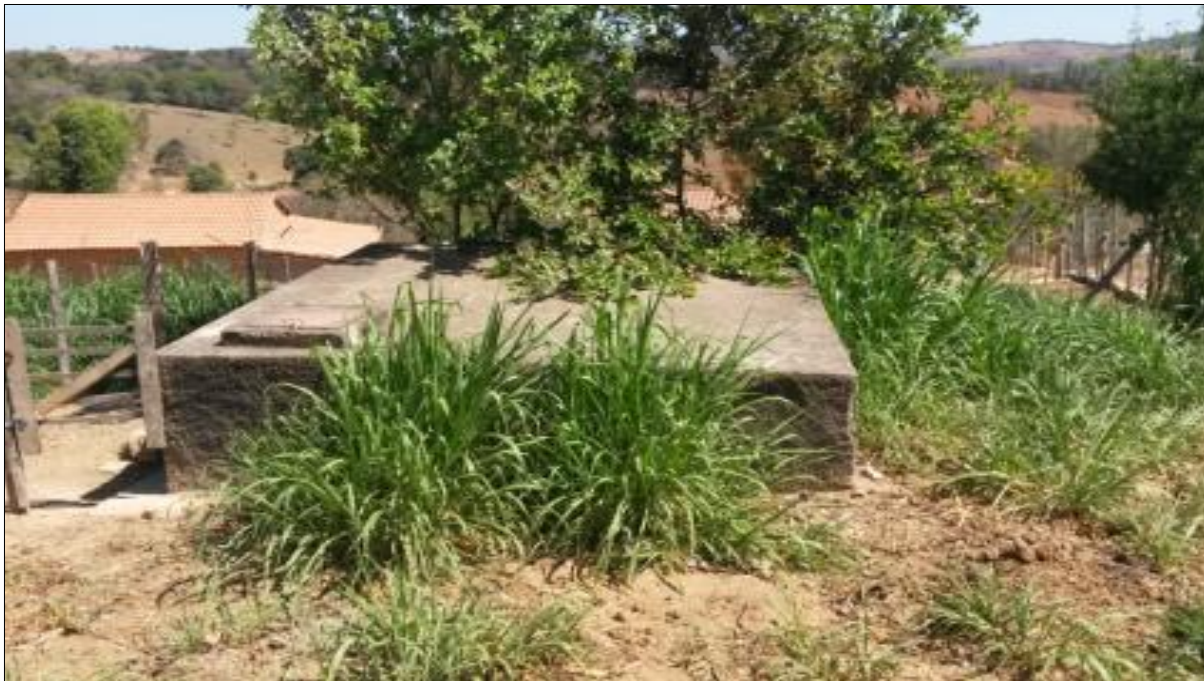
Figura 106: Reservatório de água - comunidade Tatu
