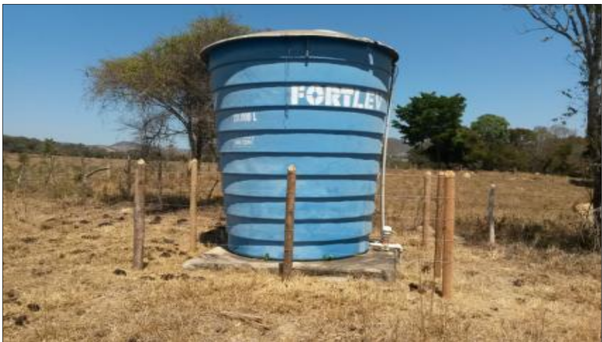
Figura 91: Reservatório - comunidade Aguada
