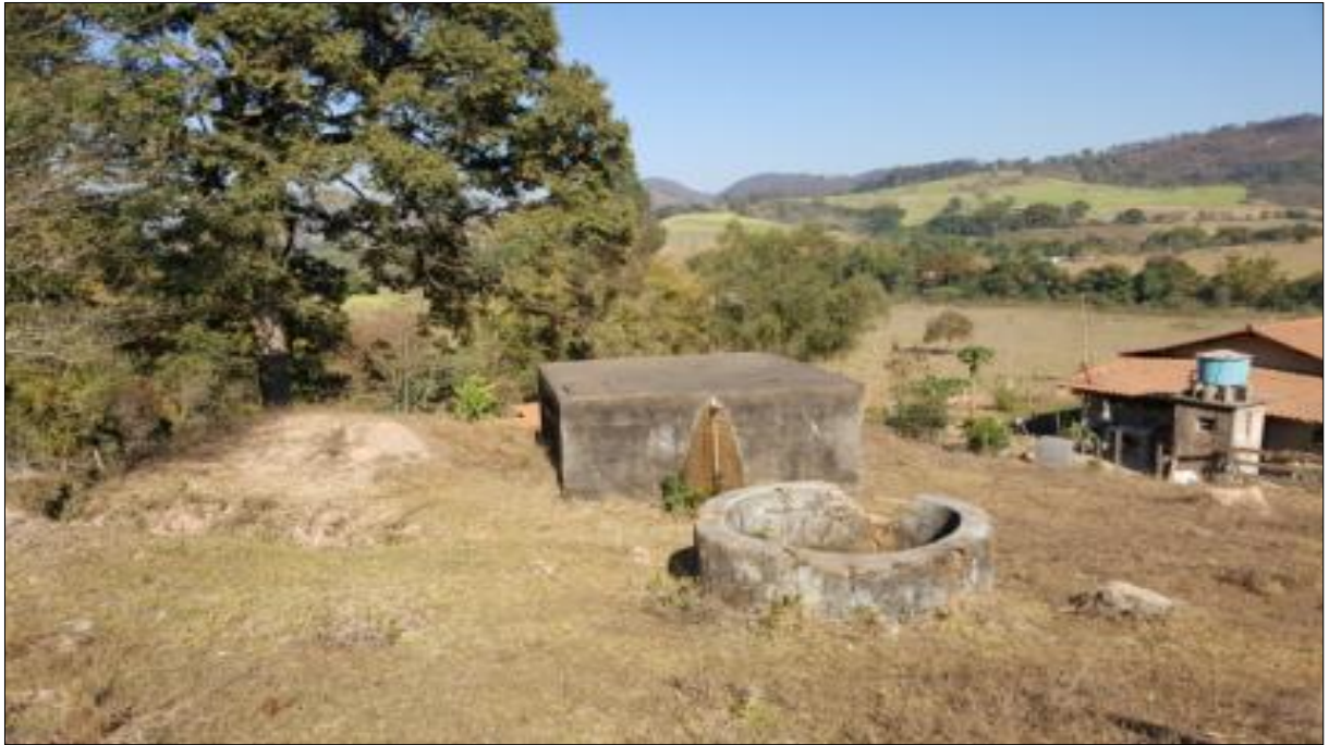
Figura 100: Reservatório de água – comunidade Joaquim Rodrigues 2
