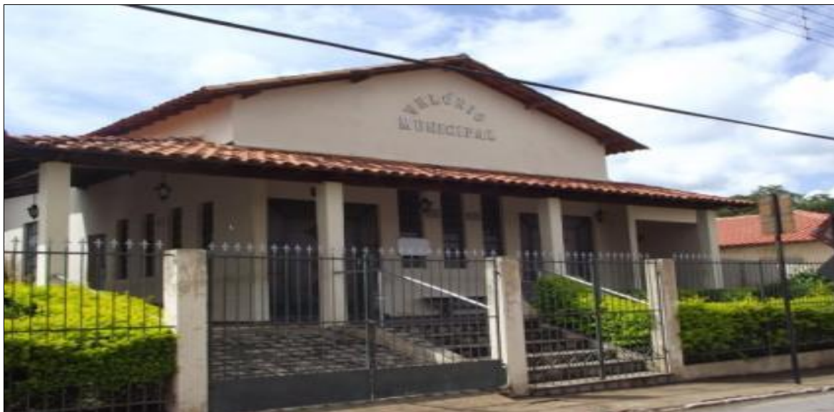
Figura 57: Capela velório municipal
