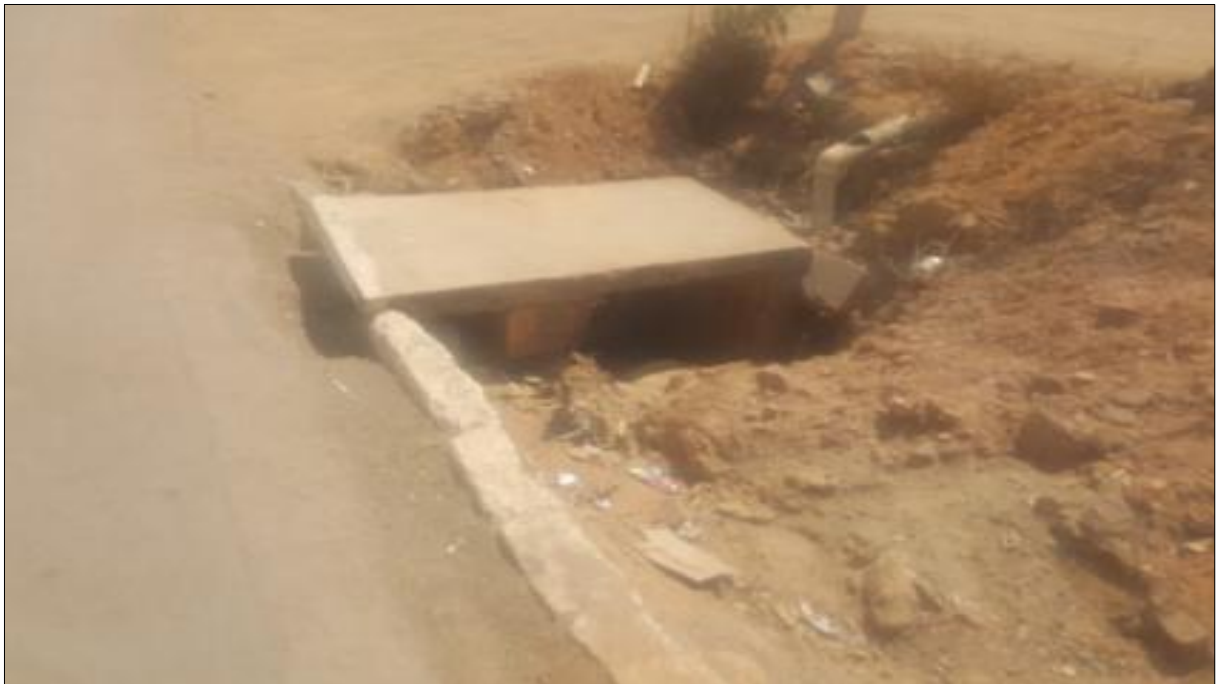
Figura 176: Estrutura da rede de drenagem pluvial - rua Rio de Janeiro
