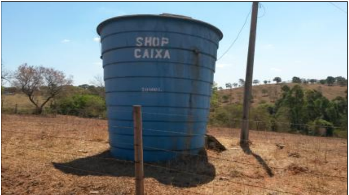
Figura 95: Reservatório de água - comunidade Correias
