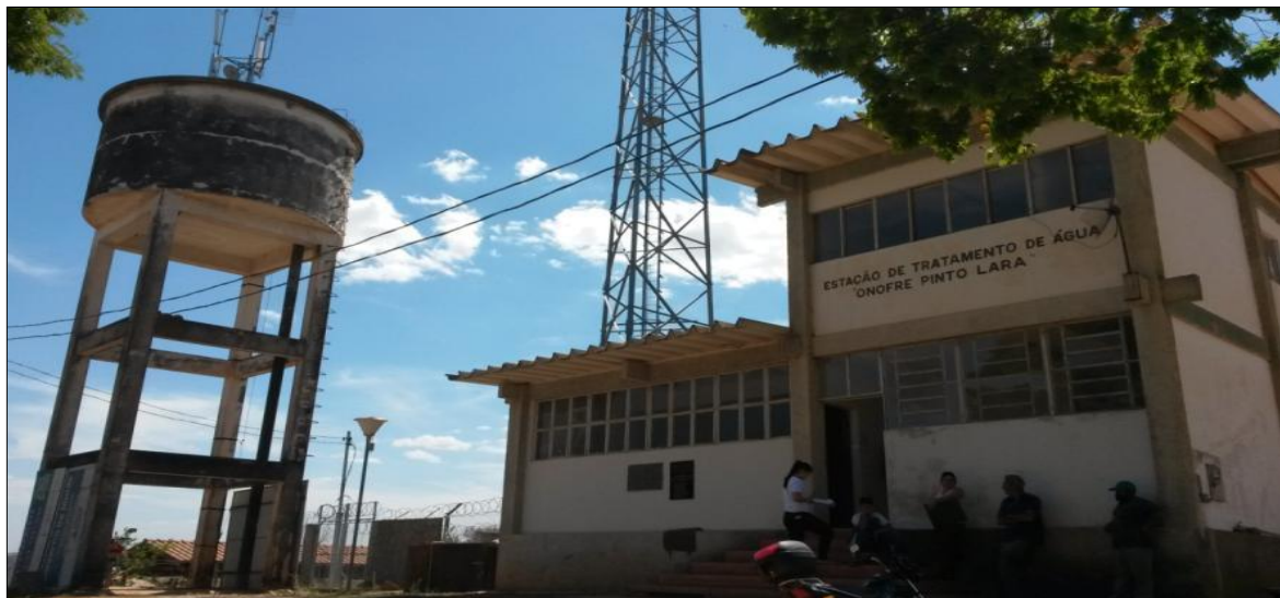
Figura 73: Estação de Tratamento de Água – ETA
