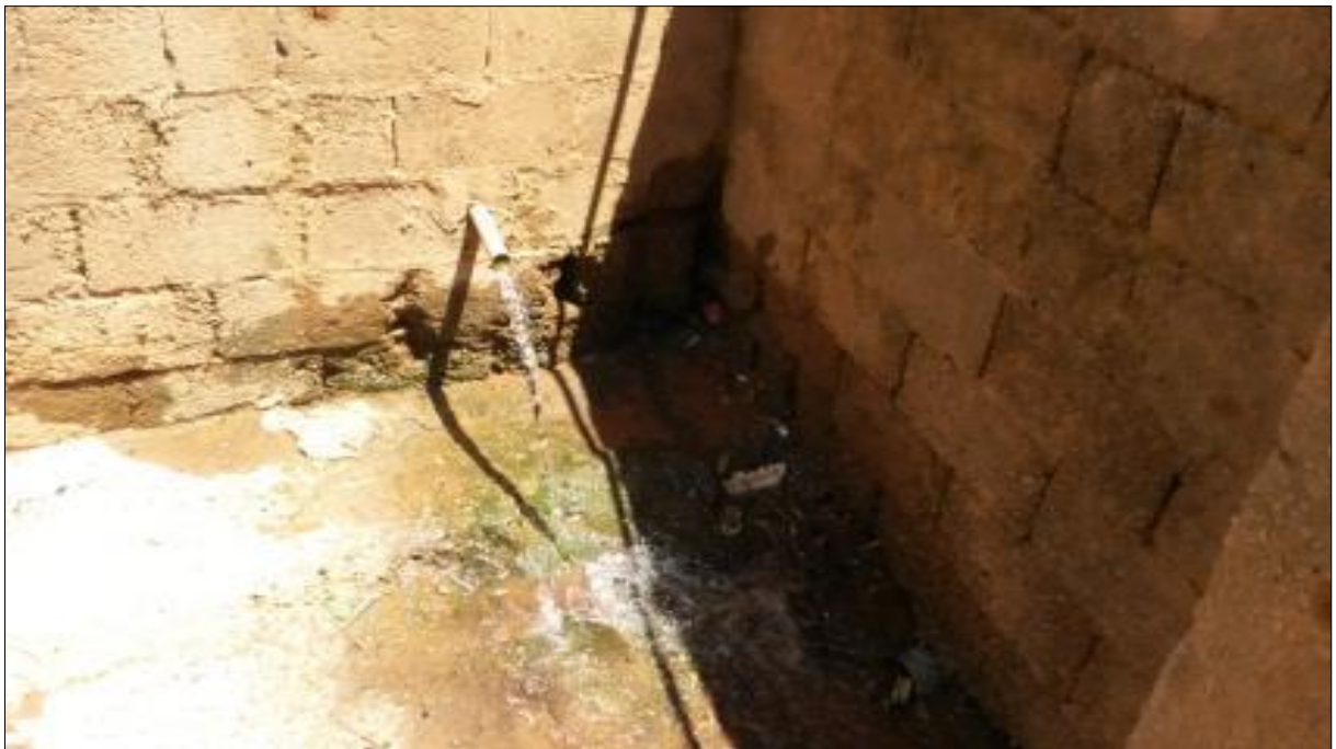
Figura 71: Minas d'água na zona urbana da sede
