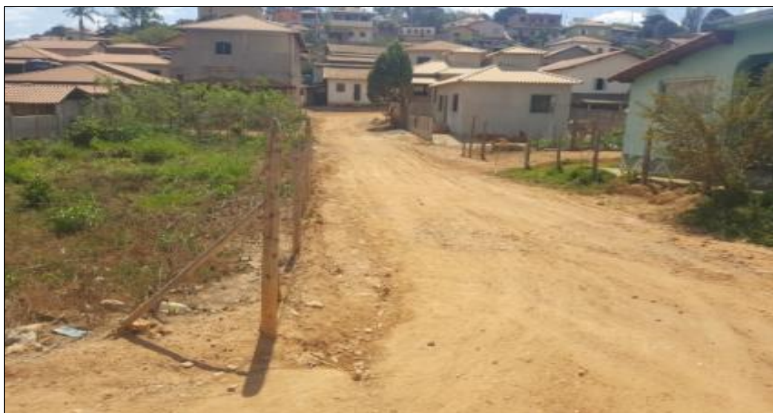
Figura 54: Rua sem pavimentação
