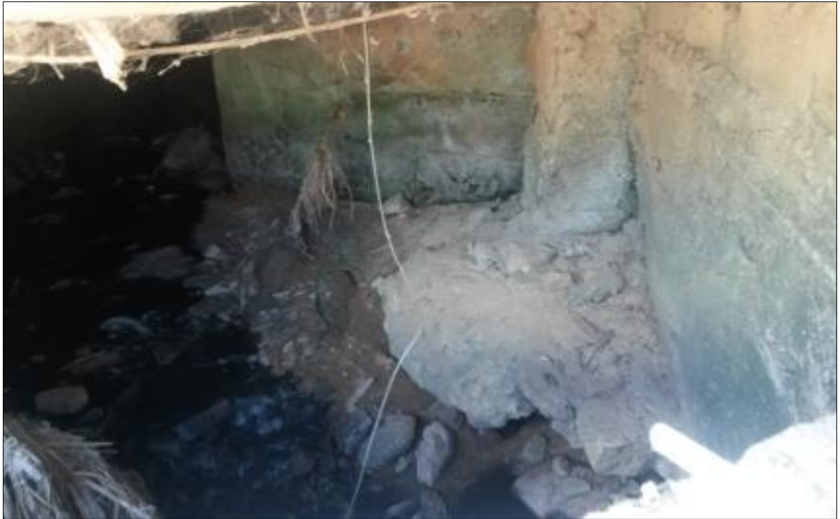
Figura 115: Galeria de drenagem pluvial com esgoto na rua Joaquim Pinto Lara
