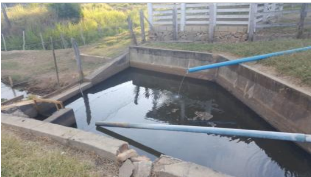
Figura 67: Captação na comunidade Laje – Foto 2
