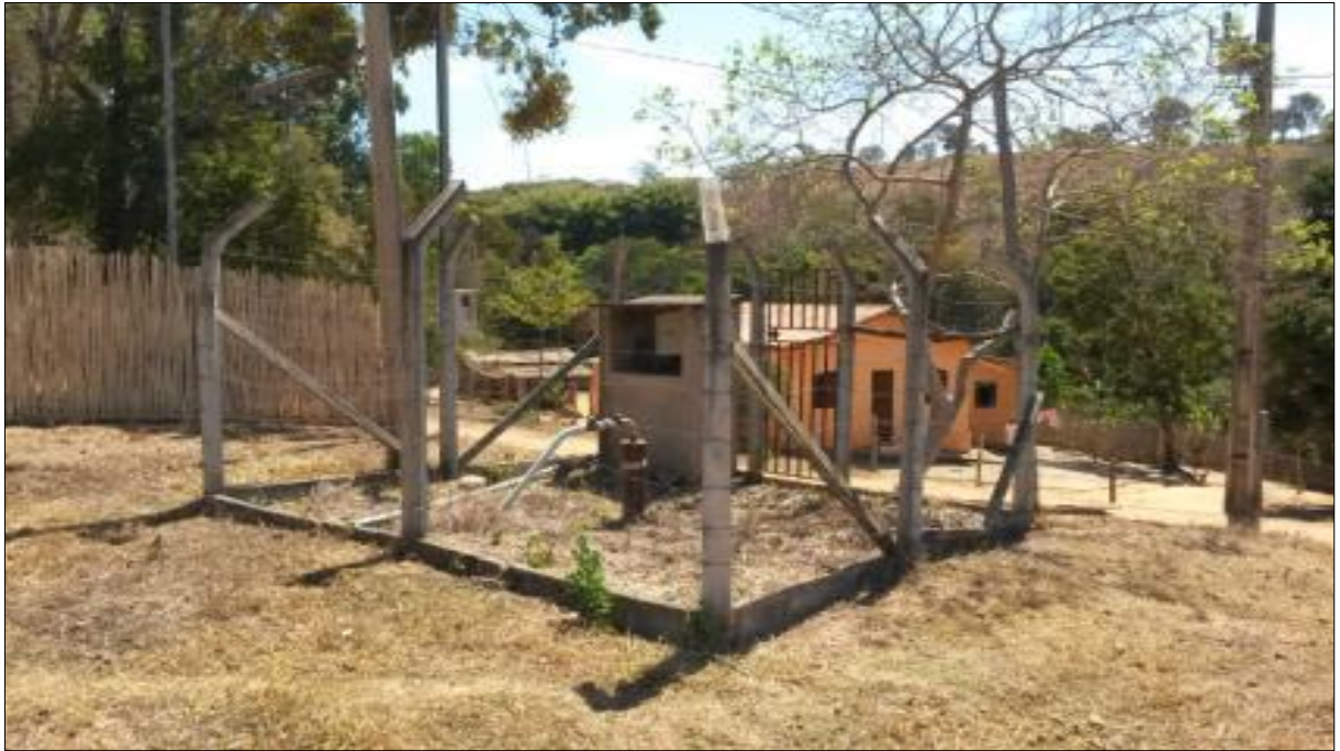
Figura 94: Captação subterrânea – comunidade Correias
