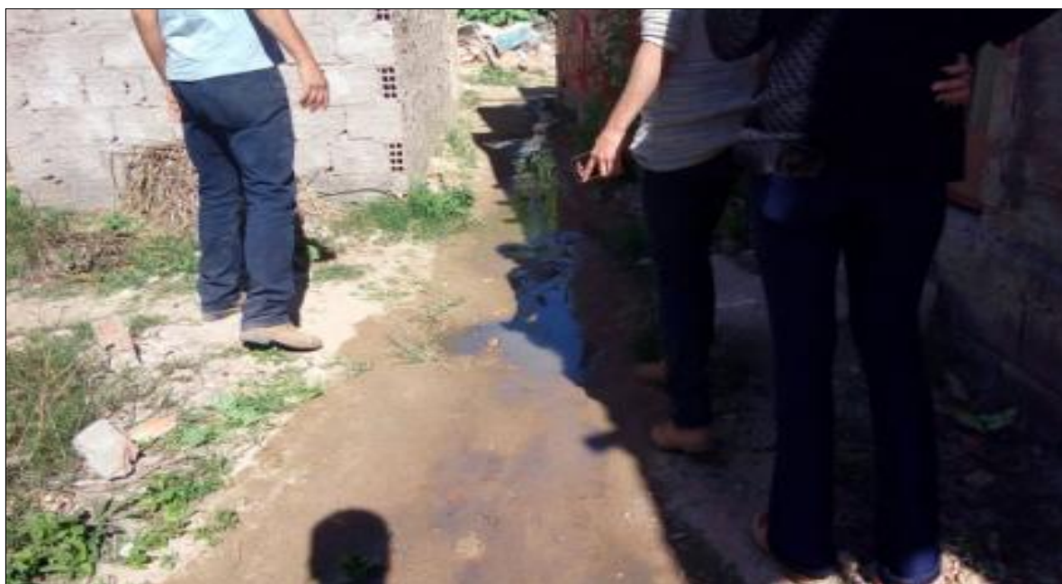
Figura 113: Lançamento de esgoto a céu aberto – bairro Fonte das Pedras
