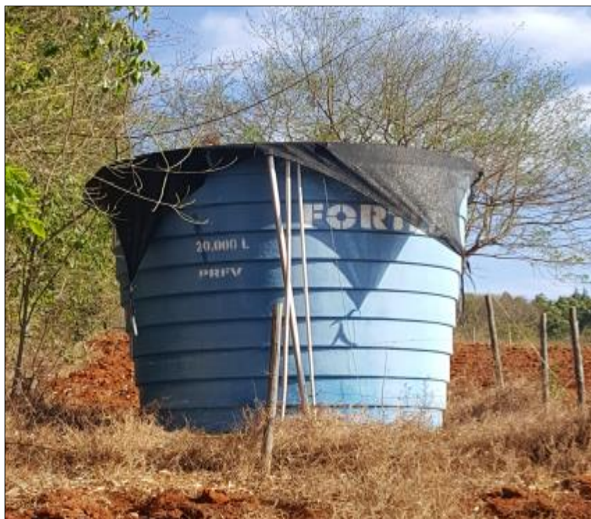
Figura 104: Reservatório de água - comunidade Quilombo
