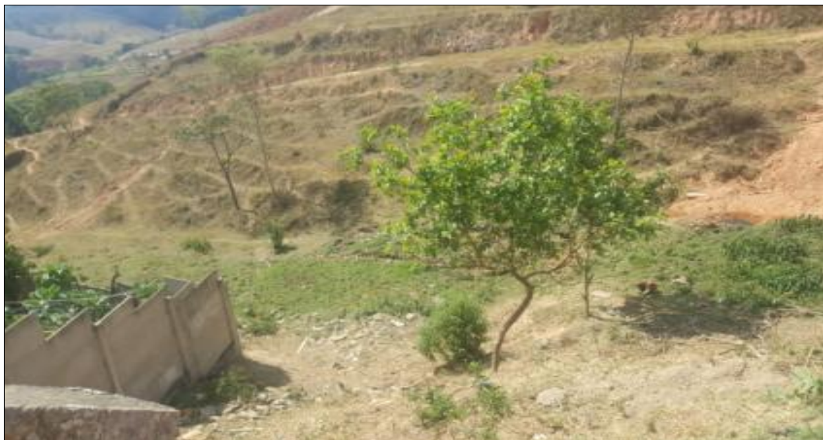
Figura 114: Lançamento de esgoto na rua Major Belizário
