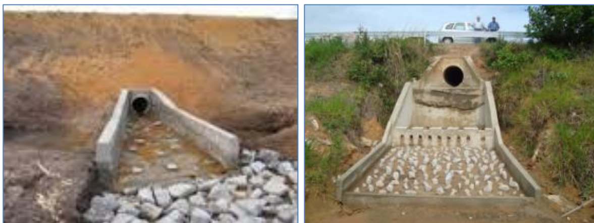
Figura 39 – Exemplo de dissipador de energia em caixa.
