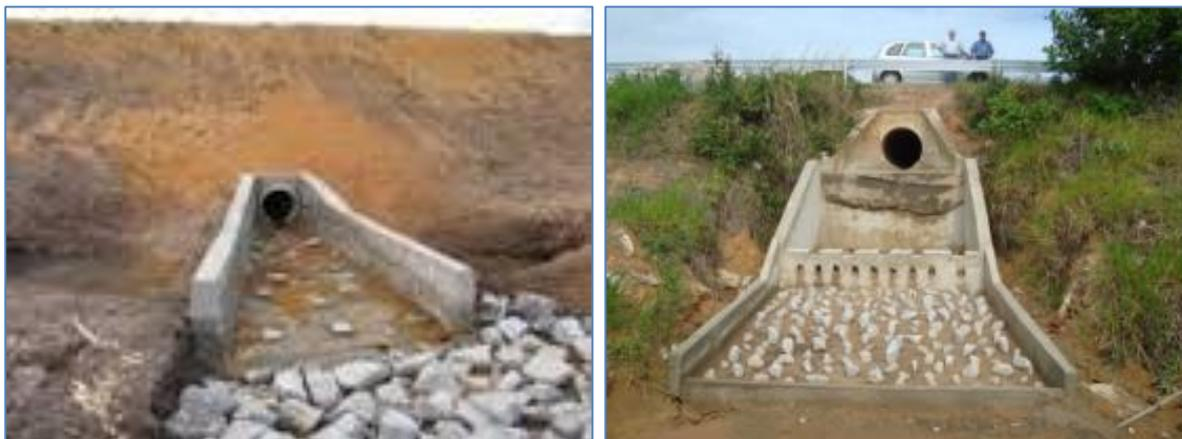
**Figura 62 – Exemplo de dissipador de energia em caixa.**
