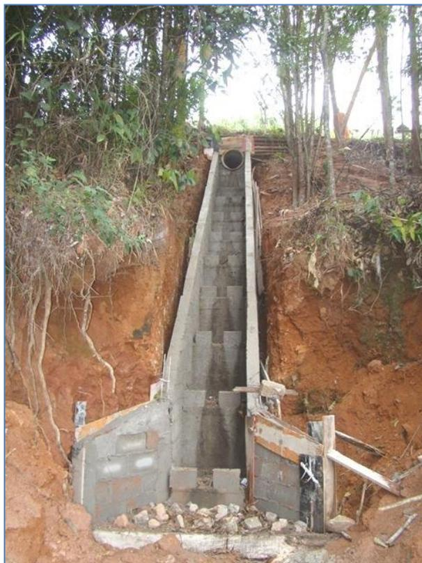
**Figura 63 – Exemplo de dissipador de energia em degraus.**
