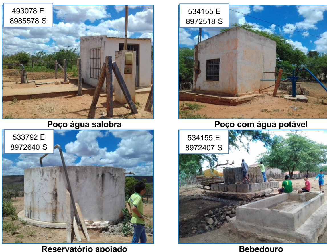
Figura 71 – Estruturas de abastecimento de água do povoado de Salgado do Melão.
