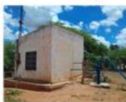
Poço com água potável
