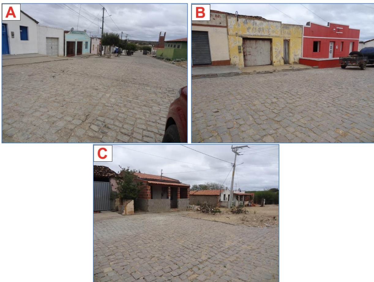
Figura 98 – Vista do sentido do escoamento (A), casas com muros de contenção (B) e área de alagamento (C).
