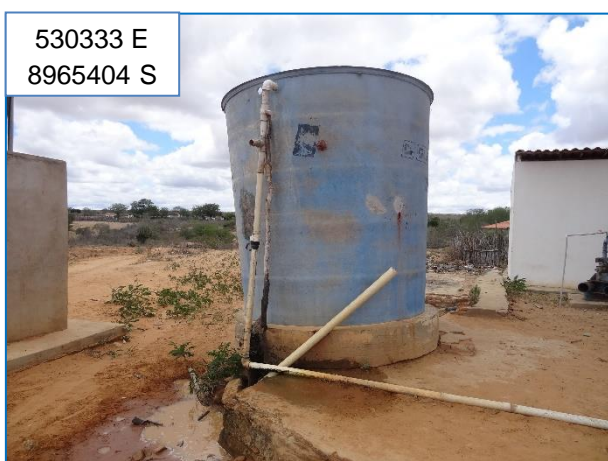
Reservatório 10 m 3 junto ao poço
