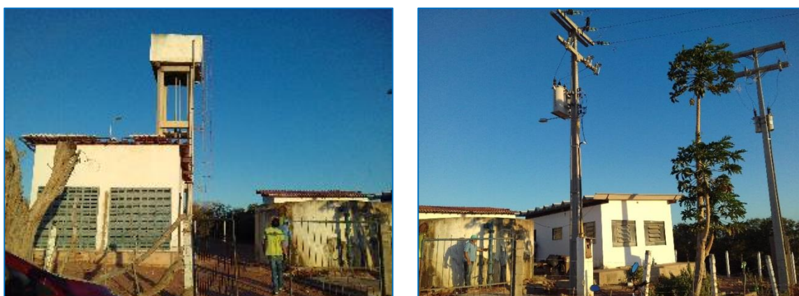
Figura 58 – Vista geral da área da captação que atende a sede de Macururé.
