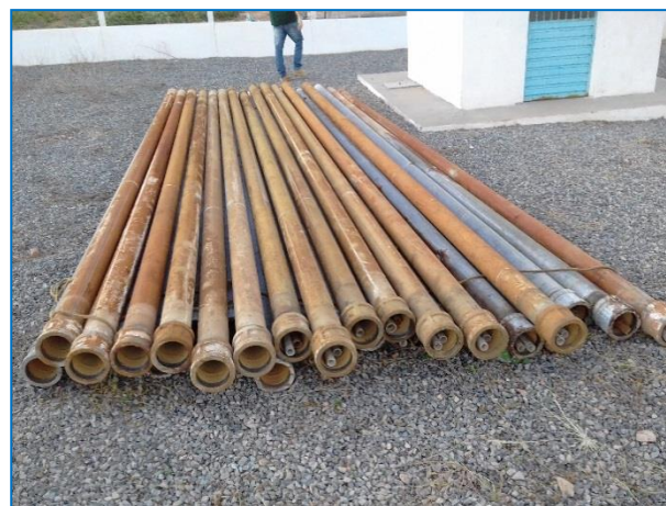
Tubulação da adutora substituída
