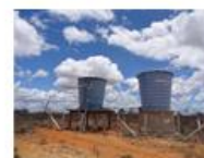
Reservatório de 20m³ cado, abastecido no ponto mais alto
