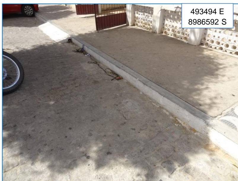
Figura 96 – Meio fio e sarjeta observados em Macururé.
