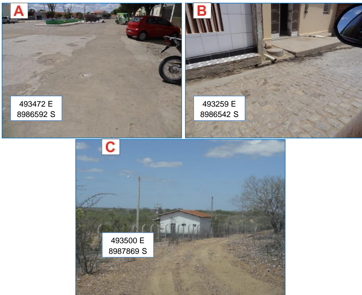
Figura 95 – Tipos de pavimento encontrados na sede: concreto (A), pedra irregular (B) e estradas sem pavimentação (C).
