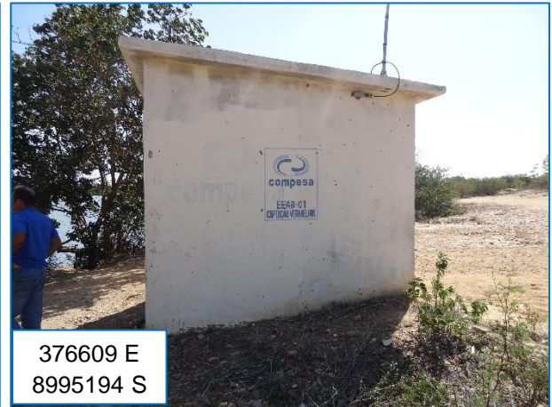
Elevatória de água bruta
