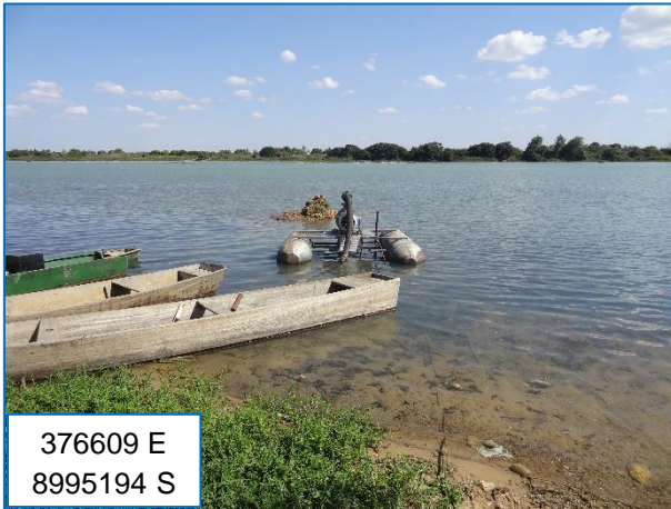
Captação flutuante rio São Francisco
