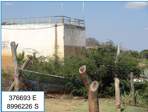
Estação de tratamento de água
