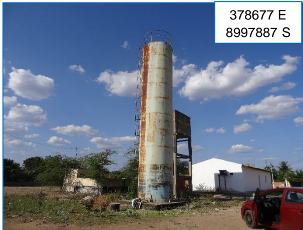
Reservatório no PA Ouro Verde
