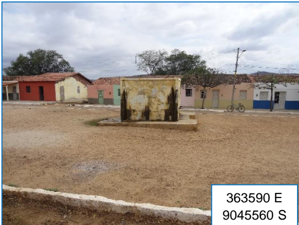
Reservatório no distrito Jutai
