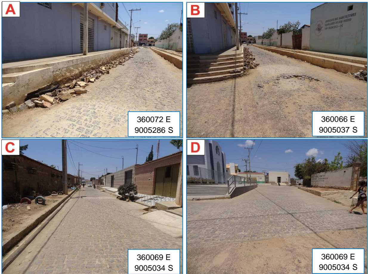
Figura 110 – Pontos Críticos de Alagamento na sede municipal. Rua Oeste (A) e (B), rua Tancredo Neves (C) e Agamenon Magalhães (D).
