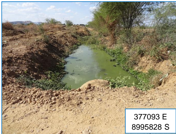
Canais de esgoto
