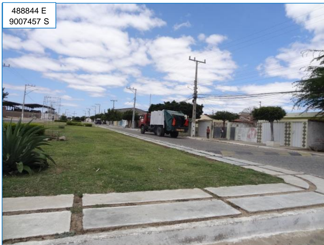
Figura 93 – Meio fio e sarjeta observados em Chorrochó. Fonte: EnvEx Engenharia e Consultoria, 2017.
