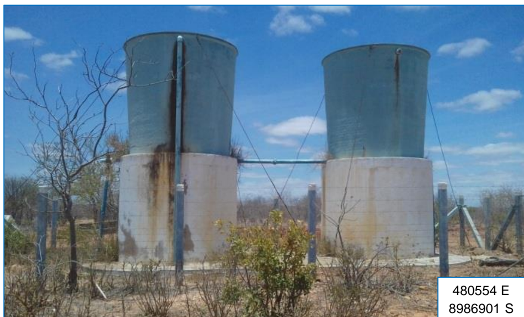
Figura 67 – Reservatórios desativados, capacidade de 10 m 3 , situados na parte alta de São José.
