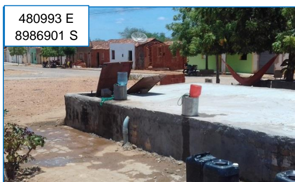
Cisterna situada na avenida central.
