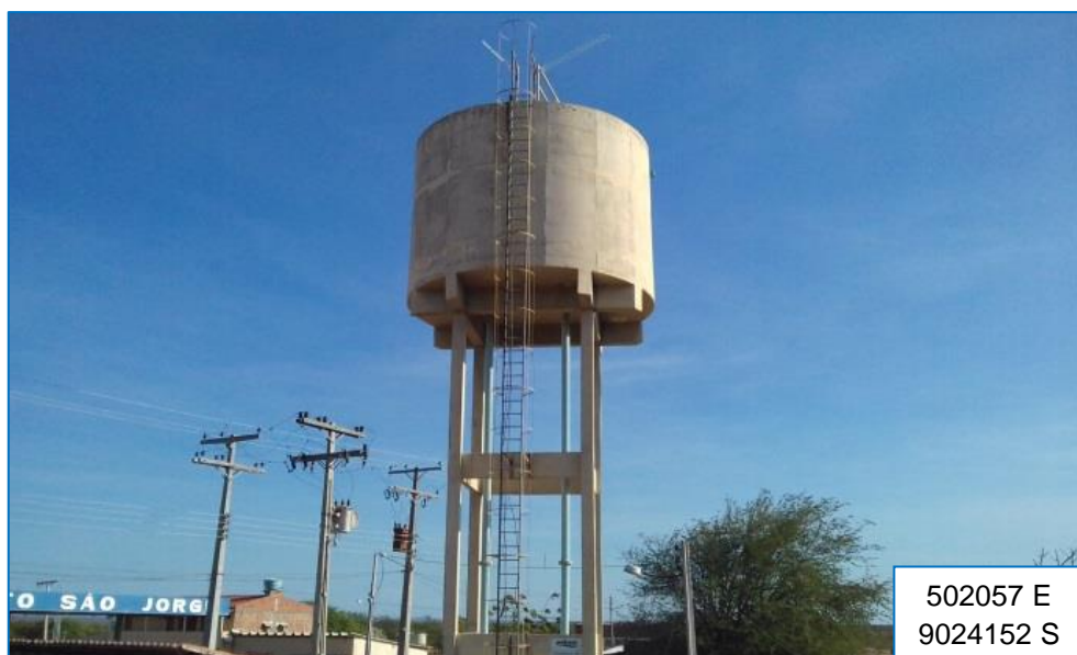
Figura 65 – Reservatório elevado do distrito, situado na área da ETA.
