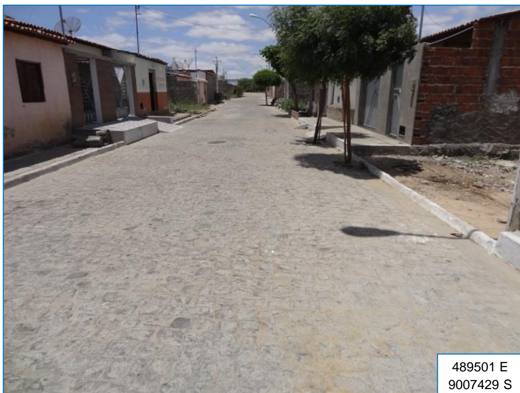
Figura 92 – Tipo de pavimento encontrado na sede.
