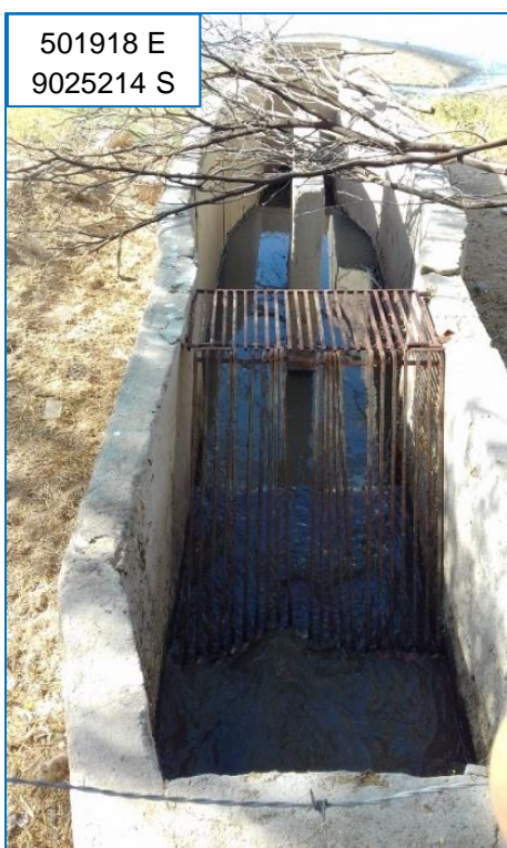
Figura 78 – Gradeamento: tratamento preliminar e vertedor de saída da ETE.
