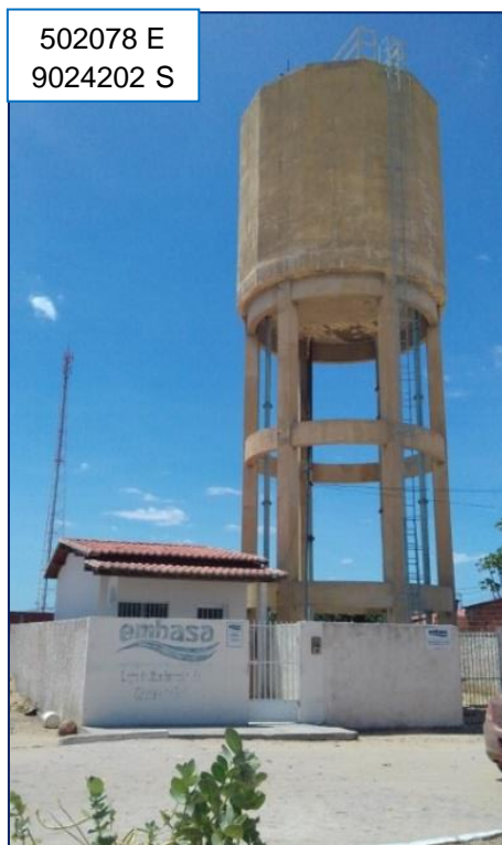
Figura 61 – Reservatório elevado com capacidade de 150 m 3 na sede de Chorrochó.
