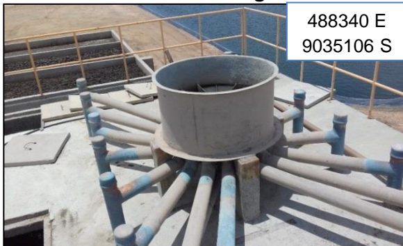
Distribuidor radial do DAFA
