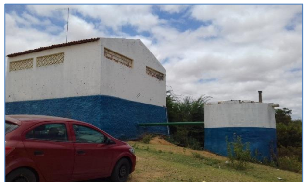
Poço de sucção da EEAB
