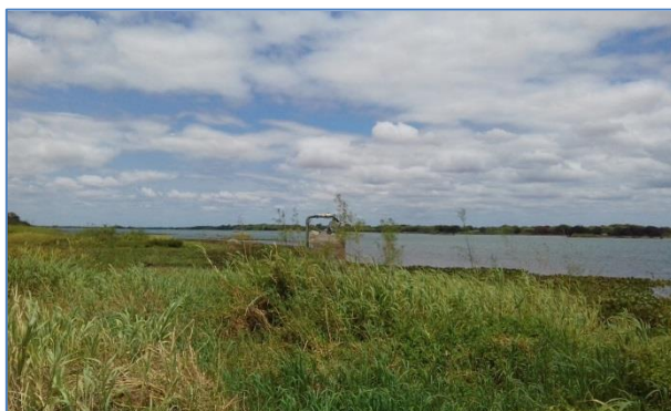
Captação no rio São Francisco
