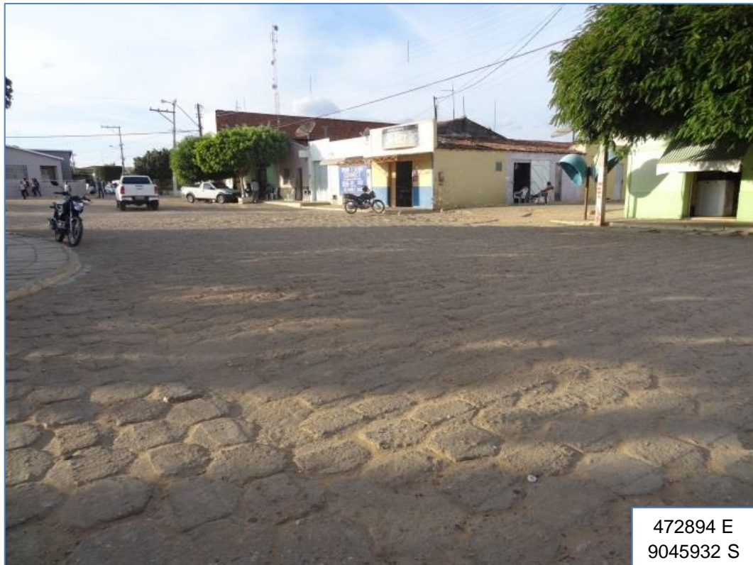
Figura 118 – Local crítico de alagamentos em Ibó. Fonte: EnvEx Engenharia e Consultoria, 2017.
