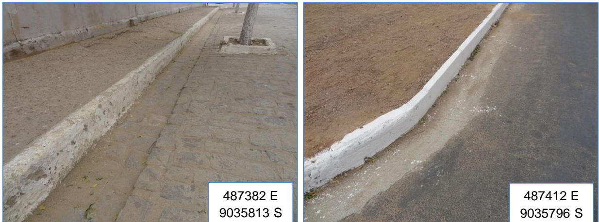
Figura 114 – Meio fio e sarjeta observados em Abaré. Fonte: EnvEx Engenharia e Consultoria, 2017.
