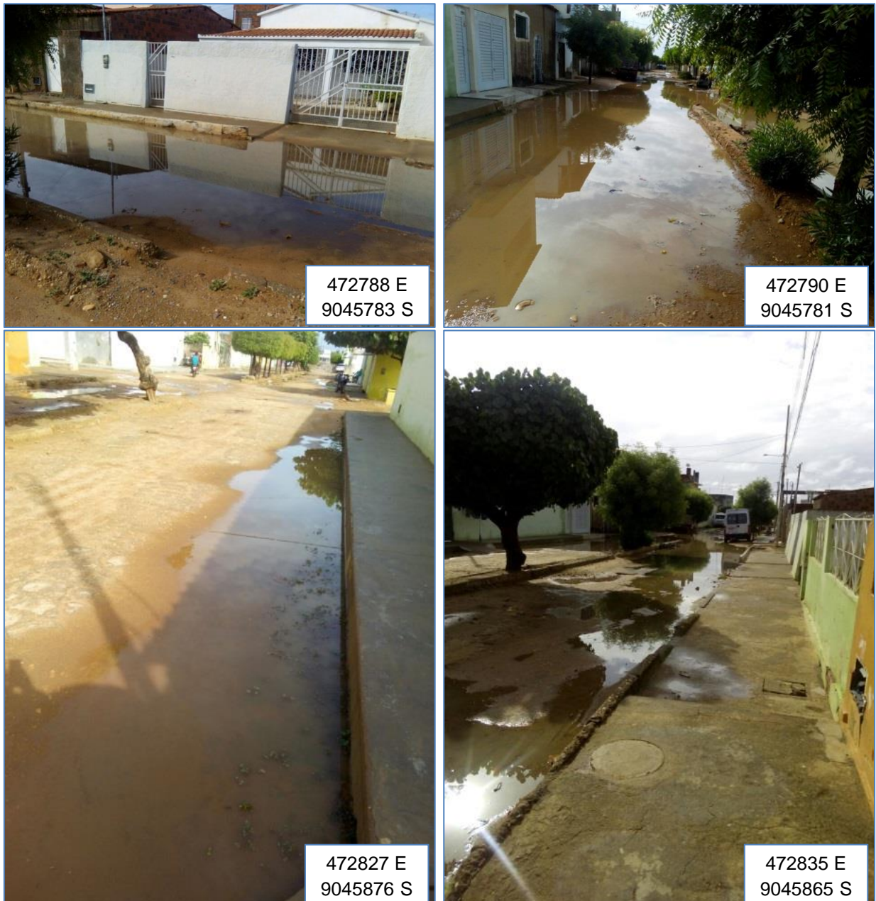
Figura 117 – Rua alagadas no distrito de Ibó. Fonte: EnvEx Engenharia e Consultoria, 2017.
