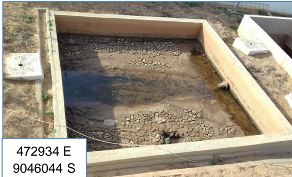
Leitos de secagem de lodo
