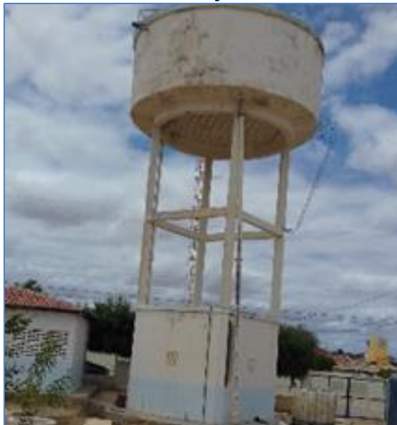
Reservatório elevado da sede
