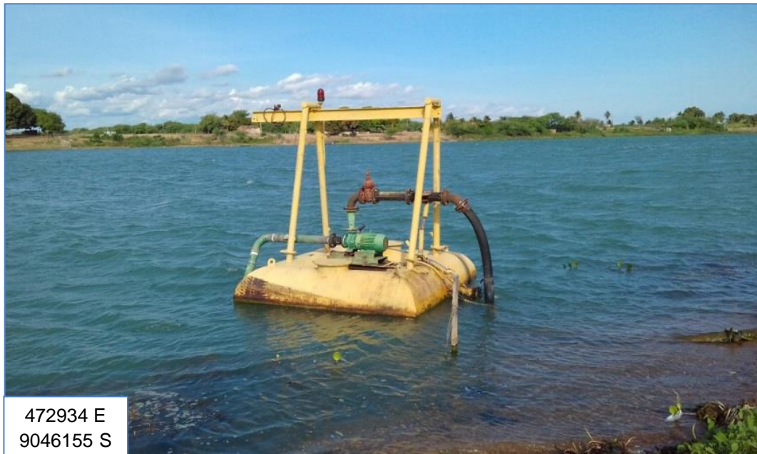
Figura 69 – Captação no rio São Francisco do distrito de Ibó. Fonte: EnvEx, Engenharia e Consultoria, 2017.
