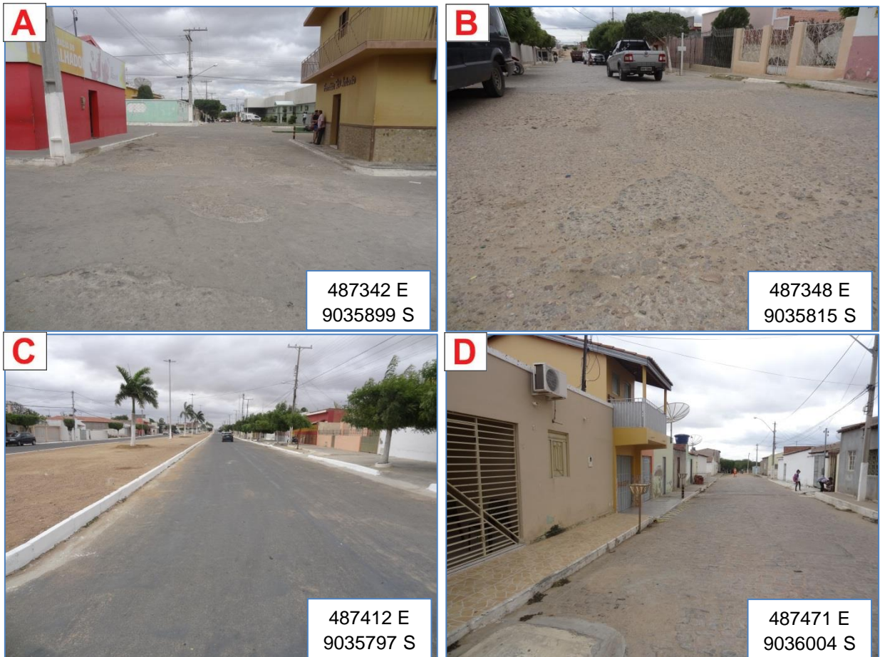
Figura 111 – Tipos de pavimento encontrados na sede. Concreto, rua Ministro Oliveira Brito (A) e rua Cônego Pascoal (B), asfalto, rua Edésio Tolentino (C) e pedra irregular, rua do Campo (D).
