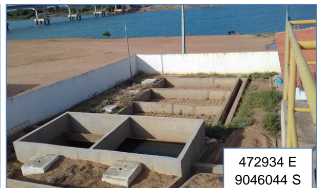
Leitos de secagem do lodo
