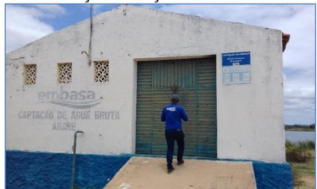
Elevatória de água bruta
