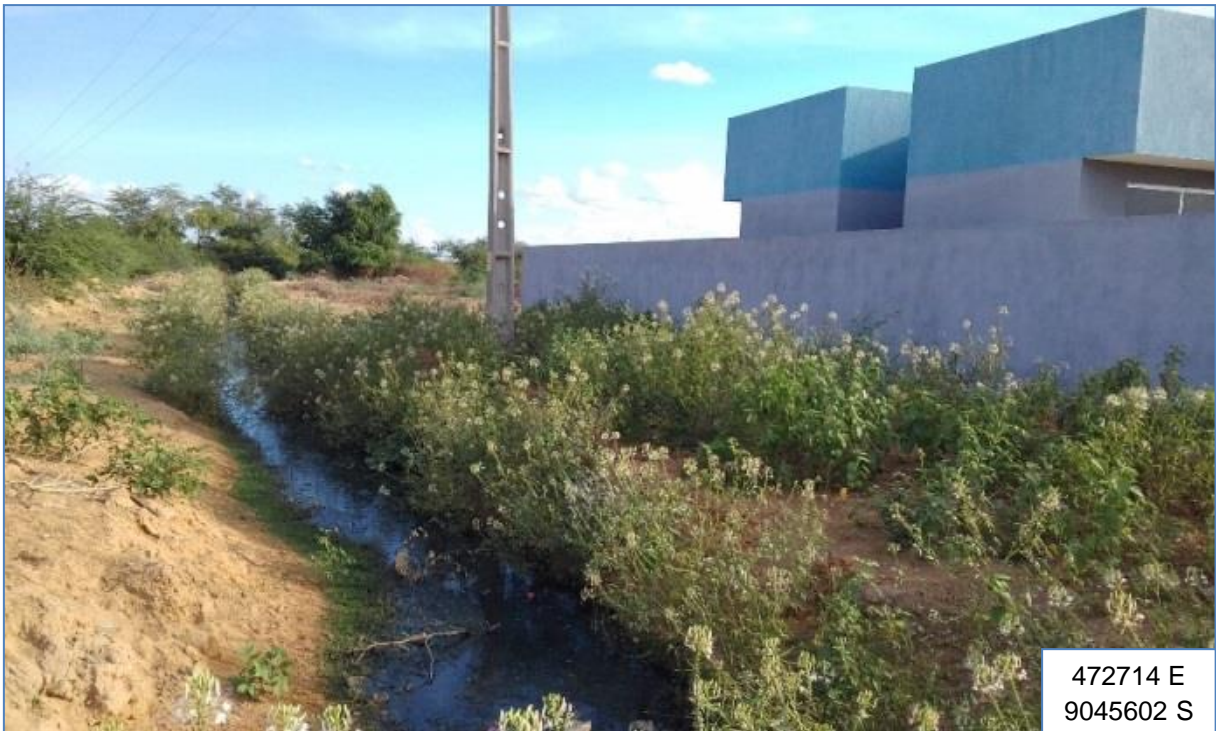
Esgoto lançado a céu aberto
