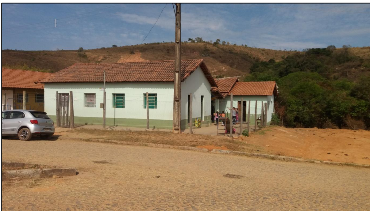
Figura 39: Escola municipal na comunidade Passa Sete
