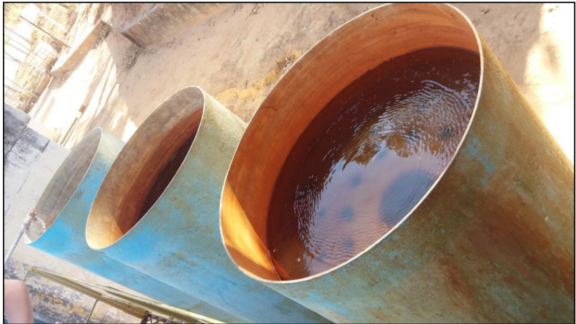
Figura 73: Filtros na ETA
