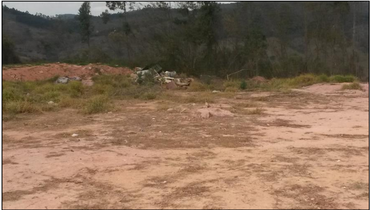
Figura 150: Vala de rejeitos encerradas
