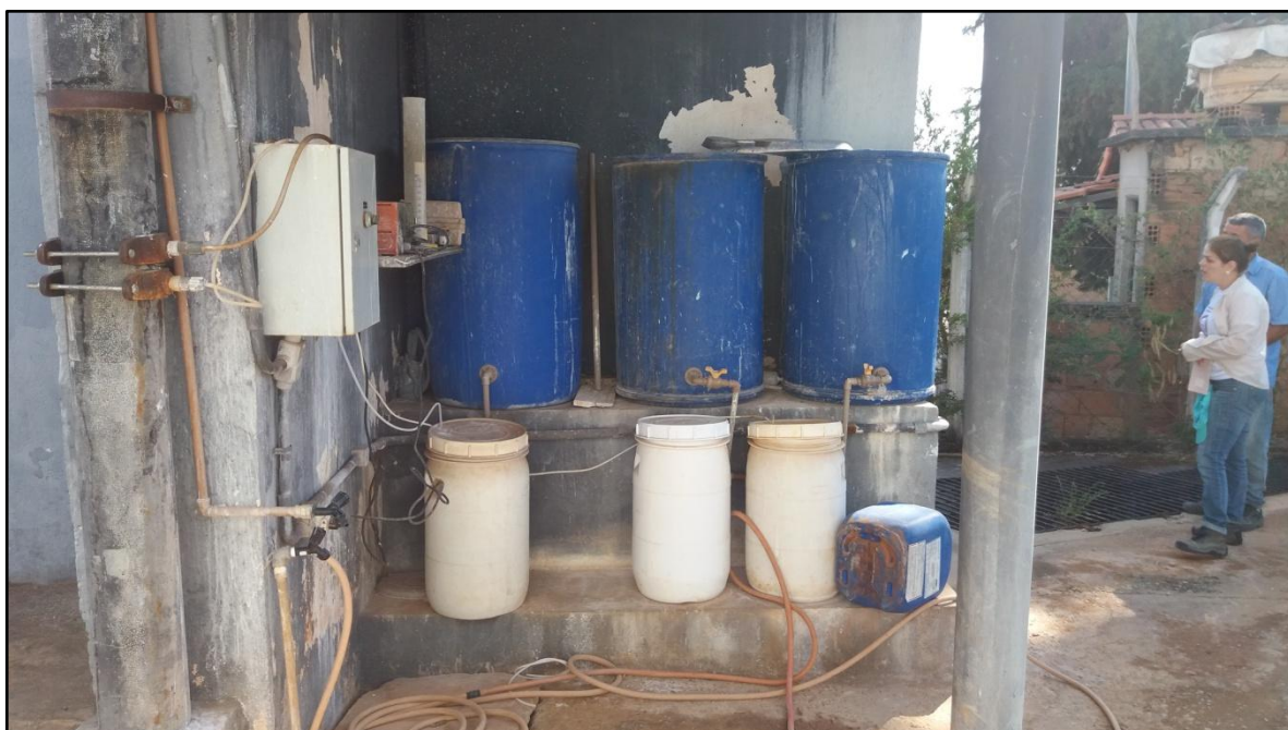
Figura 82: Tratamento de água simplificado
