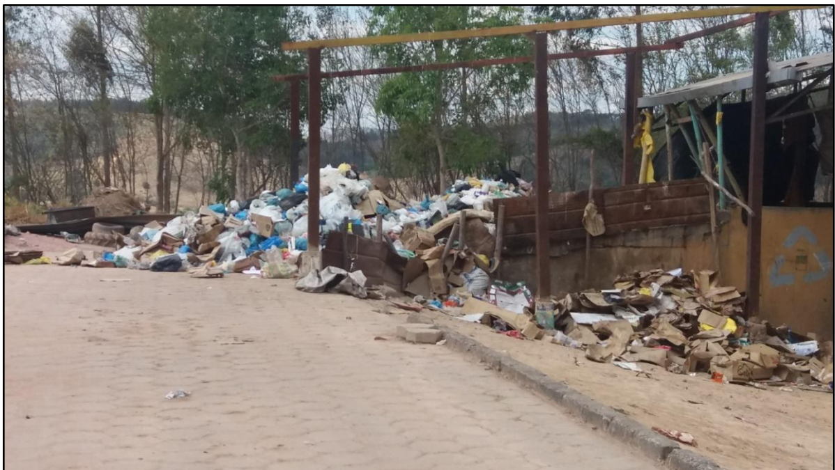
Figura 124: Área de recepção sem o telhado
