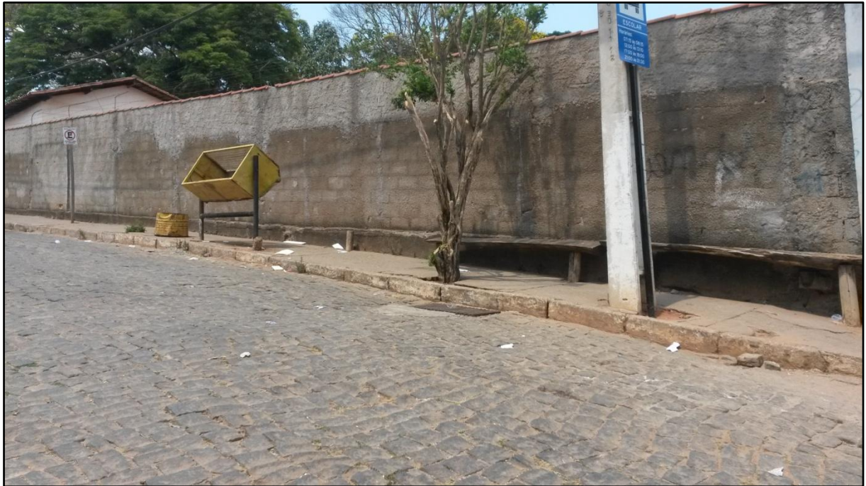
Figura 175: Bueiro na região central
