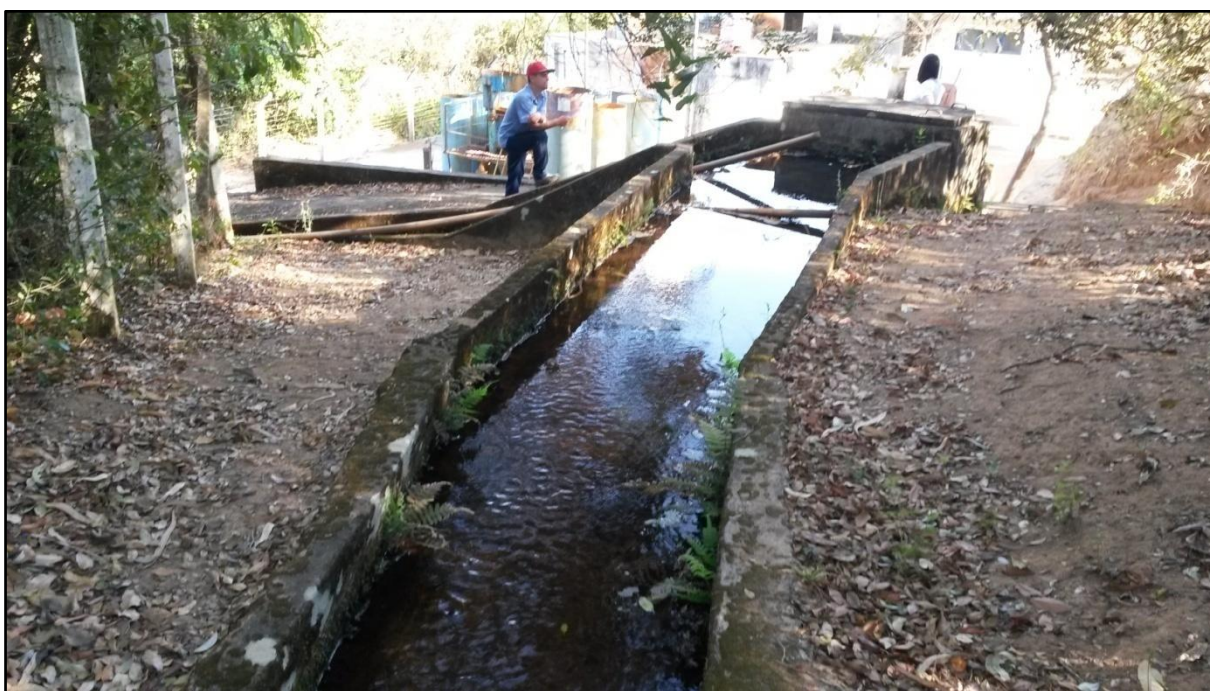
Figura 64: Captação superficial
