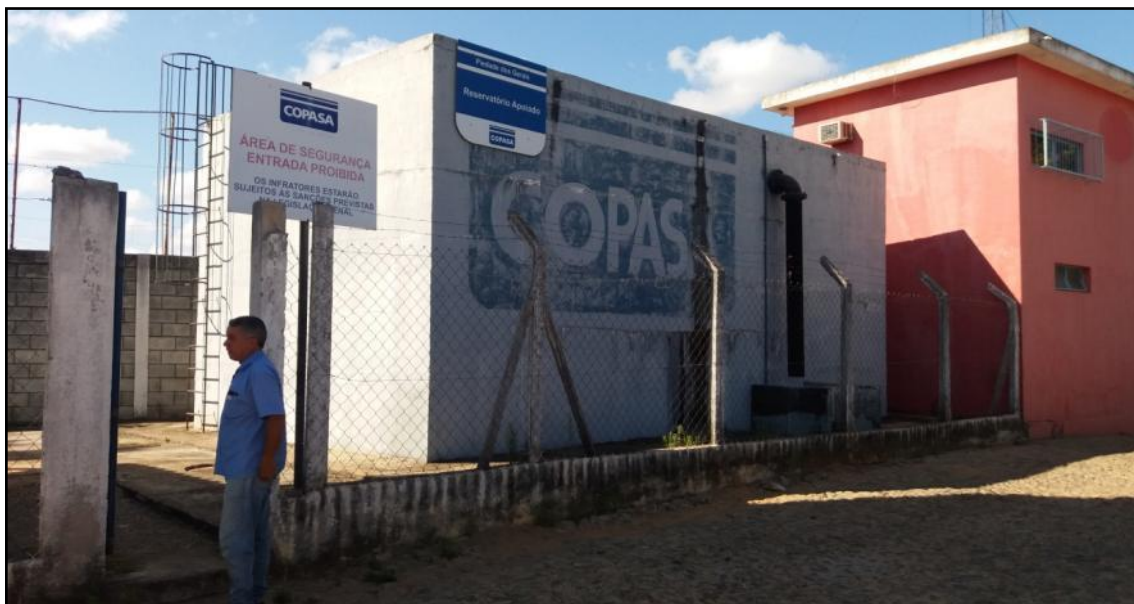
Figura 86: Reservatórios para atender a sede e bairro Dom Pedro I
