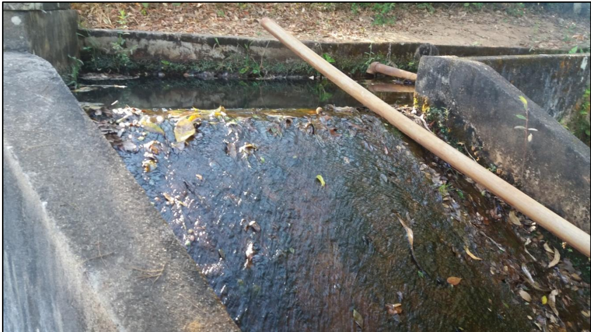
Figura 69: Chegada da água bruta na ETA
