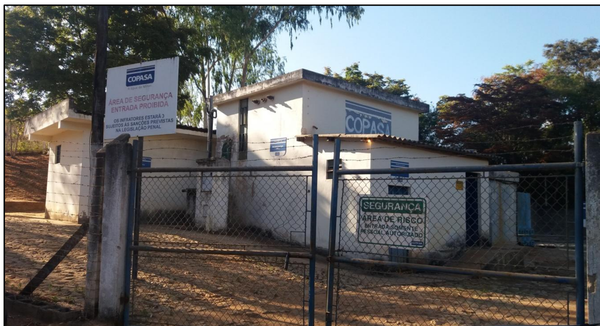
Figura 67: Estação de Tratamento de Água
