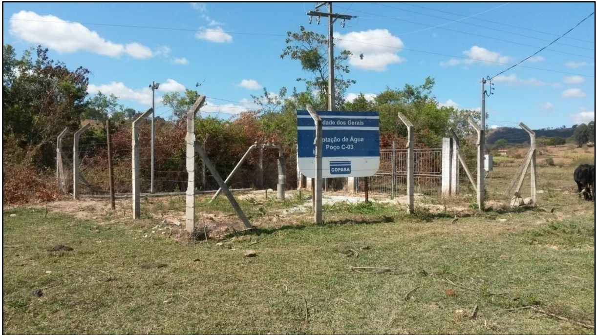
Figura 61: Vista total do poço de captação C-03 no rio Macaúbas
