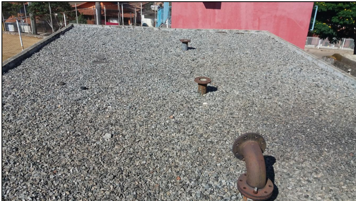
Figura 88: Vista superior do reservatório
