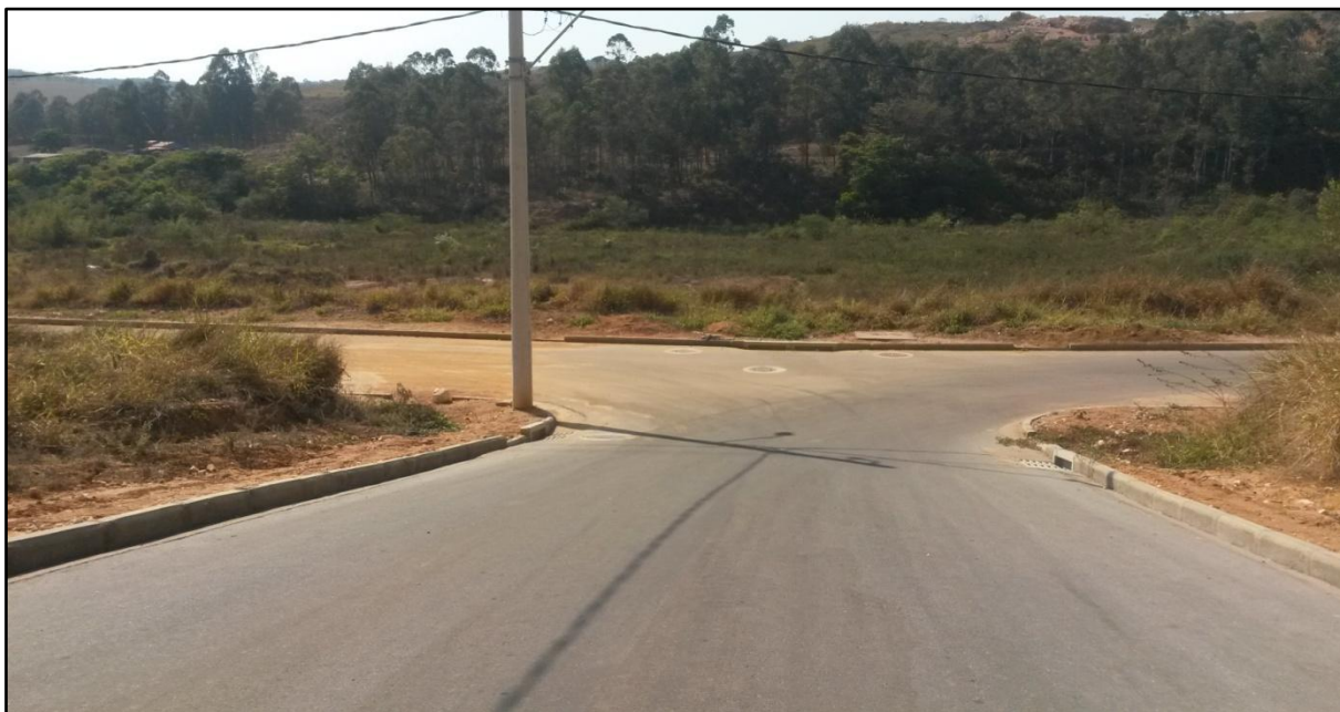
Figura 50: Via pavimentada com asfalto
