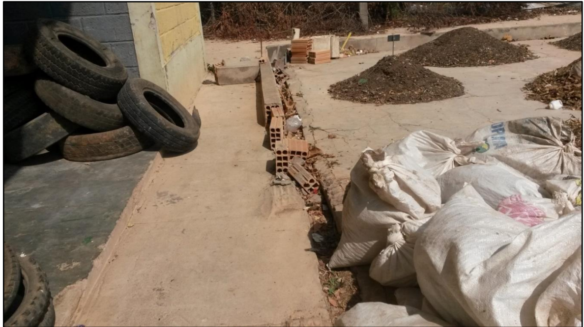
Figura 139: Pátio de compostagem necessitando reparo
