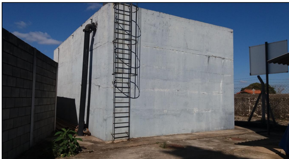
Figura 87: Reservatórios do tipo apoiado
