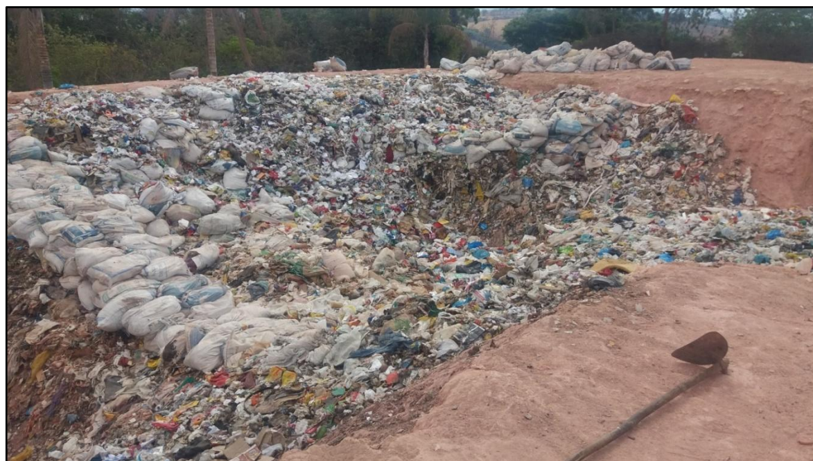
Figura 147: Excesso de rejeitos na vala
