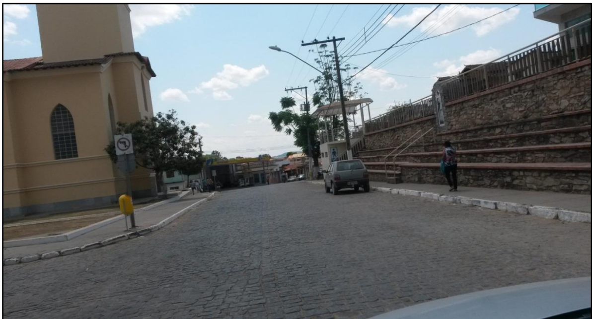
Figura 48: Pavimentação em pedra calçada
