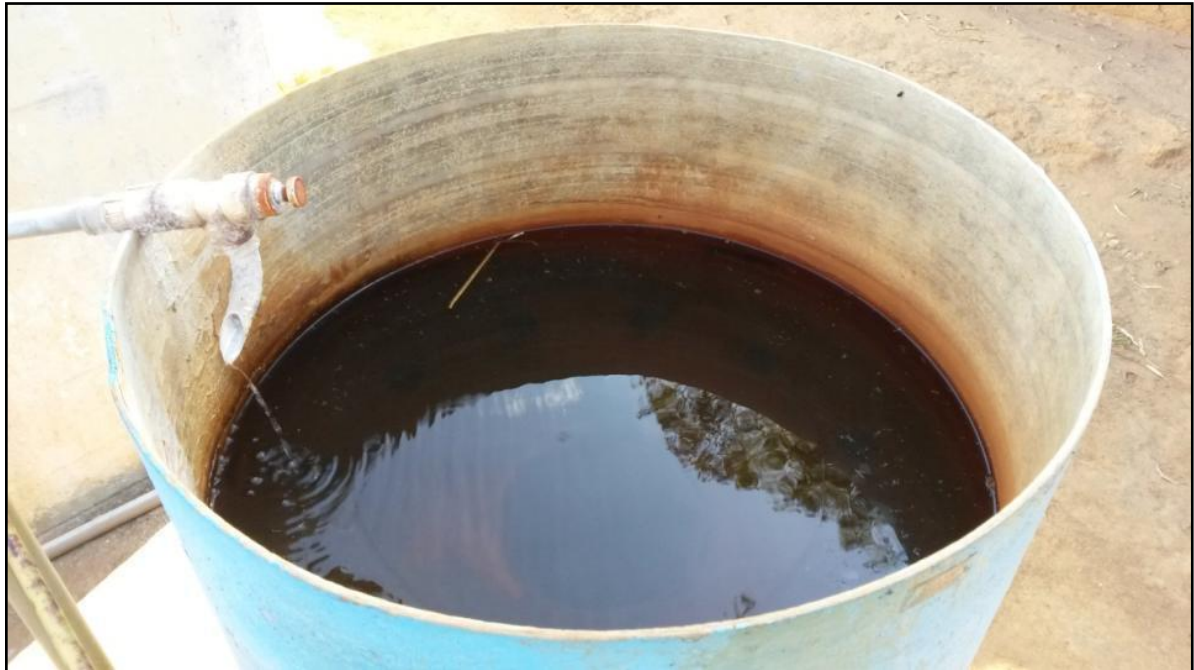
Figura 71: Floculador na ETA
