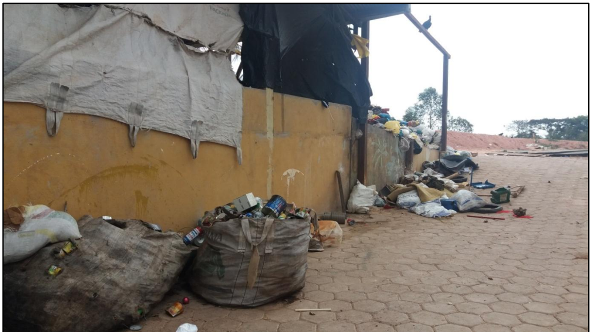
Figura 131: Acúmulo de materiais ao ar livre
