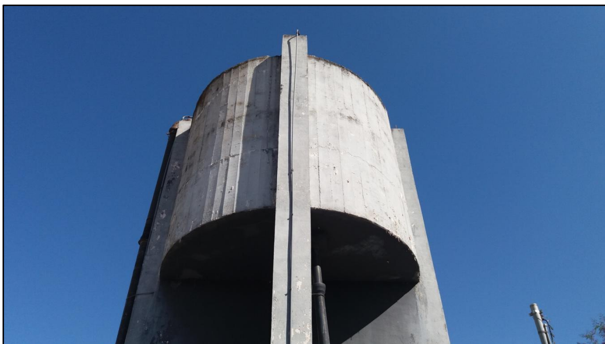
Figura 89: Reservatório do tipo elevado
