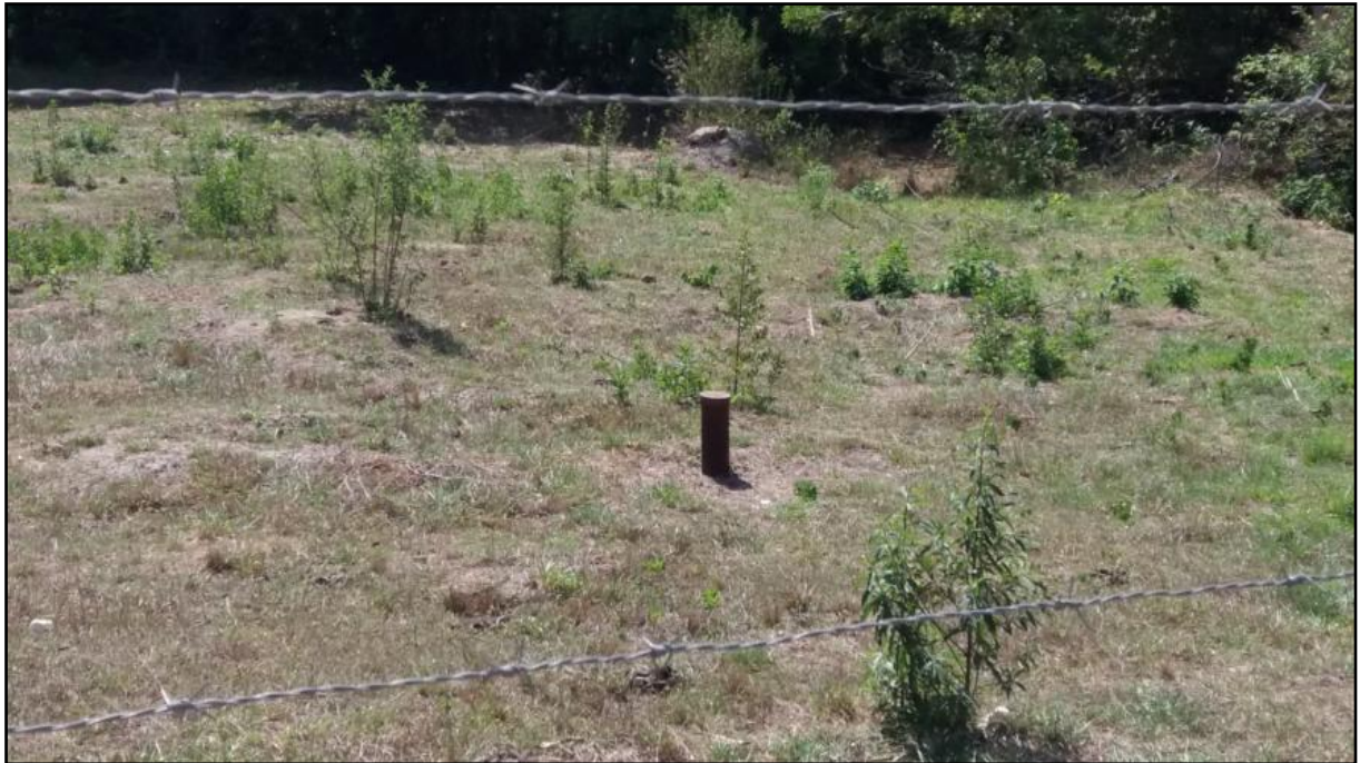
Figura 71: Poço perfurado desativado - bairro Maravilhas
