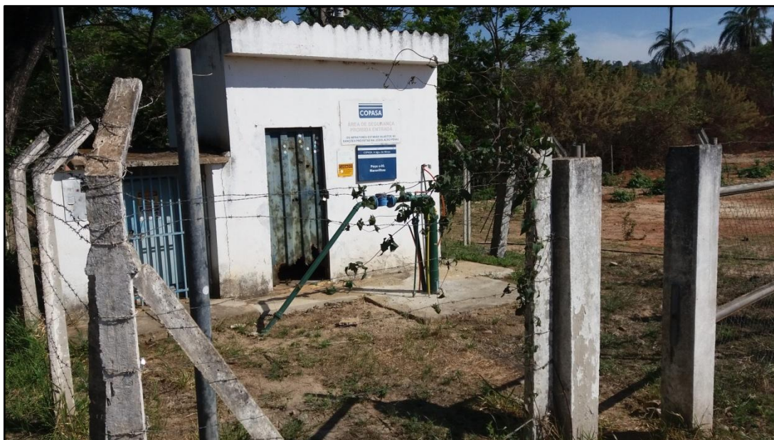
Figura 68: Poço C-01 bairro Maravilhas
