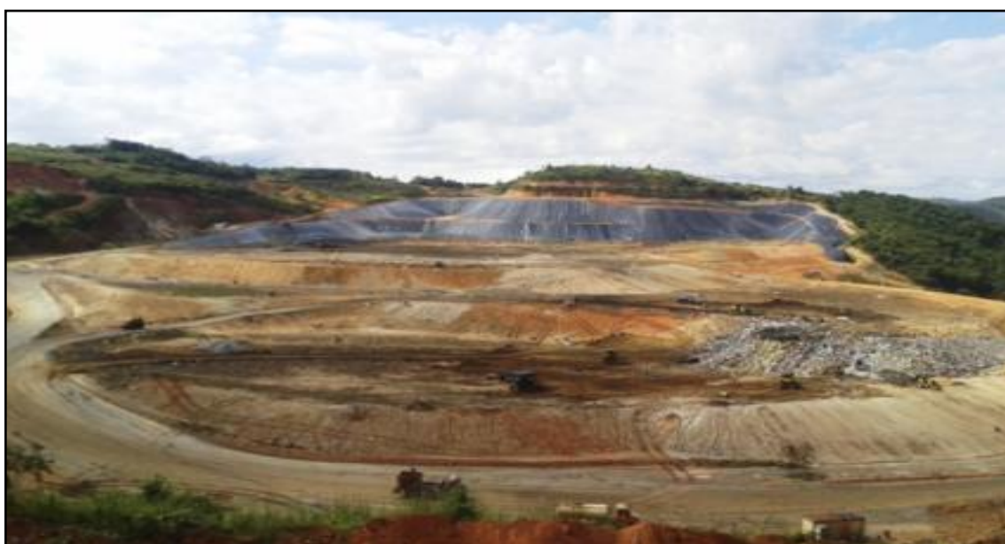
Figura 132: Central de tratamento de resíduos Macaúbas
