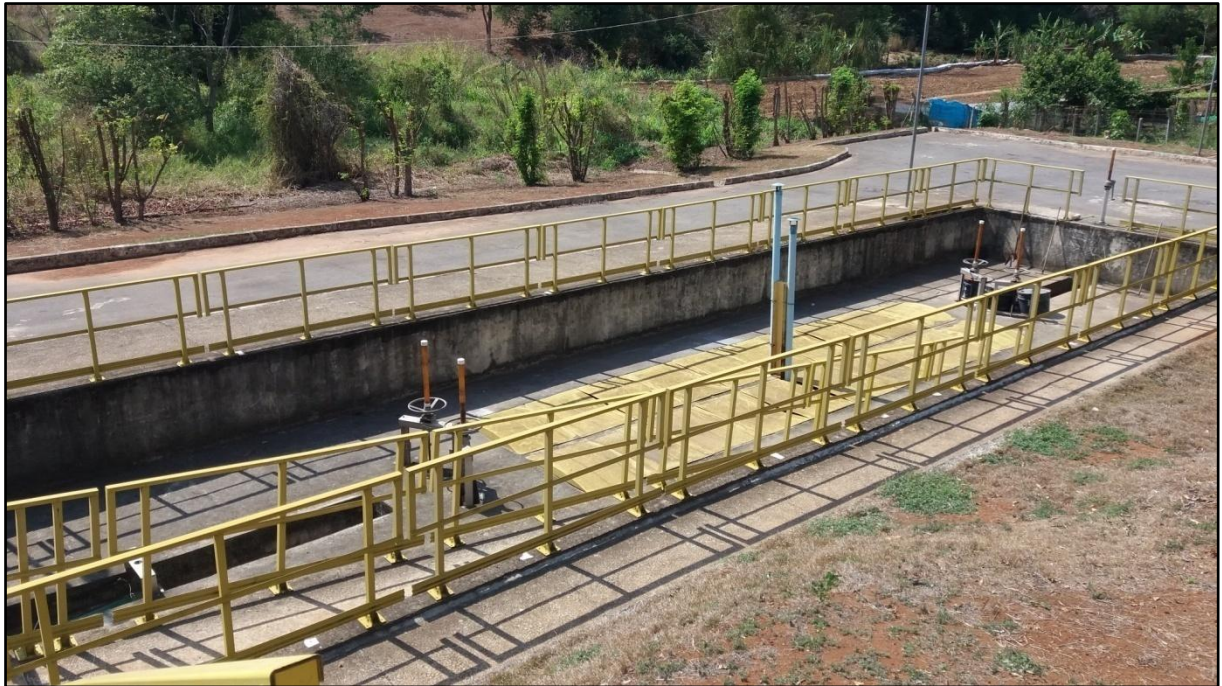
Figura 95: Tratamento preliminar ETE da sede
