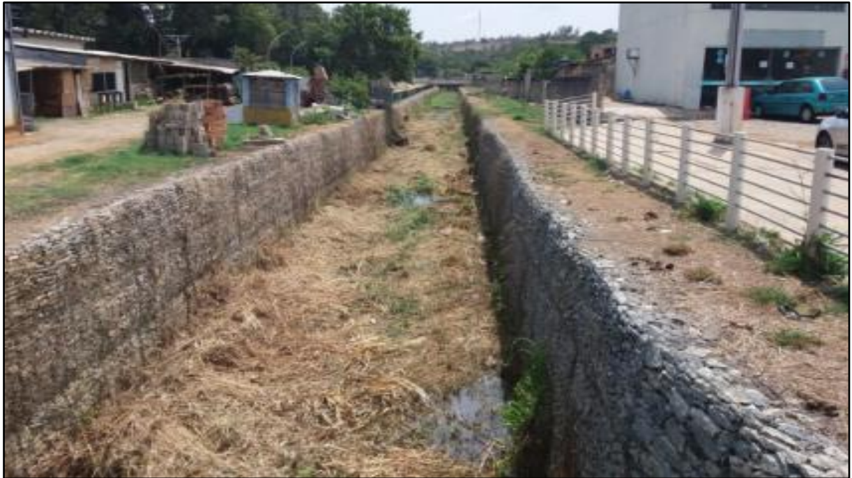
Figura 172: Sistema de macrodrenagem existente.
