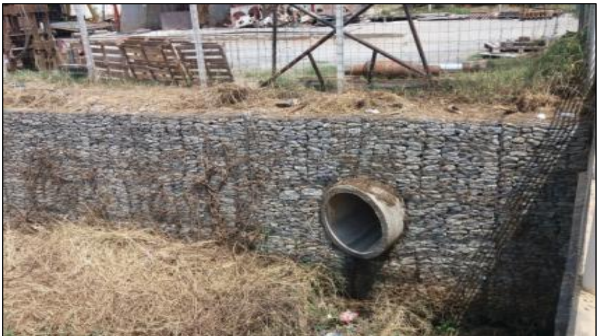
Figura 173: Sistema de macrodrenagem existente.
