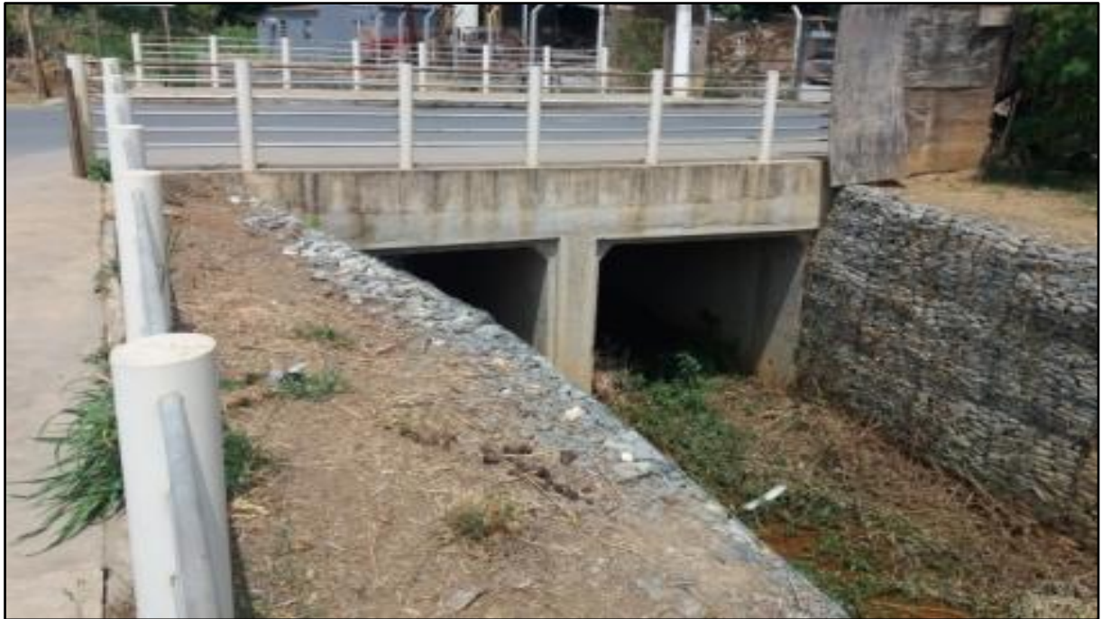
Figura 174: Sistema de macrodrenagem existente.
