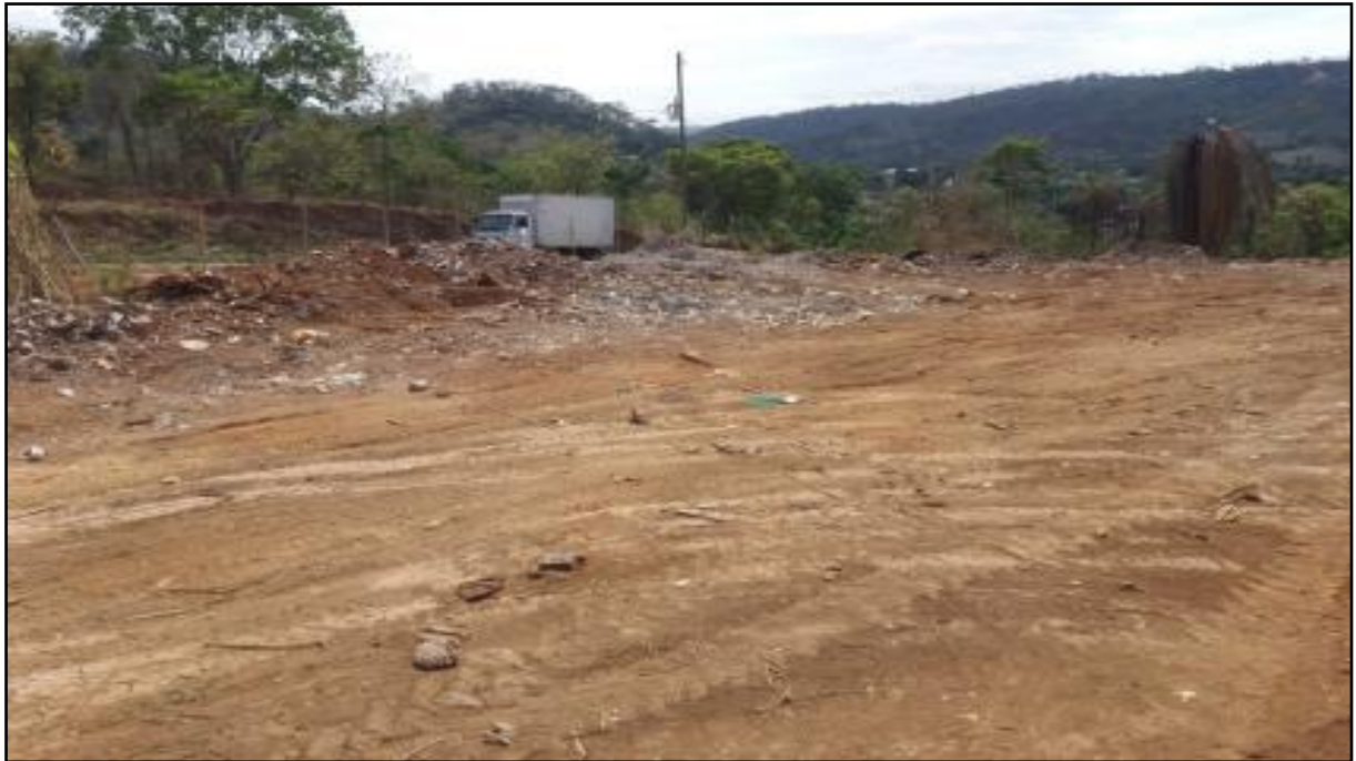
Figura 147: Bota fora de RCC
