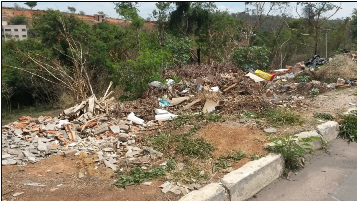
Figura 152: Acondicionamento inadequado de RCC
