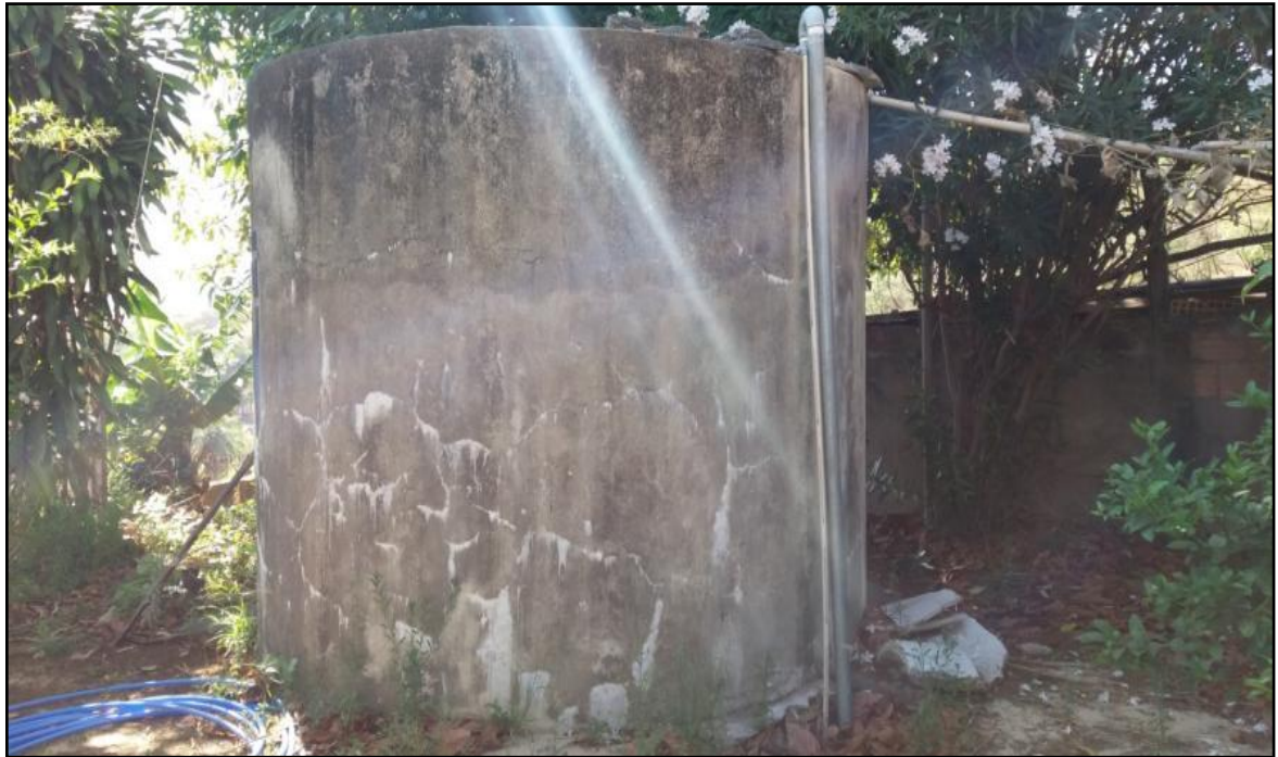
Figura 83: Reservatório para atender o bairro Maravilhas
