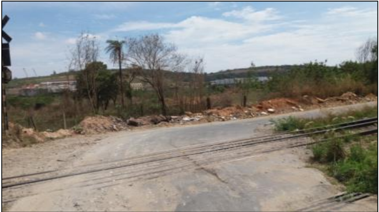
Figura 150: Disposição inadequada de RCC ao lado da linha férrea
