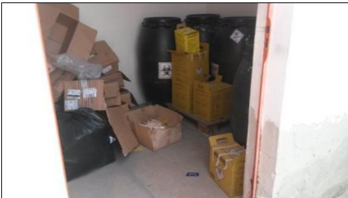
Figura 135: Acondicionamento dos RSS na Policlínica
