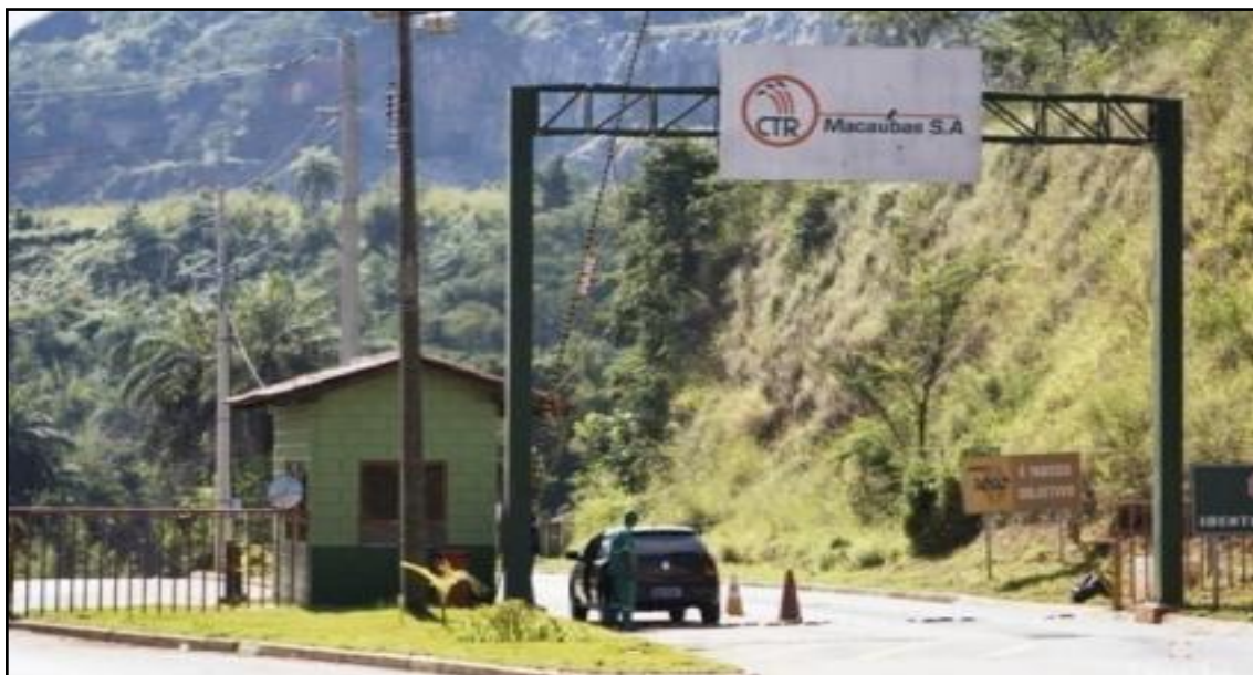
Figura 131: Central de tratamento de resíduos Macaúbas
