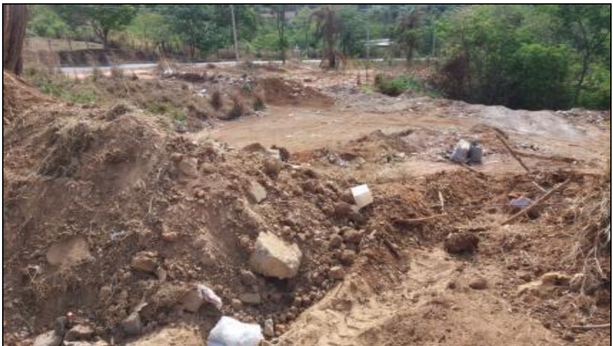
Figura 148: Bota fora de RCC
