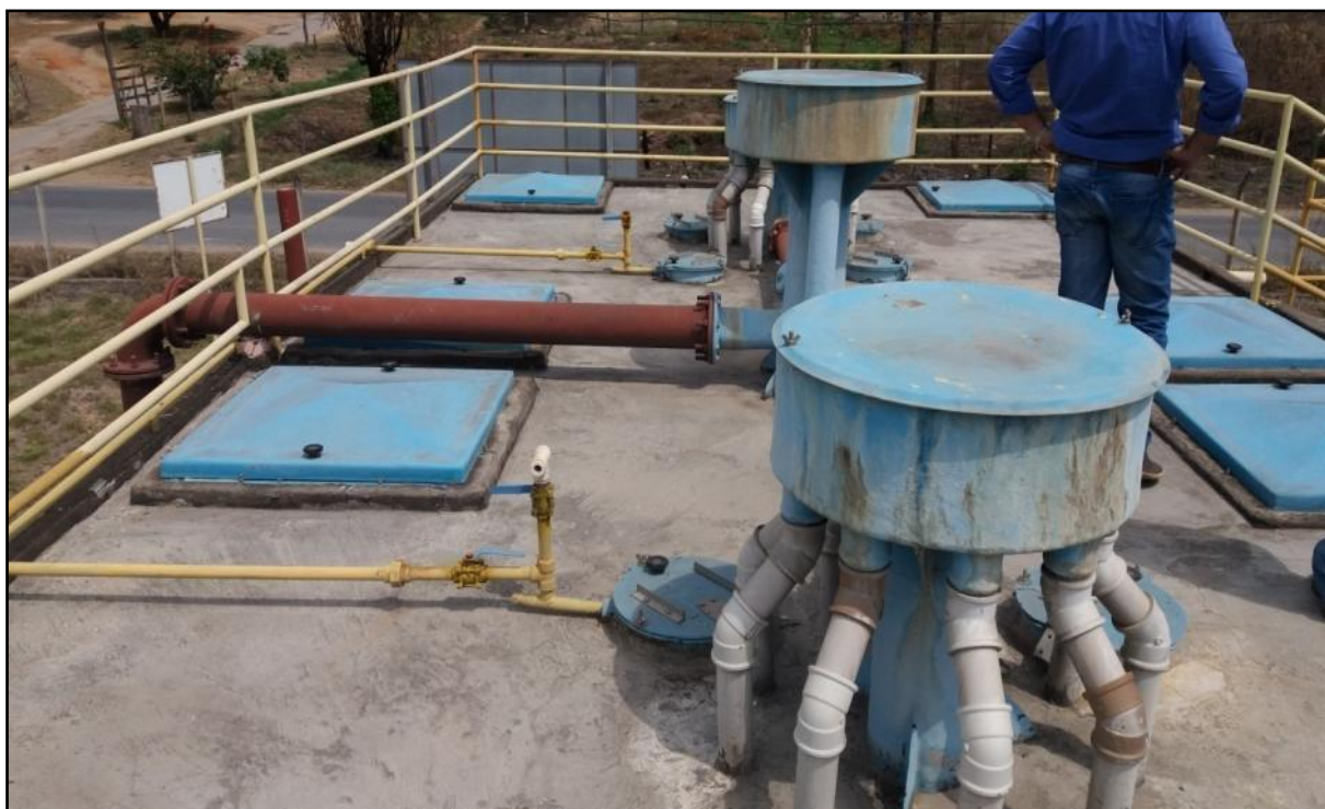
Figura 108: Reator UASB da ETE de Maravilhas e Inácia de Carvalho
