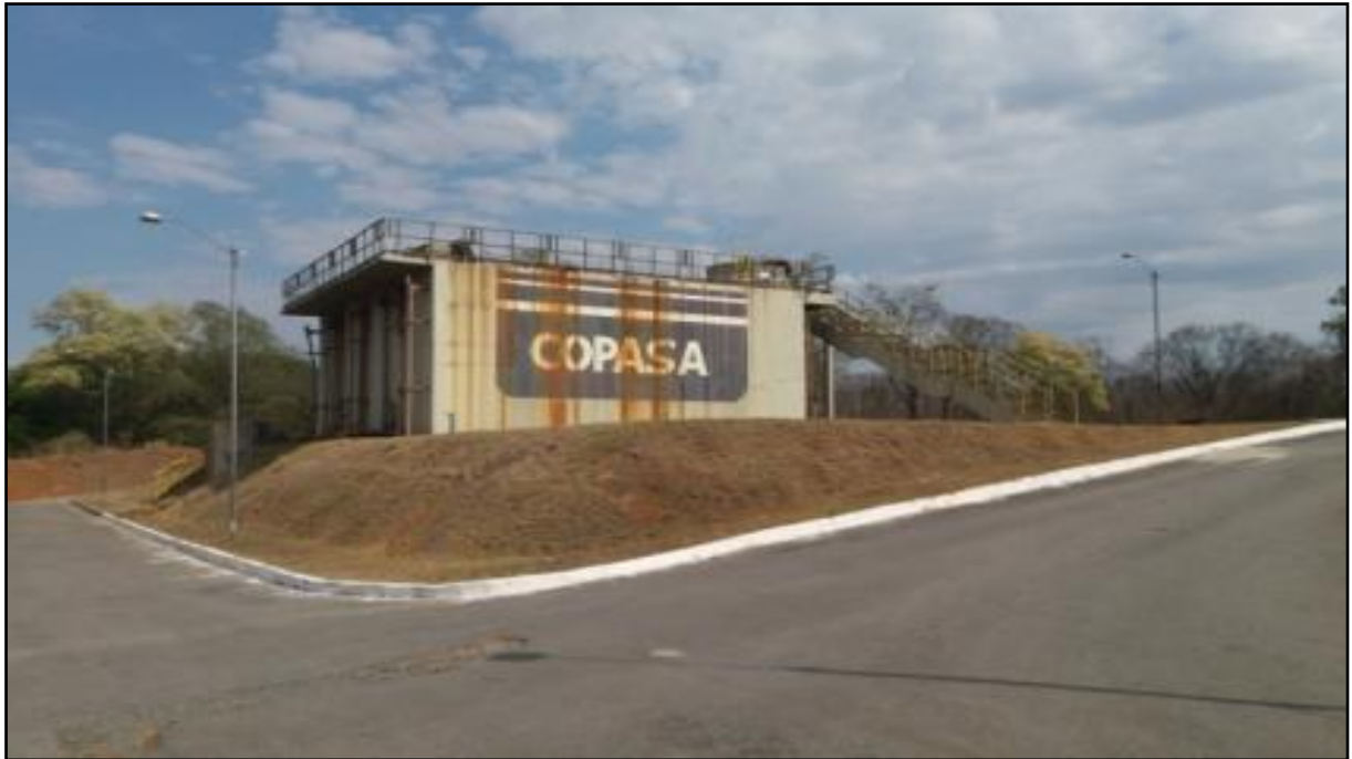
Figura 98: Reator UASB, tratamento primário da ETE da sede
