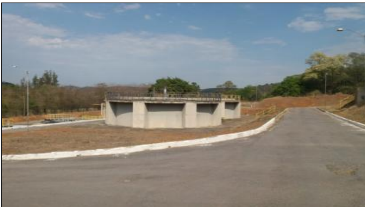
Figura 100: Filtro biológico percolador, tratamento secundário da ETE da sede
