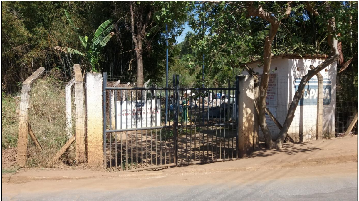
Figura 72: Poço C-01 bairro Inácia de Carvalho
