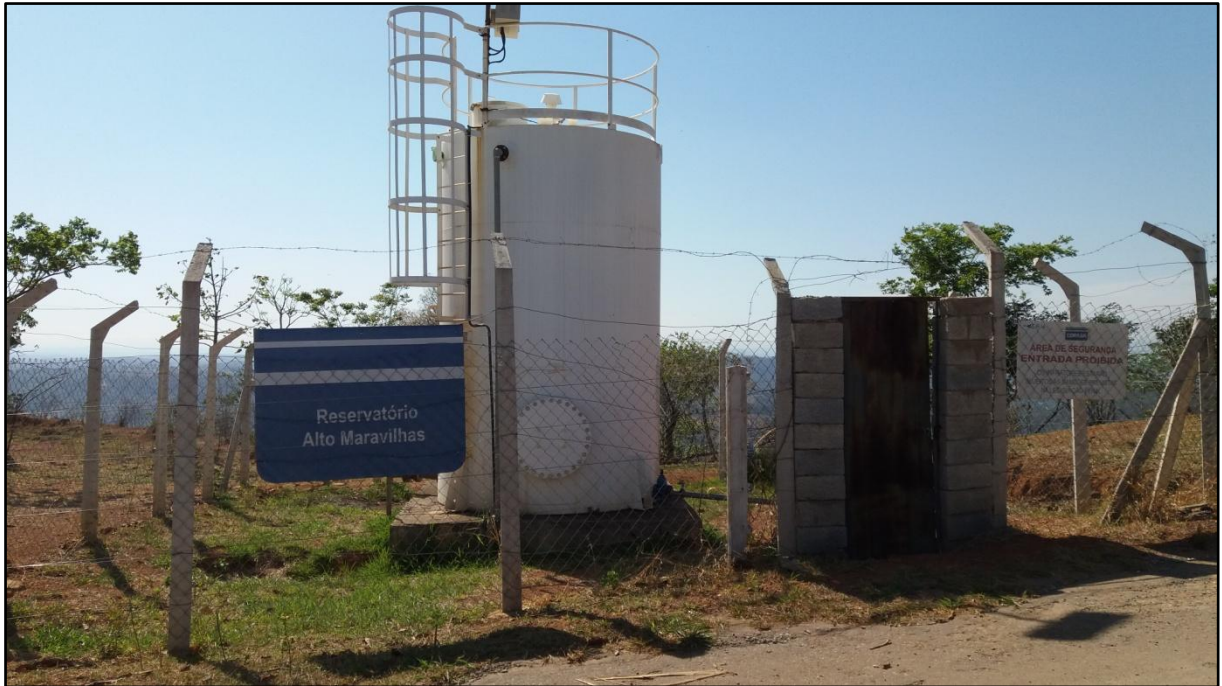
Figura 84: Reservatório para atender alto Maravilhas
