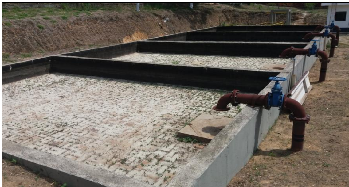
Figura 111: Leitos de secagem da ETE de Maravilhas e Inácia de Carvalho
