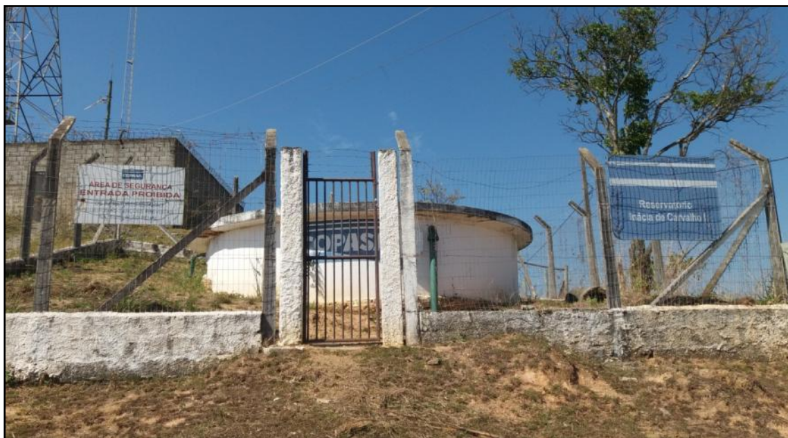
Figura 85: Reservatório para atender o bairro Inácia de Carvalho - I
