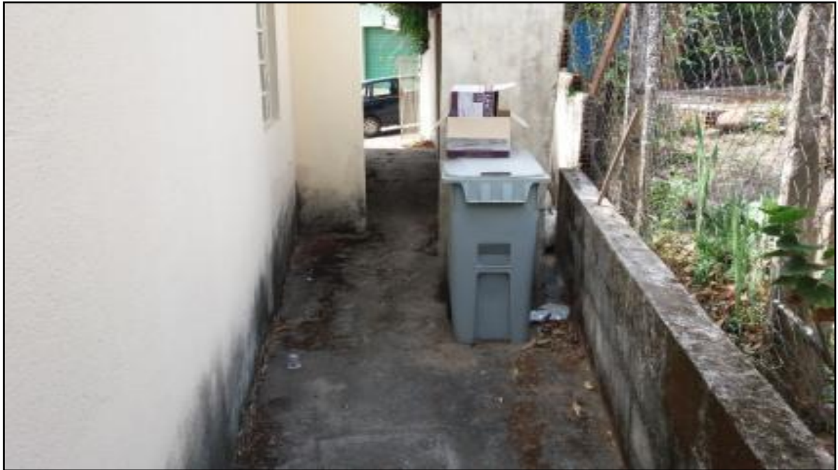
Figura 137: Acondicionamento dos RSS nas UBS
