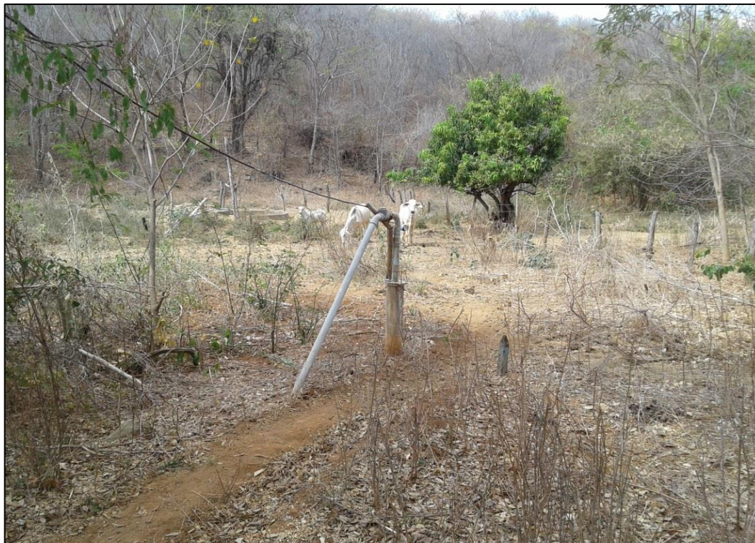
Figura 95 – Captação por poço na comunidade Monzodó. Fonte: DRZ – Geotecnologia e Consultoria, 2017.
