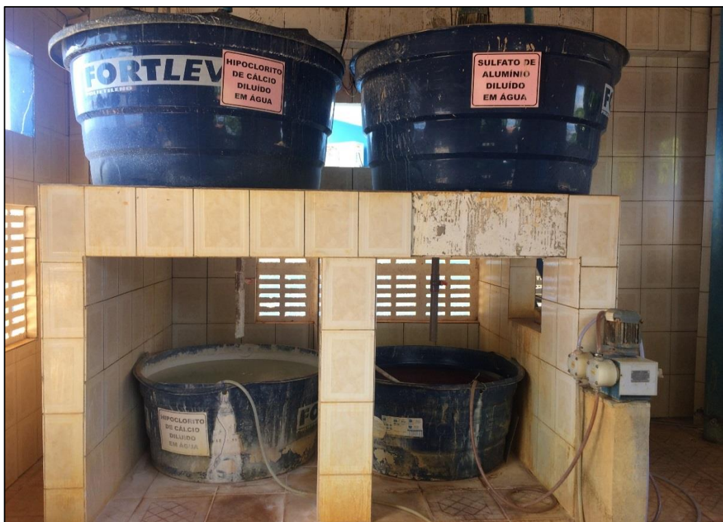
Figura 44 – Dosagem dos produtos químicos por bombas – distrito Sede Fonte: DRZ - Geotecnologia e Consultoria, 2017.
