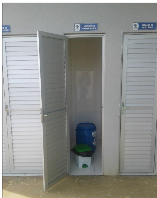
Figura 131 - Abrigo do posto de saúde para armazenamento de resíduos. Fonte: DRZ – Geotecnologia e Consultoria, 2017.
