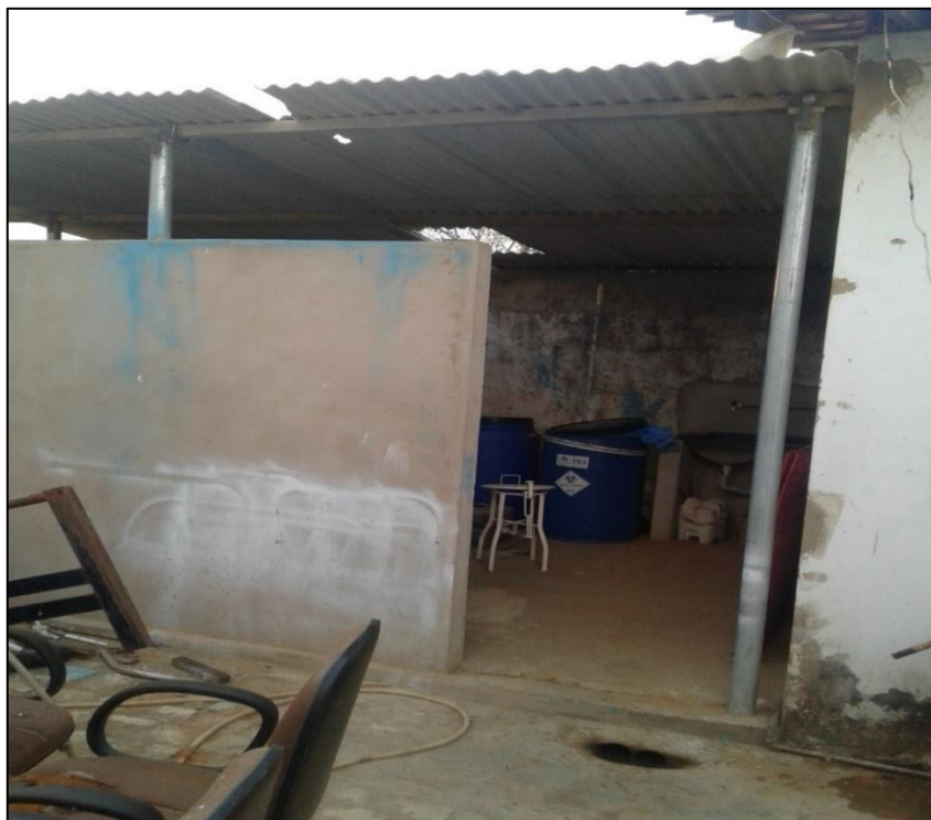
Figura 132 - Armazenamento irregular de resíduos de serviço de saúde Fonte: DRZ - Geotecnologia e Consultoria, 2017.
