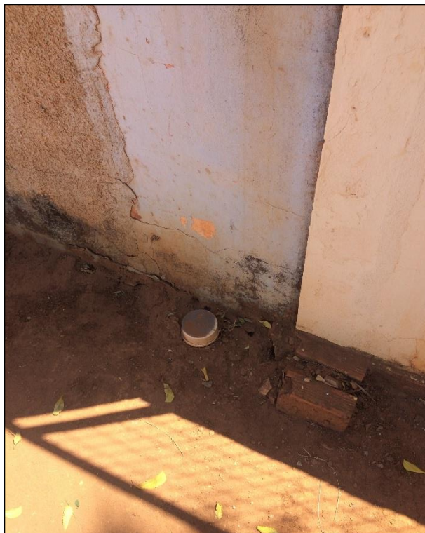
Figura 116 – Fossa na comunidade Baixa Verde. Fonte: DRZ - Geotecnologia e Consultoria, 2017.
