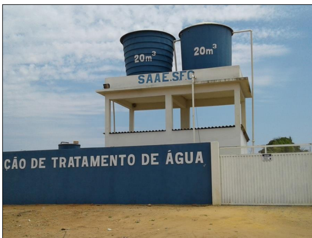
Figura 74 – Reservatório elevado - REL – ETA Entroncamento.
