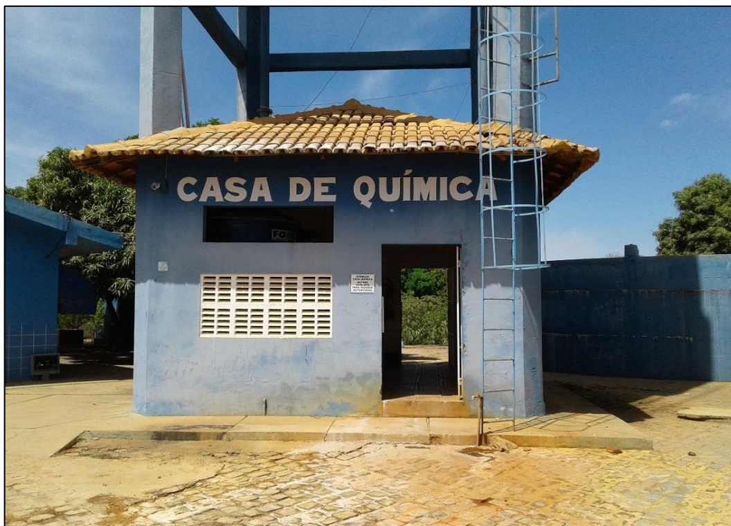
Figura 43 – Casa de química – distrito Sede. Fonte: DRZ - Geotecnologia e Consultoria, 2017.
