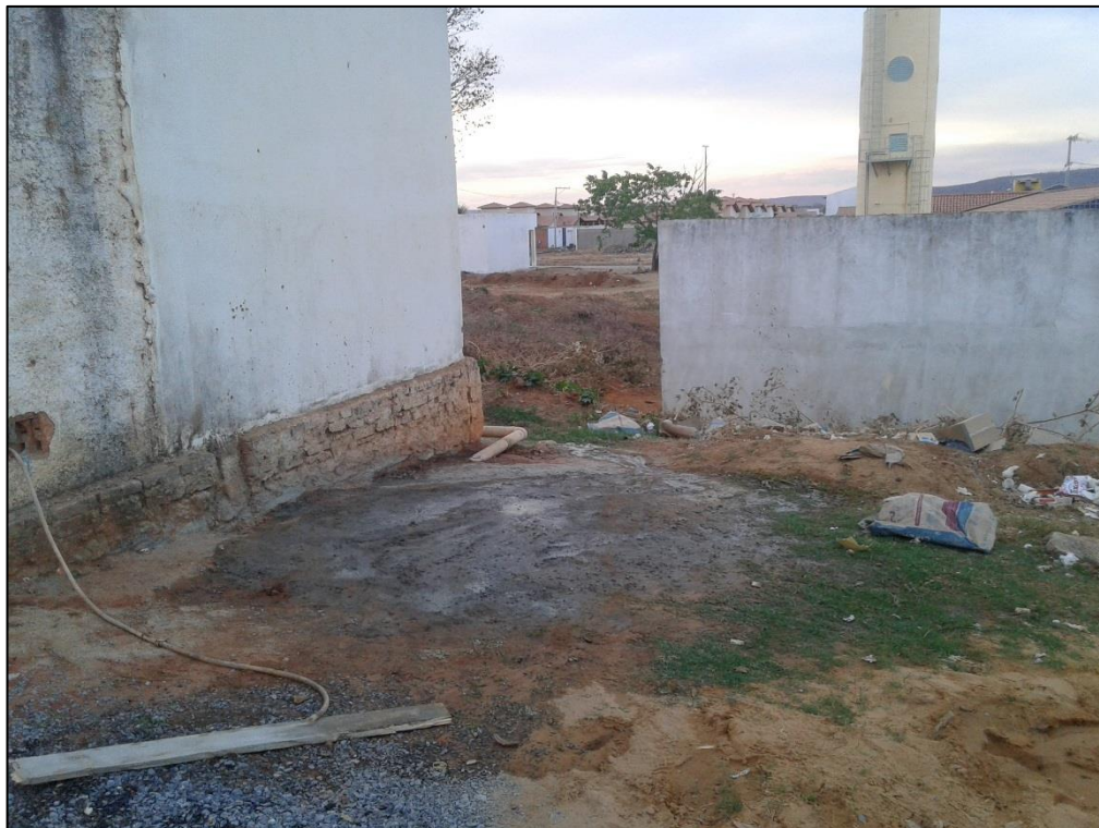
Figura 109 – Construção de fossa. Fonte: DRZ - Geotecnologia e Consultoria, 2017.
