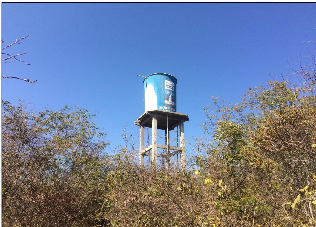
Figura 99 – REL de fibra de vidro da comunidade Rumo Novo. Fonte: DRZ – Geotecnologia e Consultoria, 2017.
