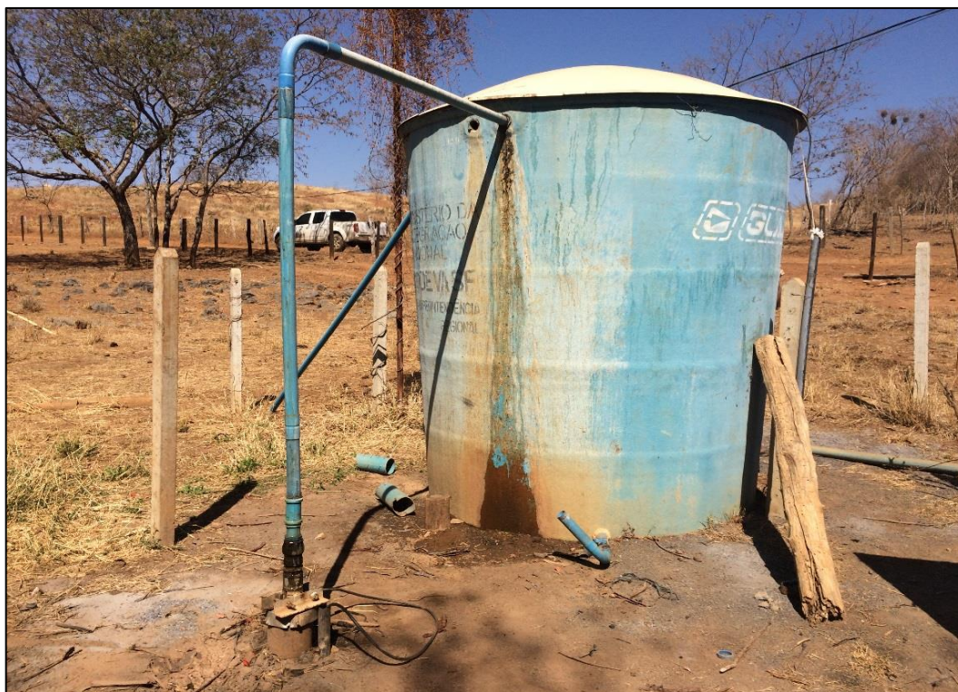
Figura 98 – Captação por poço e RAP da comunidade Rumo Novo. Fonte: DRZ – Geotecnologia e Consultoria, 2017.
