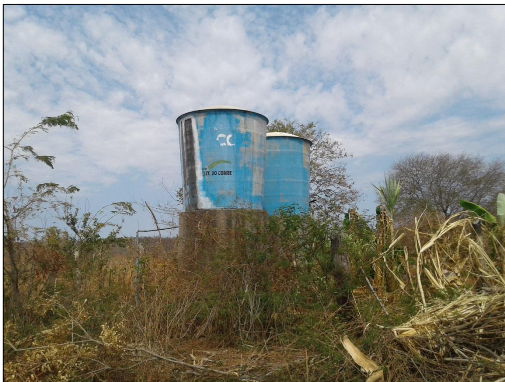
Figura 90 – REL de fibra de vidro da comunidade Caracol. Fonte: DRZ – Geotecnologia e Consultoria, 2017.
