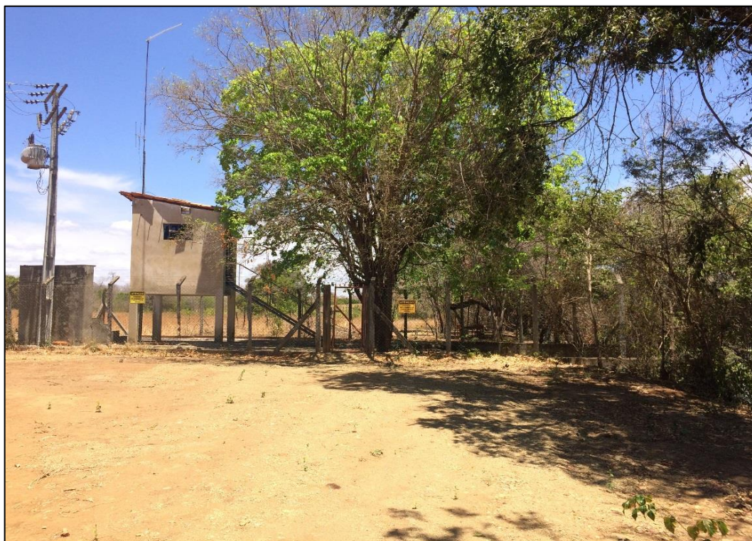
Figura 33 – Casa de controle - Captação superficial no rio Corrente – distrito Sede.
