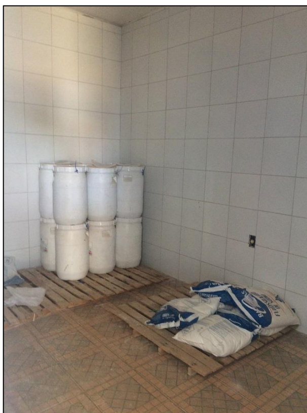
Figura 48 – Depósito de cloro e flúor. Fonte: DRZ - Geotecnologia e Consultoria, 2017.
