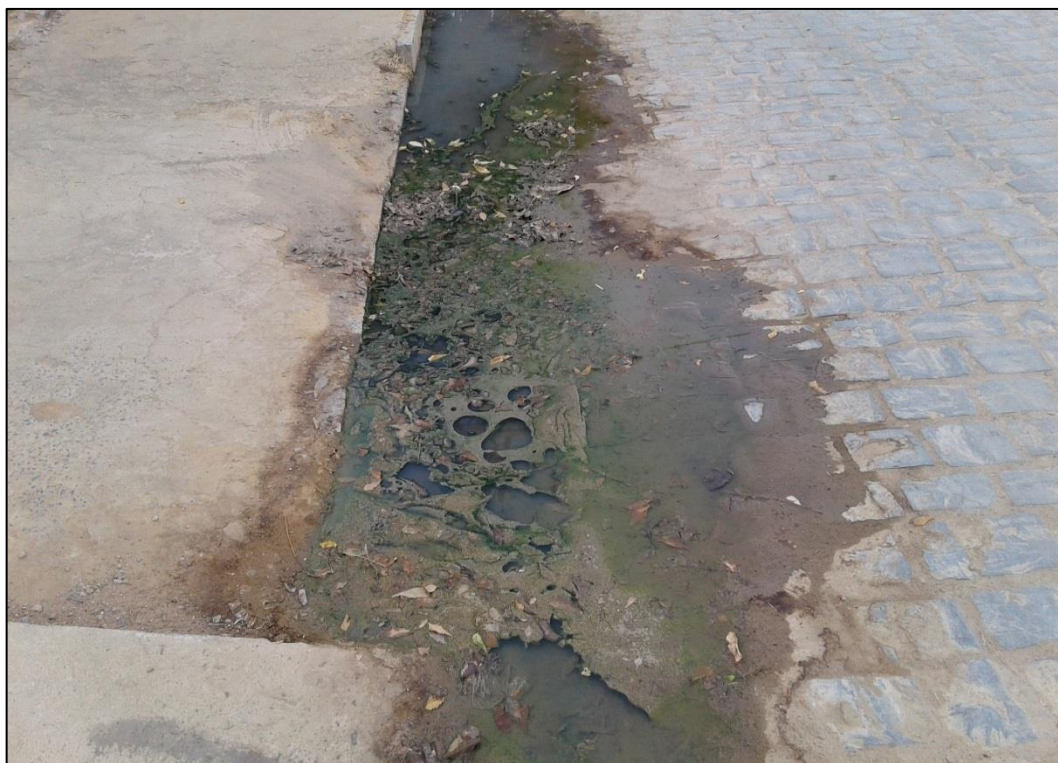
Figura 107 – Lançamento de esgoto na sarjeta. Fonte: DRZ - Geotecnologia e Consultoria, 2017.
