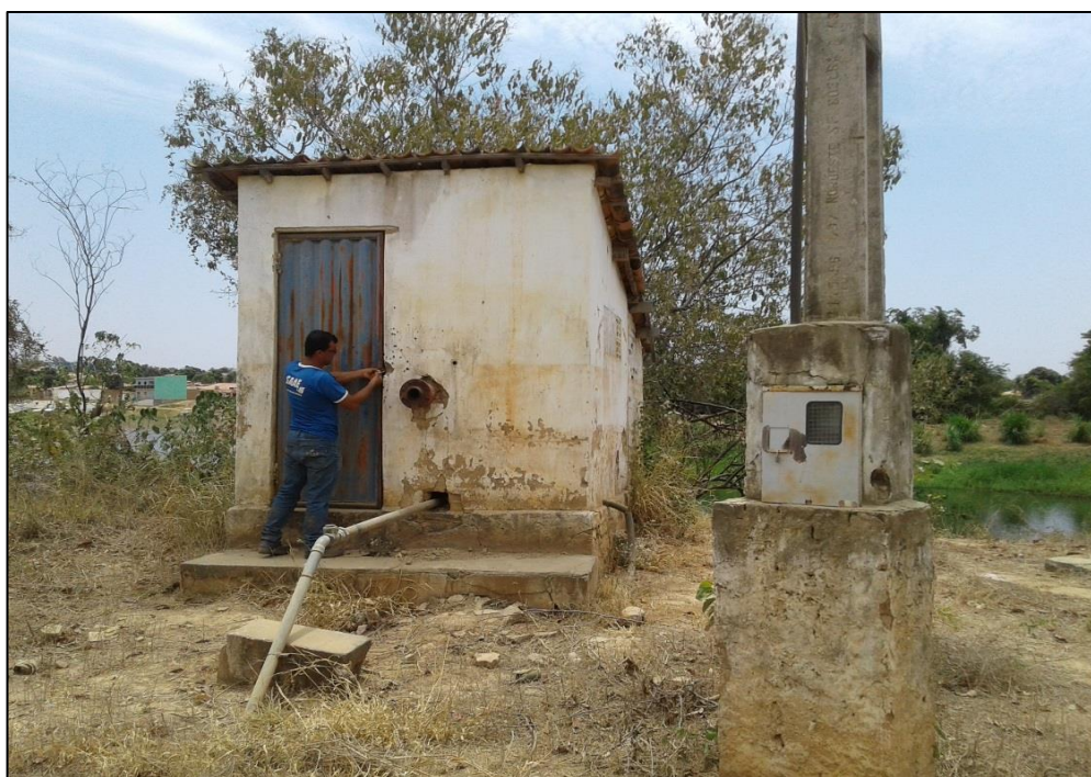
Figura 62 – Casa de controle - Captação superficial no rio Corrente – Povoado Entroncamento. Fonte: DRZ - Geotecnologia e Consultoria, 2017.
