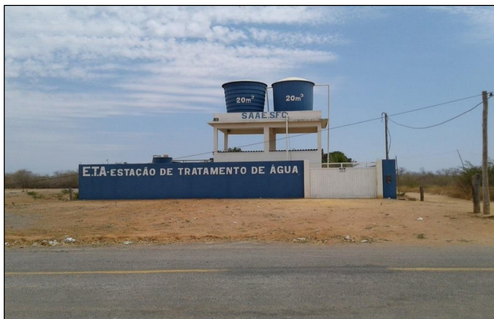
Figura 65 – Vista frontal da ETA do Entroncamento. Fonte: DRZ - Geotecnologia e Consultoria, 2017.
