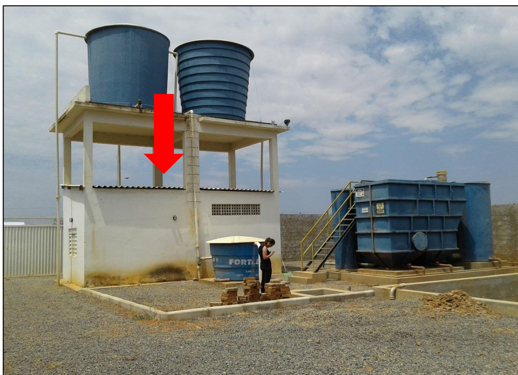
Figura 69 – Casa de química da ETA – Entroncamento. Fonte: DRZ - Geotecnologia e Consultoria, 2017.
