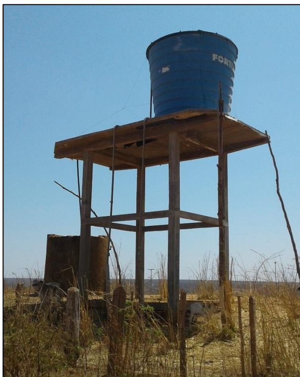
Figura 78 – REL 1 de fibra de vidro e 20 m 3 da comunidade Alagoinha. Fonte: DRZ – Geotecnologia e Consultoria, 2017.
