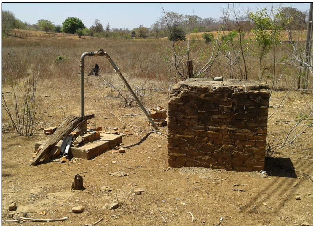
Figura 77 – Poço seco da comunidade Alagoinha.
