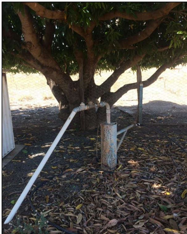
Figura 84 – Captação subterrânea da Comunidade Baixa Verde. Fonte: DRZ – Geotecnologia e Consultoria, 2017.
