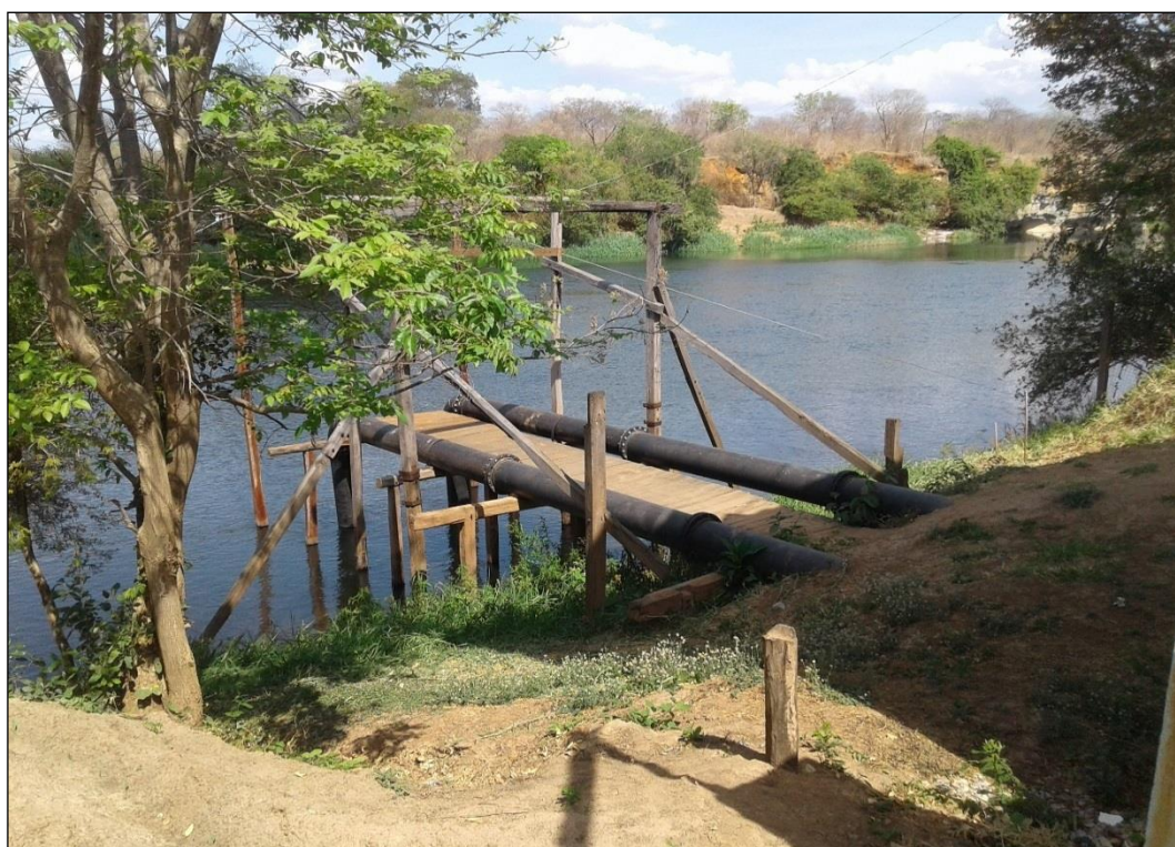
Figura 42 – Área ao entorno da captação superficial no Rio Corrente - Distrito Sede. Fonte: DRZ – Geotecnologia e Consultoria, 2017.
