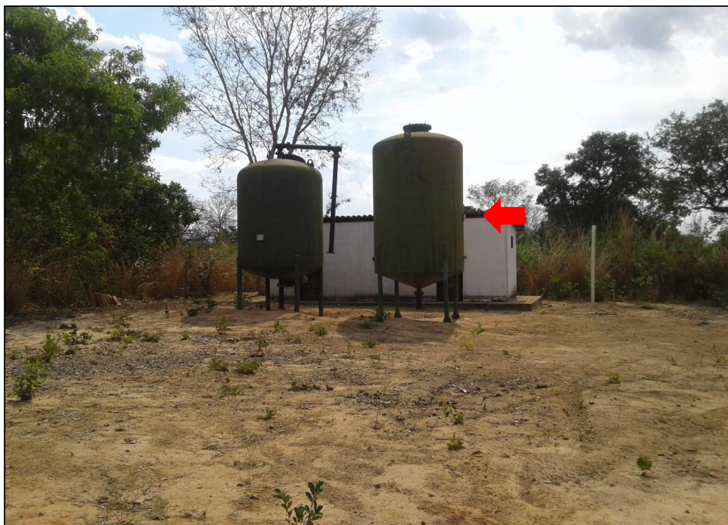
Figura 78 – Filtro Russo desativado do distrito de Inhaúmas. Fonte: DRZ – Geotecnologia e Consultoria, 2017.
