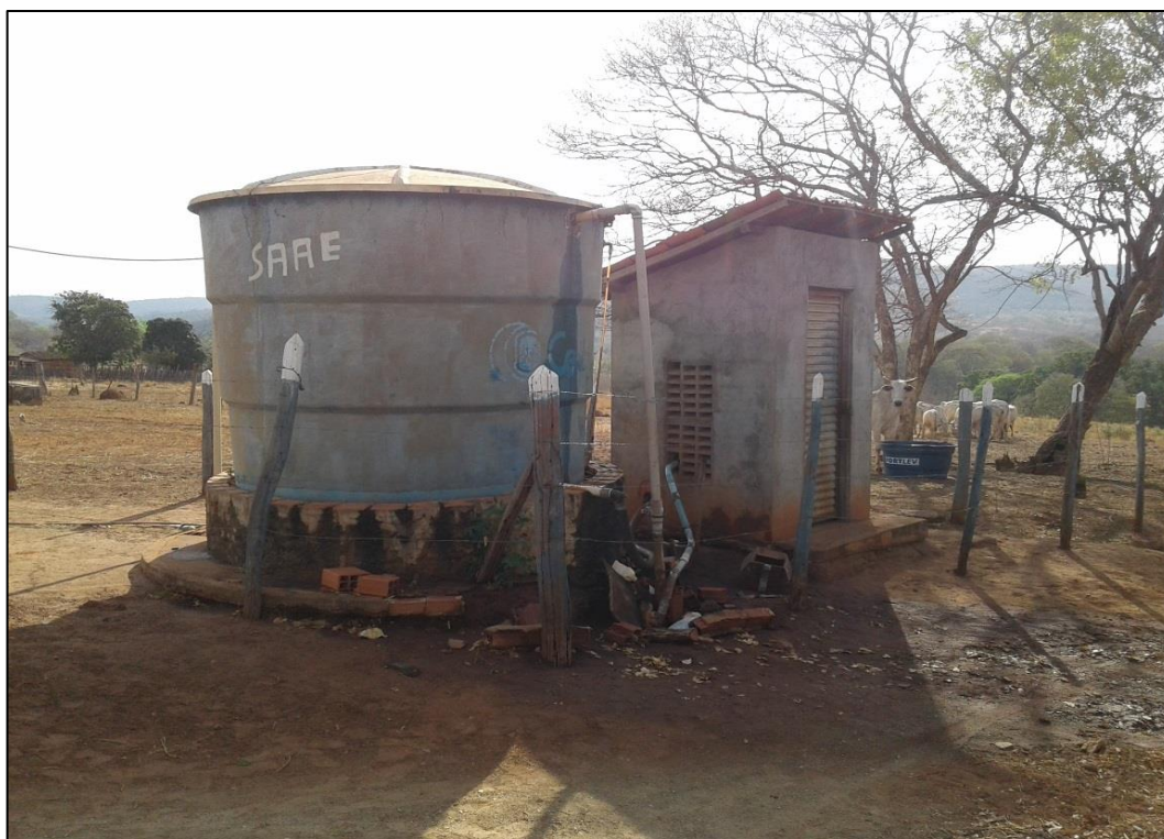
Figura 107 – RAP 3 do povoado de Montividinha, Caruaru e Currais. Fonte: DRZ – Geotecnologia e Consultoria, 2017.
