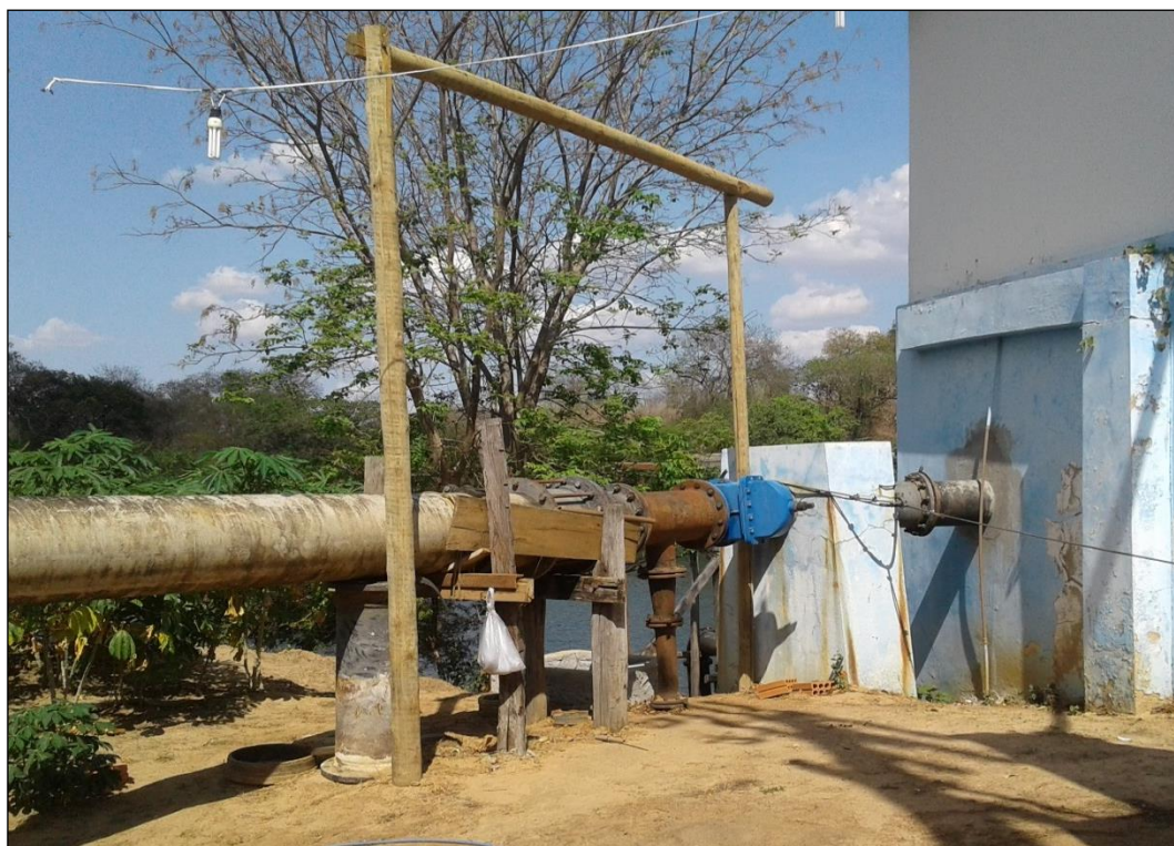
Figura 50 – Reparos na Adutora de Água Bruta. Fonte: DRZ – Geotecnologia e Consultoria, 2017.
