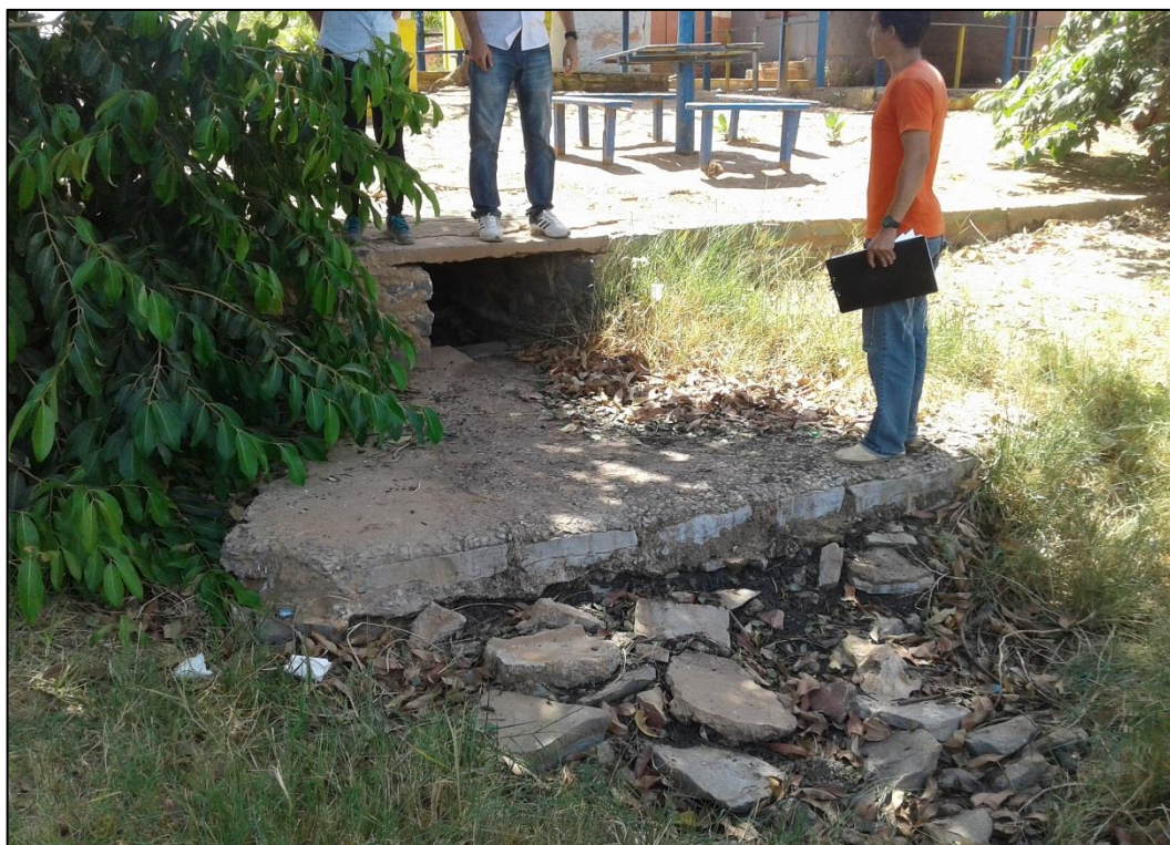
Figura 171 - Ponto de lançamento de rede de drenagem não cadastrada. Fonte: DRZ – Geotecnologia e Consultoria, 2017.
