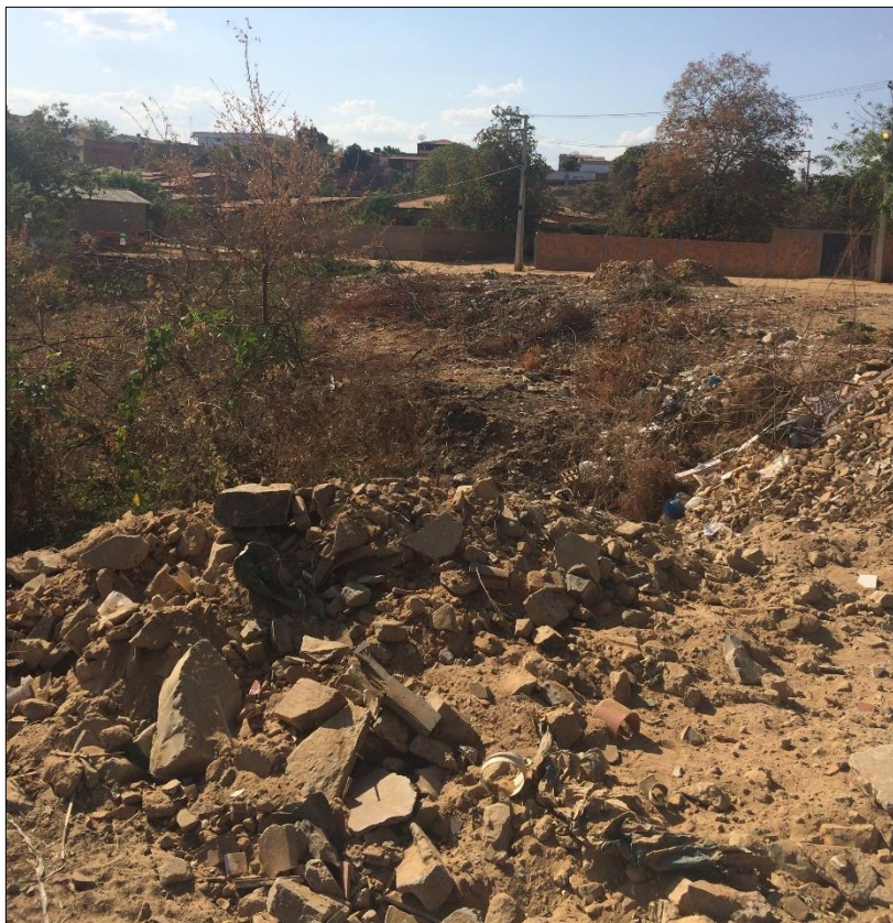
Figura 183 - Erosão da Bairro Centro. Fonte: DRZ – Geotecnologia e Consultoria, 2017.
