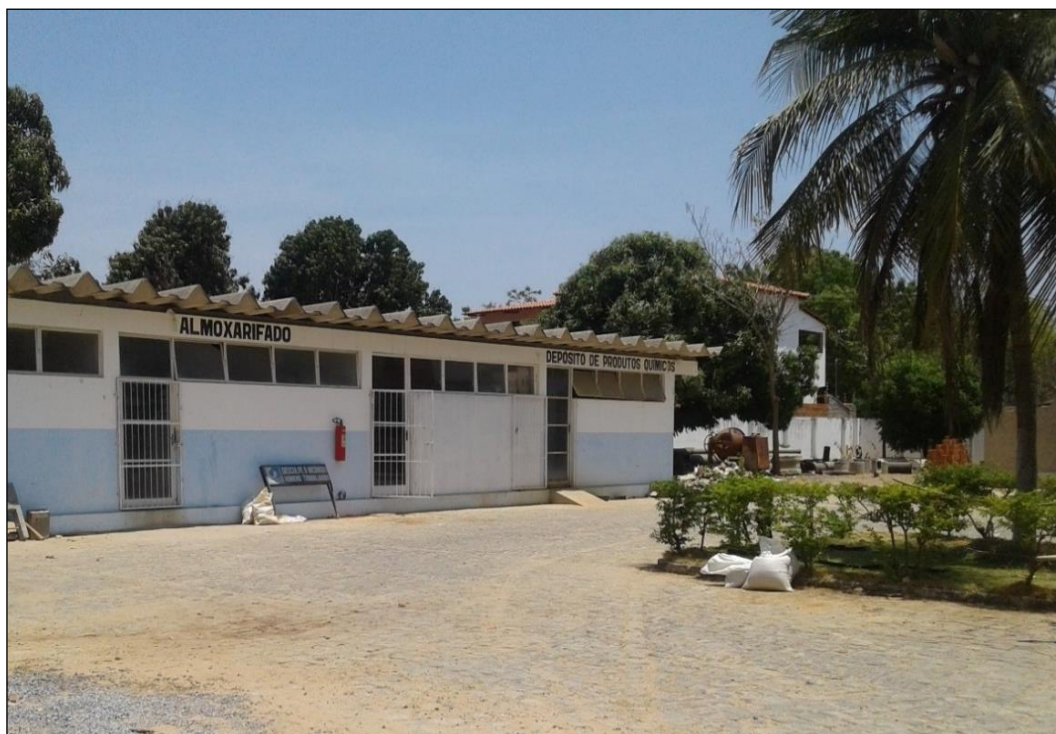
Figura 38 – Almoxarifado e depósito de produtos químicos. Fonte: DRZ – Geotecnologia e Consultoria, 2017.
