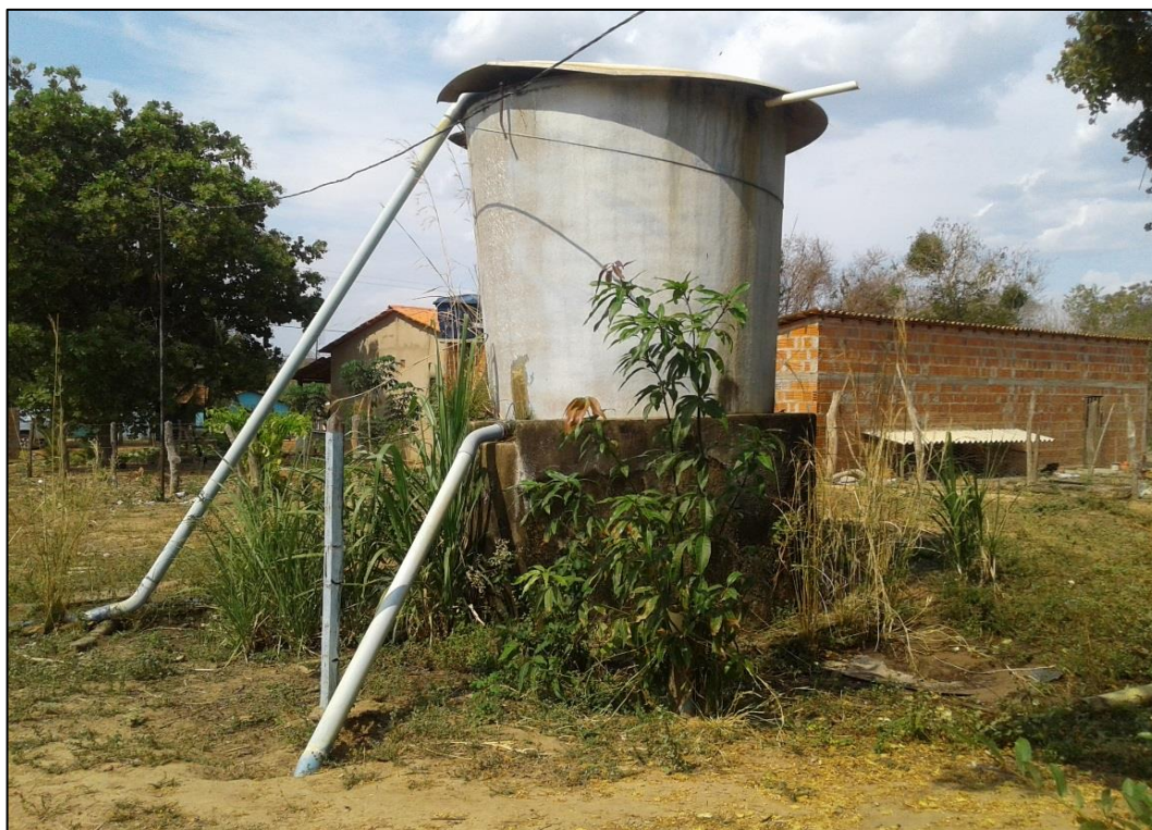
Figura 82 – REL 1 de fibra de vidro do distrito de Inhaúmas. Fonte: DRZ – Geotecnologia e Consultoria, 2017.
