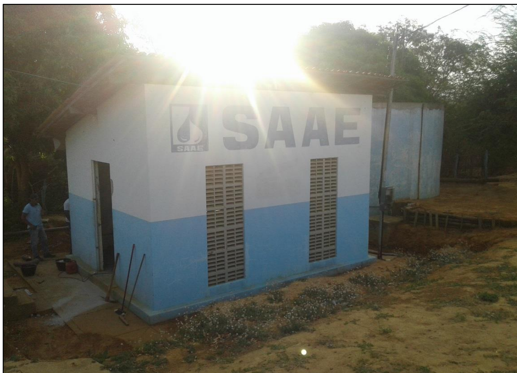
Figura 102 – Casa da bomba de recalque do povoado Cuscuzeiro. Fonte: DRZ – Geotecnologia e Consultoria, 2017.
