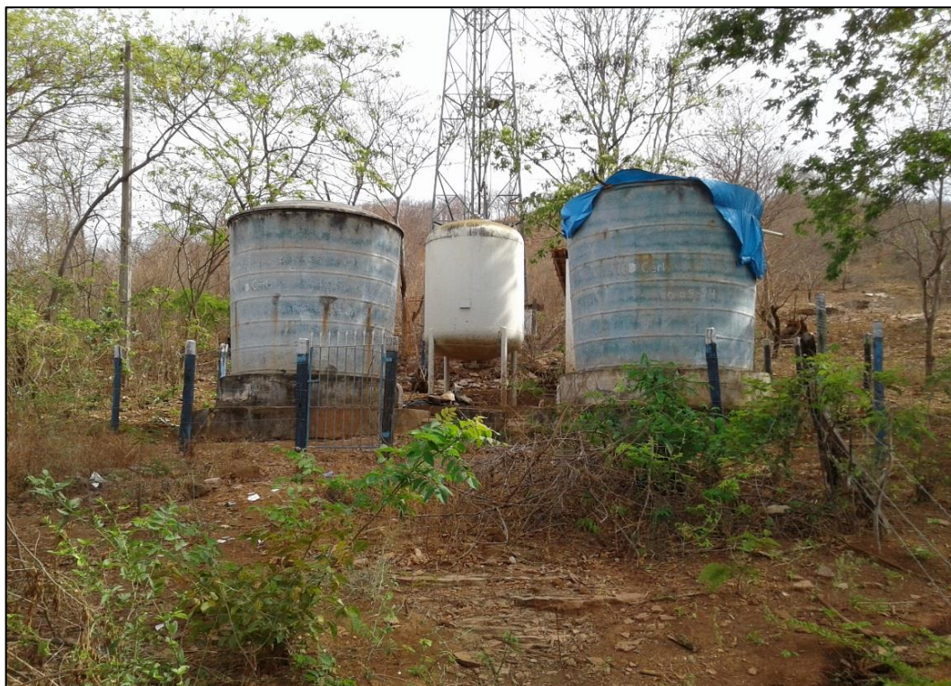
Figura 114 – RAP 1 e RAP 2 de fibra de vidro do povoado de Nova Franca. Fonte: DRZ – Geotecnologia e Consultoria, 2017.
