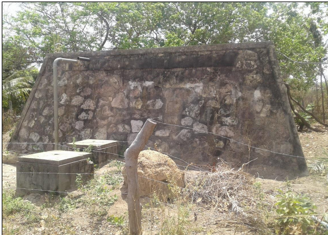
Figura 81 – RAP de pedra do distrito de Inhaúmas.
