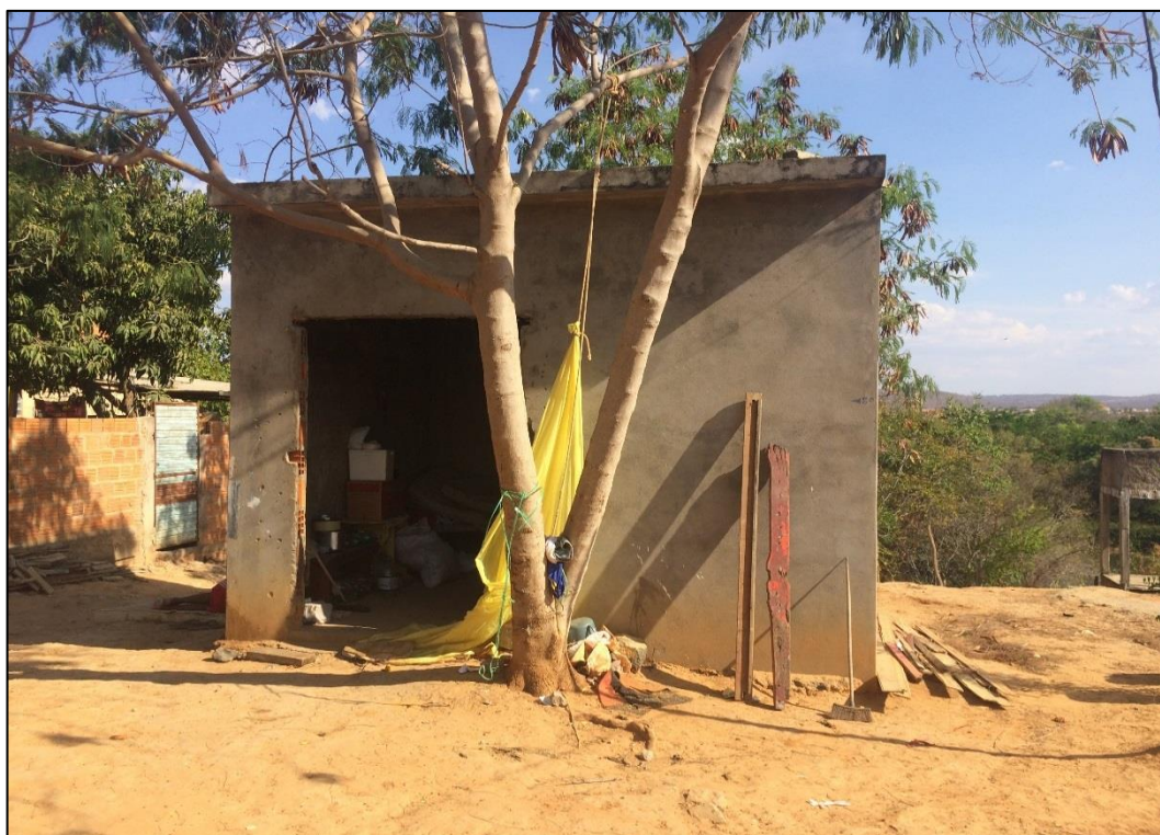
Figura 124 - EEE 1 – Bairro Sambaíba. Fonte: DRZ Geotecnologia e Consultoria, 2017.
