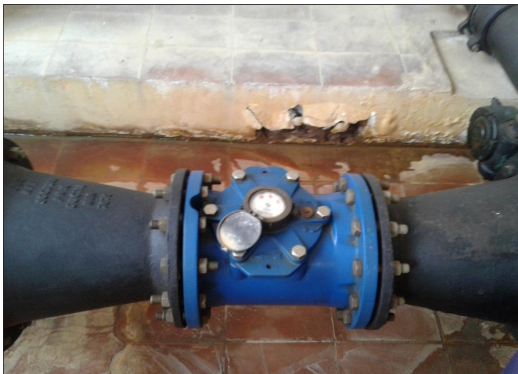
Figura 67 – Macromedidor na saída da ETA. Fonte: DRZ – Geotecnologia e Consultoria, 2017.
