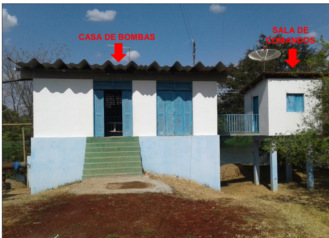
Figura 43 – Casa de bombas e sala de comando. Fonte: DRZ – Geotecnologia e Consultoria, 2017.
