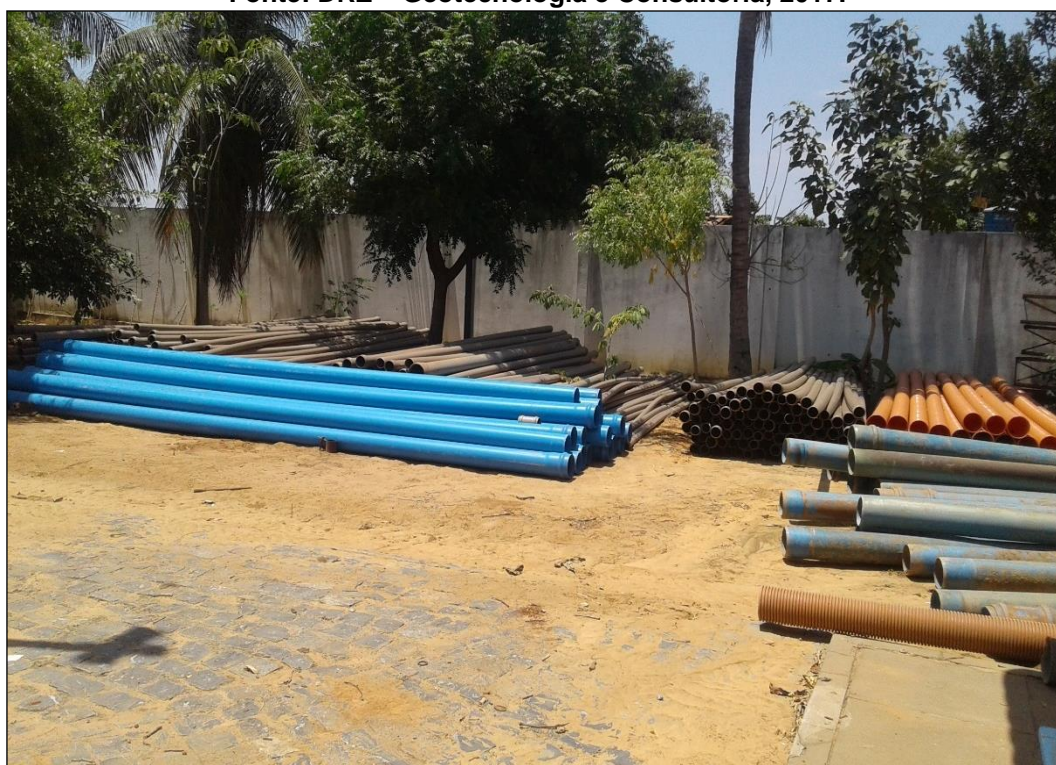
Figura 39 – Tubulações e material a ser reutilizado. Fonte: DRZ – Geotecnologia e Consultoria, 2017.
