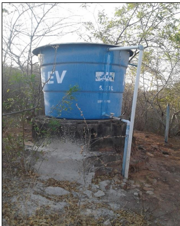
Figura 88 – REL 01 do povoado Água Quente. Fonte: DRZ – Geotecnologia e Consultoria, 2017.
