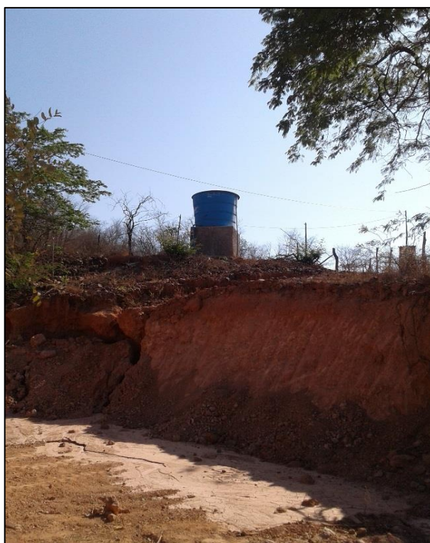
Figura 94 – REL 03 do povoado Água Quente. Fonte: DRZ – Geotecnologia e Consultoria, 2017.
