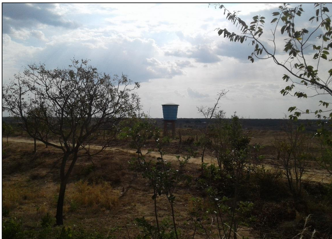
Figura 84 – REL 3 de fibra de vidro do distrito de Inhaúmas. Fonte: DRZ – Geotecnologia e Consultoria, 2017.
