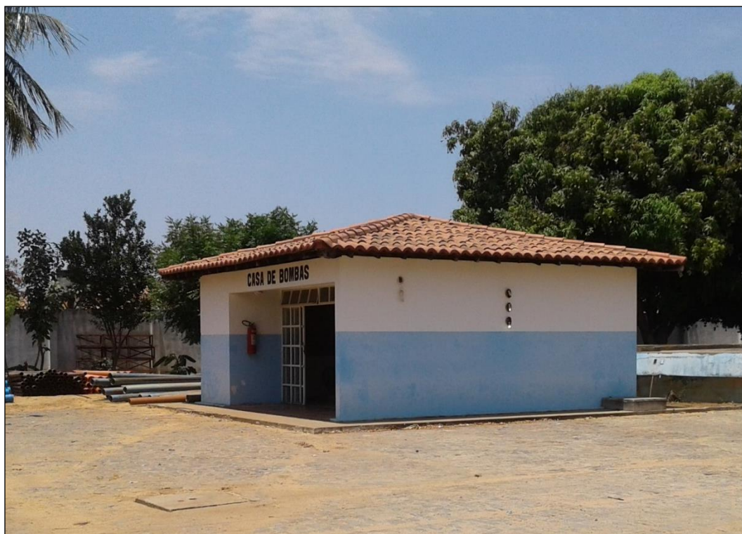
Figura 51 – Casa de bombas EEAT. Fonte: DRZ – Geotecnologia e Consultoria, 2017.
