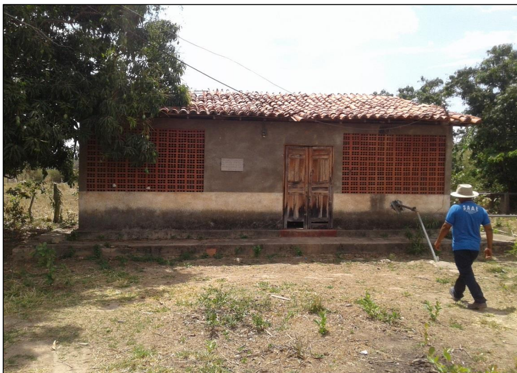
Figura 80 – Estação elevatória (EEA) do distrito de Inhaúmas. Fonte: DRZ – Geotecnologia e Consultoria, 2017.
