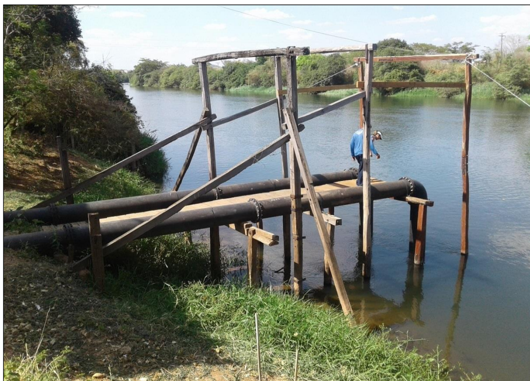
Figura 41 – Captação superficial no Rio Corrente - Distrito Sede. Fonte: DRZ – Geotecnologia e Consultoria, 2017.
