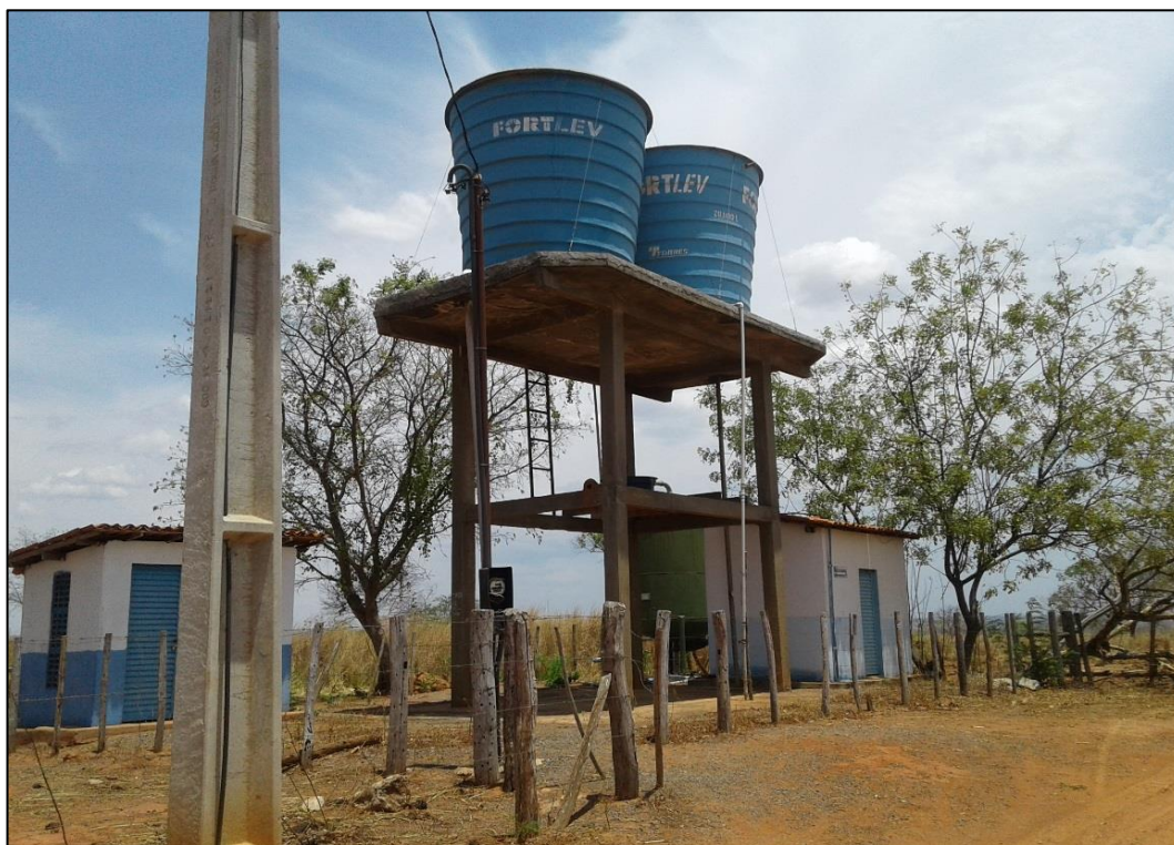
Figura 98 – ETA com REL 1 e REL 2 e filtro russo do povoado Caniveta. Fonte: DRZ – Geotecnologia e Consultoria, 2017.
