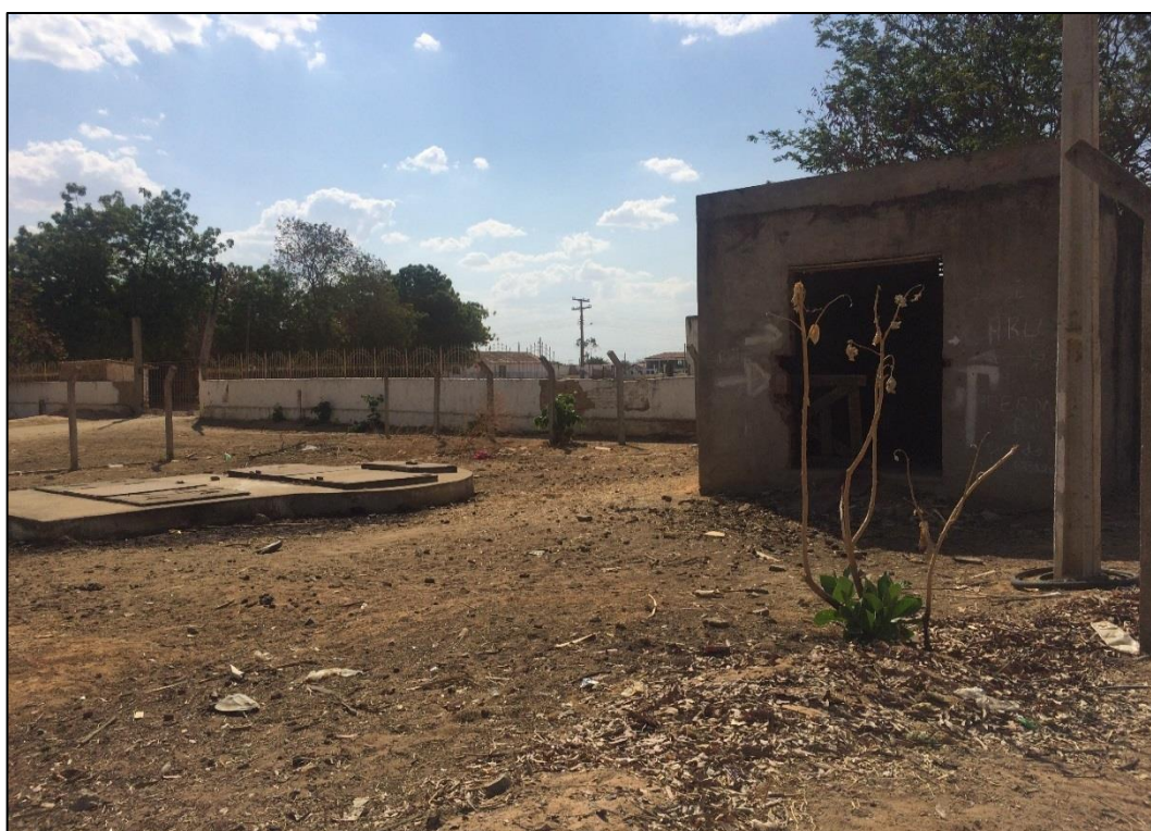
Figura 127 - EEE 5 - Parque de Exposição Fonte: DRZ Geotecnologia e Consultoria, 2017.
