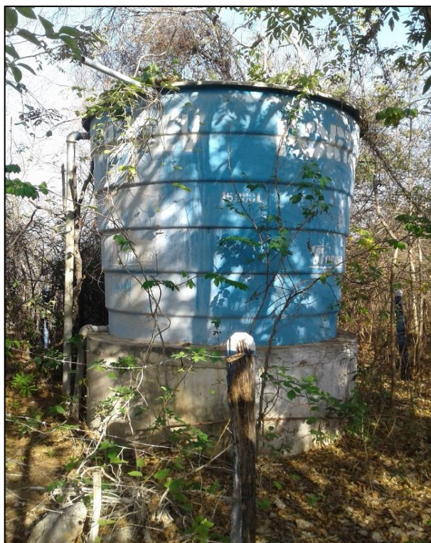
Figura 90 – REL 02 do povoado Água Quente. Fonte: DRZ – Geotecnologia e Consultoria, 2017.
