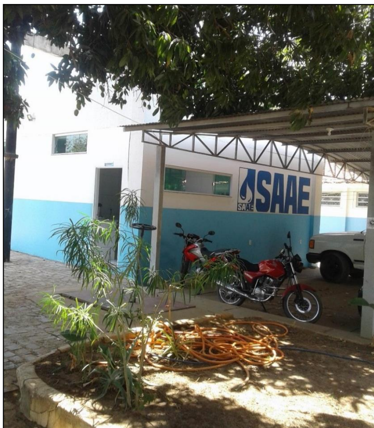
Figura 54 – Vista lateral do prédio da ETA. Fonte: DRZ – Geotecnologia e Consultoria, 2017.
