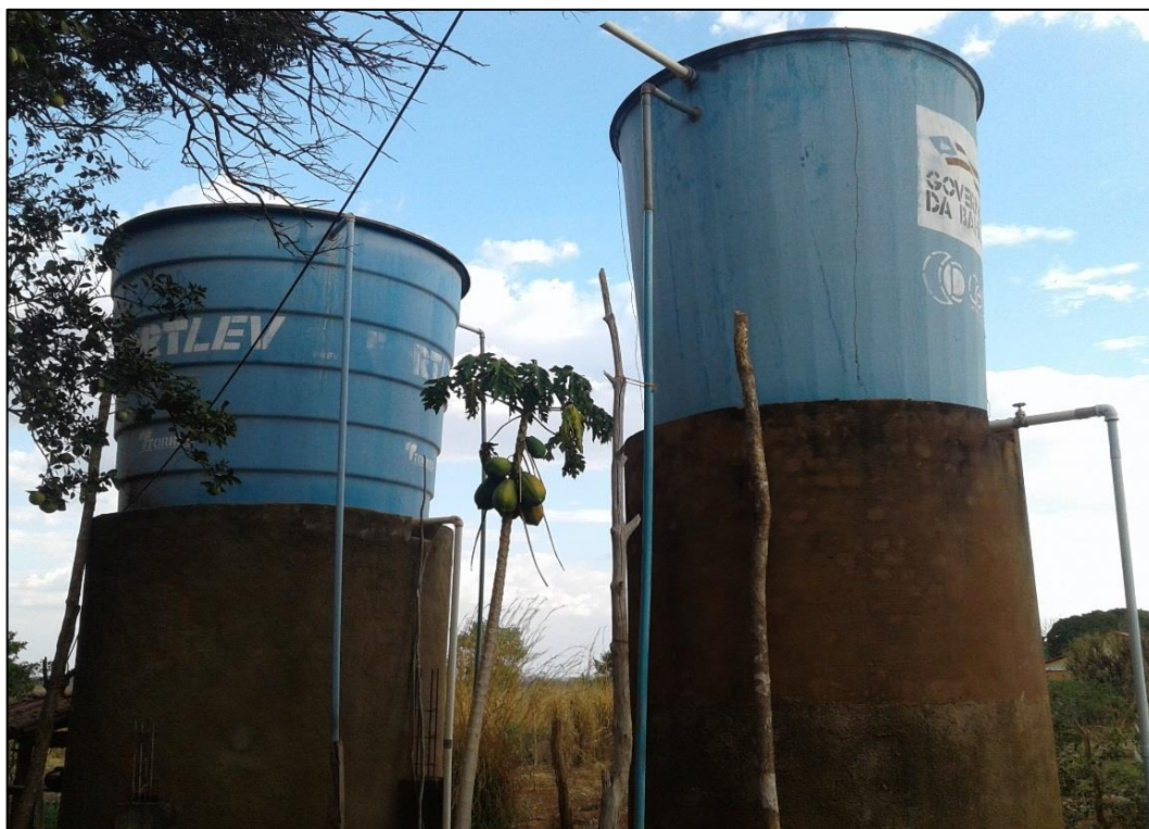
Figura 117 – REL 1 e REL 2 de fibra de vidro do povoado de Ponte Velha. Fonte: DRZ – Geotecnologia e Consultoria, 2017.
