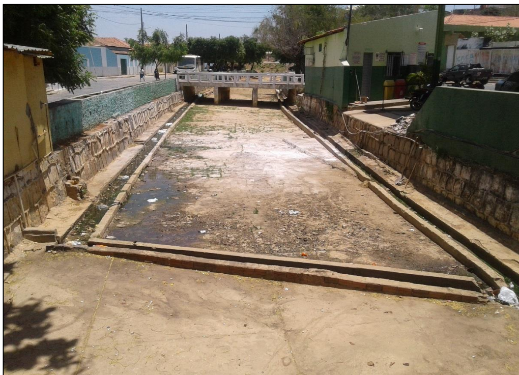
Figura 173 - Canal de macrodrenagem do Distrito Sede. Fonte: DRZ – Geotecnologia e Consultoria, 2017.
