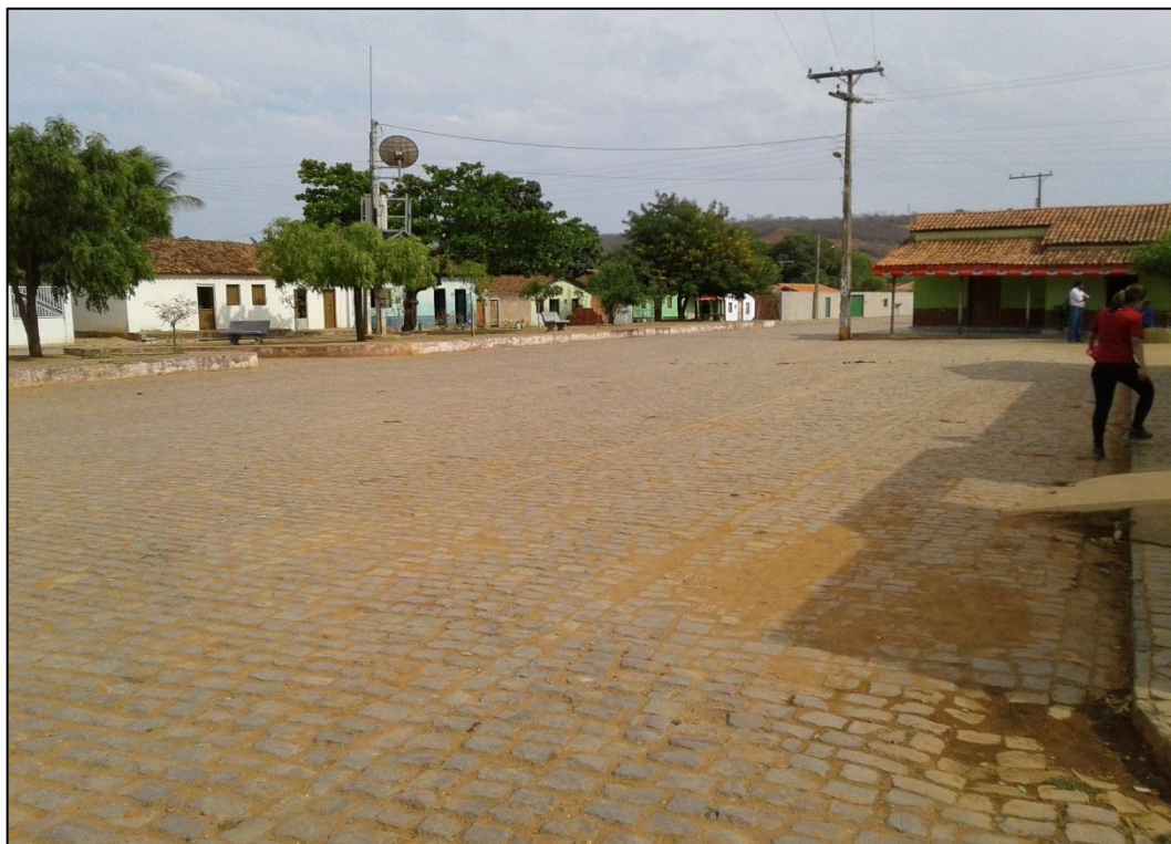
Figura 179 - Local na Comunidade Rural de Nova Franca com histórico de alagamento.
