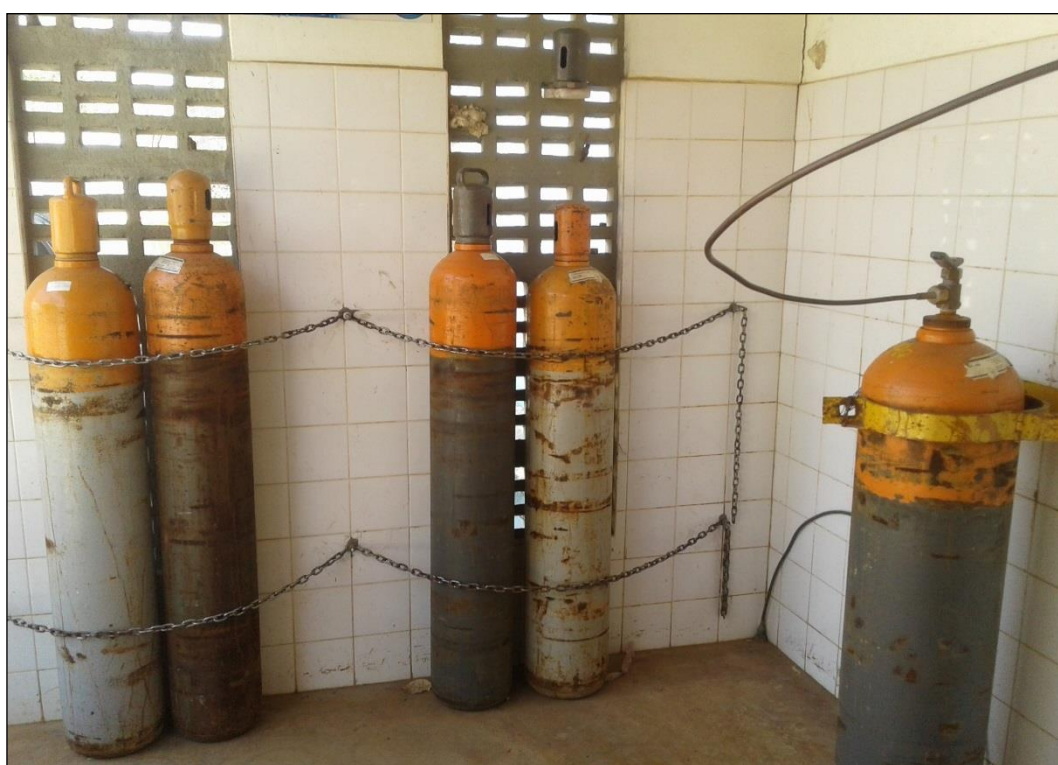
Figura 62 – Aplicação de cloro gás no tratamento. Fonte: DRZ – Geotecnologia e Consultoria, 2017.
