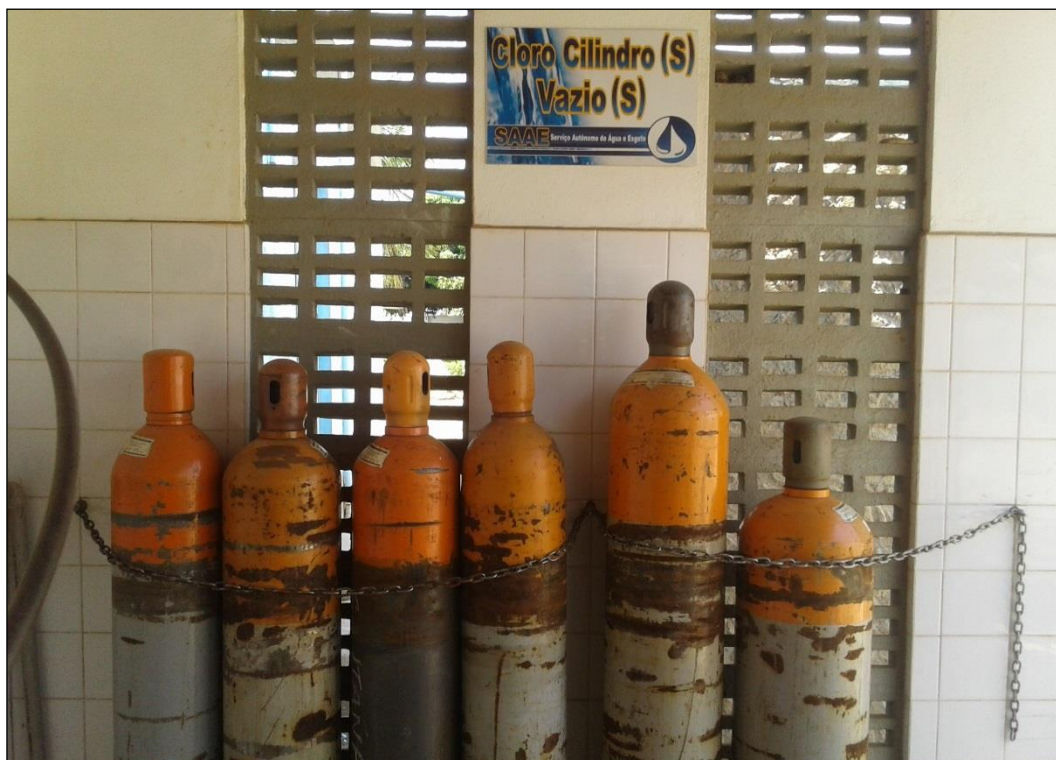
Figura 65 – Depósito de cilindros de cloro gás. Fonte: DRZ – Geotecnologia e Consultoria, 2017.
