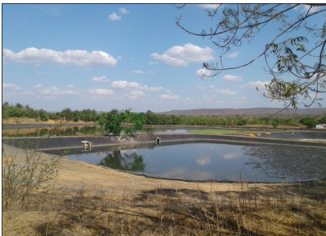
Figura 129 - Lagoas de Tratamento – ETE Fonte: DRZ Geotecnologia e Consultoria, 2017.
