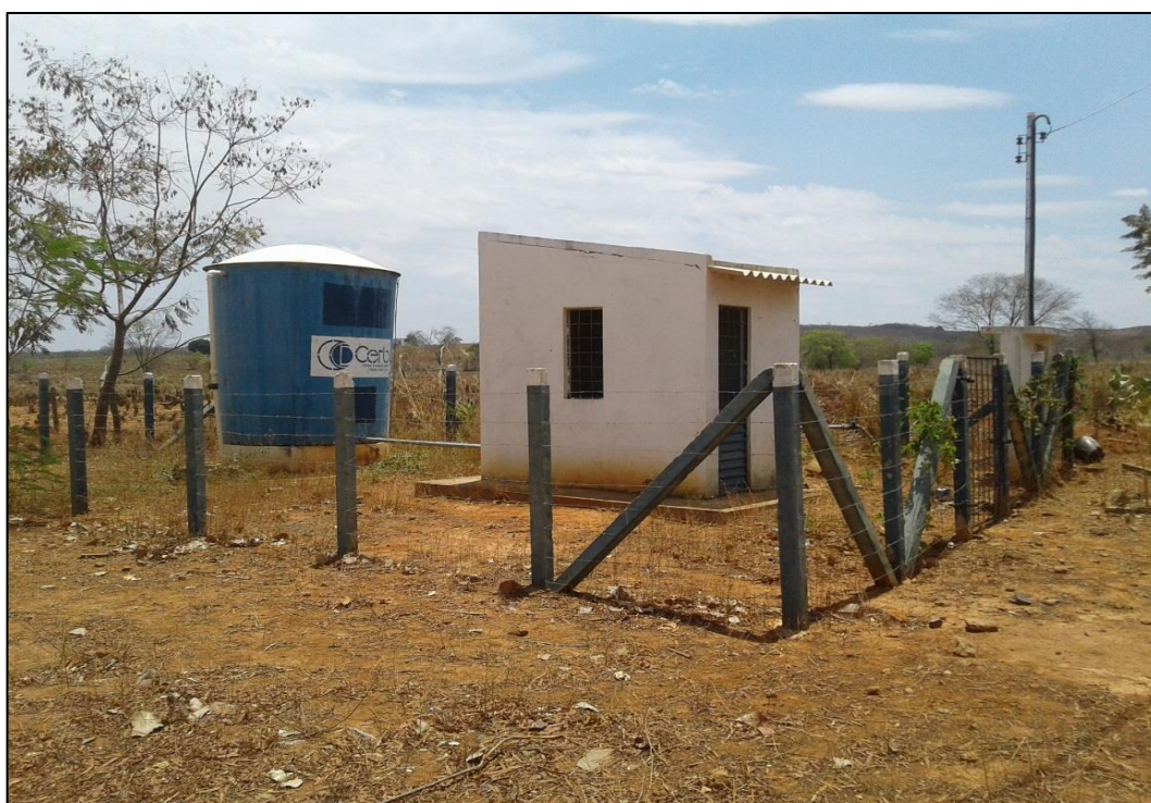
Figura 99 – RAP de fibra de vidro de 10 m 3 do povoado de Caniveta. Fonte: DRZ – Geotecnologia e Consultoria, 2017.
