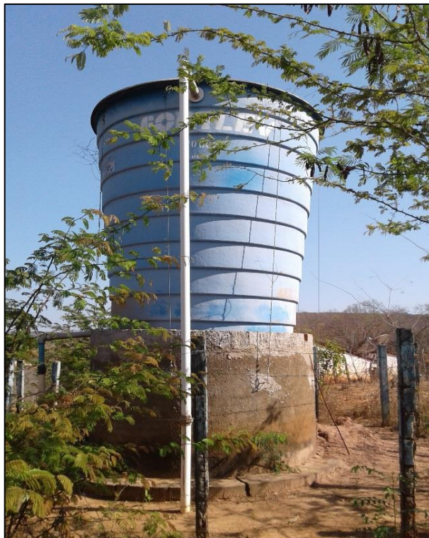
Figura 95 – REL 04 do povoado Água Quente. Fonte: DRZ – Geotecnologia e Consultoria, 2017.
