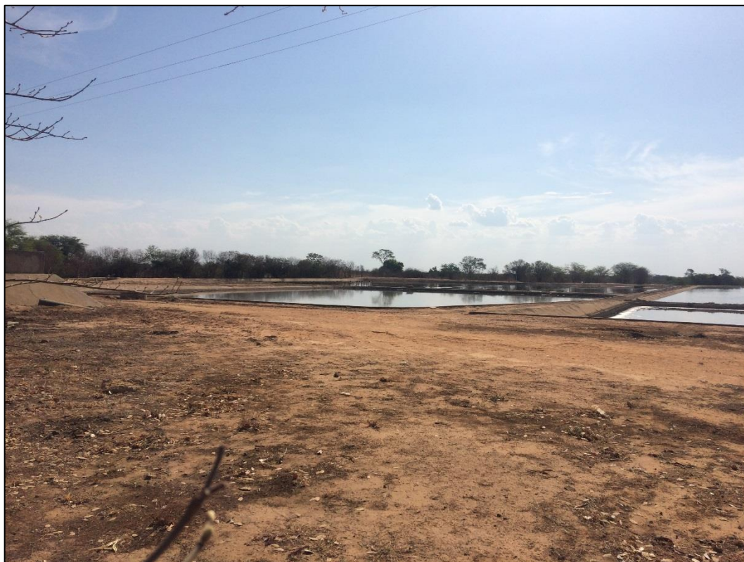
Figura 155 – Lagoas de tratamento - ETE. Fonte: DRZ – Geotecnologia e Consultoria, 2017.
