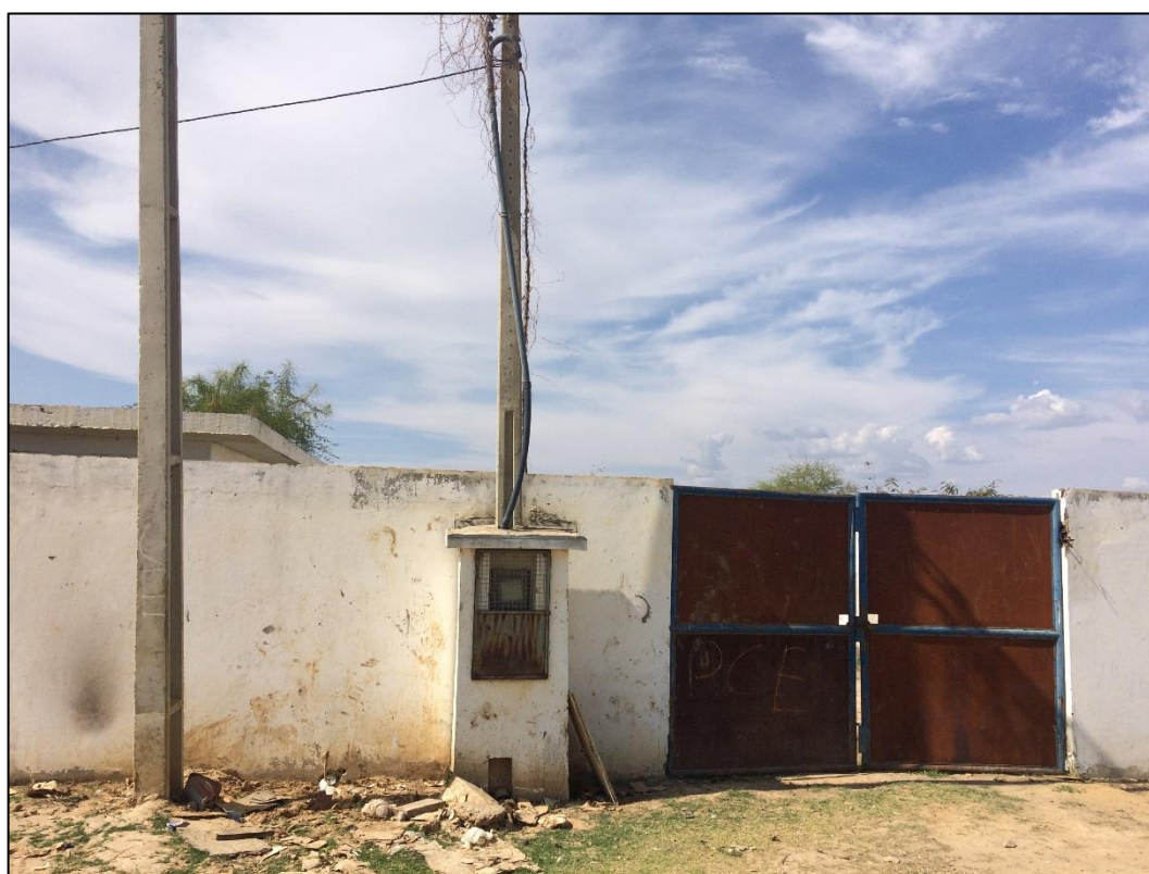
Figura 140 – EEE – Beira Rio. Fonte: DRZ – Geotecnologia e Consultoria, 2017.
