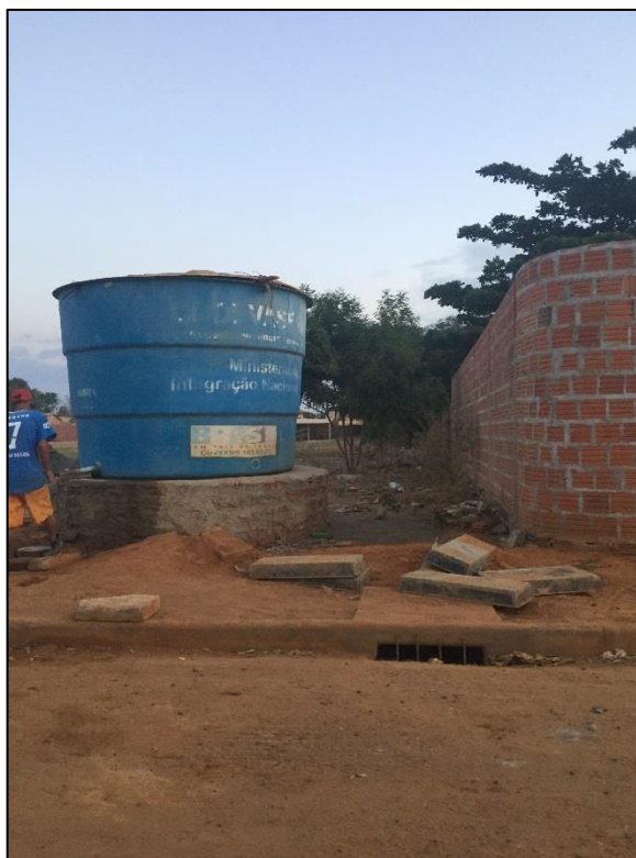
Figura 137 – RAP – 10m 3 - Setor 4. Fonte: DRZ – Geotecnia e Consultoria, 2017.
