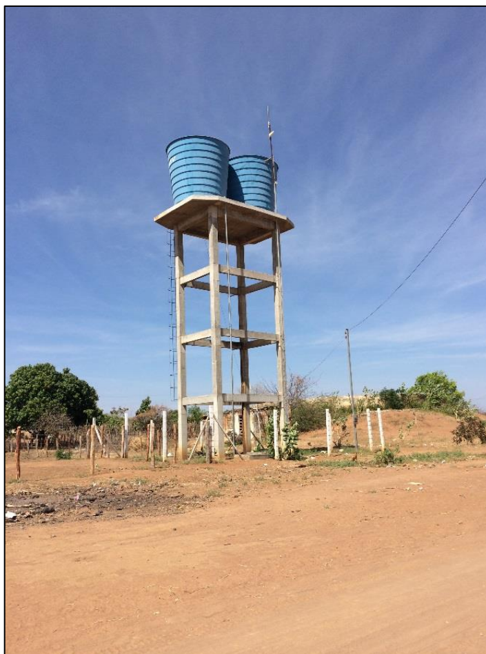
Figura 114 – REL – 30m 3 . Fonte: DRZ – Geotecnologia e Consultoria, 2017.
