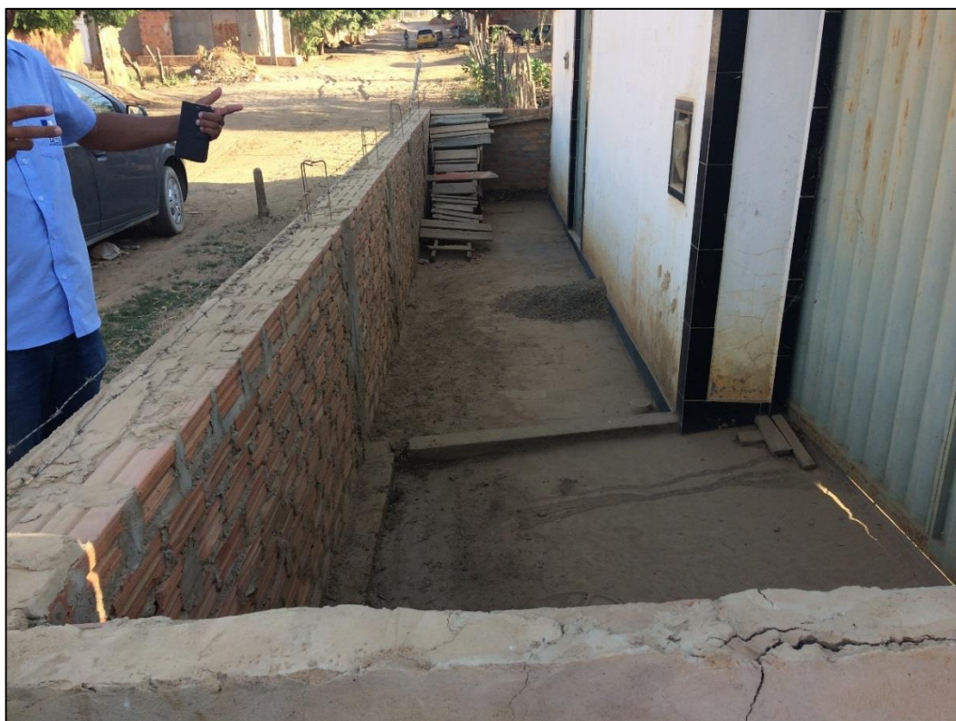
Figura 209 – Residência com barreira para impedir entrada das águas pluviais. Fonte: DRZ – Geotecnologia e Consultoria, 2017.
