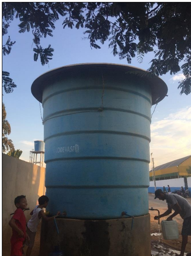
Figura 134 – RAP – 20m 3 - Setor 33. Fonte: DRZ – Geotecnologia e Consultoria, 2017.
