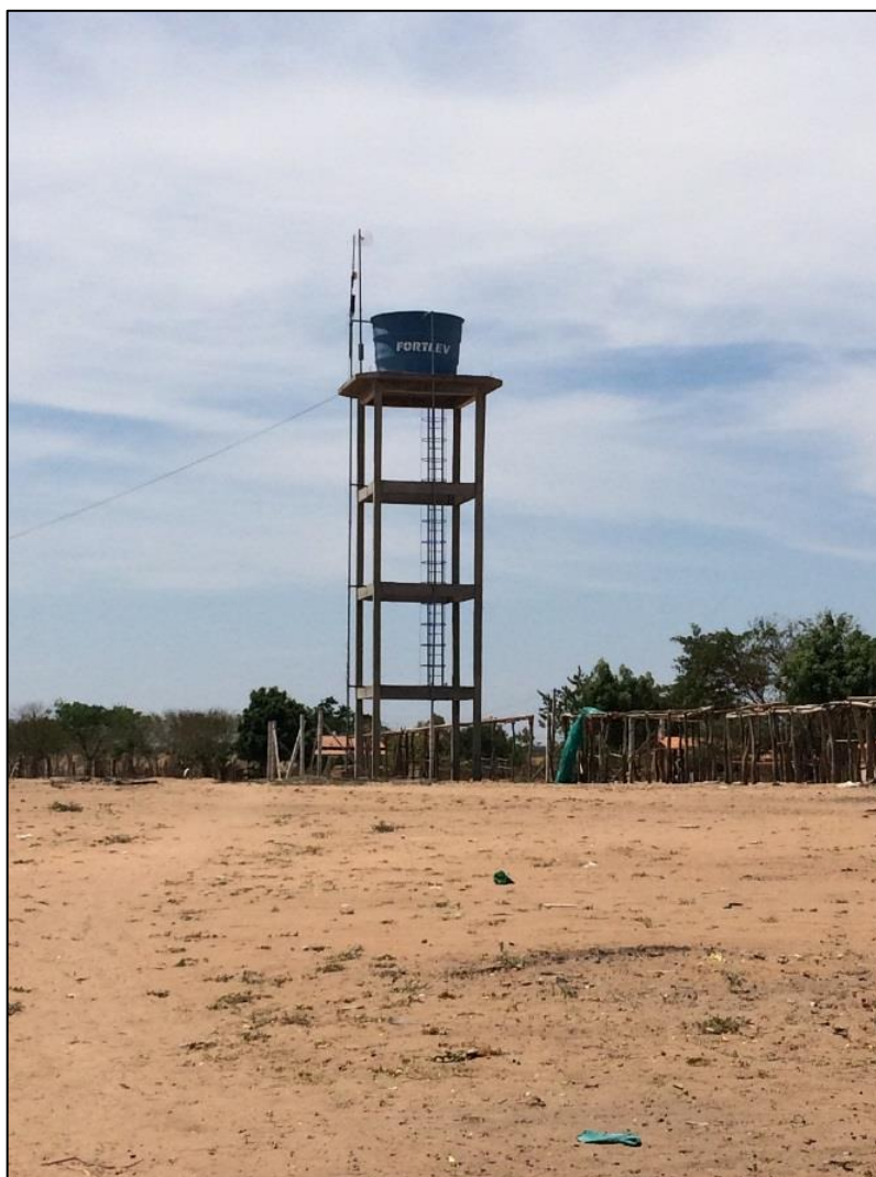
Figura 119 – REL 20m 3 . Fonte: DRZ – Geotecnologia e Consultoria, 2017.
