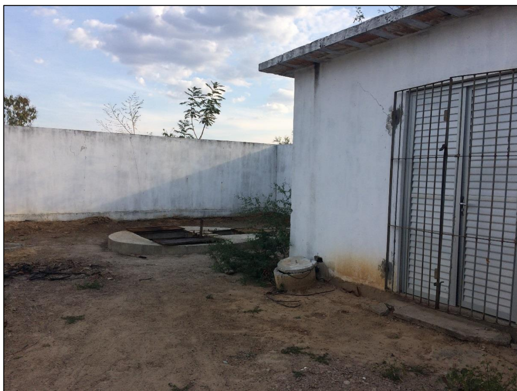
Figura 148 – EEE – Sem denominação. Fonte: DRZ – Geotecnologia e Consultoria, 2017.
