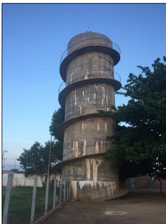
Figura 68 – Reservatório 6. Fonte: DRZ – Geotecnologia e Consultoria, 2017.
