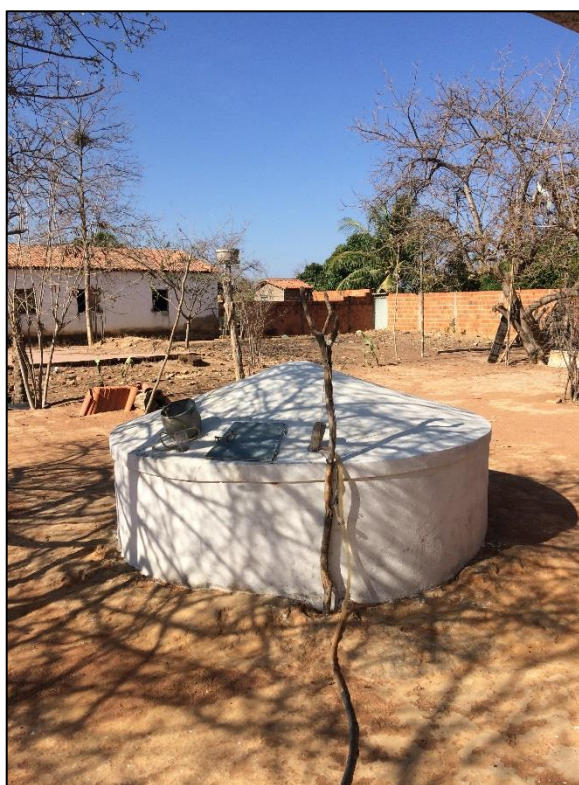
Figura 89 – Cisterna do controlador – Comunidade Tanque Novo. Fonte: DRZ – Geotecnologia e Consultoria, 2017.
