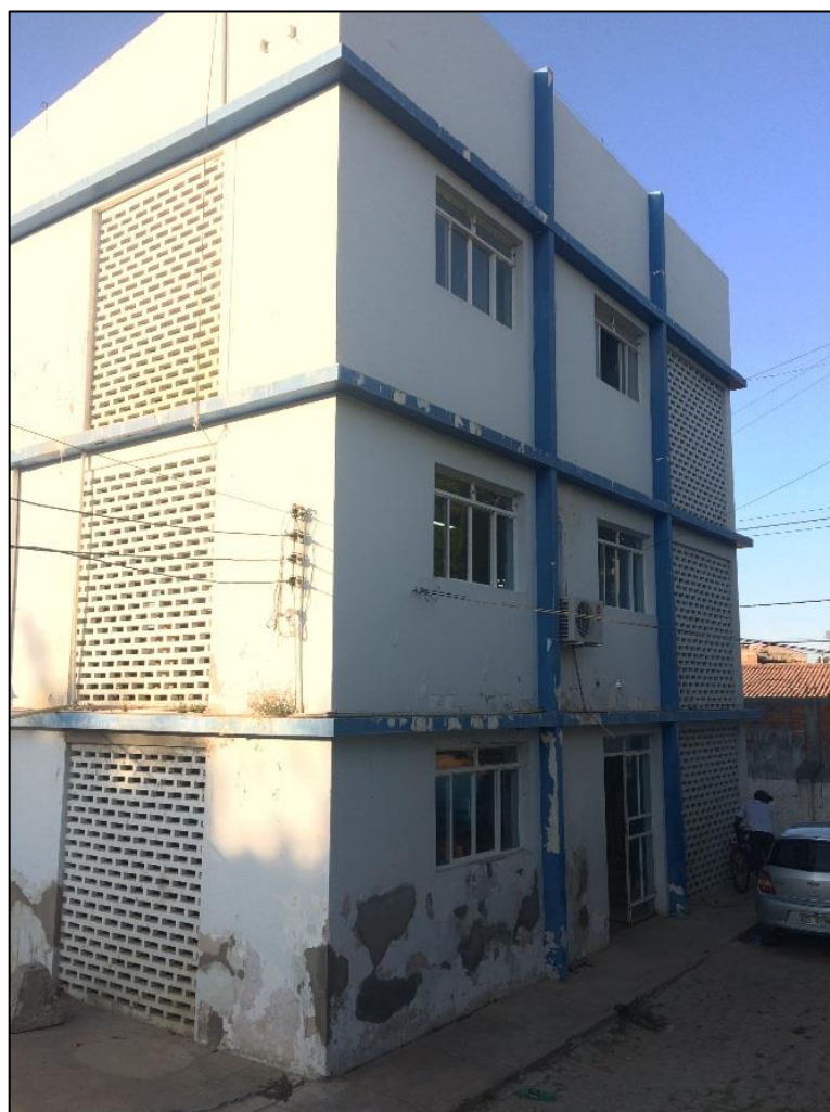
Figura 40 – Vista frontal do prédio da ETA. Fonte: DRZ – Geotecnologia e Consultoria, 2017.
