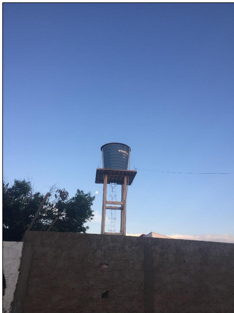
Figura 133 – REL – 20m 3 - Setor 33. Fonte: DRZ – Geotecnologia e Consultoria, 2017.
