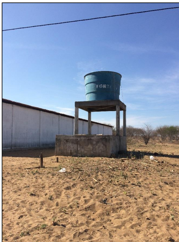
Figura 91 – Reservatório abastecido pelo caminhão pipa – Quilombo Araça - Cariacá.
