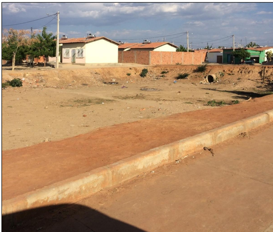
Figura 205 – Reservatório de detenção I em área residencial do Distrito Sede. Fonte: DRZ – Geotecnologia e Consultoria, 2017.
