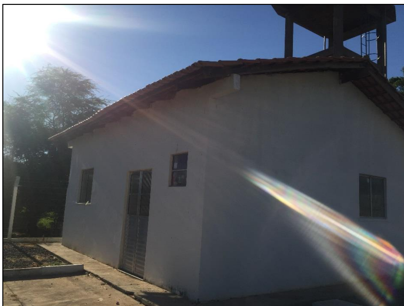
Figura 127 – Casa de química. Fonte: DRZ – Geotecnologia e Consultoria, 2017.
