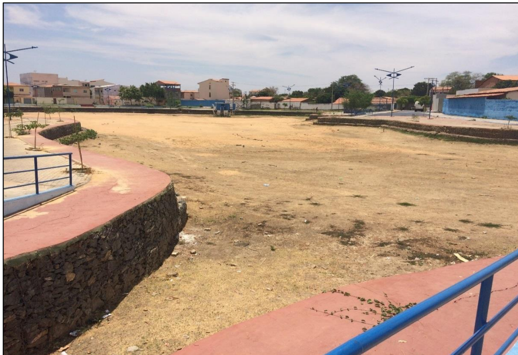
Figura 204 – Reservatório de detenção próximo a área central do Distrito Sede. Fonte: DRZ – Geotecnologia e Consultoria, 2017.
