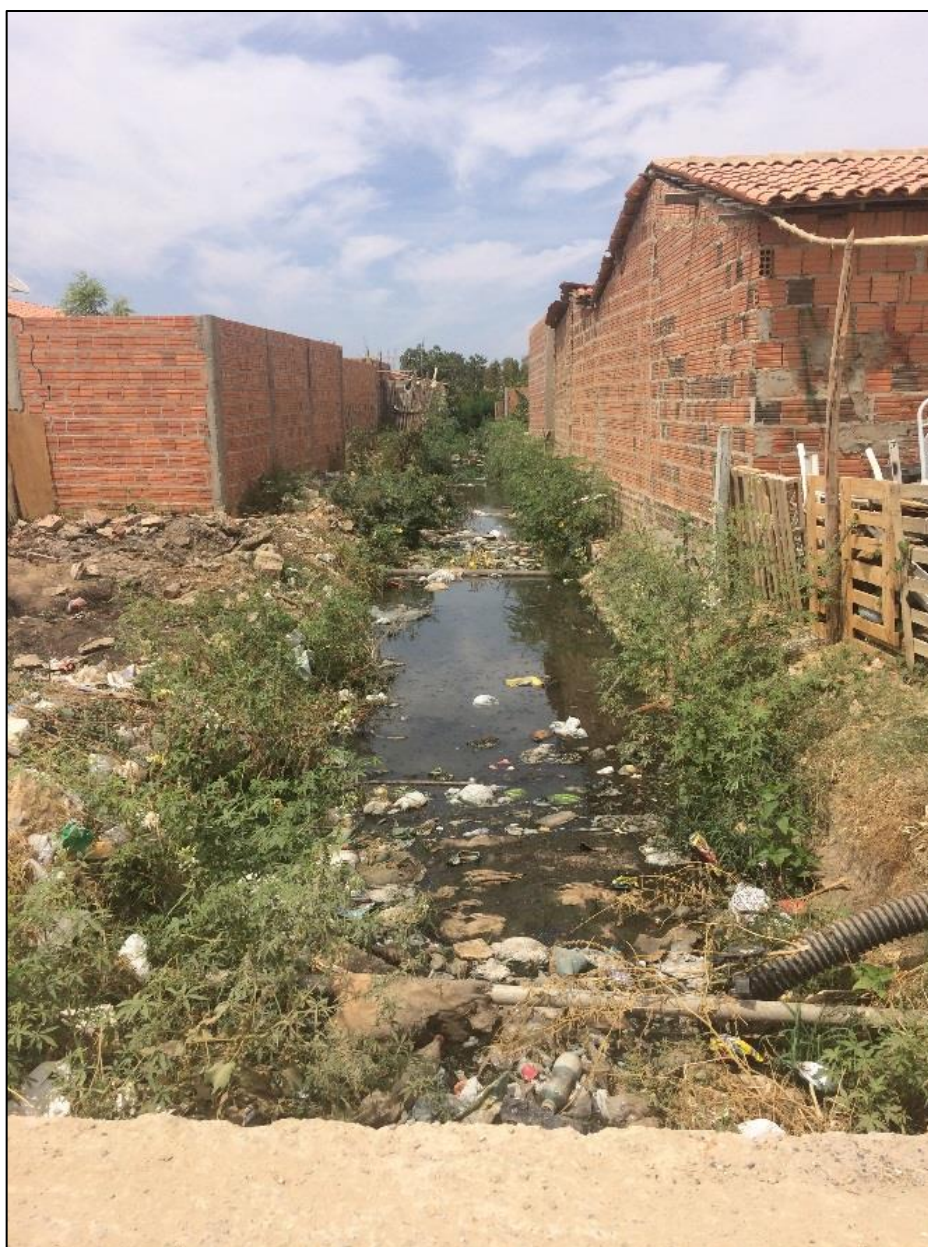
Figura 160 – Canaleta de drenagem com esgoto. Fonte: DRZ – Geotecnologia e Consultoria, 2017.
