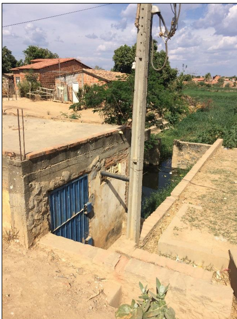
Figura 158 – Casa de bombas da lagoa de esgoto e drenagem. Fonte: DRZ – Geotecnologia e Consultoria, 2017.
