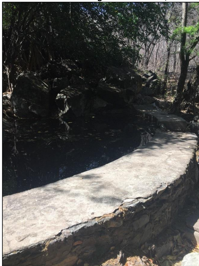
Figura 74 – Barragem de Captação – Distrito de Favelândia. Fonte: DRZ – Geotecnologia e Consultoria, 2017.
