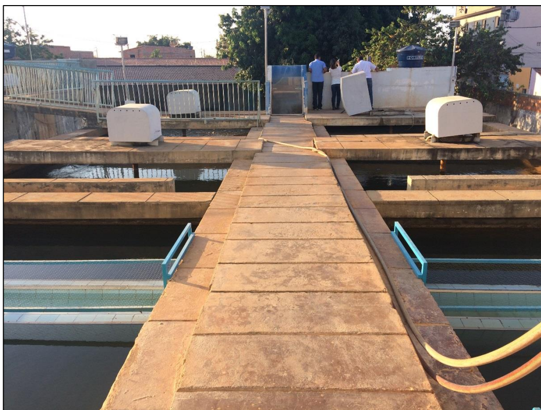
Figura 42 – Floculadores da ETA antiga – Distrito Sede. Fonte: DRZ – Geotecnologia e Consultoria, 2017.
