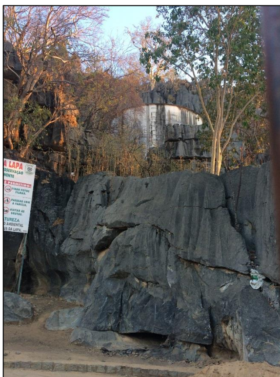
Figura 66 – Reservatório 4. Fonte: DRZ – Geotecnologia e Consultoria, 2017.
