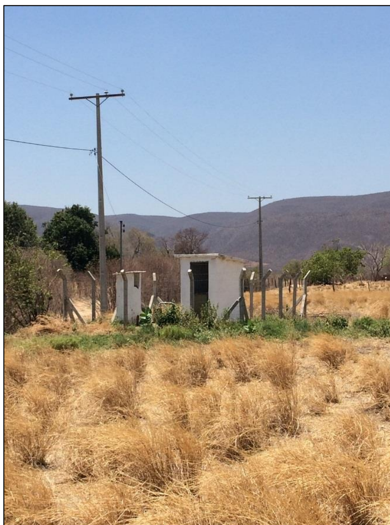
Figura 87 – Poço de captação – Comunidade de Silvestre. Fonte: DRZ – Geotecnologia e Consultoria, 2017.
