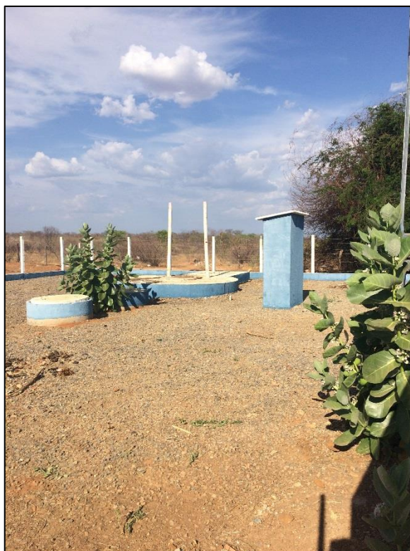
Figura 147 – EEE – Vale Verde. Fonte: DRZ – Geotecnologia e Consultoria, 2018.
