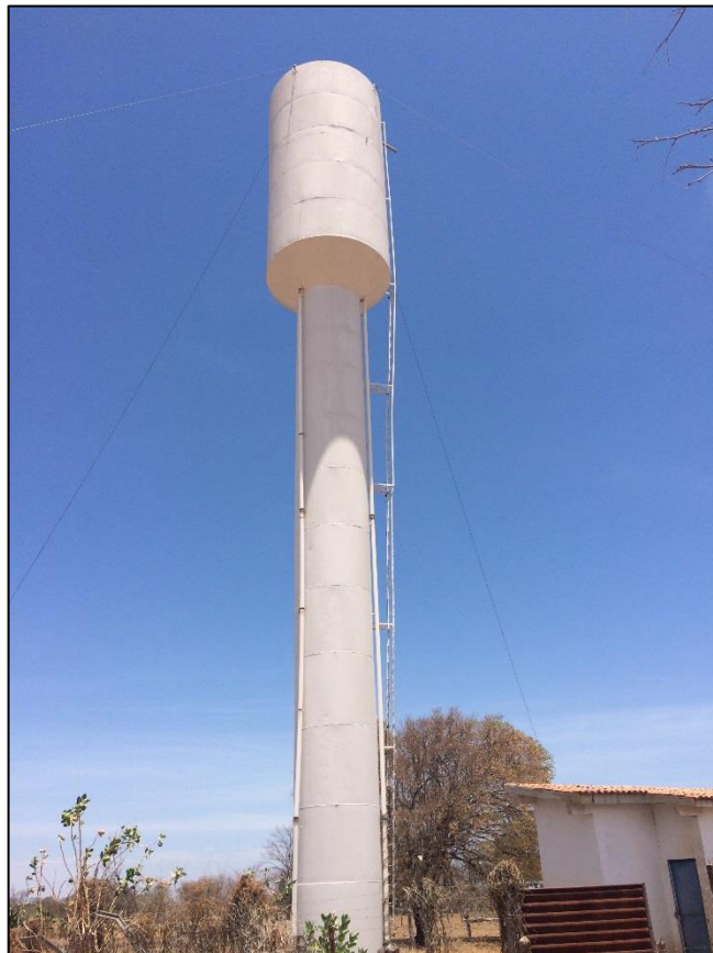
Figura 121 – REL 60m 3 - Comunidade Brasileiras. Fonte: DRZ – Geotecnologia e Consultoria, 2017.
