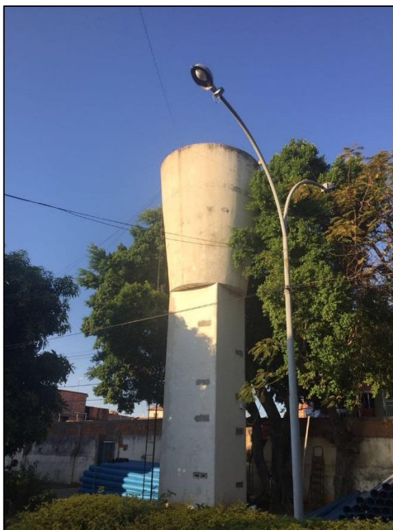
Figura 65 – Reservatório 3. Fonte: DRZ – Geotecnologia e Consultoria, 2017.
