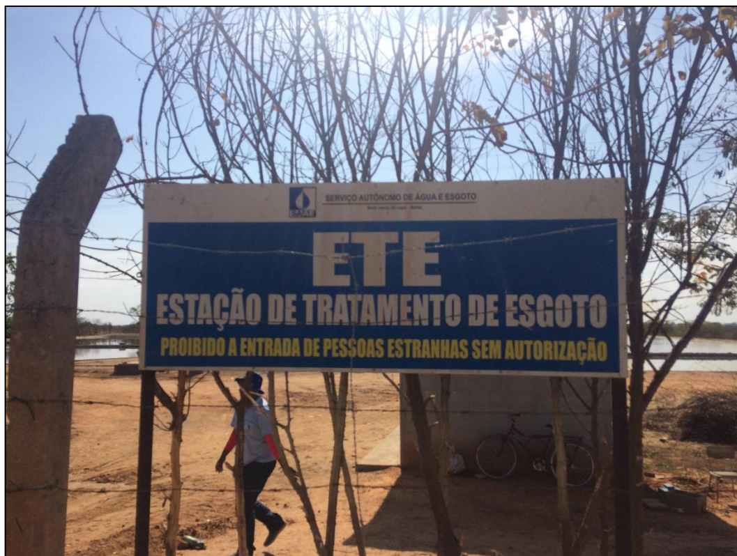
Figura 151 – Entrada da ETE. Fonte: DRZ – Geotecnologia e Consultoria, 2017.
