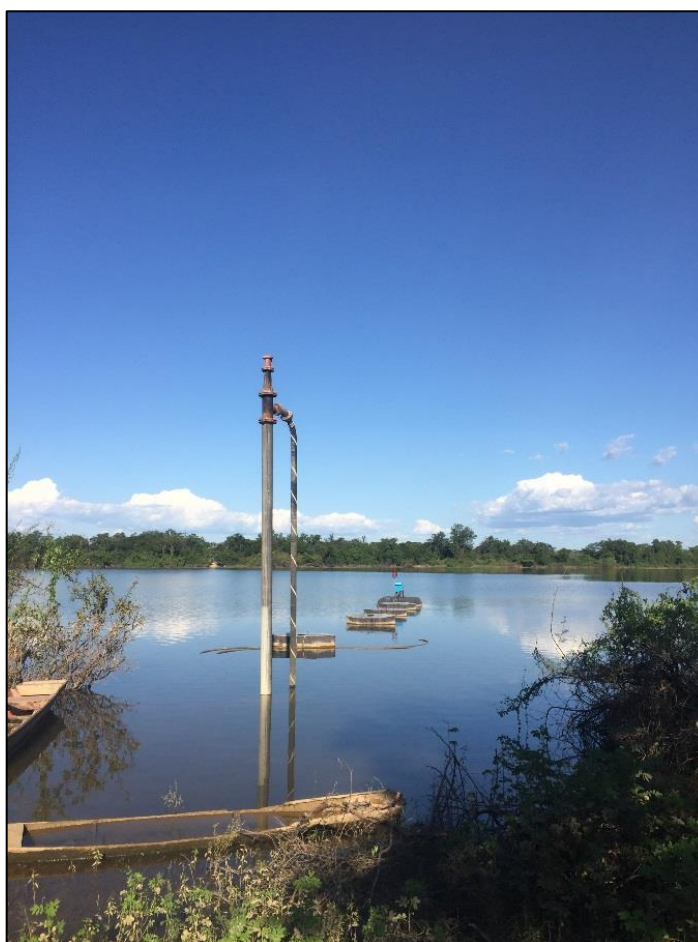
Figura 123 – Captação superficial. Fonte: DRZ – Geotecnologia e Consultoria, 2017.
