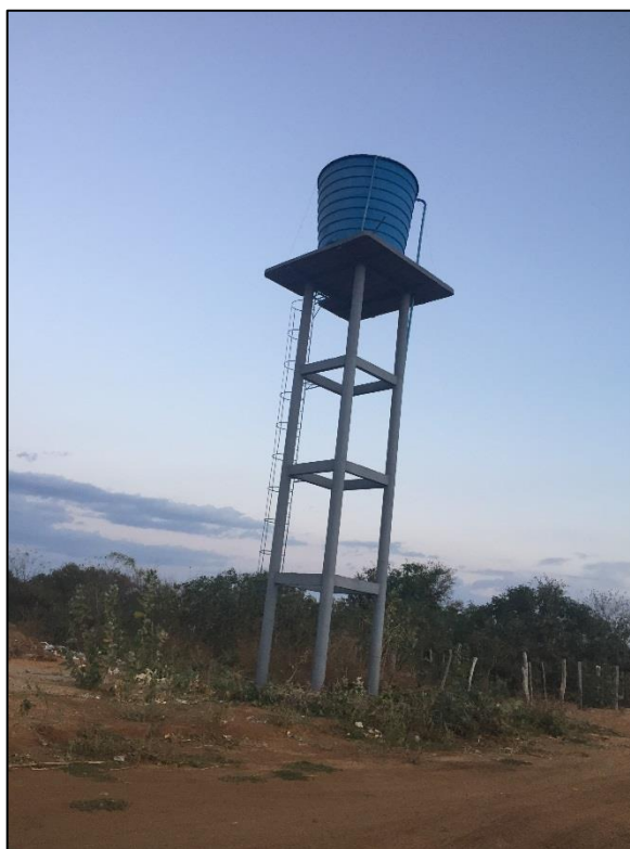
Figura 136 – REL – 20m 3 - Setor 4. Fonte: DRZ – Geotecnologia e Consultoria, 2017.
