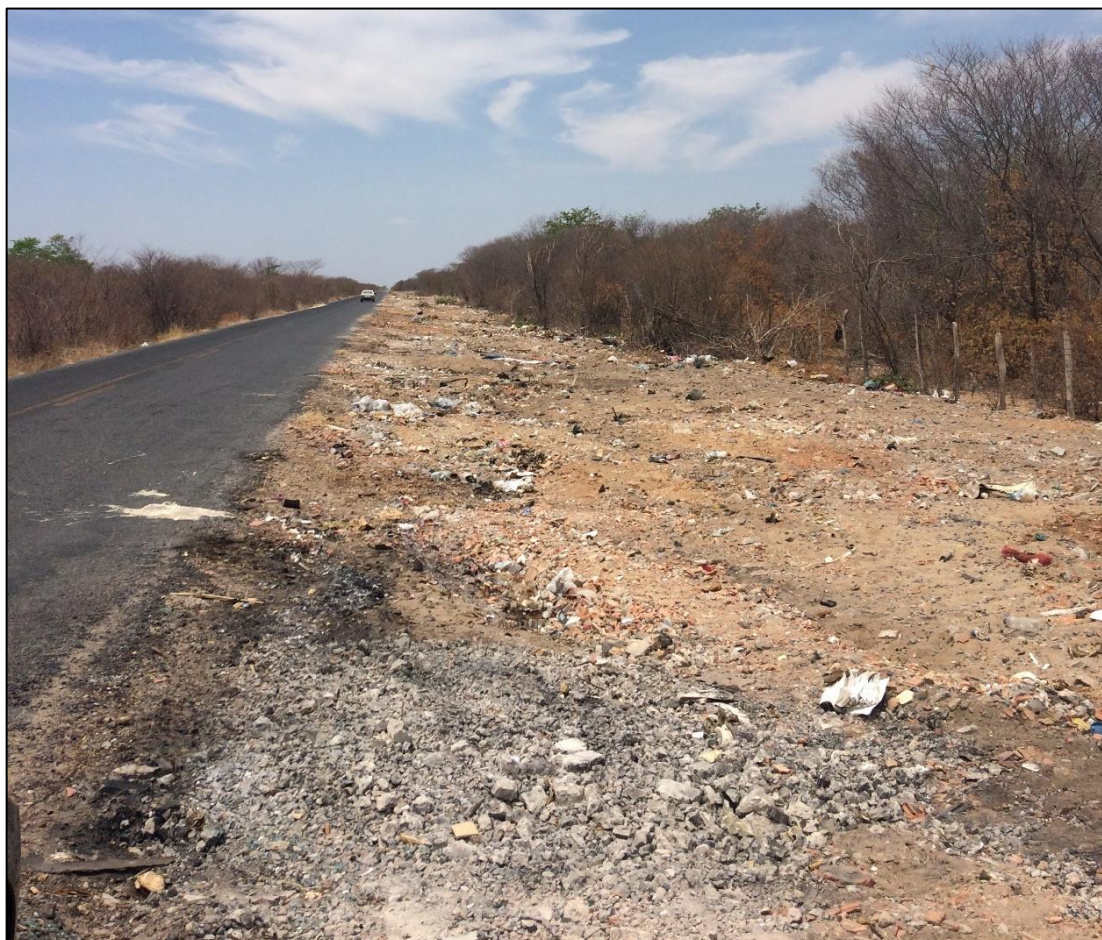
Figura 191 – Resíduos de construção civil utilizado para manutenção de rodovias.
