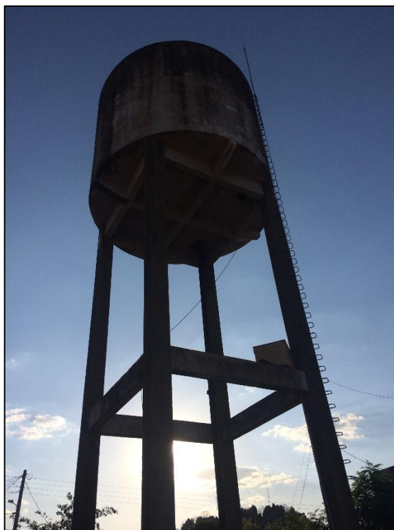
Figura 67 – Reservatório 5. Fonte: DRZ – Geotecnologia e Consultoria, 2017.
