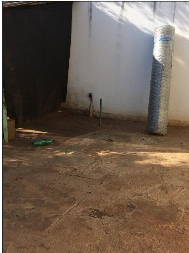
Figura 162 – Fossa comunidade Chapada Grande. Fonte: DRZ – Geotecnologia e Consultoria, 2017.
