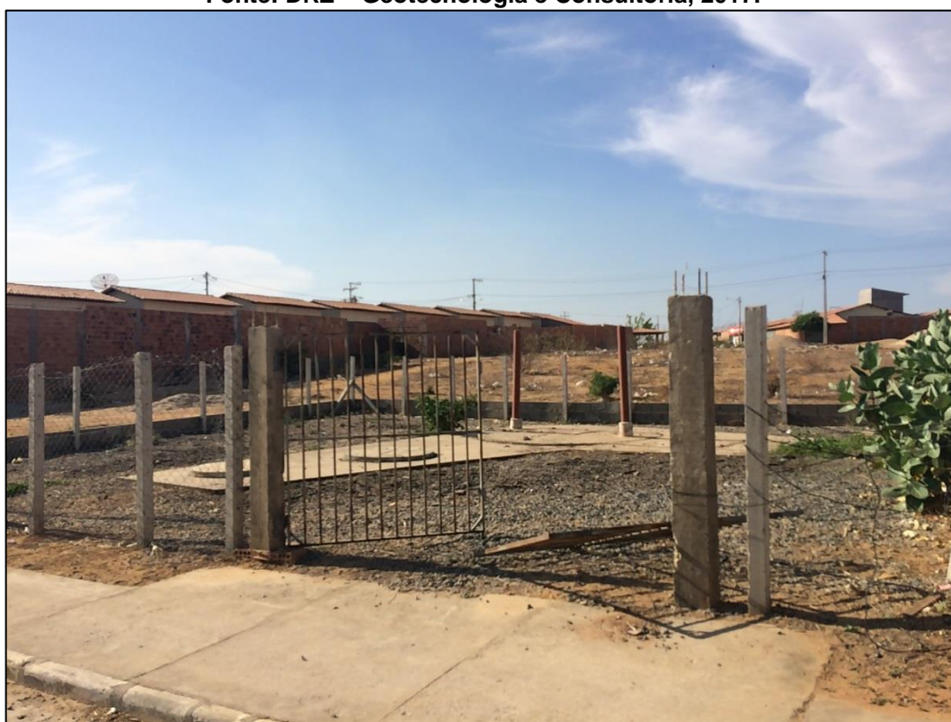
Figura 144 – EEE – Primavera I. Fonte: DRZ – Geotecnologia e Consultoria, 2017.
