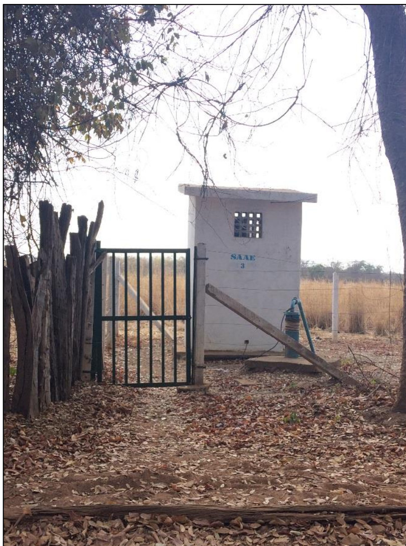
Figura 83 – Poço de captação – Comunidade Mossorongo. Fonte: DRZ – Geotecnologia e Consultoria, 2017.
