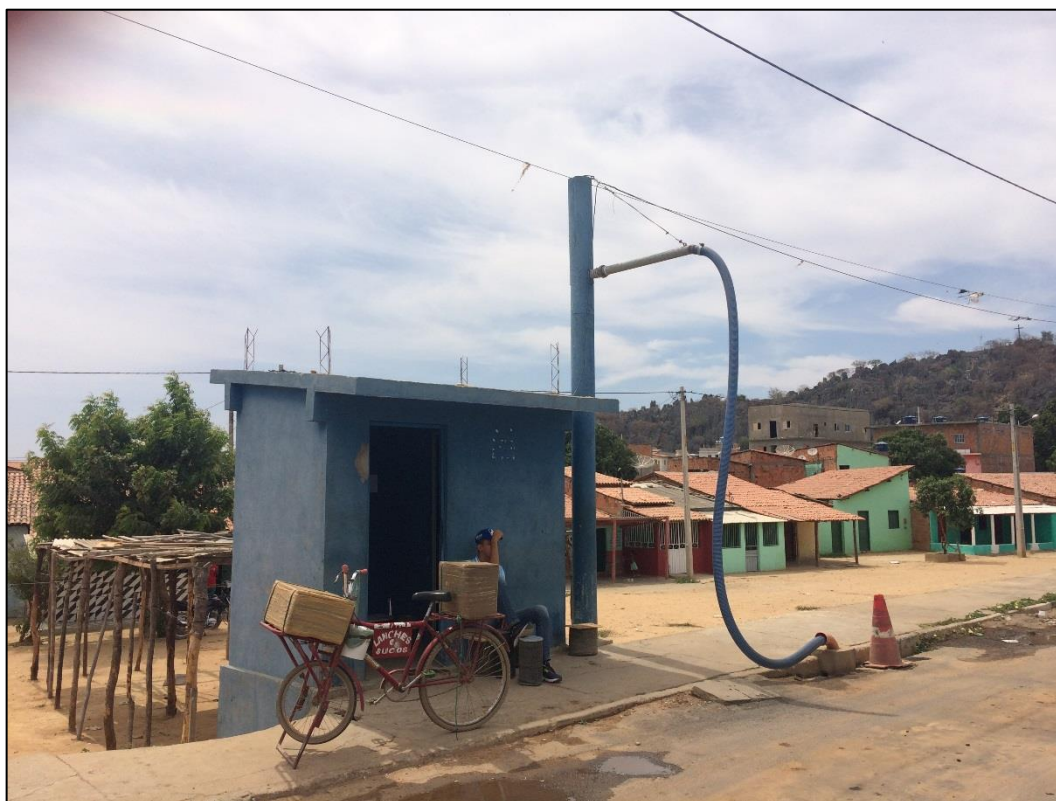
Figura 79 – Ponto de abastecimento de água dos caminhões pipa – Operação Carro Pipa.
