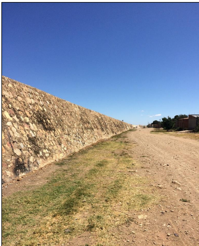
Figura 236 – Dique de proteção das cheias do Rio São Francisco. Fonte: DRZ – Geotecnologia e Consultoria, 2017.
