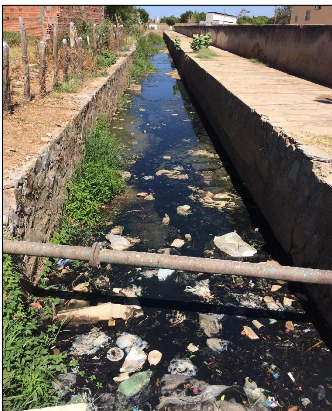
Figura 142 – Lançamento de esgoto nos canais de drenagem pluvial da Sede. Fonte: DRZ – Geotecnologia e Consultoria, 2017.
