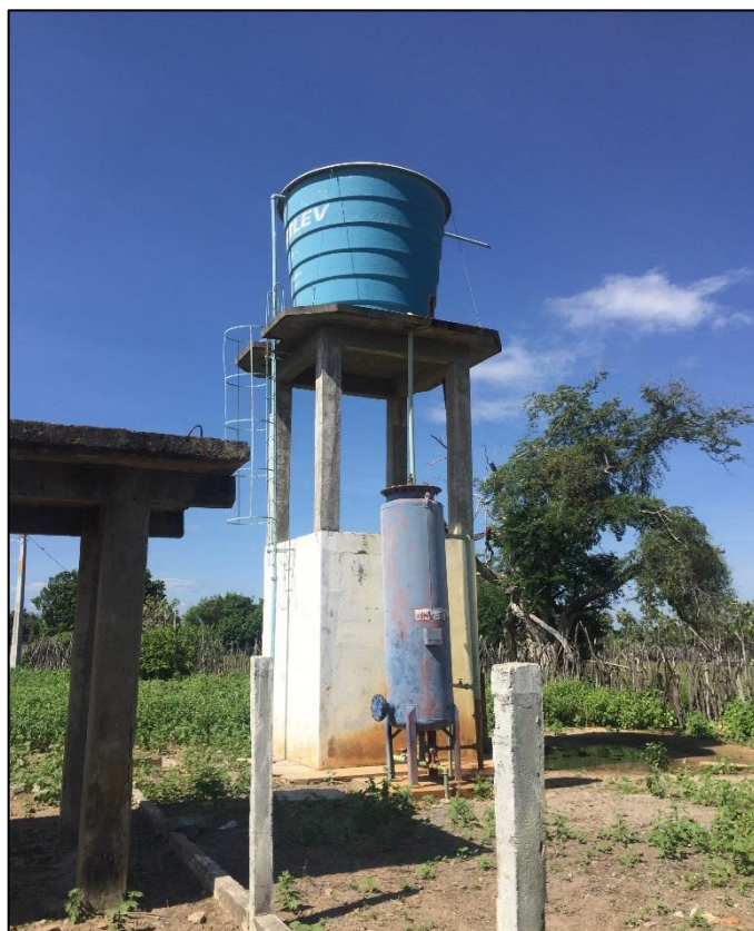
Figura 97 – Reservatório Elevado (REL) da comunidade Capão do Saco. Fonte: DRZ – Geotecnologia e Consultoria, 2018.
