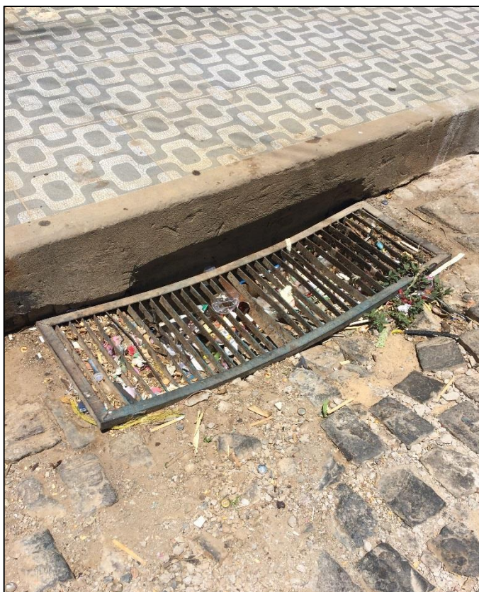
Figura 214 – Boca de lobo lateral com grade. Fonte: DRZ – Geotecnologia e Consultoria, 2017.
