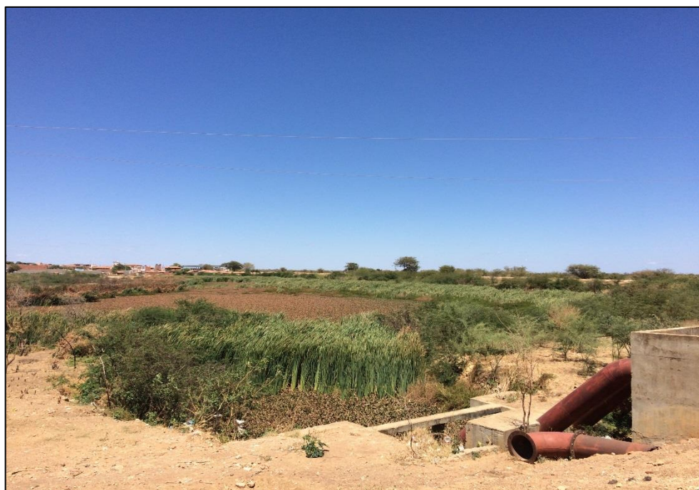
Figura 222 – Lagoa de contenção de águas pluviais. Fonte: DRZ – Geotecnologia e Consultoria, 2017.
