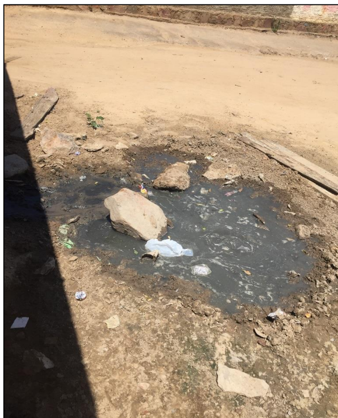
Figura 174 – Acúmulo de esgoto em via pública: comunidade Utinga. Fonte: DRZ – Geotecnologia e Consultoria, 2018.
