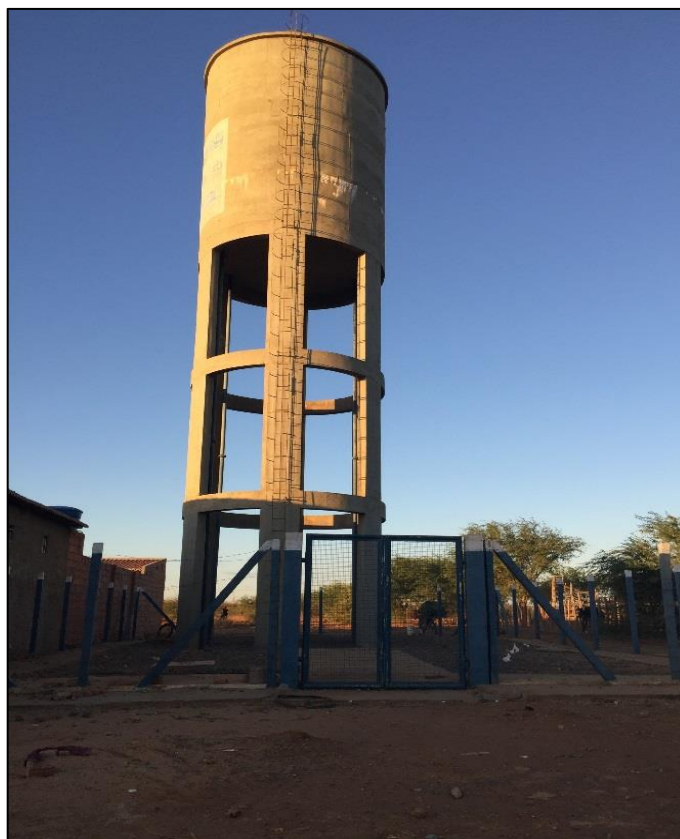
Figura 76 – REL desativado, distrito Nova Iguaíra. Fonte: DRZ – Geotecnologia e Consultoria, 2017.
