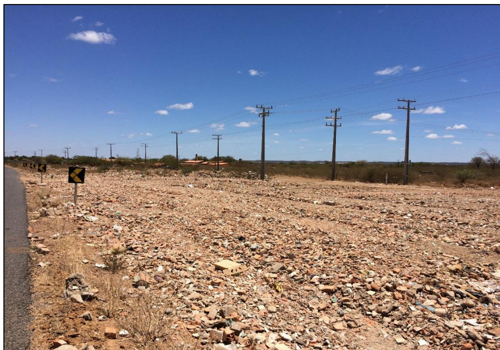
Figura 201 – Resíduos de construção civil utilizados para a manutenção do acostamento.
