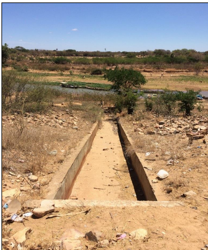
Figura 227 – Canaleta de drenagem, ponto de lançamento da lagoa de drenagem pluvial. Fonte: DRZ – Geotecnologia e Consultoria, 2017.
