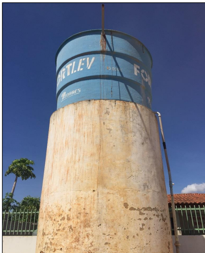
Figura 117 – Reservatório Elevado (REL 02) de 10 m 3 da comunidade Utinga. Fonte: DRZ – Geotecnologia e Consultoria, 2018.
