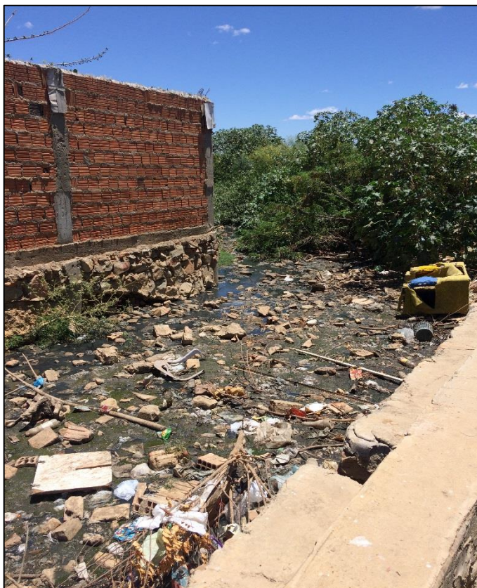
Figura 143 – Canal de drenagem com lançamento de esgoto e resíduos sólidos no distrito Sede.
