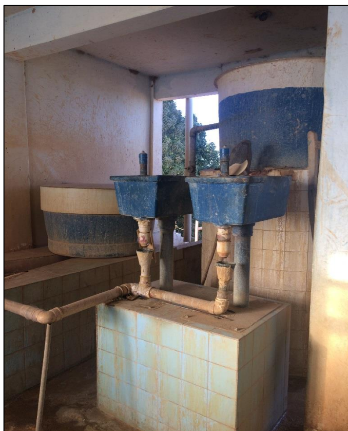
Figura 41 – Aplicação de sulfato de alumínio. Fonte: DRZ – Geotecnologia e Consultoria, 2017.
