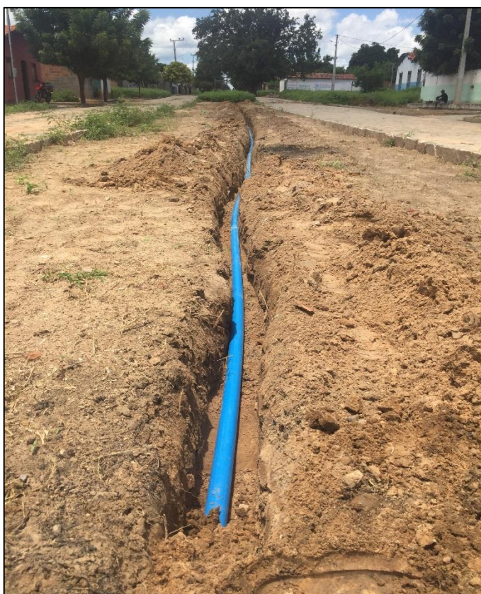
Figura 109 – Instalação da AAB do novo poço da comunidade. Fonte: DRZ – Geotecnologia e Consultoria, 2018.
