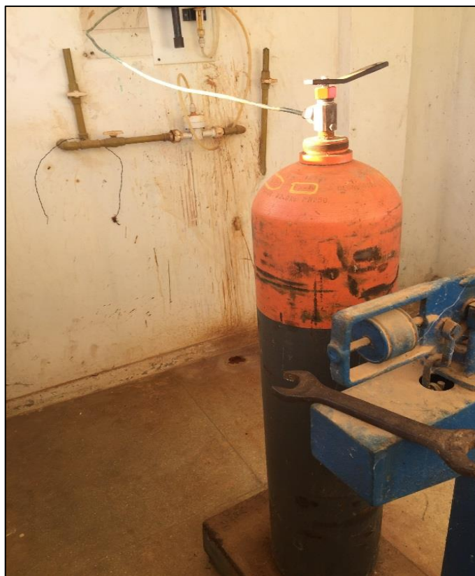
Figura 51 – Aplicação de cloro gás para o tratamento da água. Fonte: DRZ – Geotecnologia e Consultoria, 2017.
