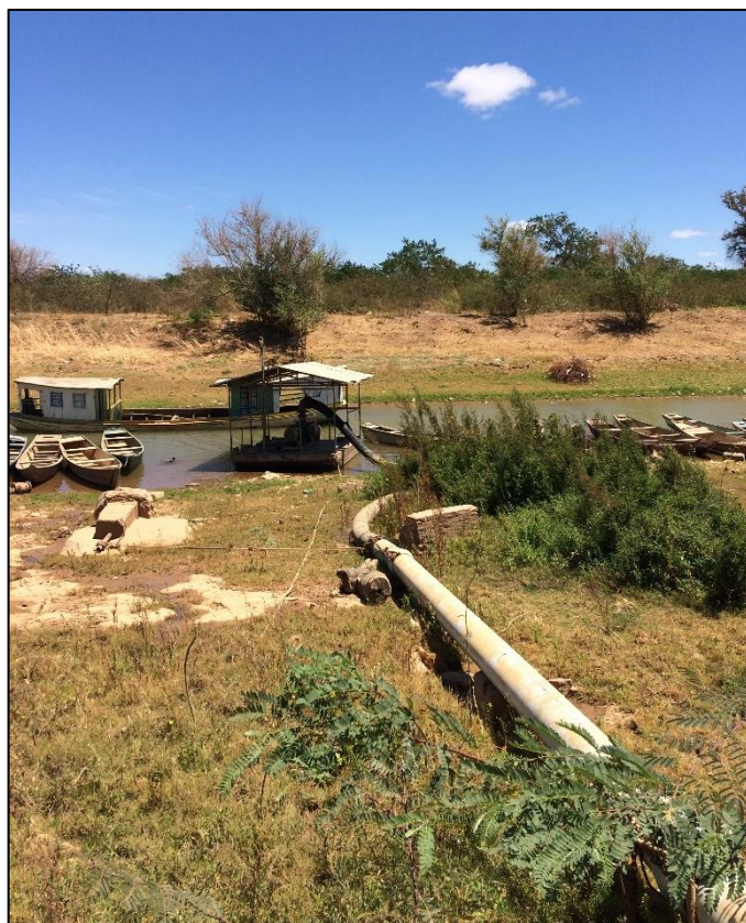
Figura 35 – Adutora de água bruta da captação superficial. Fonte: DRZ – Geotecnologia e Consultoria, 2017.
