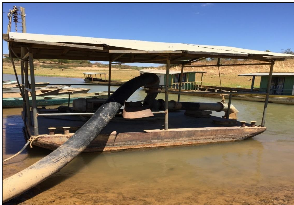
Figura 31 – Balsa flutuante da captação superficial no rio São Francisco. Fonte: DRZ – Geotecnologia e Consultoria, 2017.
