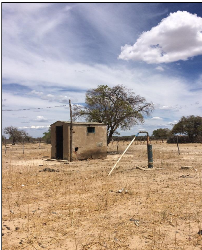
Figura 132 – Poço de captação subterrânea: comunidade Pesqueiro. Fonte: DRZ – Geotecnologia e Consultoria, 2017.
