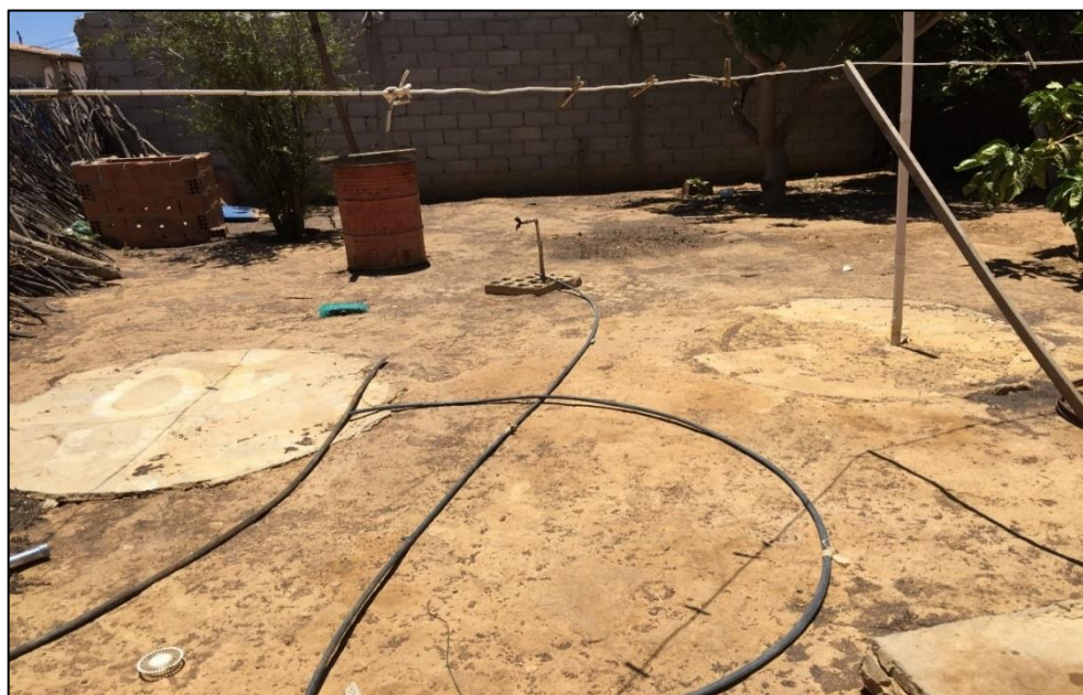
Figura 149 – Fossas sépticas instaladas no bairro Nair Barreto no distrito Sede. Fonte: DRZ – Geotecnologia e Consultoria, 2017.
