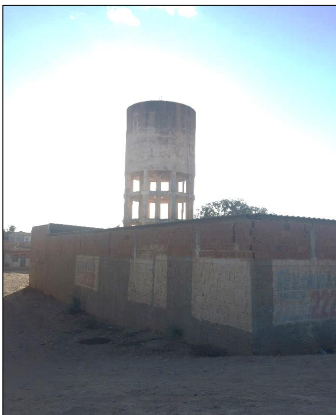
Figura 60 – R3: desativado. Fonte: DRZ – Geotecnologia e Consultoria, 2017.
