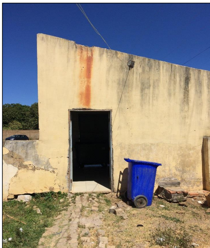
Figura 204 – Local de acondicionamento temporário dos resíduos de serviços de saúde.
