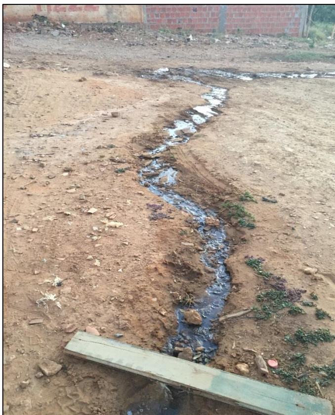
Figura 164 – Lançamento de esgoto na via pública no distrito Nova Iguaíra. Fonte: DRZ – Geotecnologia e Consultoria, 2017.
