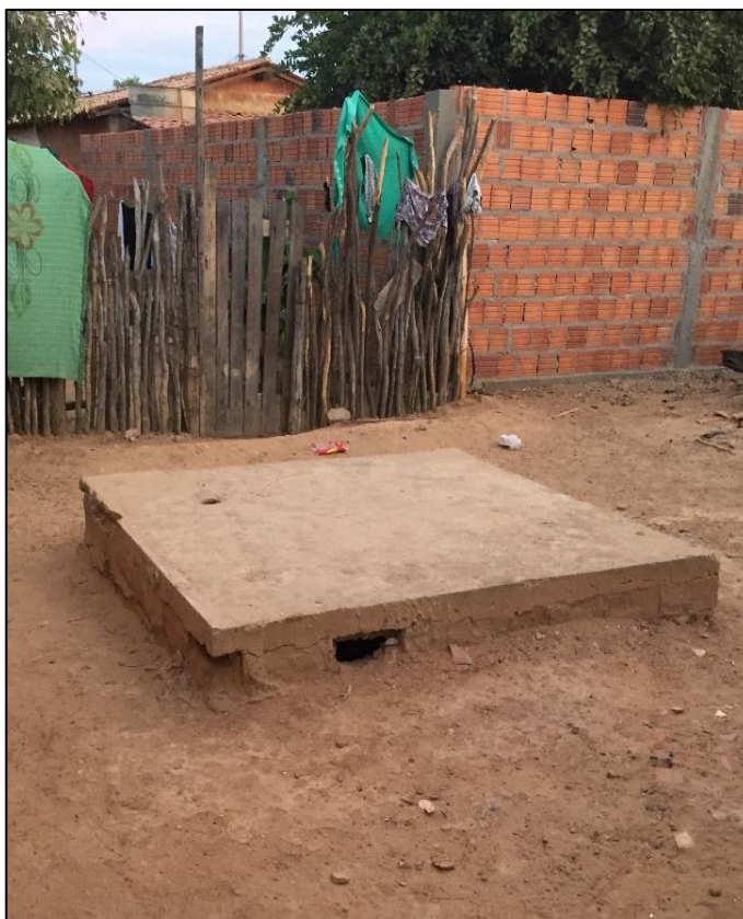
Figura 167 – Fossa rudimentar: comunidade Marreca Velha. Fonte: DRZ – Geotecnologia e Consultoria, 2017.
