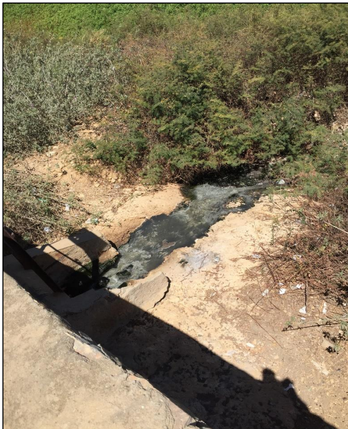
Figura 217 – Lançamento de esgoto pelas comportas. Fonte: DRZ – Geotecnologia e Consultoria, 2017.
