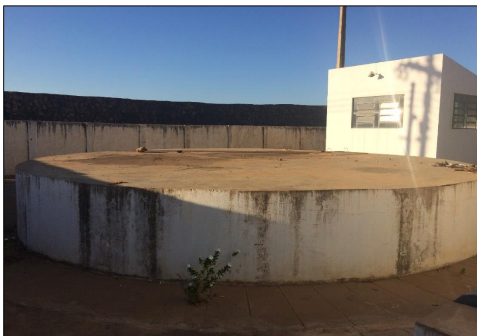
Figura 58 – R1: Reservatório apoiado localizado na ETA, 500 m 3 . Fonte: DRZ – Geotecnologia e Consultoria, 2017.
