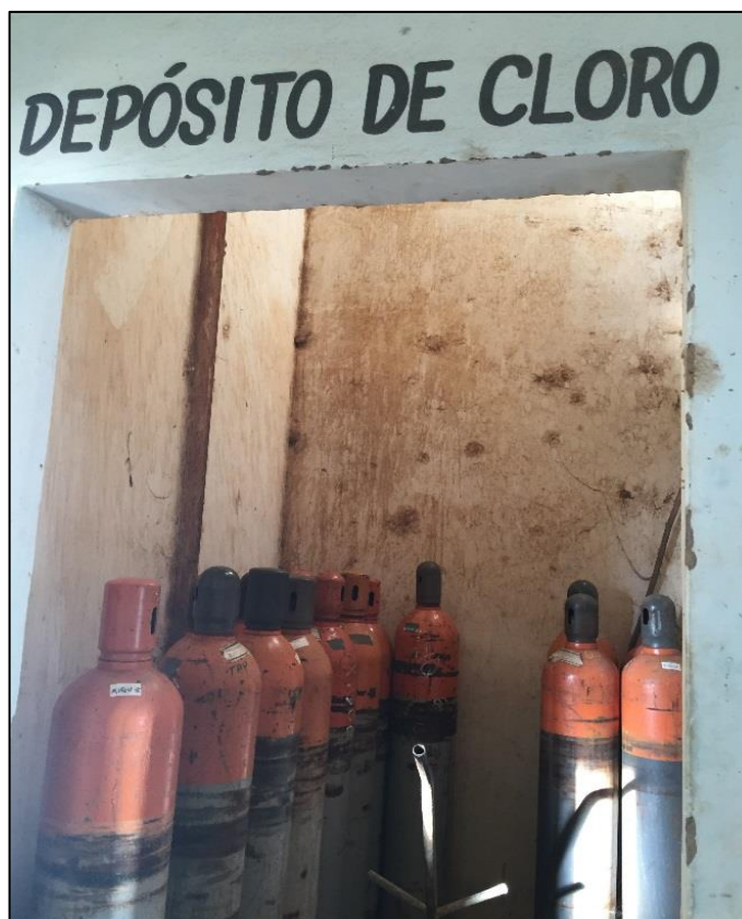
Figura 54 – Depósito de cilindros de cloro gás. Fonte: DRZ – Geotecnologia e Consultoria, 2017.
