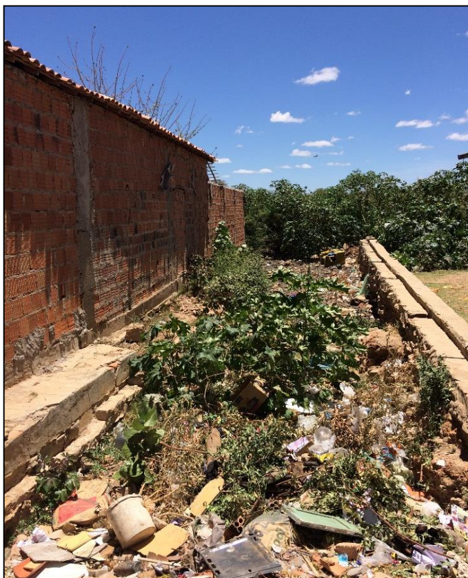
Figura 179 – Descarte incorreto de resíduos. Fonte: DRZ – Geotecnologia e Consultoria, 2017.
