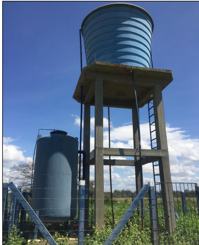
Figura 115 – Reservatório Elevado (REL 01) de 20 m 3 da comunidade Utinga. Fonte: DRZ – Geotecnologia e Consultoria, 2018.
