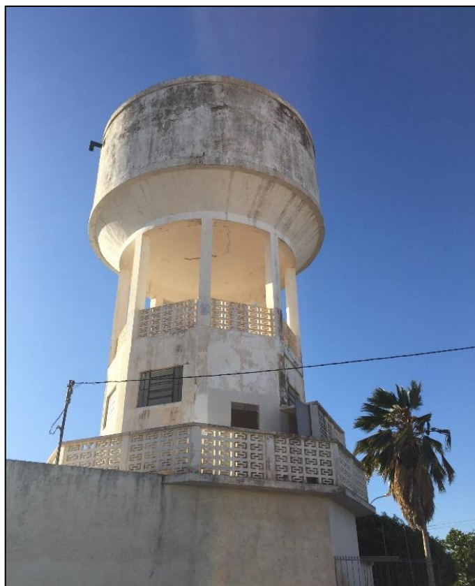
Figura 61 – R4: desativado. Fonte: DRZ – Geotecnologia e Consultoria, 2017.
