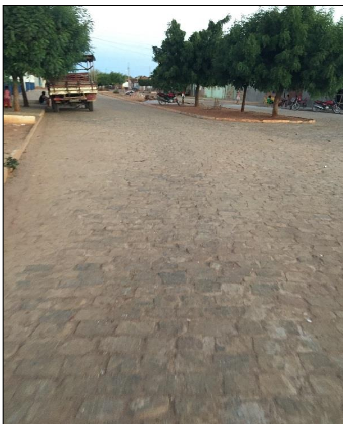
Figura 234 – Exemplo de ruas pavimentadas no distrito Nova Iguaíra.
