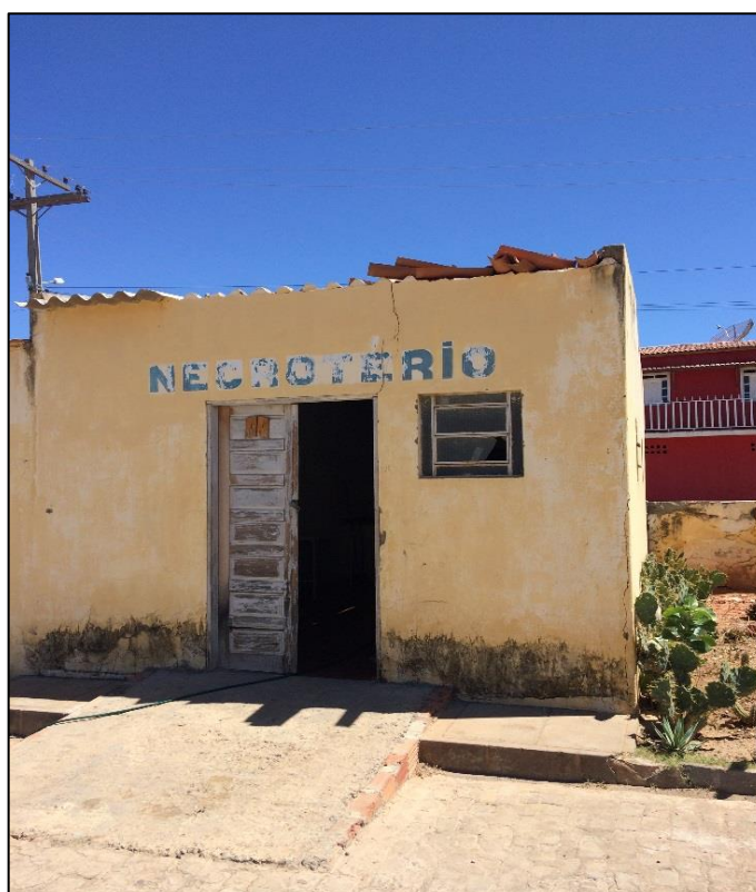
Figura 206 – Necrotério, local de acondicionamento temporário de peças anatômicas.
