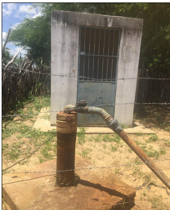
Figura 79 – Poço subterrâneo da comunidade Alto do Gonçalves.
