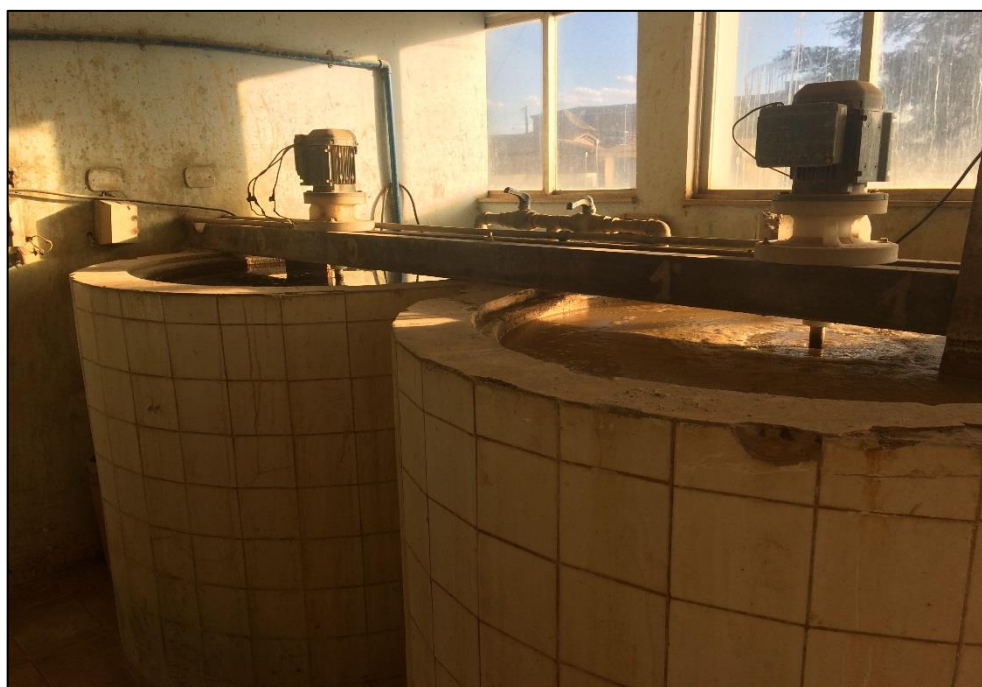
Figura 48 – Sala de preparo do sulfato para ser aplicada na água. Fonte: DRZ – Geotecnologia e Consultoria, 2017.
