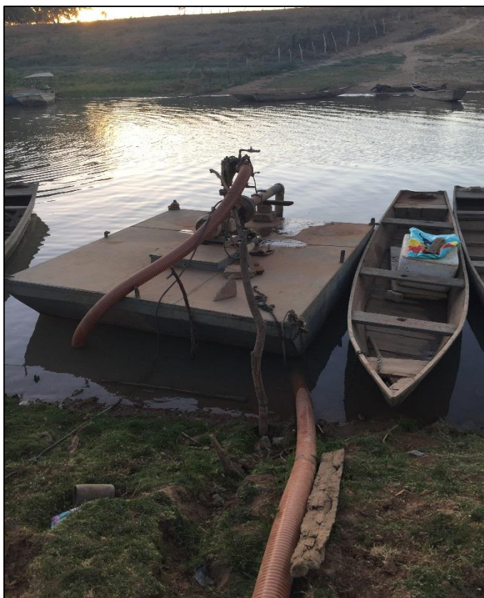
Figura 72 – Captação superficial do distrito Nova Iguira. Fonte: DRZ – Geotecnologia e Consultoria, 2017.
