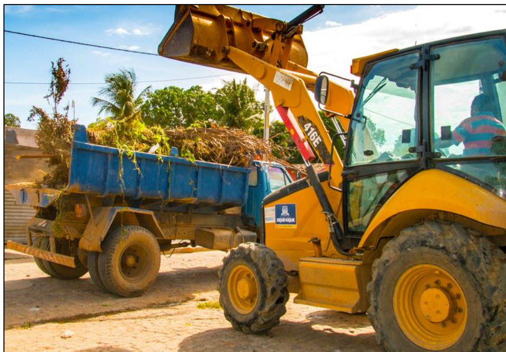
Figura 199 – Serviço de remoção de entulhos na sede de Xique-Xique. Fonte: Xique-Xique, 2018.
