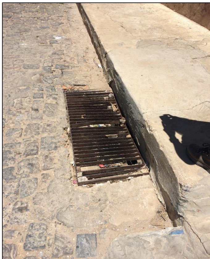
Figura 215 – Exemplo de bocas de lobo utilizadas em Xique-Xique. Fonte: DRZ – Geotecnologia e Consultoria, 2017.
