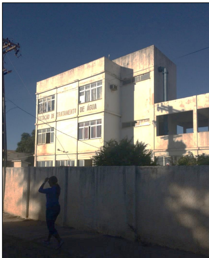
Figura 39 – Vista frontal do prédio da ETA. Fonte: DRZ – Geotecnologia e Consultoria, 2017.
