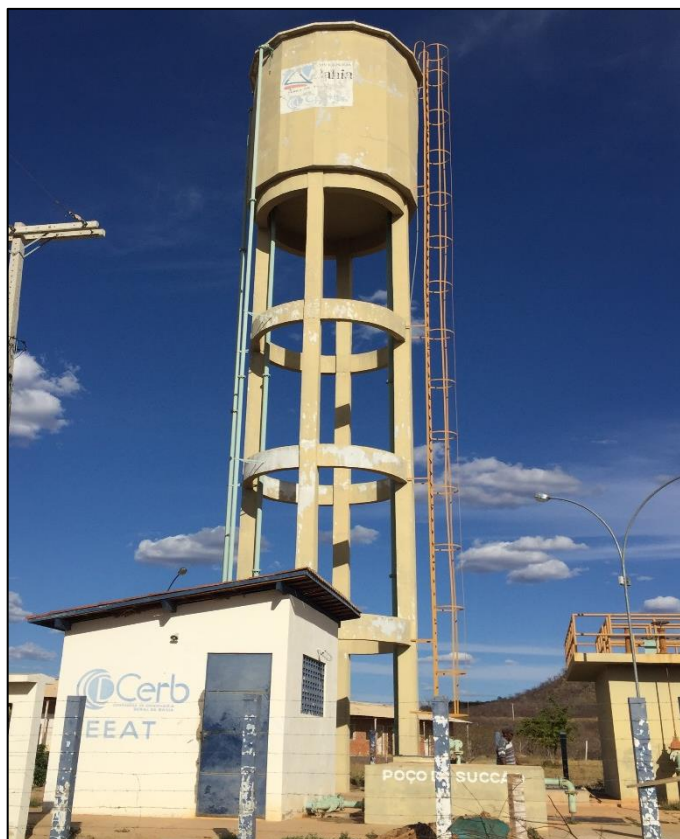
Figura 89 – Reservatório Elevado (REL) de 100 m 3 da comunidade Boa Vista. Fonte: DRZ – Geotecnologia e Consultoria, 2017.
