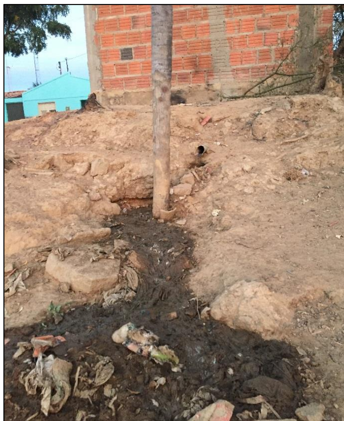
Figura 169 – Ligação de esgoto sem tratamento: comunidade Marreca Velha. Fonte: DRZ – Geotecnologia e Consultoria, 2017.
