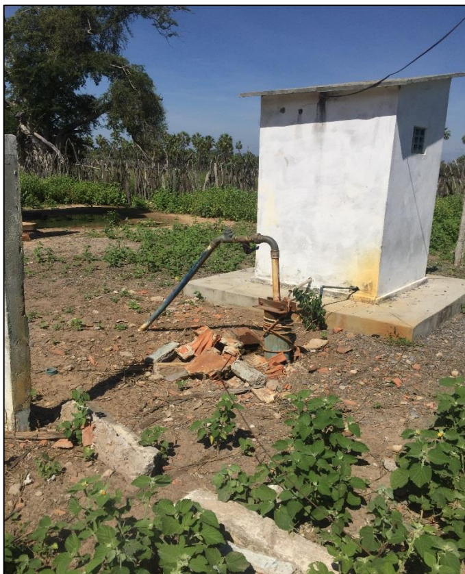
Figura 96 – Poço subterrâneo da comunidade Capão do Saco. Fonte: DRZ – Geotecnia e Consultoria, 2018.
