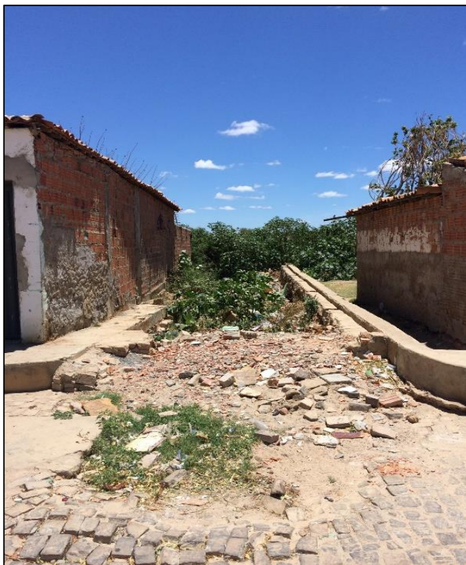
Figura 224 – Canaleta que direciona água pluvial para a lagoa. Fonte: DRZ – Geotecnologia e Consultoria, 2017.
