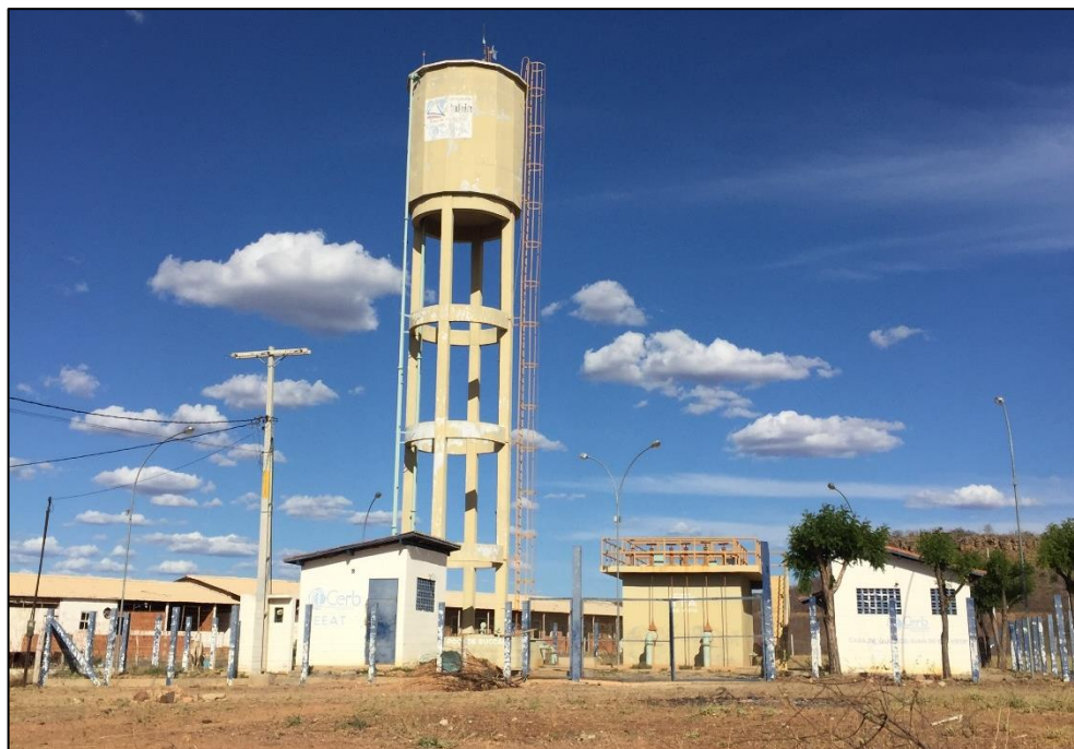
Figura 84 – Estação de tratamento de água da comunidade Boa Vista. Fonte: DRZ – Geotecnologia e Consultoria, 2017.
