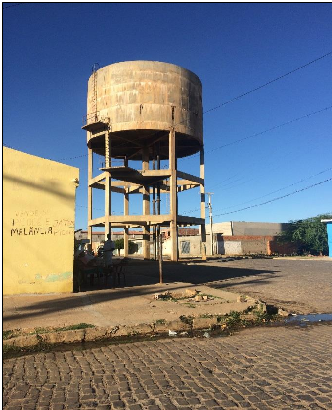
Figura 59 – R2: Reservatório elevado, 600 m 3 . Fonte: DRZ – Geotecnologia e Consultoria, 2017.
