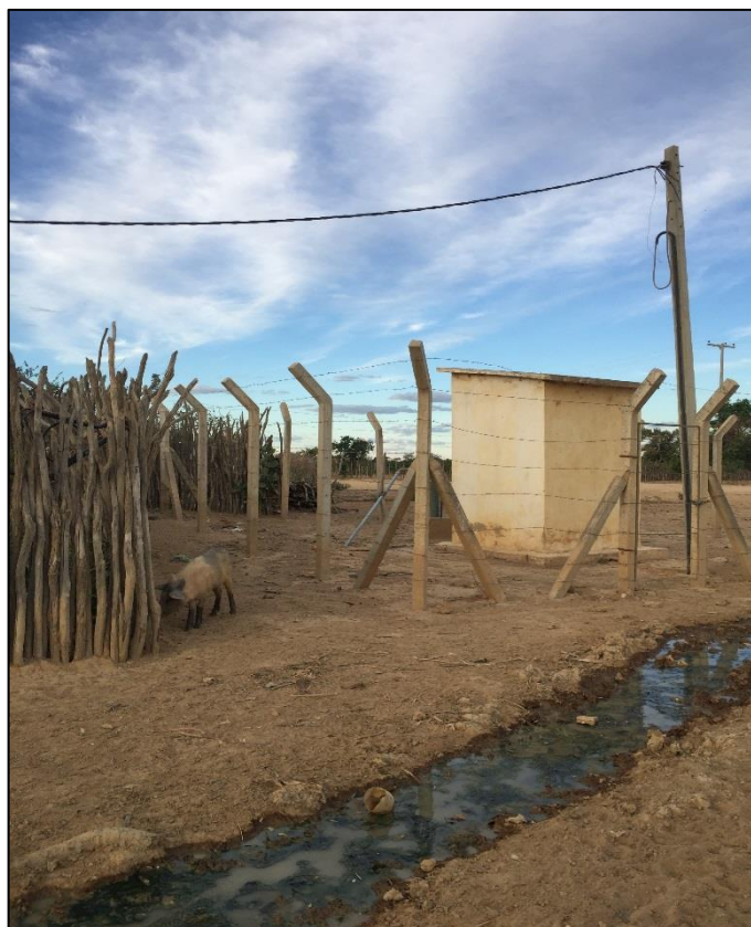
Figura 177 – Lançamento de esgoto à céu aberto: comunidade Vicentes. Fonte: DRZ – Geotecnologia e Consultoria, 2017.
