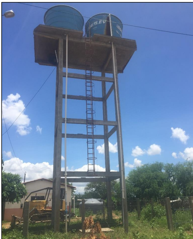
Figura 80 – Reservatórios da comunidade Alto do Gonçalves. Fonte: DRZ – Geotecnologia e Consultoria, 2018.
