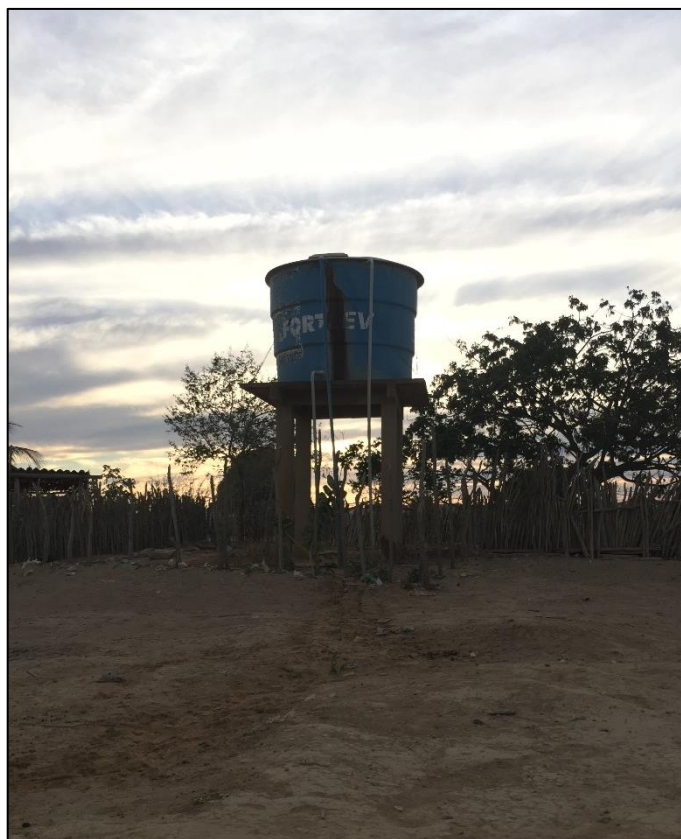
Figura 138 – Reservatório 02: comunidade Vicentes. Fonte: DRZ – Geotecnologia e Consultoria, 2017.
