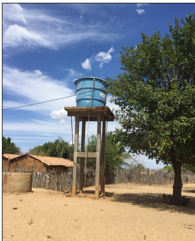
Figura 120 – Reservatório: comunidade Besouro. Fonte: DRZ – Geotecnologia e Consultoria, 2017.
