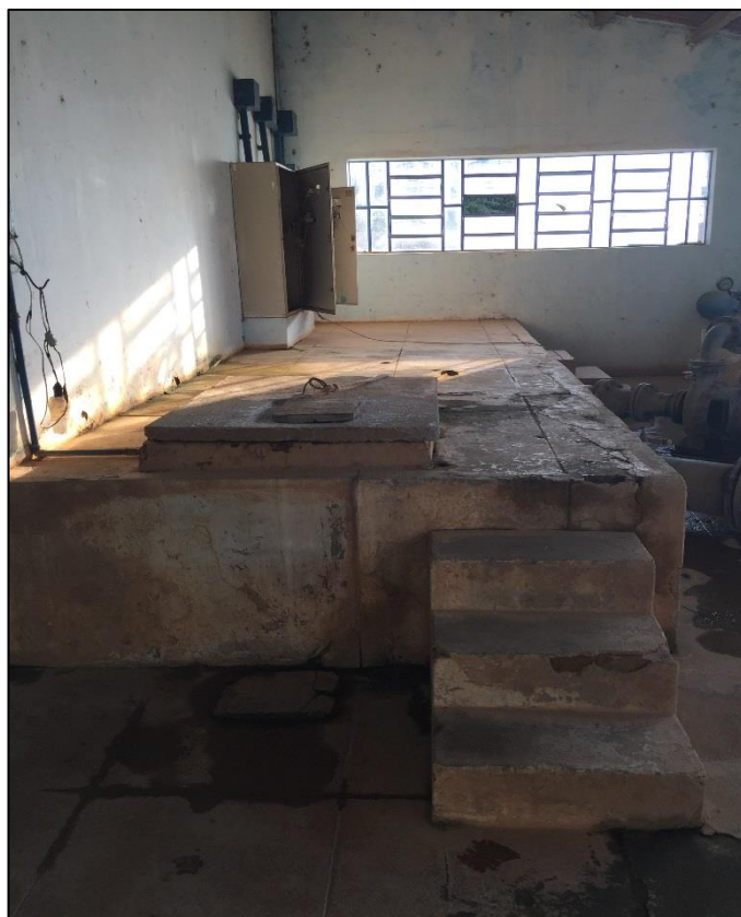
Figura 46 – Local de aplicação do cloro na água. Fonte: DRZ – Geotecnologia e Consultoria, 2017.
