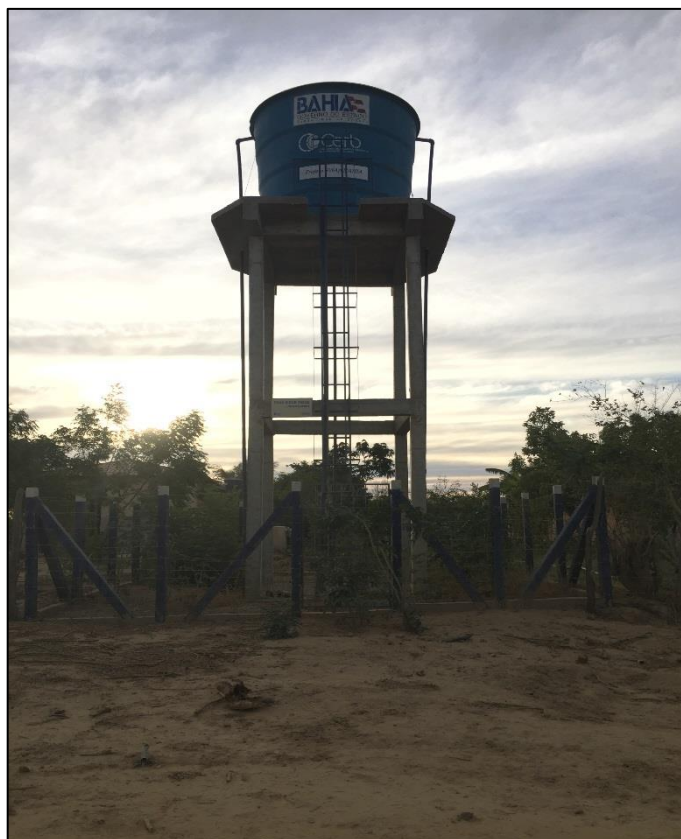
Figura 136 – Reservatório 01: comunidade Vicentes. Fonte: DRZ – Geotecnologia e Consultoria, 2017.
