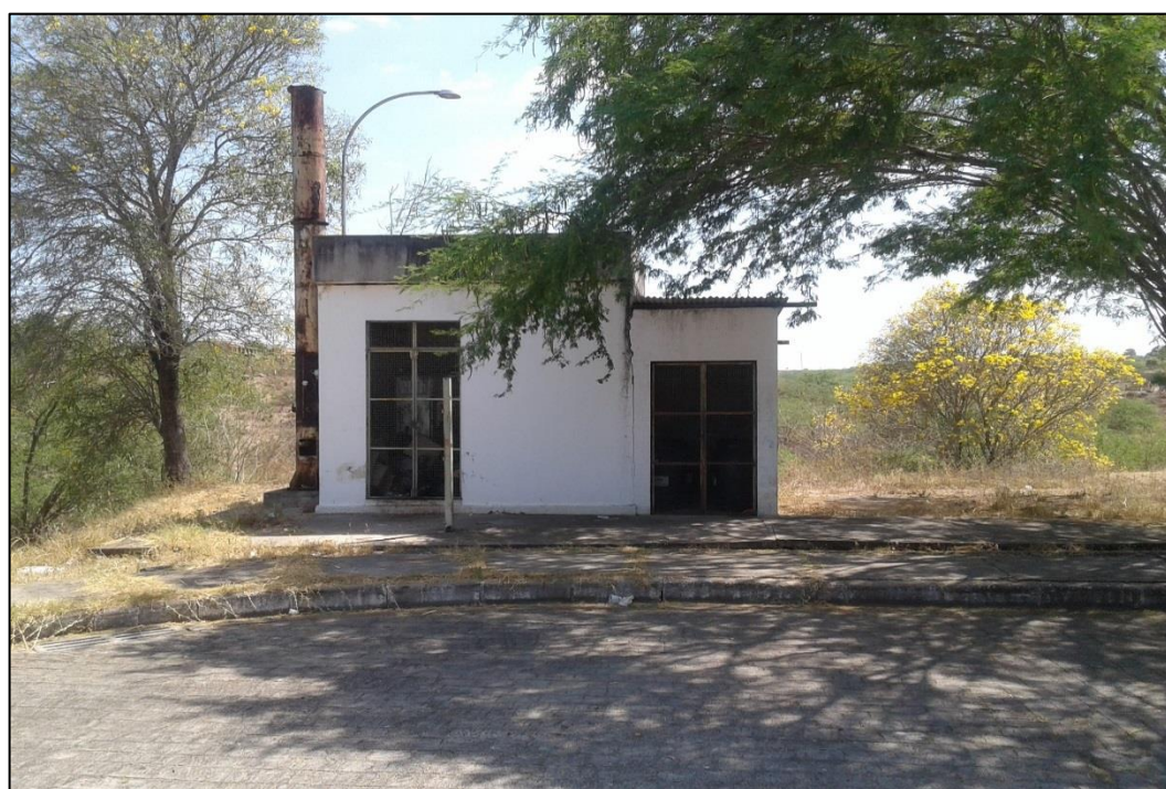
Figura 128 – Local de acondicionamento temporário dos resíduos de serviços de saúde no Hospital Municipal. Fonte: DRZ – Geotecnologia e Consultoria, 2017.
