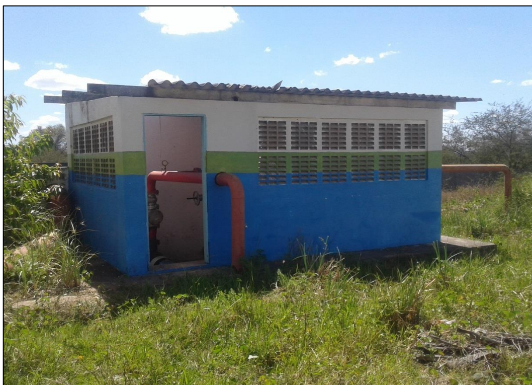
Figura 52 – Casa de bombas da Estação Elevatória de Água Bruta.
