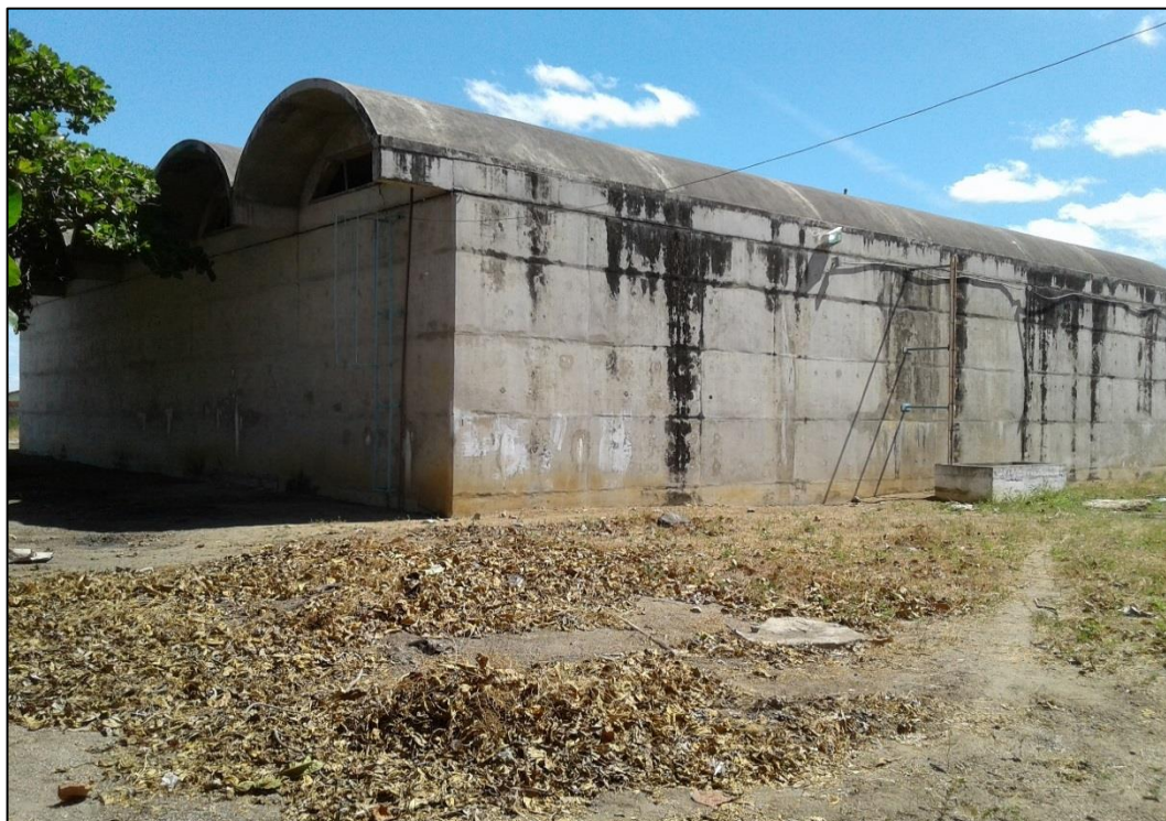
Figura 56 – Reservatório Apoiado localizado na ETA.
