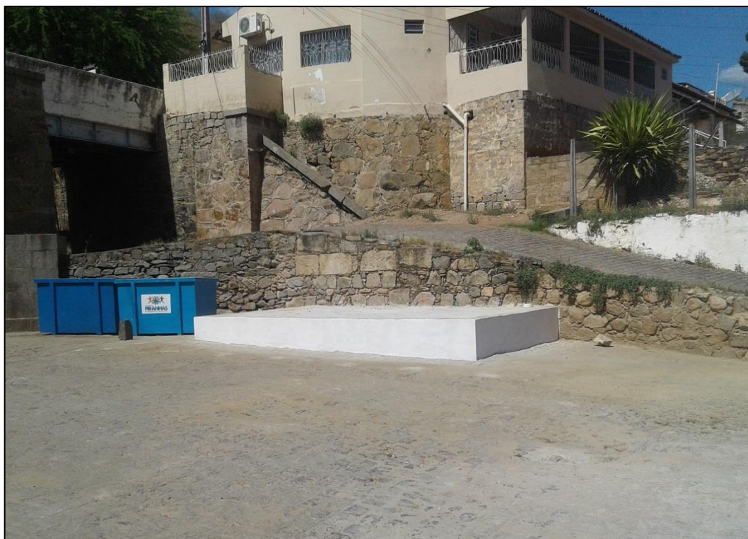
Figura 90 – Fossa coletiva instalada no centro histórico. Fonte: DRZ – Geotecnologia e Consultoria, 2017.
