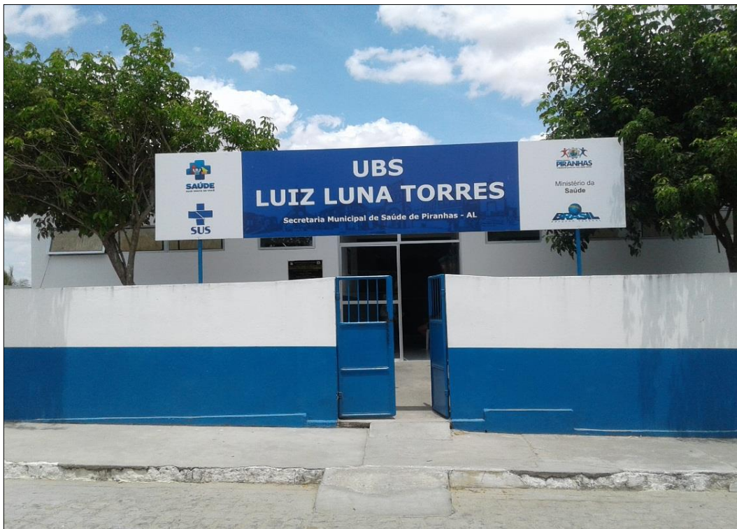
Figura 24 – Fachada da UBS Luiz Luna Torres – Lagoa Nova. Fonte: DRZ – Geotecnologia e Consultoria, 2017.
