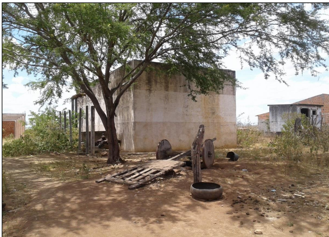
Figura 80 – RAP de concreto de 40 m 3 do distrito de Piau. Fonte: DRZ – Geotecnologia e Consultoria, 2017.
