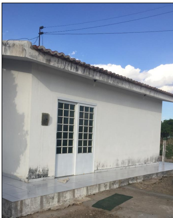
Figura 112 - Sede administrativa do Aterro Sanitário de Olivença. Fonte: DRZ – Geotecnologia e Consultoria, 2017.
