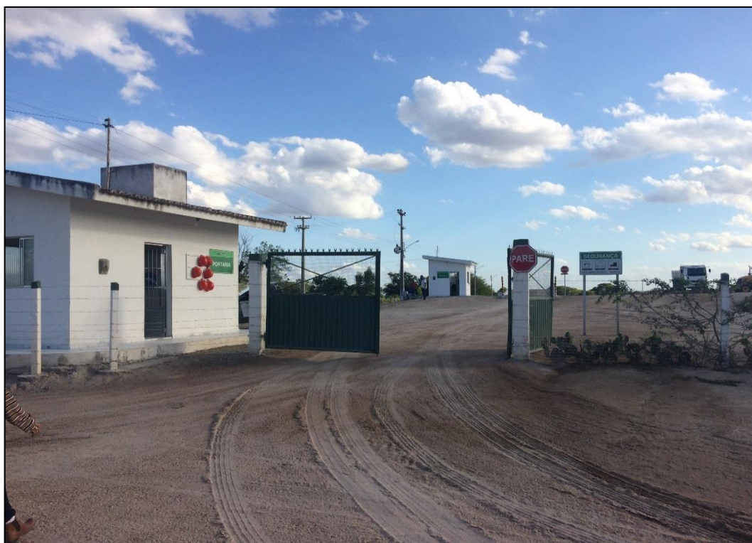
Figura 110 – Portaria do Aterro Sanitário de Olivença. Fonte: DRZ – Geotecnologia e Consultoria, 2017.
