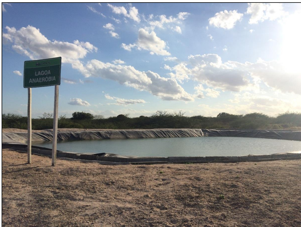
Figura 115 - Lagoa anaeróbia de tratamento de chorume do Aterro Sanitário de Olivença.
