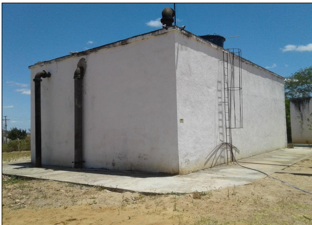
Figura 69 – Reservatório Apoiado na ETA ODC. Fonte: DRZ – Geotecnologia e Consultoria, 2017.
