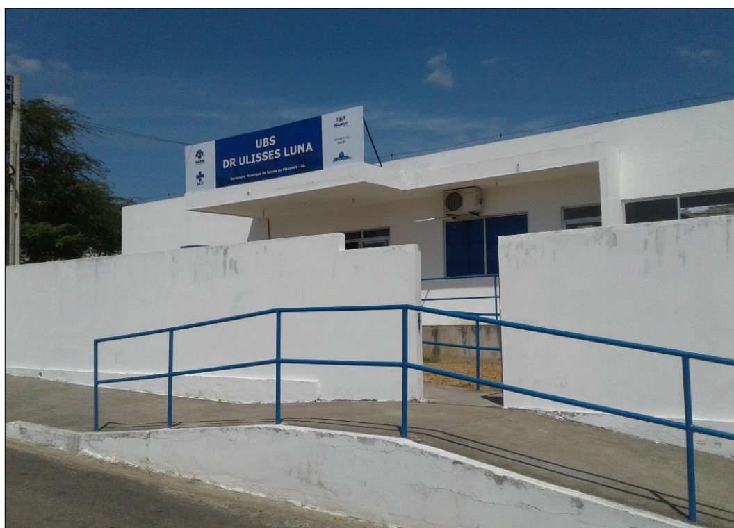
Figura 27 – Fachada da UBS Dr. Ulisses Luna. Fonte: DRZ – Geotecnologia e Consultoria, 2017.
