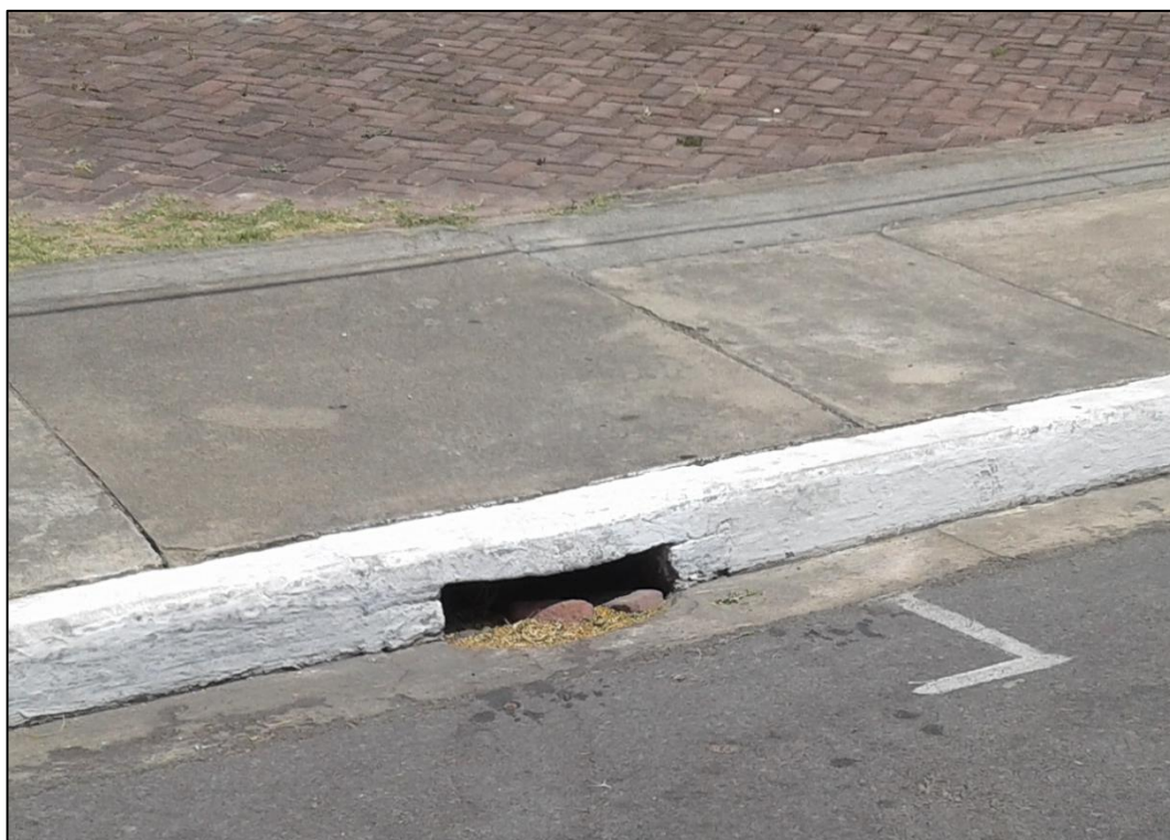
Figura 135 – Estrutura de captação lateral utilizada em Piranhas. Fonte: DRZ – Geotecnologia e Consultoria, 2017.
