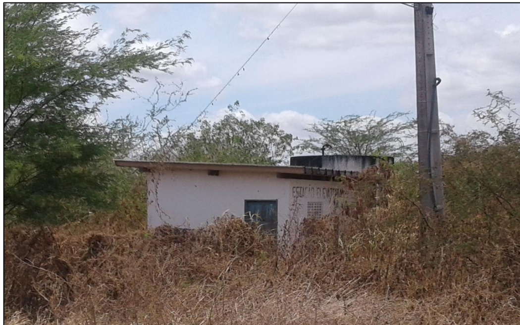
Figura 77 – Estação Elevatória de Água Tratada da comunidade de Lagoa Nova.
