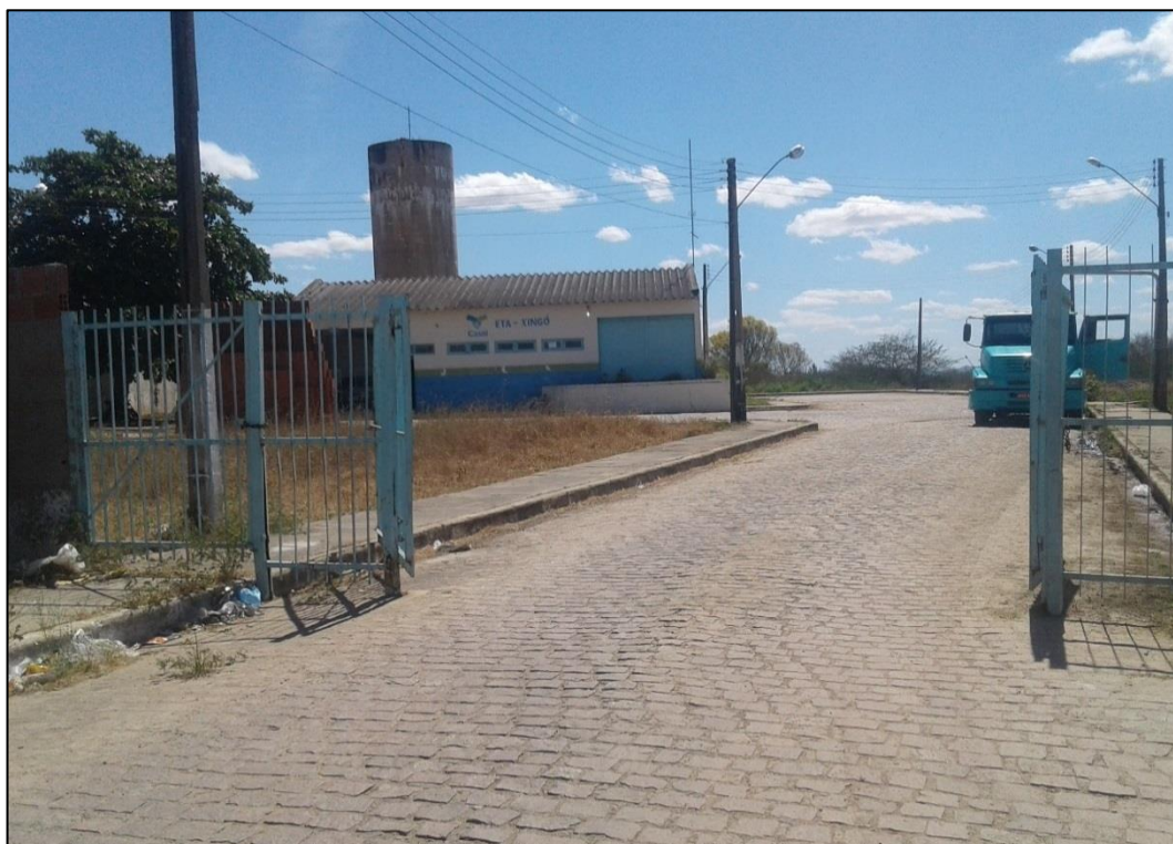
Figura 43 – Entrada e vista frontal do prédio da ETA. Fonte: DRZ – Geotecnologia e Consultoria, 2017.
