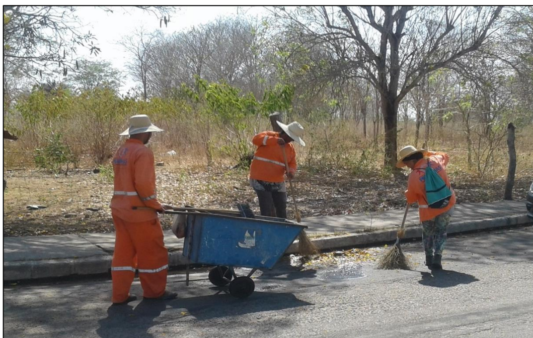
Figura 117 – Varredor e equipamentos utilizados nos serviços de varrição. Fonte: DRZ – Geotecnologia e Consultoria, 2017.
