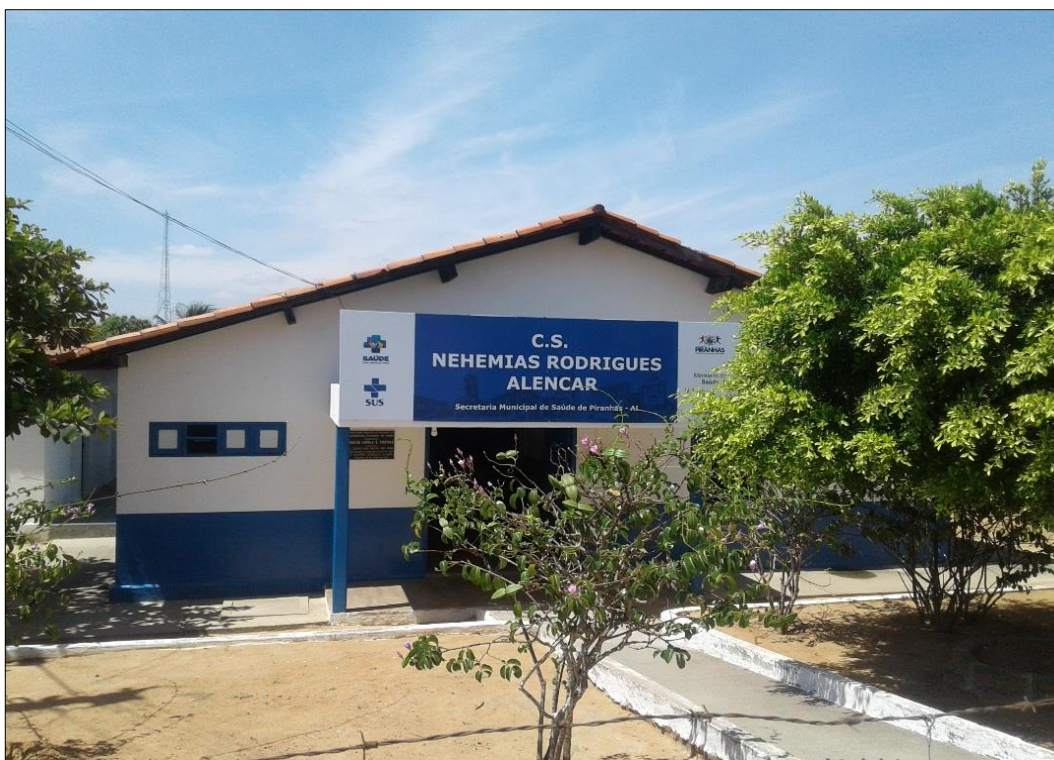
Figura 25 - Fachada da C.S Nehemias Rodrigues Alencar - Sede. Fonte: DRZ – Geotecnologia e Consultoria, 2017.
