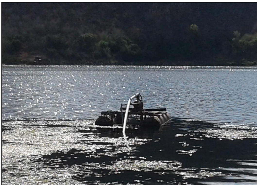
Figura 60 – Captação superficial do distrito de Entremontes.
