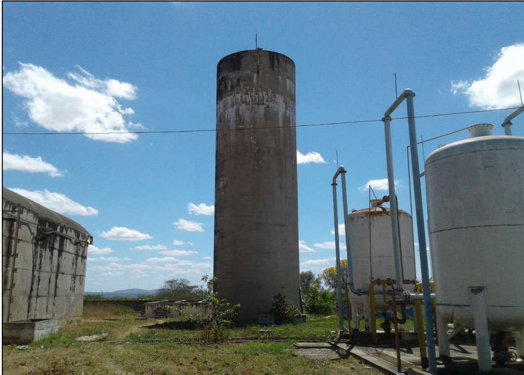
Figura 57 – Reservatório Elevado localizado na ETA. Fonte: DRZ – Geotecnologia e Consultoria, 2017.
