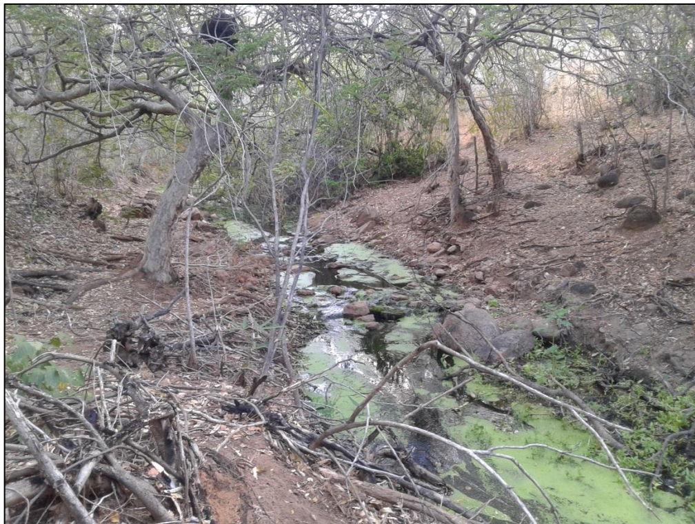
Figura 82 – Extravasamento de esgoto no Parque Ecológico Pedra do Sino. Fonte: DRZ – Geotecnologia e Consultoria, 2017.
