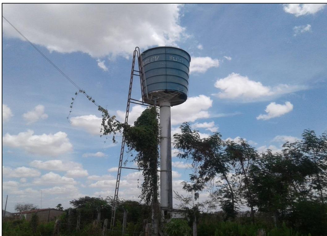
Figura 72 – REL de fibra de 10 m 3 do Assentamento Margaria Alves e Antônio Conselheiro.
