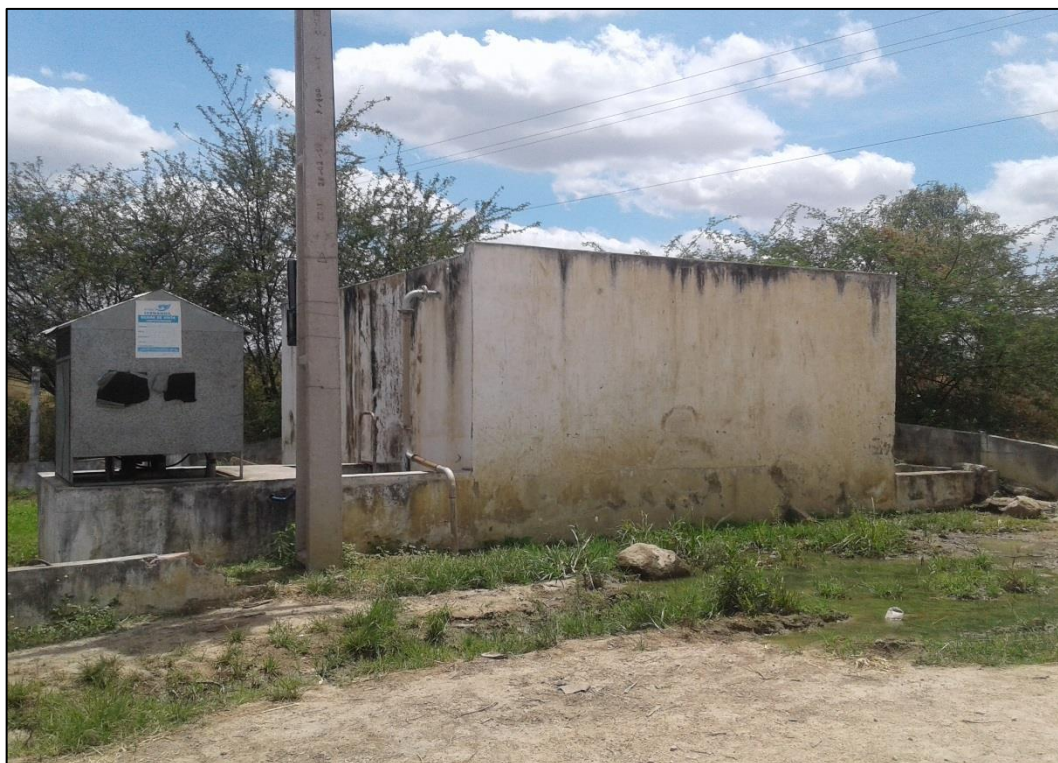
Figura 71 – RAP de concreto de 20 m 3 do Assentamento Margaria Alves e Antônio Conselheiro.
