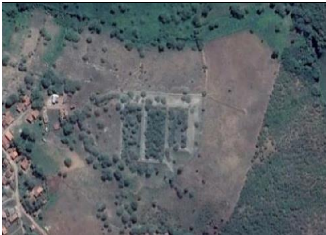
Figura 93 – Vista aérea da ETE. Fonte: Google Earth Pro, 2018.
