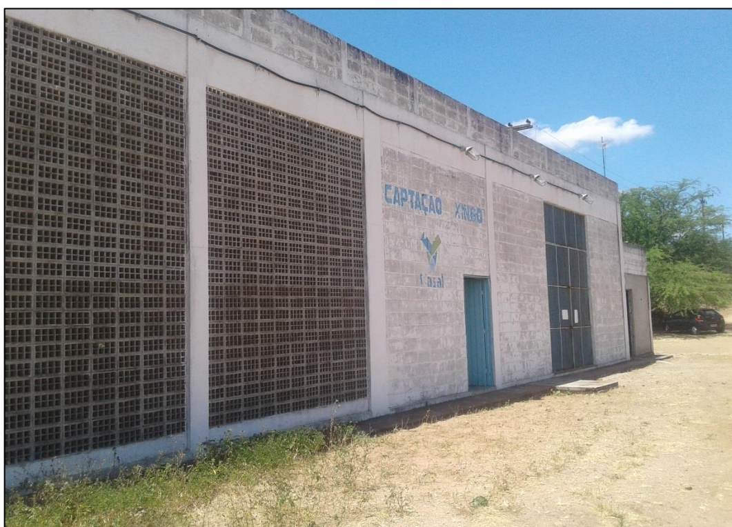
Figura 38 – Casa de bombas da captação superficial no rio São Francisco. Fonte: DRZ – Geotecnologia e Consultoria, 2017.
