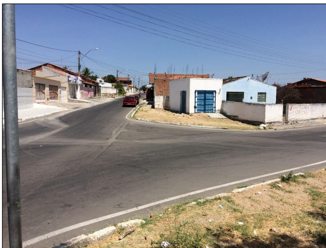
Figura 198 – Área com histórico de acúmulo de águas pluviais - Local 1. Fonte: DRZ – Geotecnologia e Consultoria, 2017.
