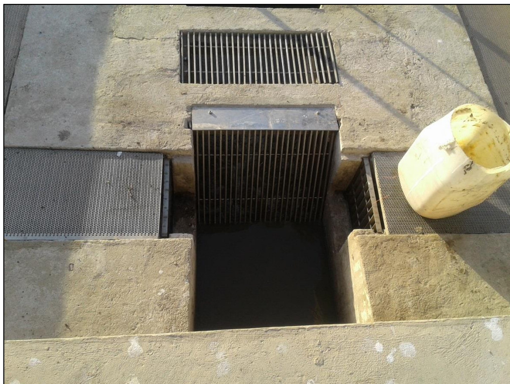
Figura 117 – Gradeamento - ETE BTN. Fonte: DRZ – Geotecnologia e Consultoria, 2017.
