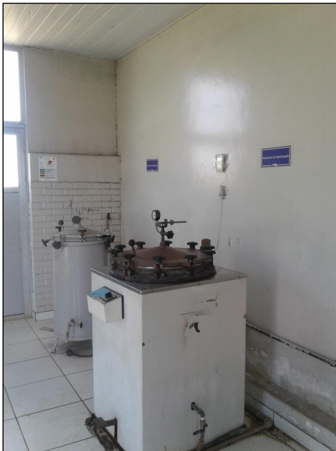
Figura 55 – Laboratório Bacteriológico (2) - ETA Centro. Fonte: DRZ – Geotecnologia e Consultoria, 2017.
