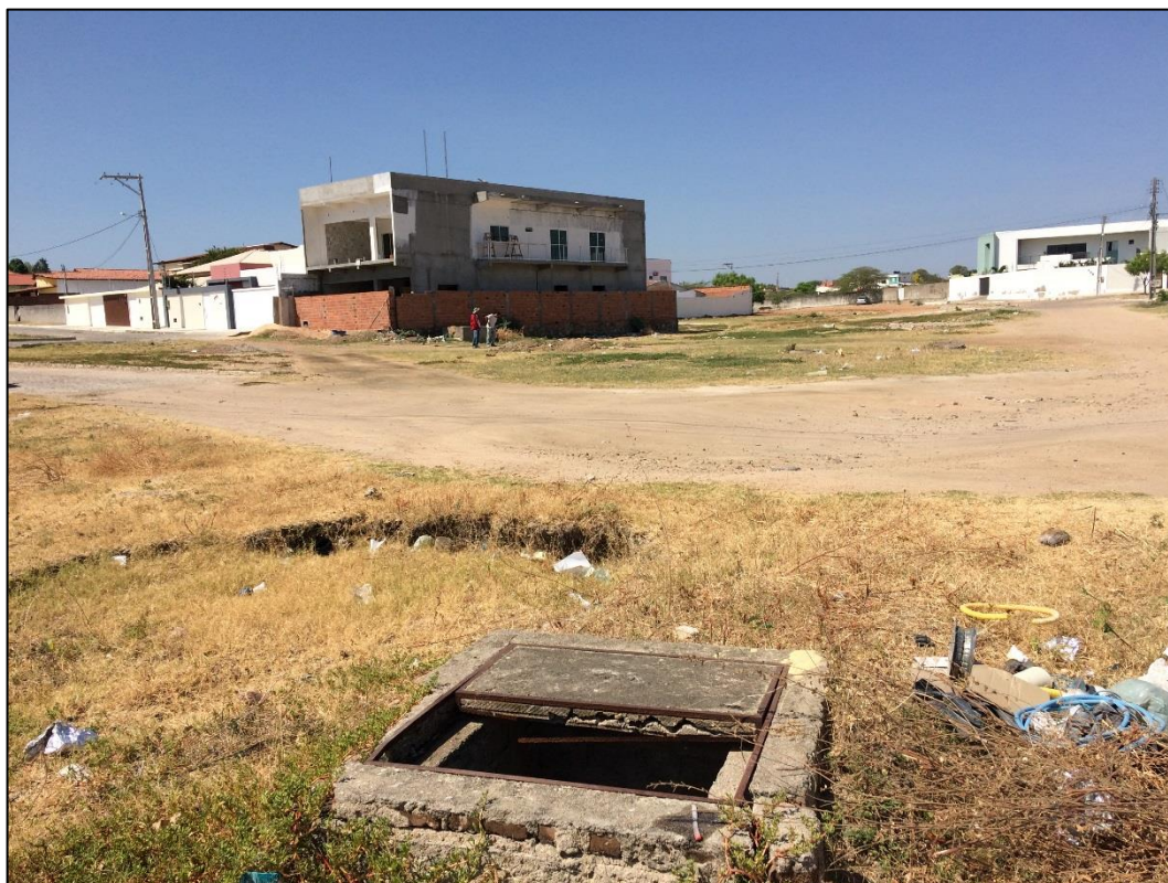
Figura 190 – Área com histórico de acúmulo de água pluvial - Local 6. Fonte: DRZ – Geotecnologia e Consultoria, 2017.
