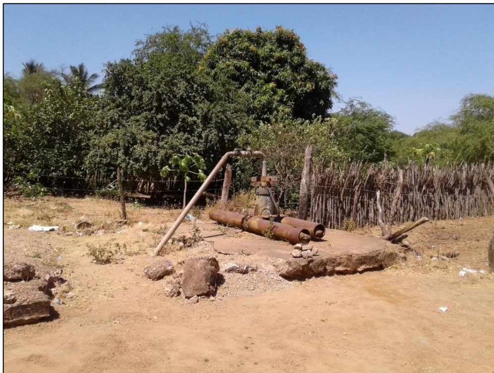
Figura 79 – Poço 1 - Comunidade Juá. Fonte: DRZ – Geotecnologia e Consultoria, 2017.
