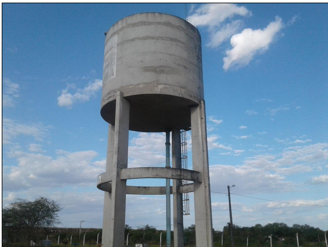
Figura 60 – REL Retro lavagem – 200 m 3 - Reservatório ETA - BTN. Fonte: DRZ – Geotecnologia e Consultoria, 2017.
