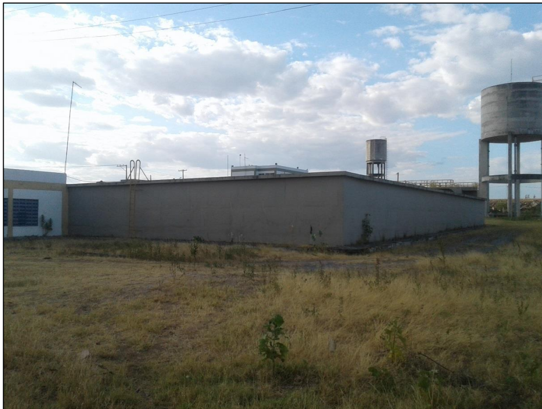
Figura 59 – RAP 2 - 2.000 m 3 - Reservatório ETA - BTN. Fonte: DRZ – Geotecnologia e Consultoria, 2017.
