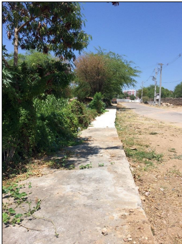
Figura 96 – Rede de drenagem que encaminha o efluente de esgoto doméstico à EEE IV.
