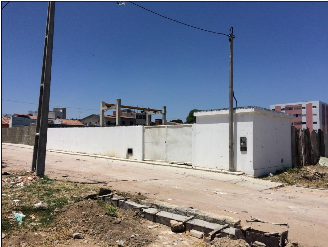
Figura 106 – EEE Condomínio Girassol. Fonte: DRZ – Geotecnologia e Consultoria, 2017.
