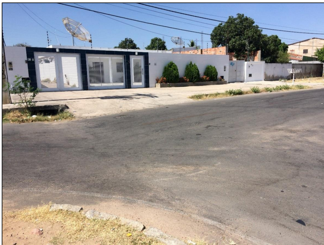
Figura 192 – Área em cota altimétrica com rede de drenagem insuficiente - Local 8.
