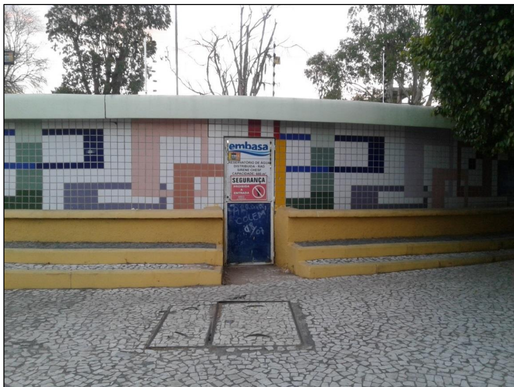
Figura 65 – RAP 600 m 3 - Centro. Fonte: DRZ – Geotecnologia e Consultoria, 2017.
