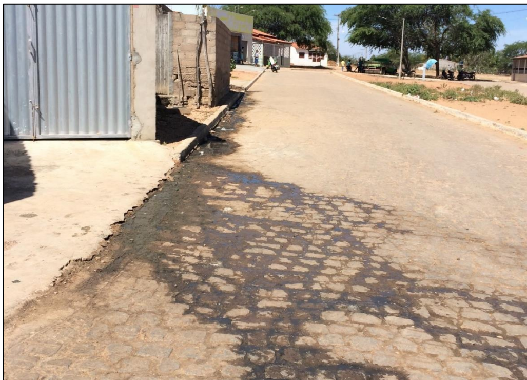
Figura 130 – Efluente de esgoto doméstico lançado em via pública - Comunidade Rural de São José.
