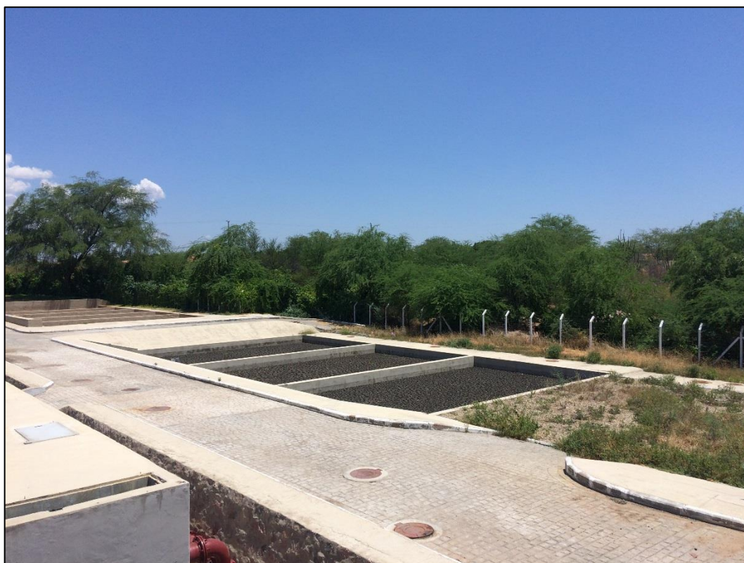
Figura 111 – Área dos leitos de secagem - ETE Centro. Fonte: DRZ – Geotecnologia e Consultoria, 2017.
