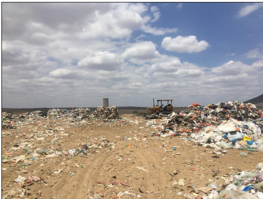
Figura 149 – Queimador de gás da célula em operação. Fonte: DRZ – Geotecnologia e Consultoria, 2017.
