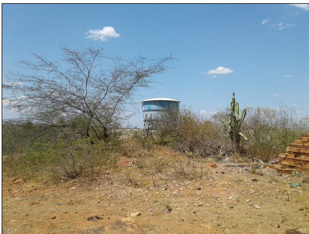
Figura 91 – RAP - 10m 3 - Comunidade Várzea. Fonte: DRZ – Geotecnologia e Consultoria, 2017.
