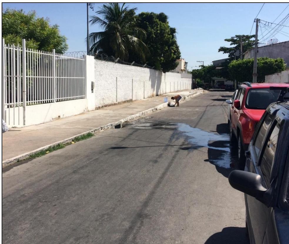
Figura 194 – Área com histórico de alagamento devido a insuficiência de rede de drenagem - Local 10.
