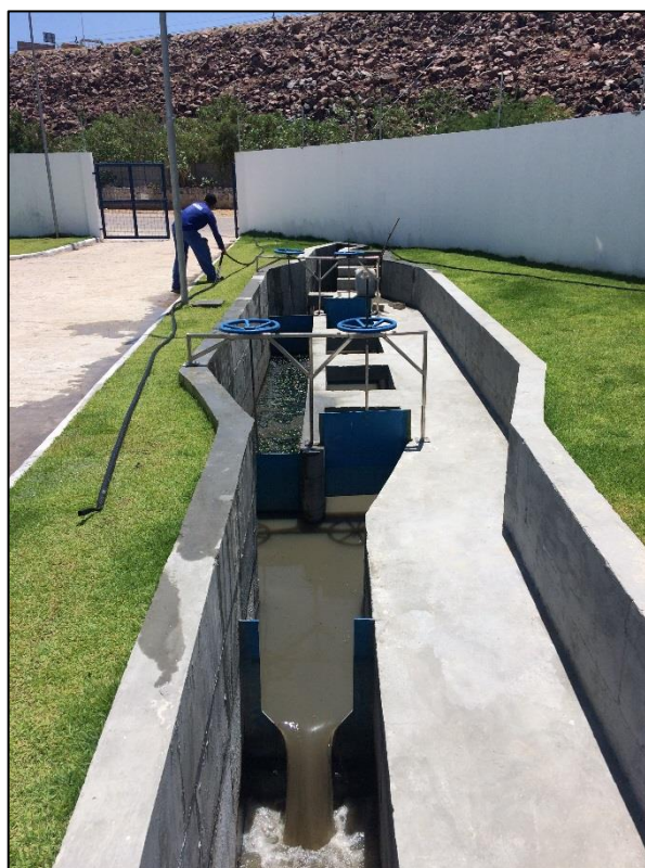
Figura 105 – Calha Parshall e gradeamento da EEE IV. Fonte: DRZ – Geotecnologia e Consultoria, 2017.
