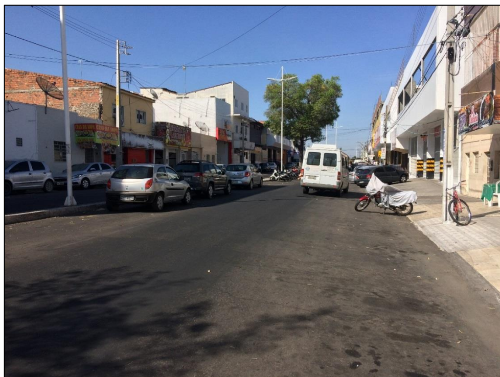
Figura 195 – Área com histórico de alagamento devido a inexistência de rede de drenagem - Local 11.
