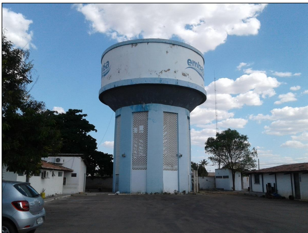
Figura 64 – REL 750 m 3 - Reservatório ETA - Centro. Fonte: DRZ – Geotecnologia e Consultoria, 2017.
