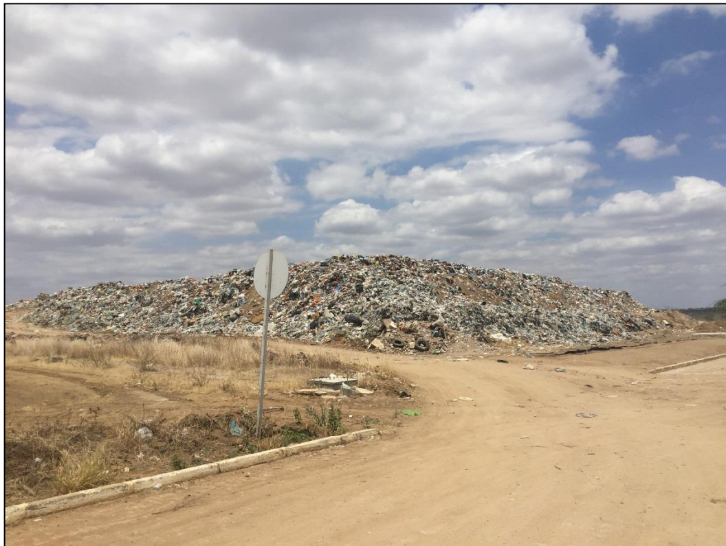
Figura 148 – Célula em operação sem o devido aterramento. Fonte: DRZ – Geotecnologia e Consultoria, 2017.
