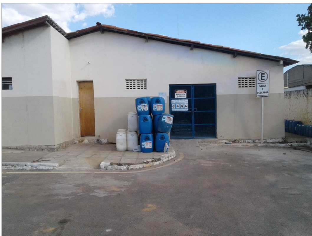
Figura 49 – Depósito de produtos químicos - Sistema Centro. Fonte: DRZ – Geotecnologia e Consultoria, 2017.
