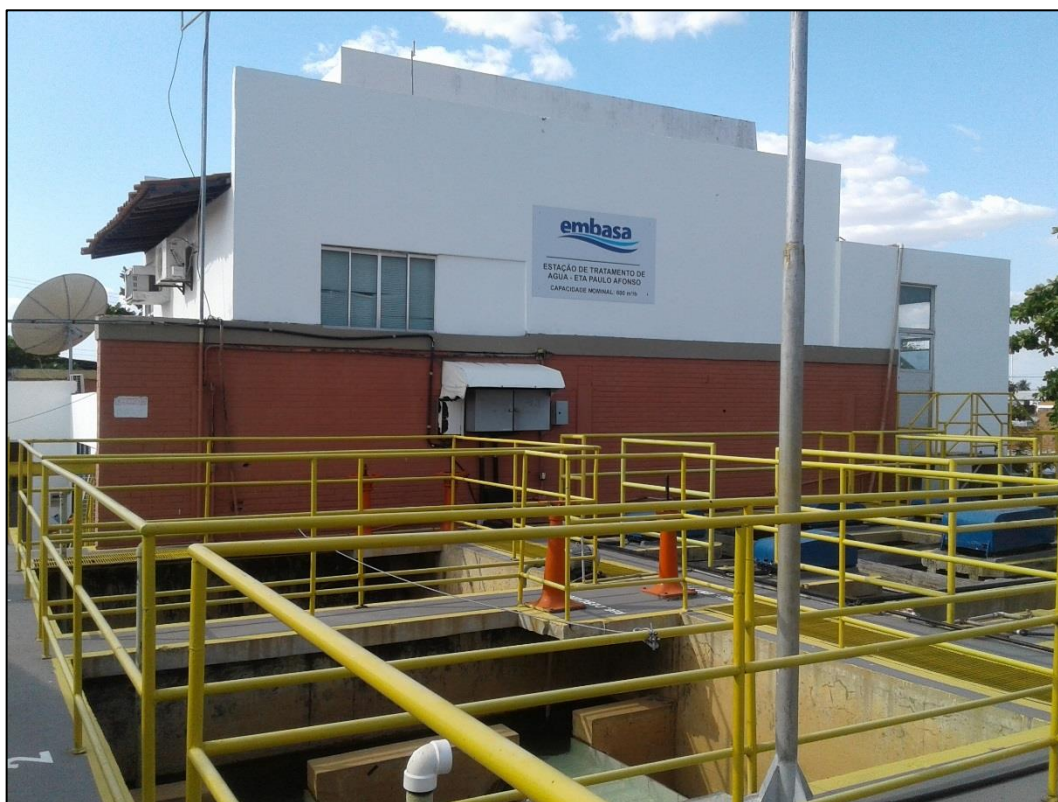
Figura 39 – Vista frontal da ETA – Sistema Centro. Fonte: DRZ – Geotecnologia e Consultoria, 2017.
