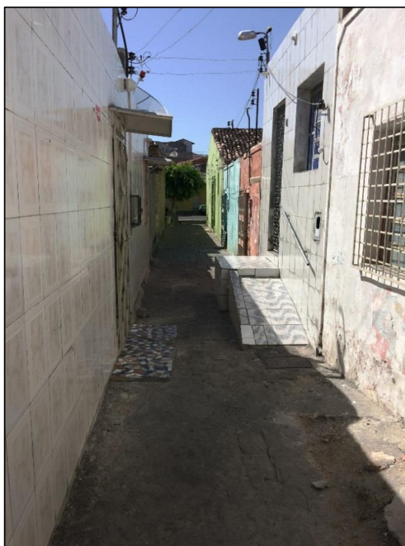
Figura 188 – Ponto com histórico de alagamento devido a inexistência de rede de drenagem - Local 4.
