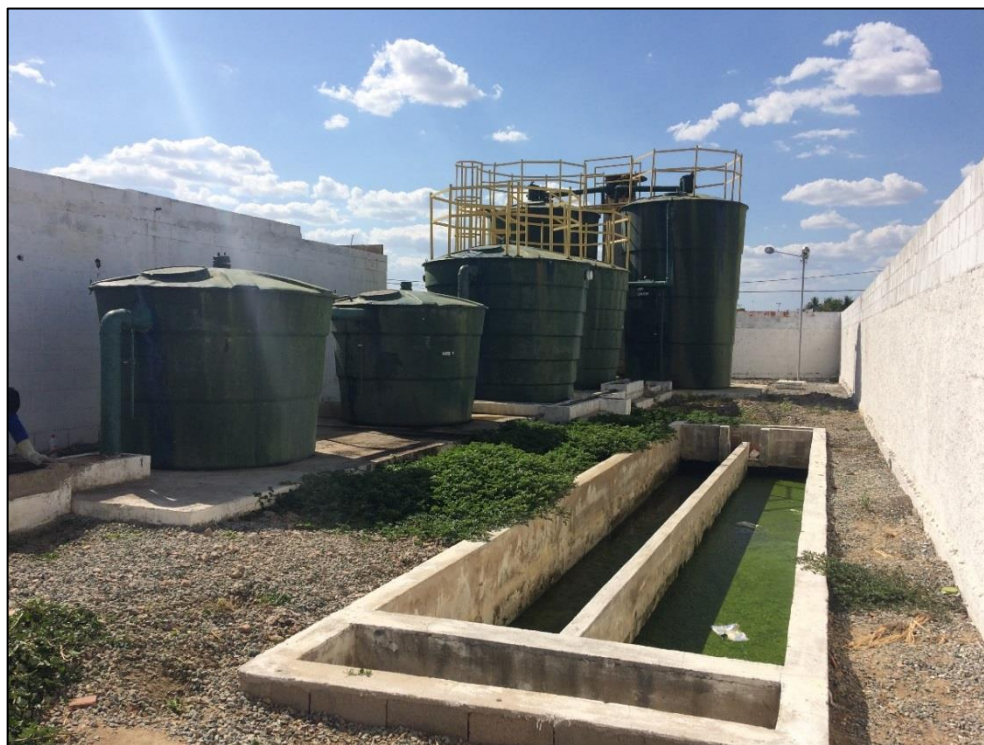
Figura 124 – ETE Amanda Moraes. Fonte: DRZ – Geotecnologia e Consultoria, 2017.
