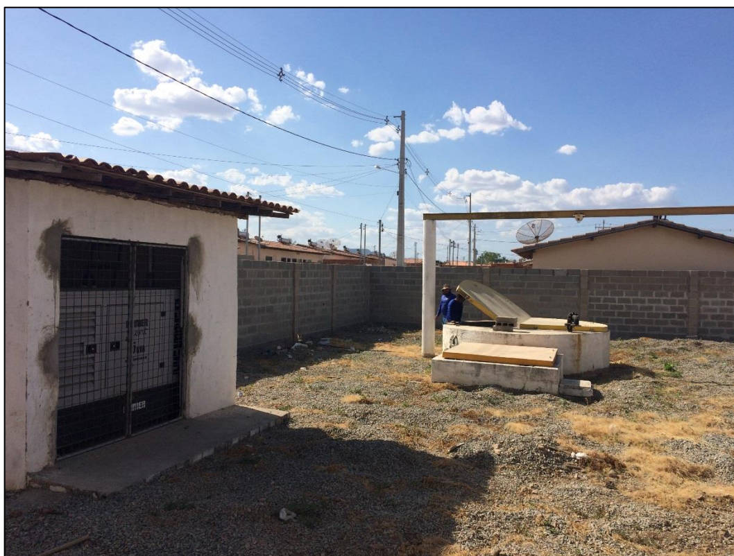
Figura 123 – Estação Elevatória de Esgoto Amanda Moraes.
