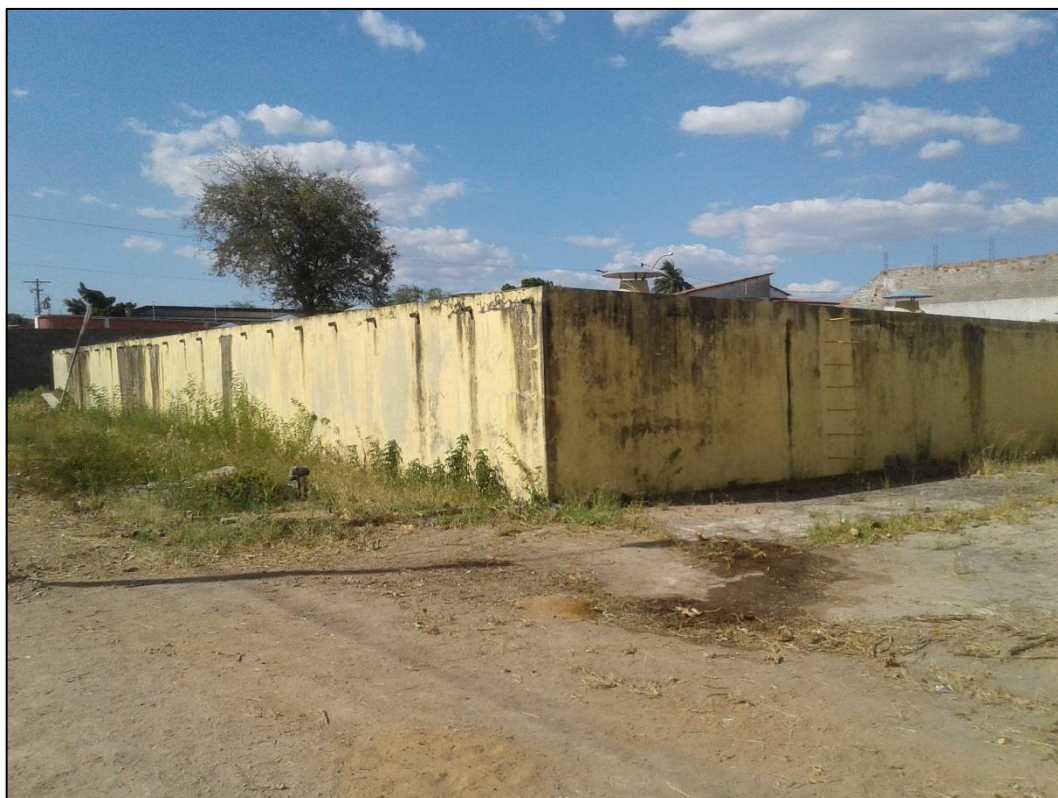
Figura 63 – RAP 1.200 m 3 - Reservatório ETA - Centro. Fonte: DRZ – Geotecnologia e Consultoria, 2017.
