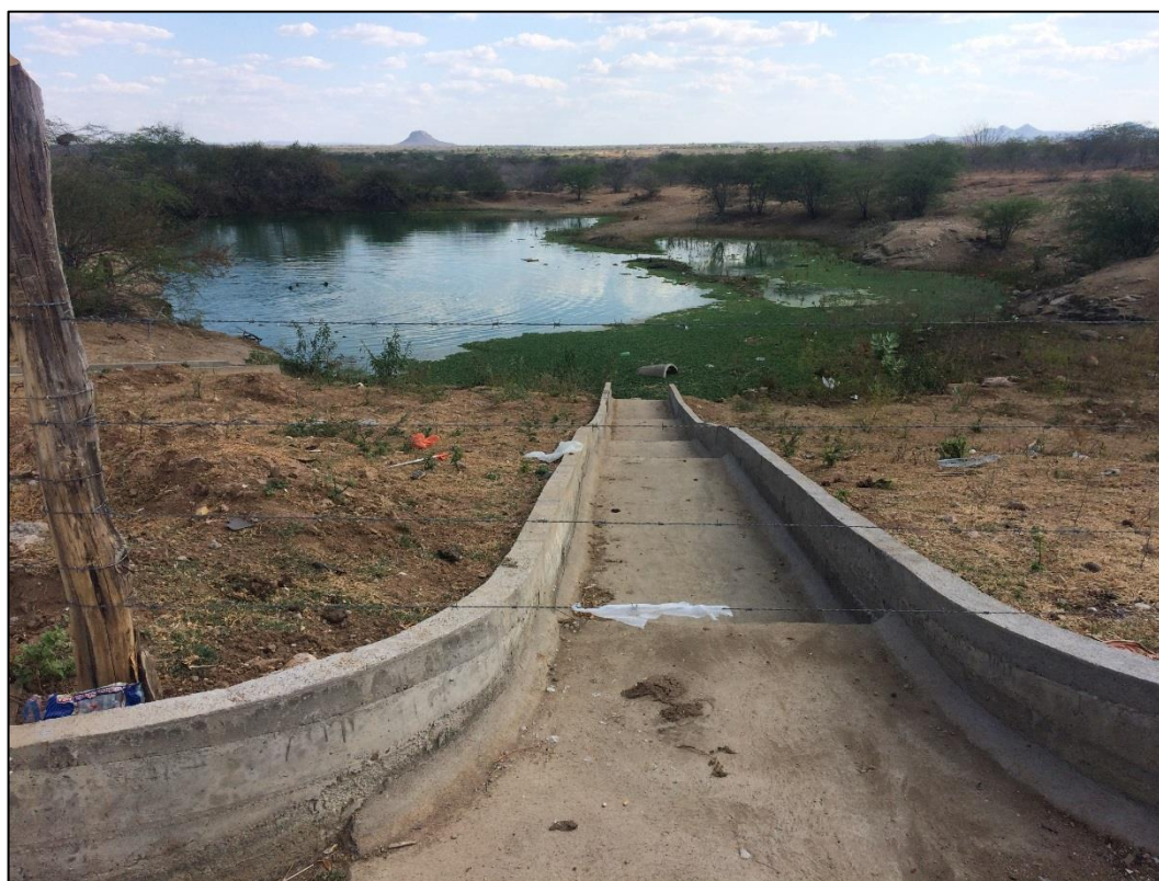
Figura 182 – Reservatório de retenção do tipo a céu aberto e não estruturado com fundo impermeabilizado - Bairro Dom Mario.
