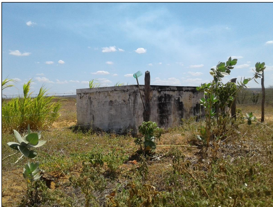
Figura 92 – RAP 3 - 20m 3 - Comunidade Várzea. Fonte: DRZ – Geotecnologia e Consultoria, 2017.
