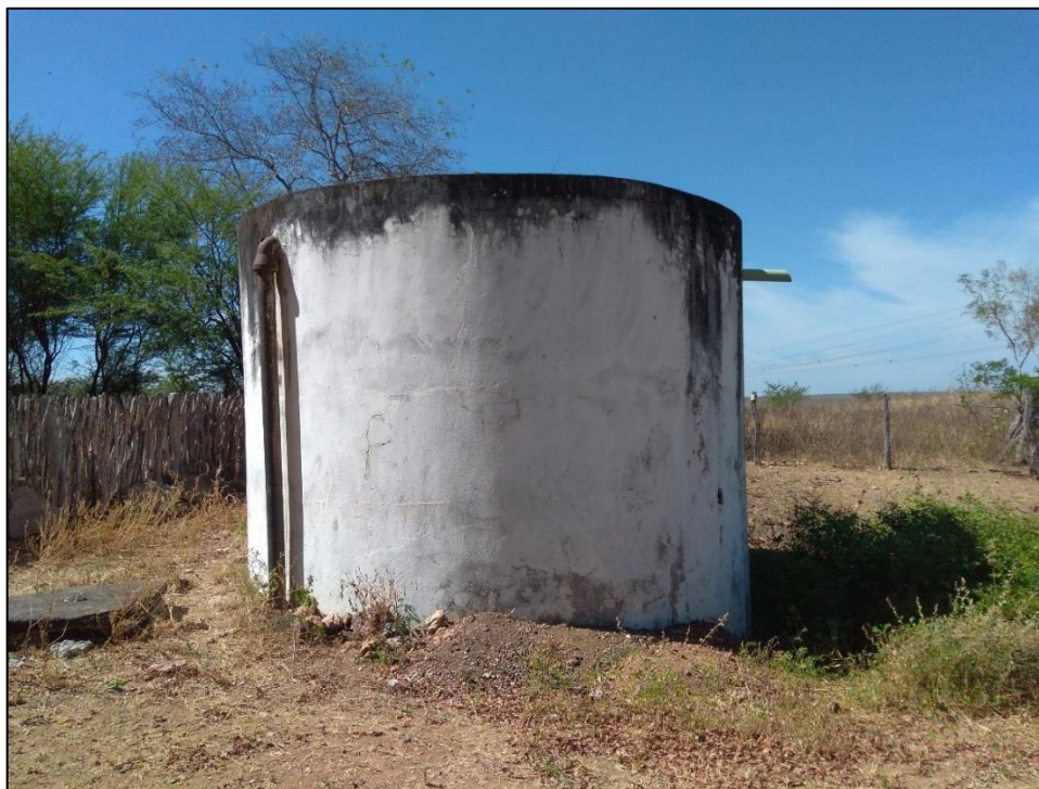
Figura 71 – RAP 50m 3 - Comunidade de Riacho. Fonte: DRZ – Geotecnologia e Consultoria, 2017.
