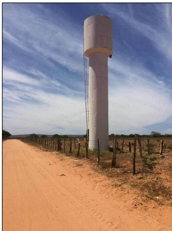
Figura 76 – Reservatório (50 m 3 ) - Comunidade São José. Fonte: DRZ – Geotecnologia e Consultoria, 2017.
