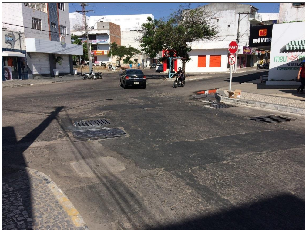
Figura 193 – Ponto com histórico de alagamento na região central - Local 9.
