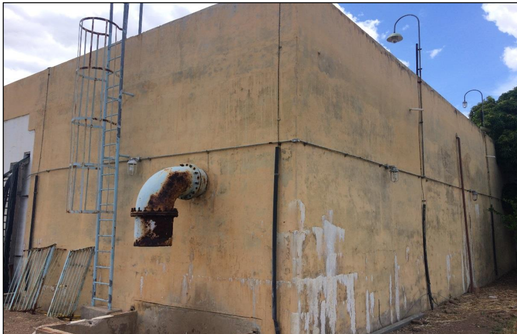
Figura 53 – Reservatório de contato para desinfecção com adição de cloro. Fonte: DRZ – Geotecnologia e Consultoria, 2017.
