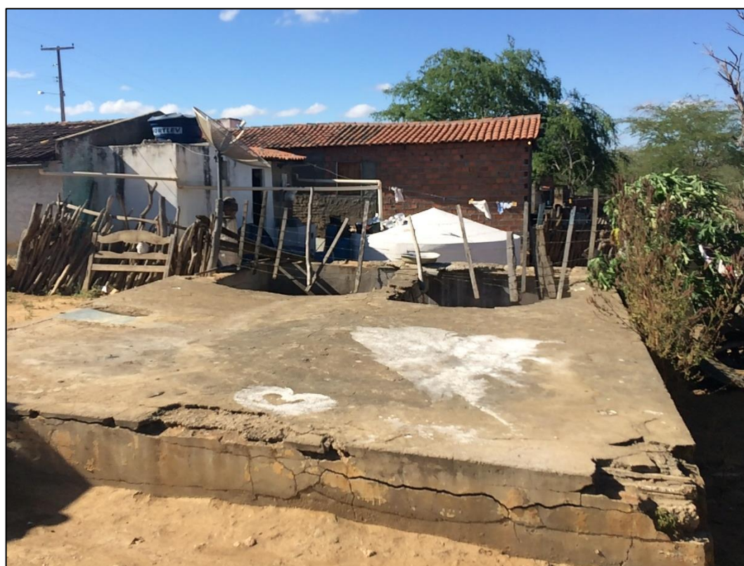
Figura 63 – Cisterna pública próxima a cisterna do controlador. Fonte: DRZ – Geotecnologia e Consultoria, 2017.
