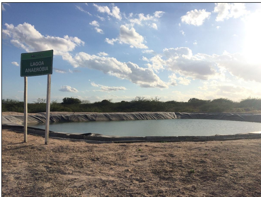
Figura 90 - Lagoa anaeróbia de tratamento de chorume do Aterro Sanitário de Olivença.
