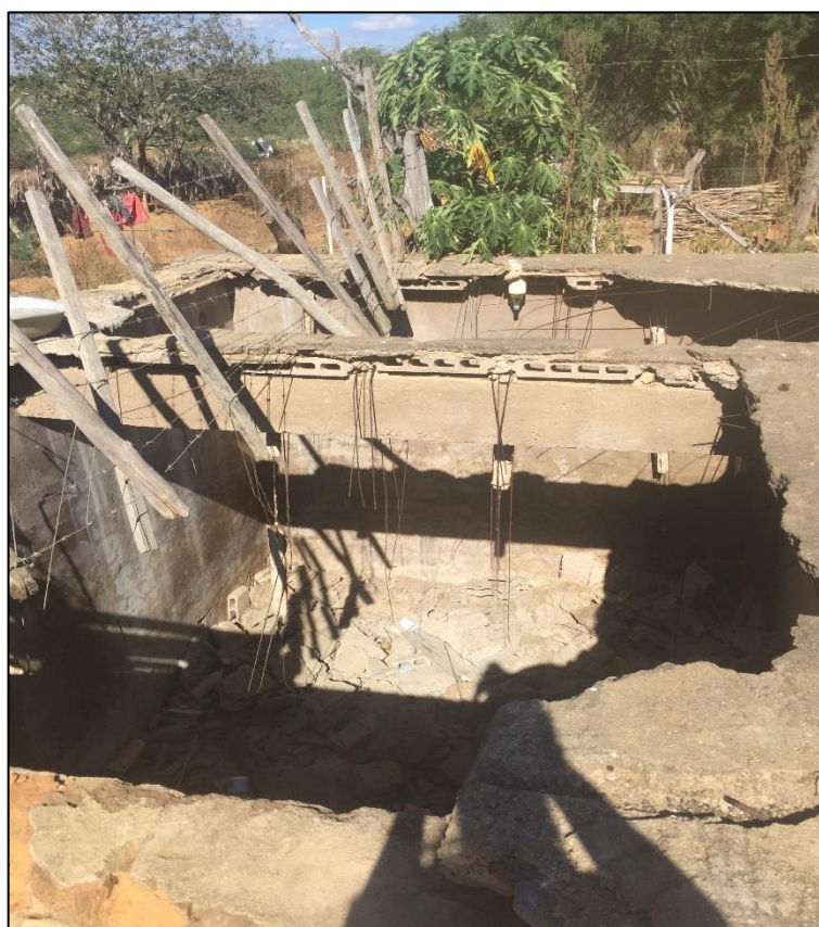
Figura 64 – Cisterna Pública. Fonte: DRZ – Geotecnologia e Consultoria, 2017.
