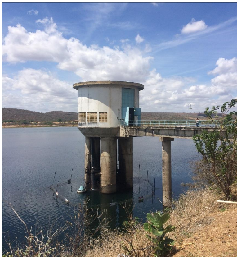
Figura 30 – Captação superficial no Rio São Francisco: Pão de Açúcar. Fonte: DRZ – Geotecnologia e Consultoria, 2017.
