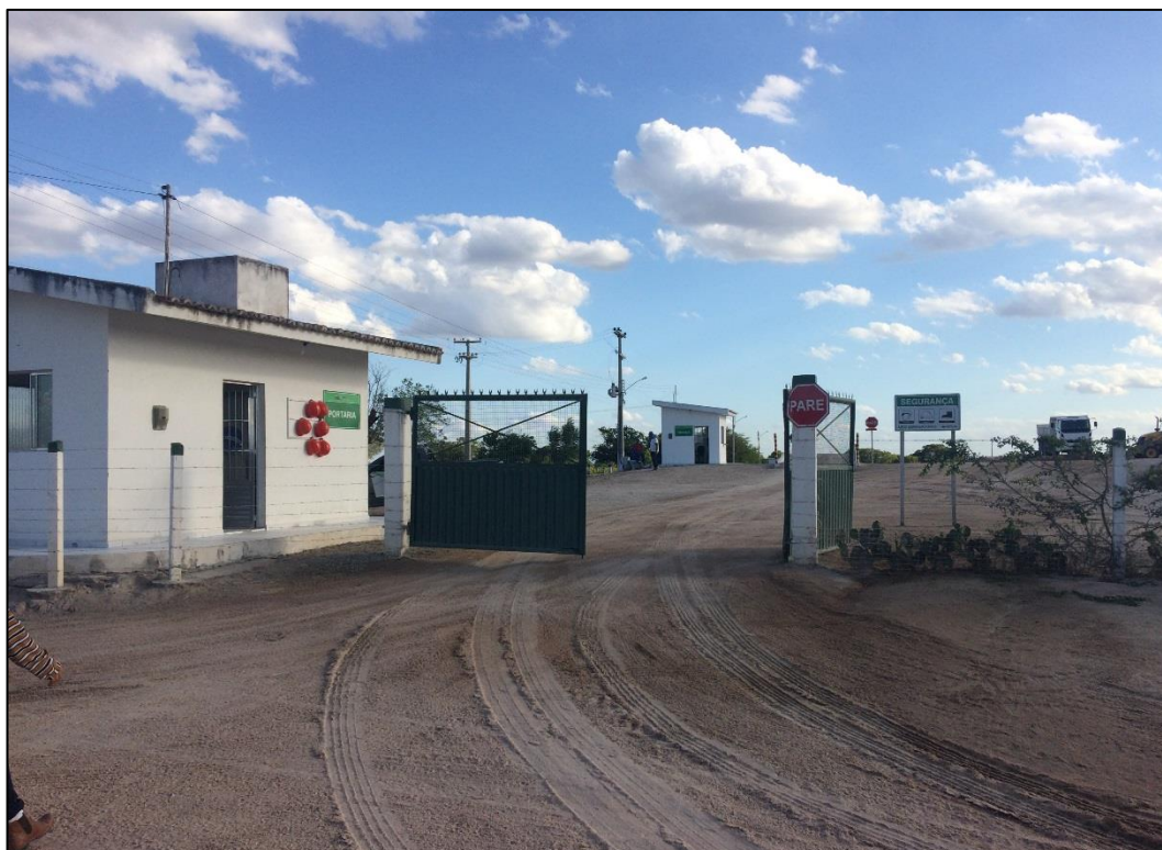
Figura 85 – Portaria do Aterro Sanitário de Olivença. Fonte: DRZ – Geotecnologia e Consultoria, 2017.
