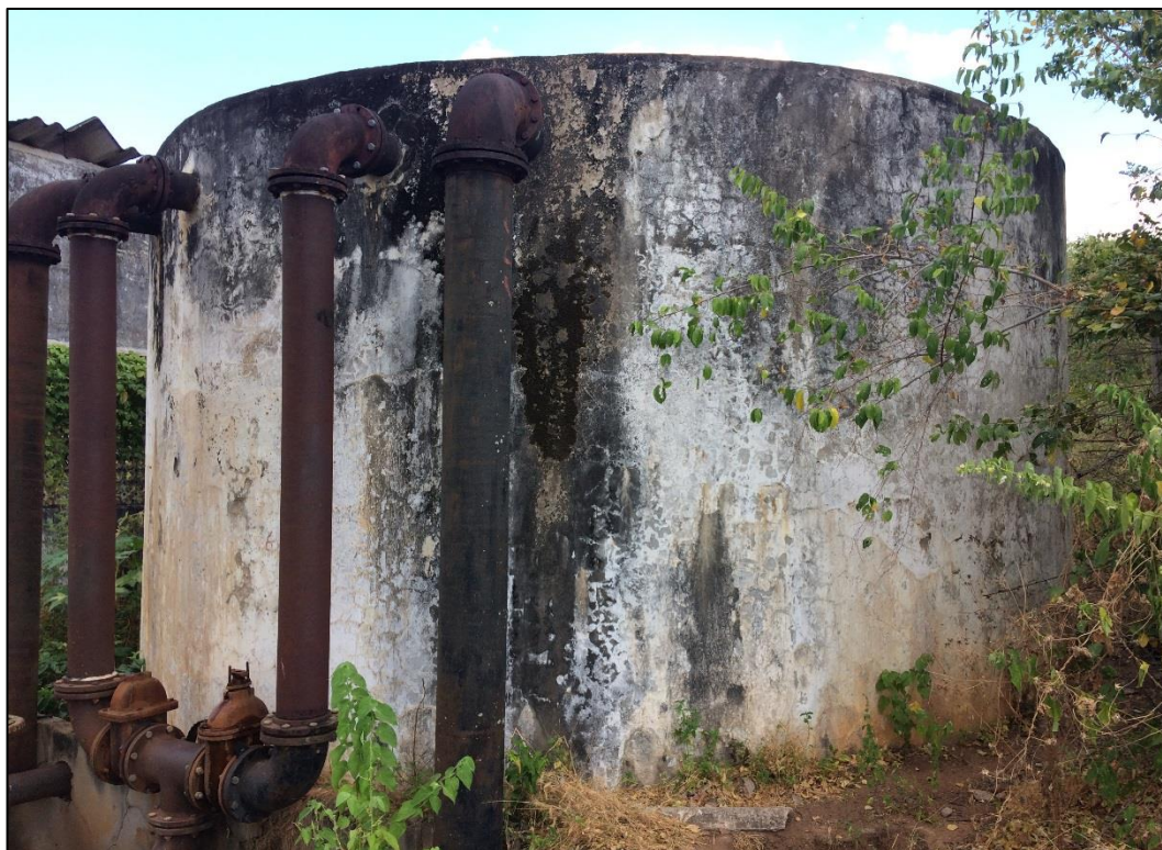
Figura 57 – Reservatório apoiado – Distrito Sede.
