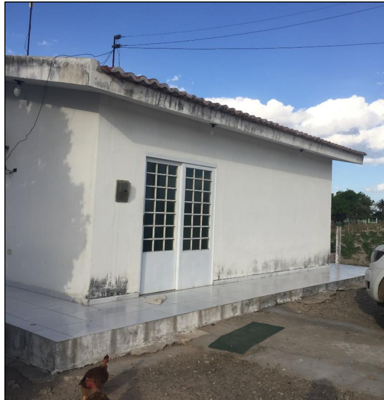
Figura 87 - Sede administrativa do Aterro Sanitário de Olivença. Fonte: DRZ – Geotecnologia e Consultoria, 2017.
