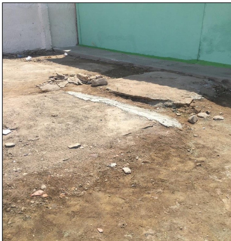
Figura 79 – Fossa rudimentar residencial no Distrito de São Cristóvão. Fonte: DRZ – Geotecnologia e Consultoria, 2017.
