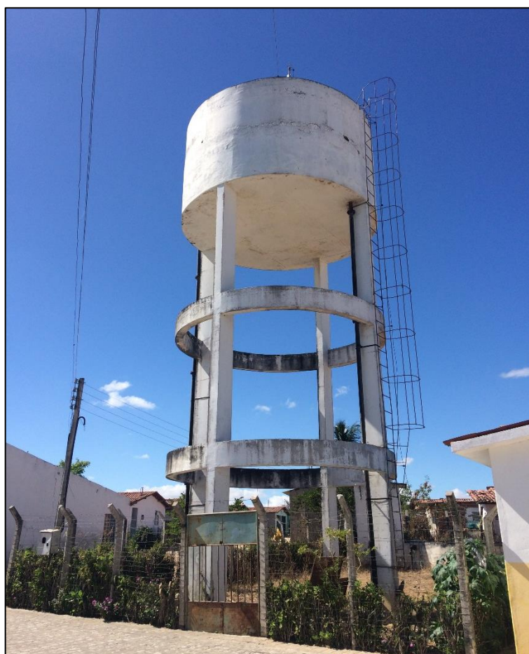
Figura 68 – Reservatório Elevado – REL Cedro. Fonte: DRZ – Geotecnologia e Consultoria, 2017.
