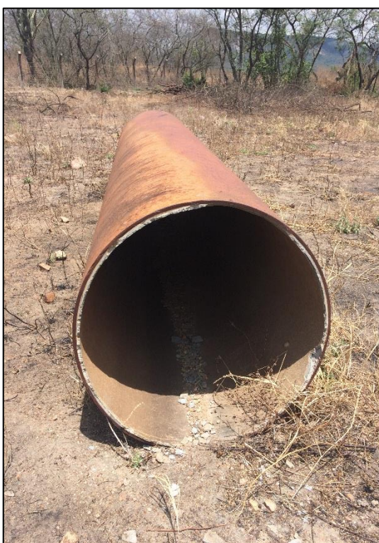
Figura 35 – Detalhe da composição da Adutora de Água Tratada.
