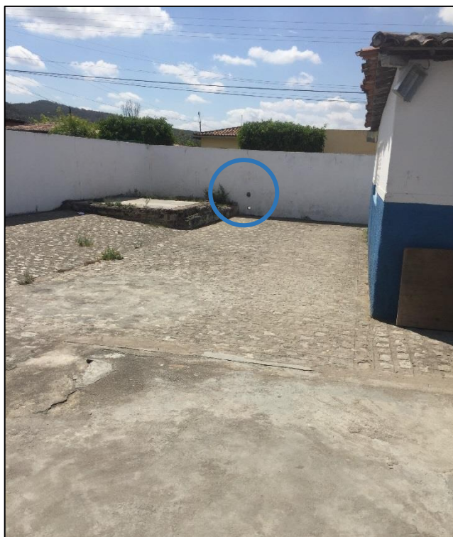
Figura 71 – Abertura no muro para abastecimento.
