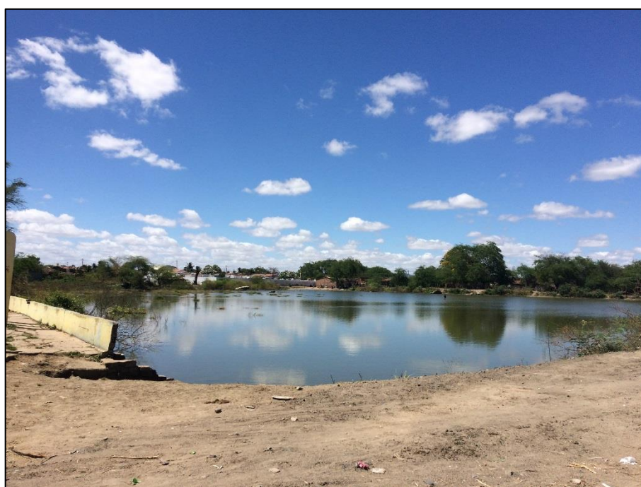
Figura 104 – Lagoa de contenção de águas pluviais.
