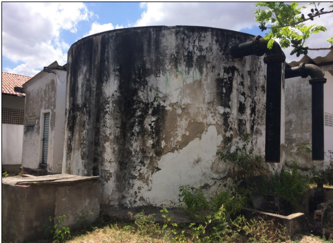
Figura 49 – Reservatório da EEAT IV. Fonte: DRZ – Geotecnologia e Consultoria, 2017.
