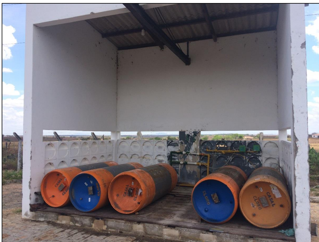
Figura 55 – Aplicação de cloro gás no tratamento. Fonte: DRZ – Geotecnologia e Consultoria, 2017.
