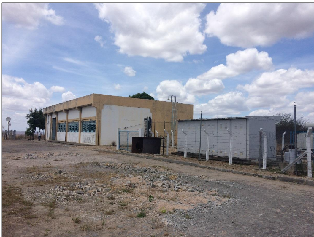
Figura 39 – Estação Elevatória de Água Tratada – EEAT I. Fonte: DRZ – Geotecnologia e Consultoria, 2017.
