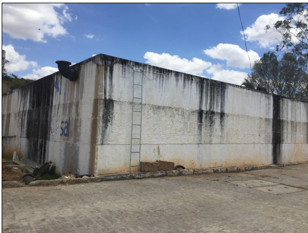
Figura 56 – Aplicação de cloro pastilha no reservatório da EEAT III. Fonte: DRZ – Geotecnologia e Consultoria, 2017.
