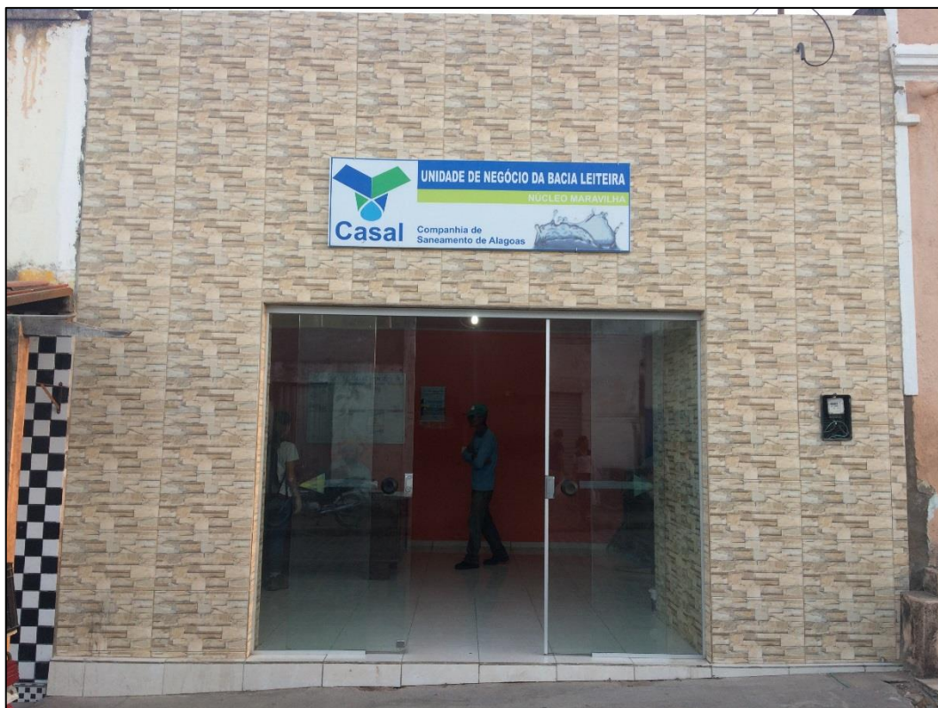
Figura 29 – Unidade da CASAL de Maravilha. Fonte: DRZ – Geotecnologia e Consultoria, 2017.
