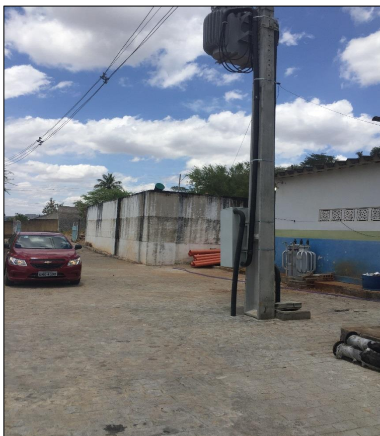
Figura 47 – Estação Elevatória de Água Tratada – EEAT III. Fonte: DRZ – Geotecnologia e Consultoria, 2017.
