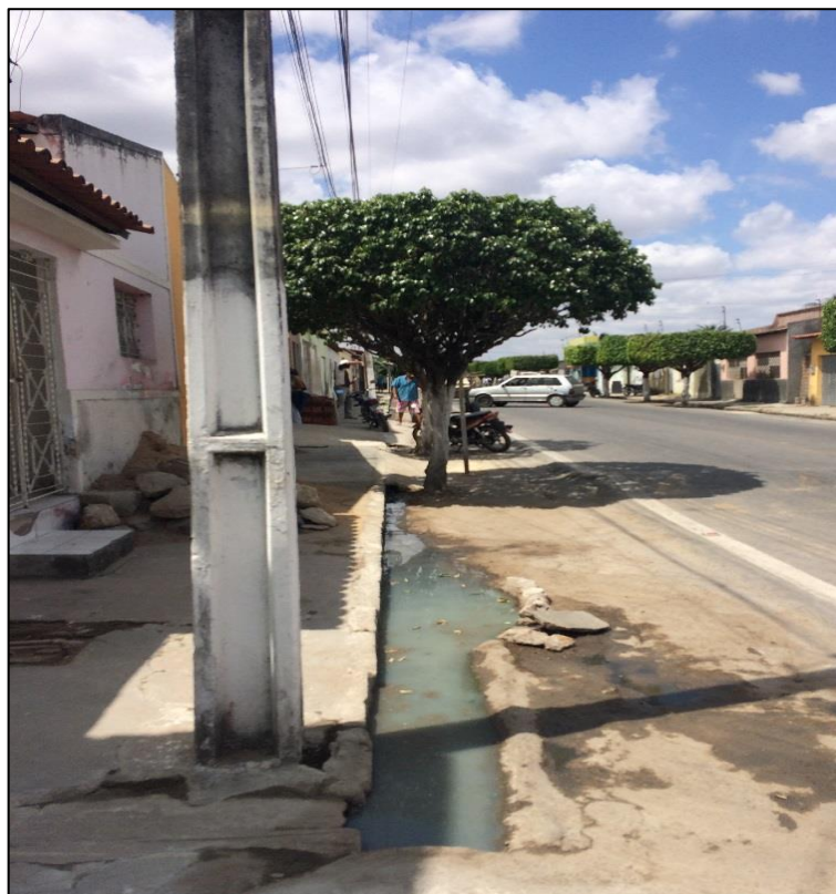
Figura 73 – Lançamento irregular de esgoto diretamente nas vias públicas do Distrito Sede.
