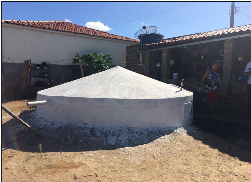
Figura 62 – Cisterna na residência do controlador. Fonte: DRZ – Geotecnologia e Consultoria, 2017.
