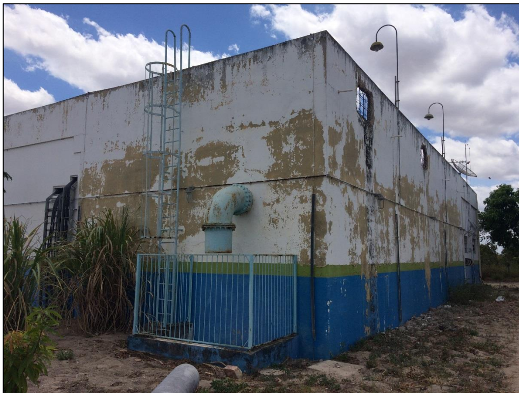
Figura 44 – Reservatório da EEAT II. Fonte: DRZ – Geotecnologia e Consultoria, 2017.
