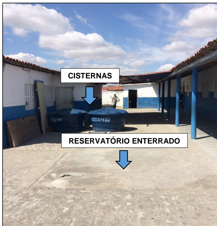
Figura 70 – Reservatório enterrado e cisternas para abastecimento com caminhão pipa.
