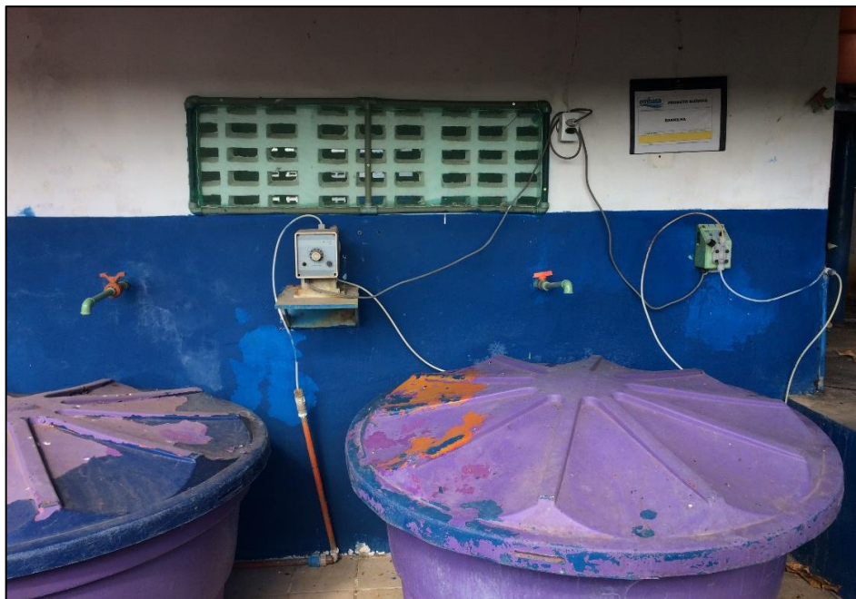
Figura 88 – Aplicação de barrilha para tratamento da água. Fonte: DRZ – Geotecnologia e Consultoria, 2017.
