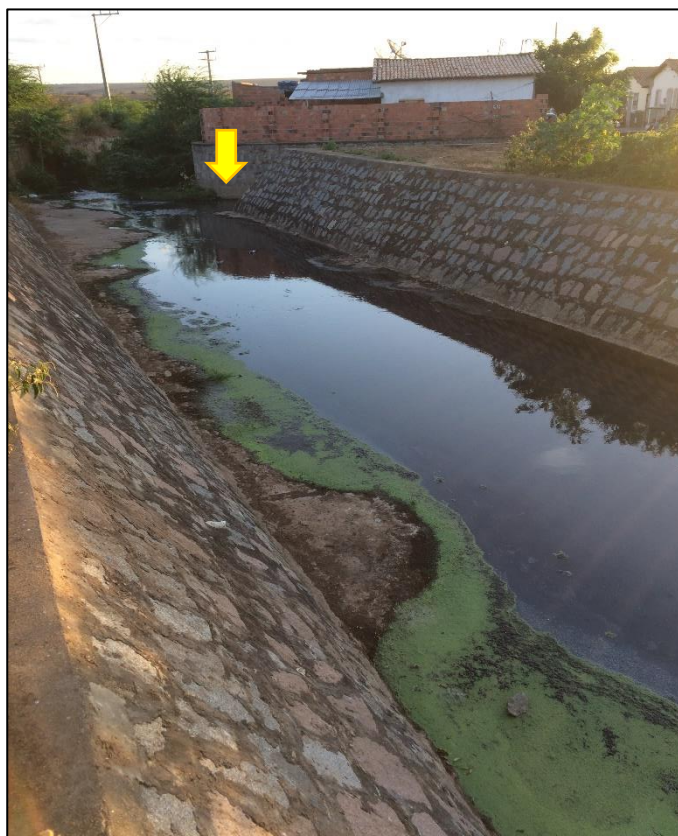
Figura 287 – Ponto de encontro dos dois canais de drenagem. Fonte: DRZ – Geotecnologia e Consultoria, 2017.
