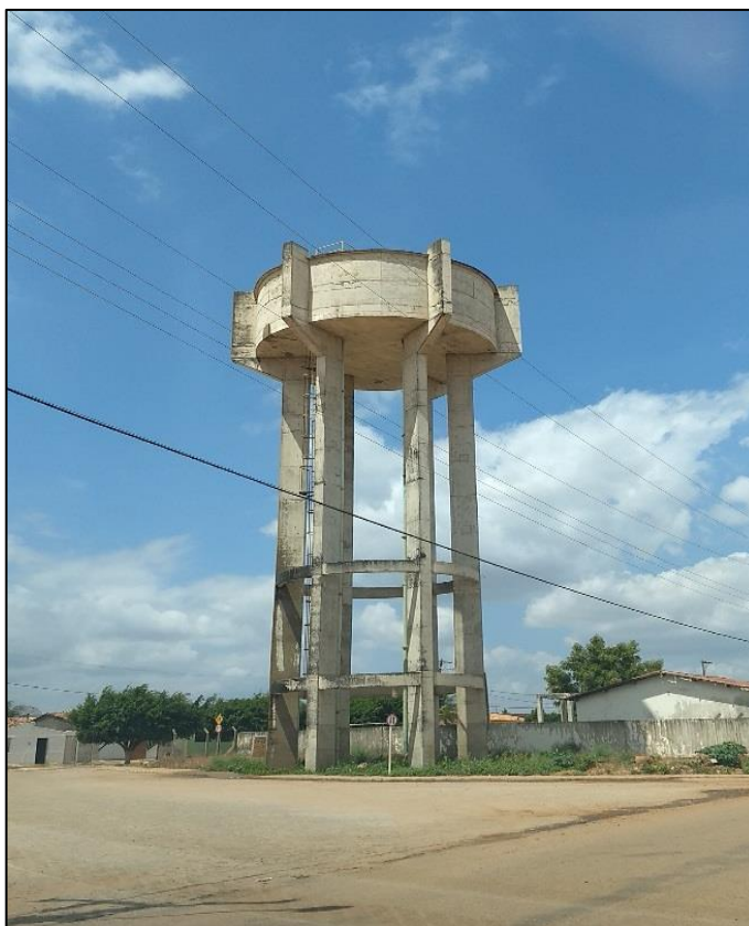
Figura 96 – Reservatório elevado (REL), 300 m 3 . Fonte: DRZ – Geotecnologia e Consultoria, 2017.
