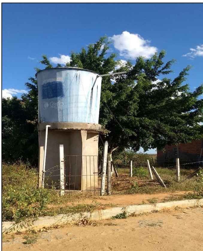
Figura 129 – Reservatório da comunidade Residência. Fonte: DRZ – Geotecnologia e Consultoria, 2017.
