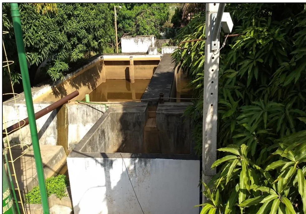
Figura 81 – Tanque de armazenamento da água da limpeza do filtro. Fonte: DRZ – Geotecnologia e Consultoria, 2017.
