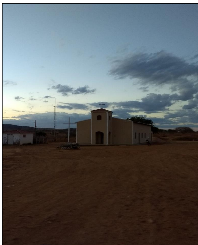
Figura 278 – Ausência de pavimentação na comunidade Monte Alegre (coordenadas UTM 590651.57 E 8903997.14 S). Fonte: DRZ – Geotecnologia e Consultoria, 2017.
