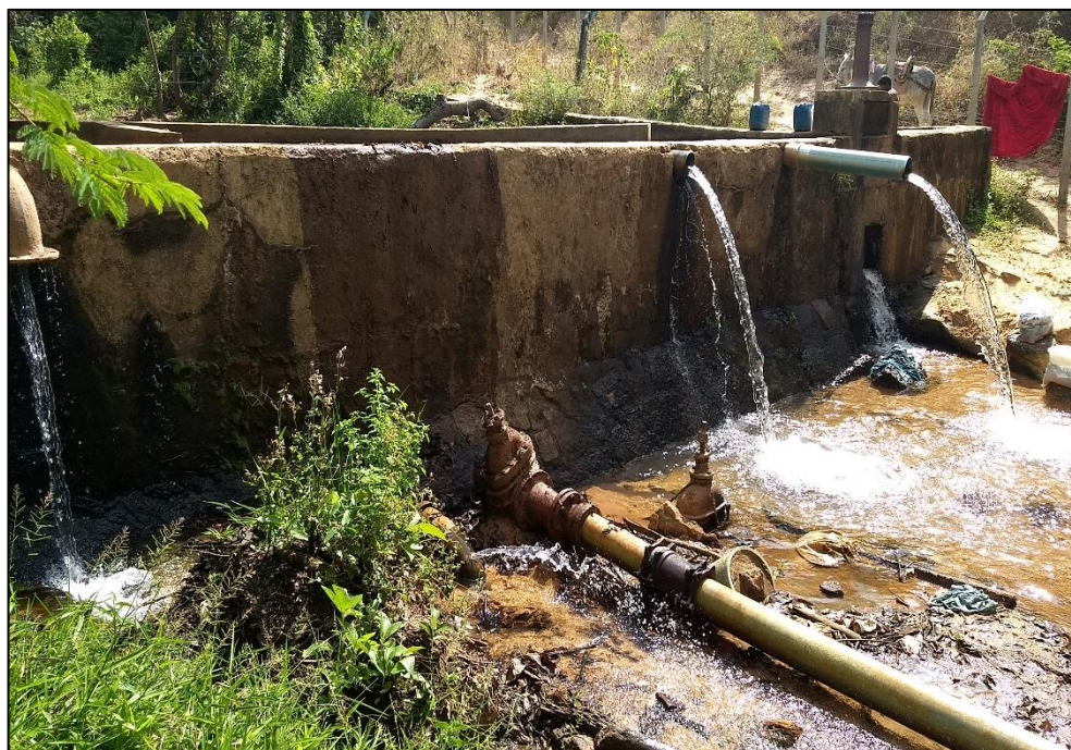
Figura 42 – Barragem da captação superficial no Rio Vermelho. Fonte: DRZ – Geotecnologia e Consultoria, 2017.
