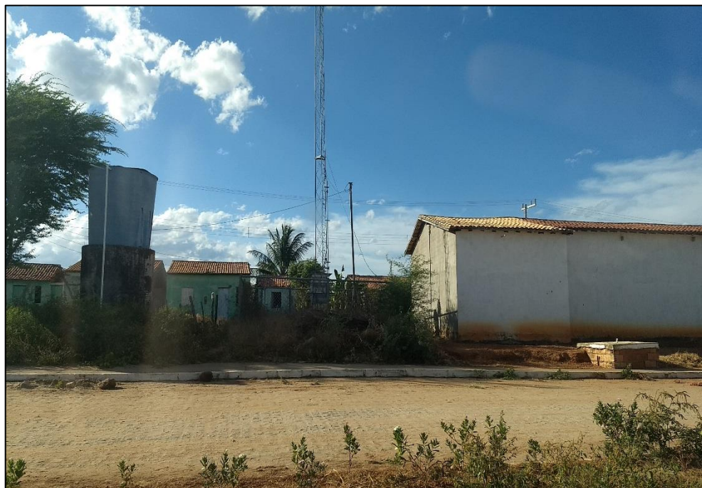
Figura 272 – Pavimentação na comunidade Cordão (coordenadas UTM 578637.99 E 8875242.98 S). Fonte: DRZ – Geotecnologia e Consultoria, 2017.
