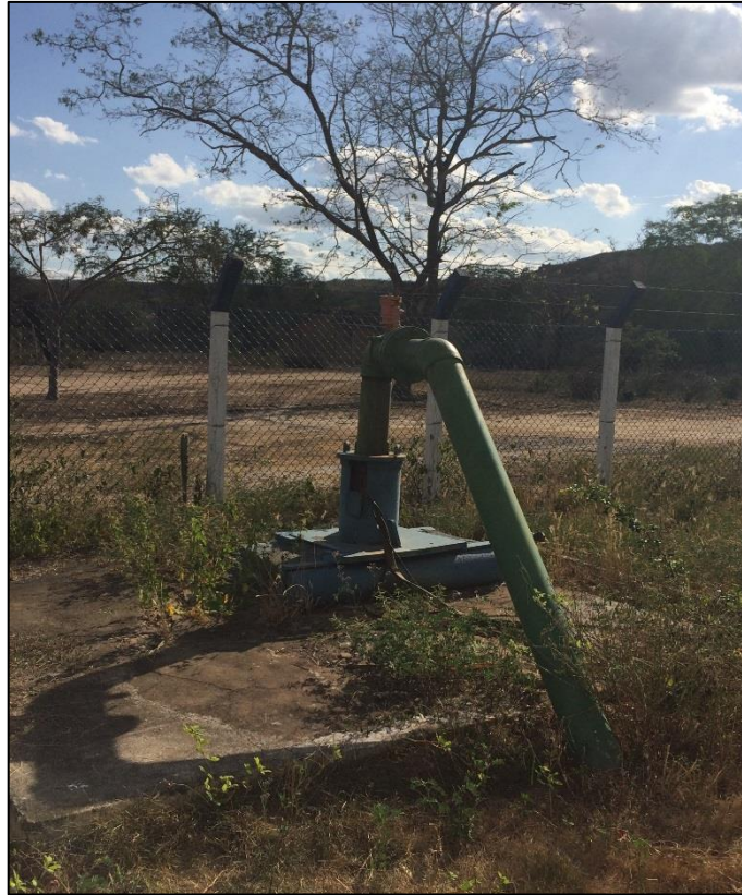
Figura 49 – Poço Tranqueira 01. Fonte: DRZ – Geotecnologia e Consultoria, 2017.
