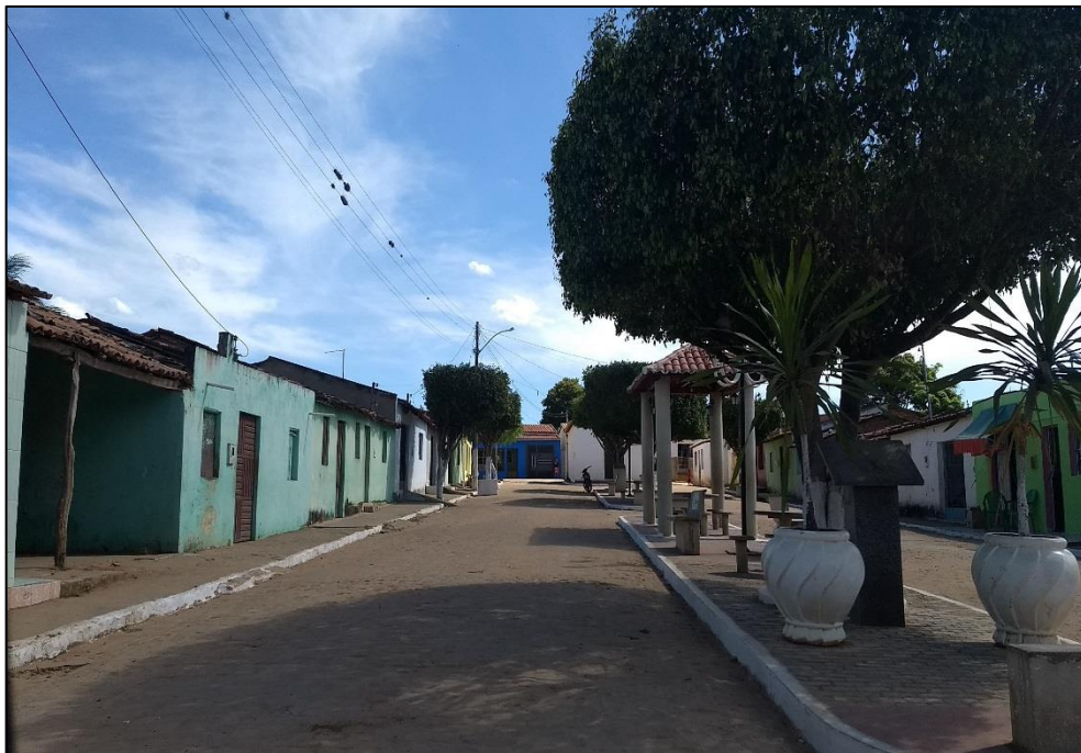
Figura 275 – Pavimentação na comunidade Viração (coordenadas UTM 558193.66 E 8865302.81 S).
