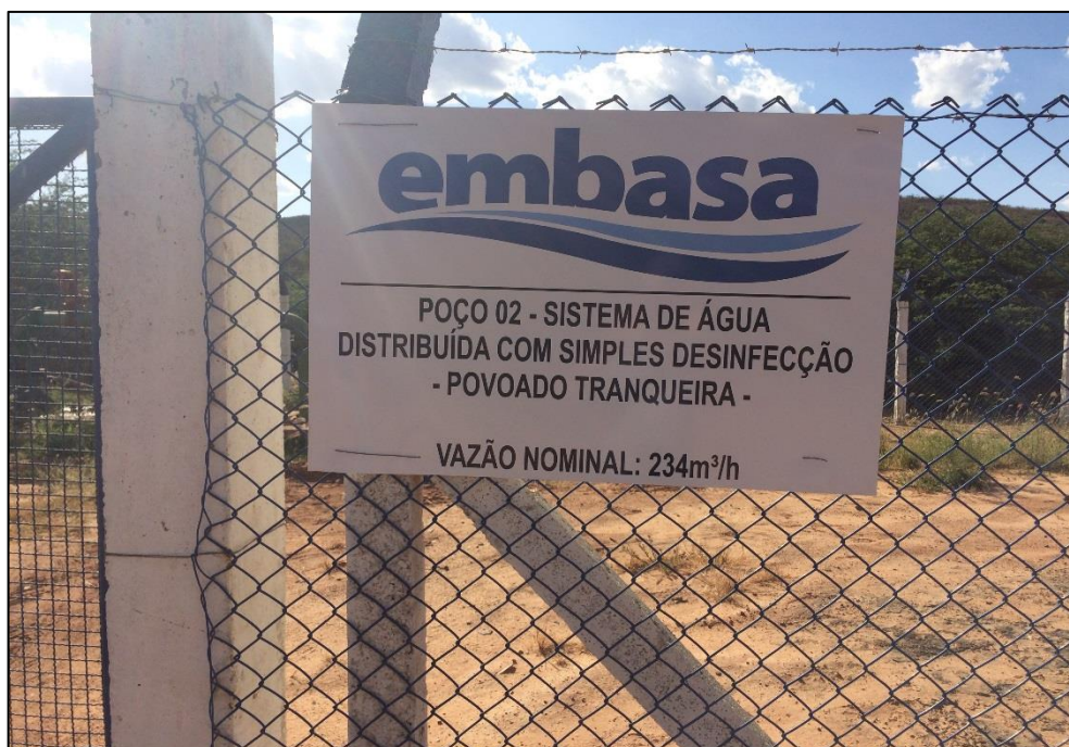
Figura 52 – Placa informativa da vazão de captação do Poço 02. Fonte: DRZ – Geotecnologia e Consultoria, 2017.
