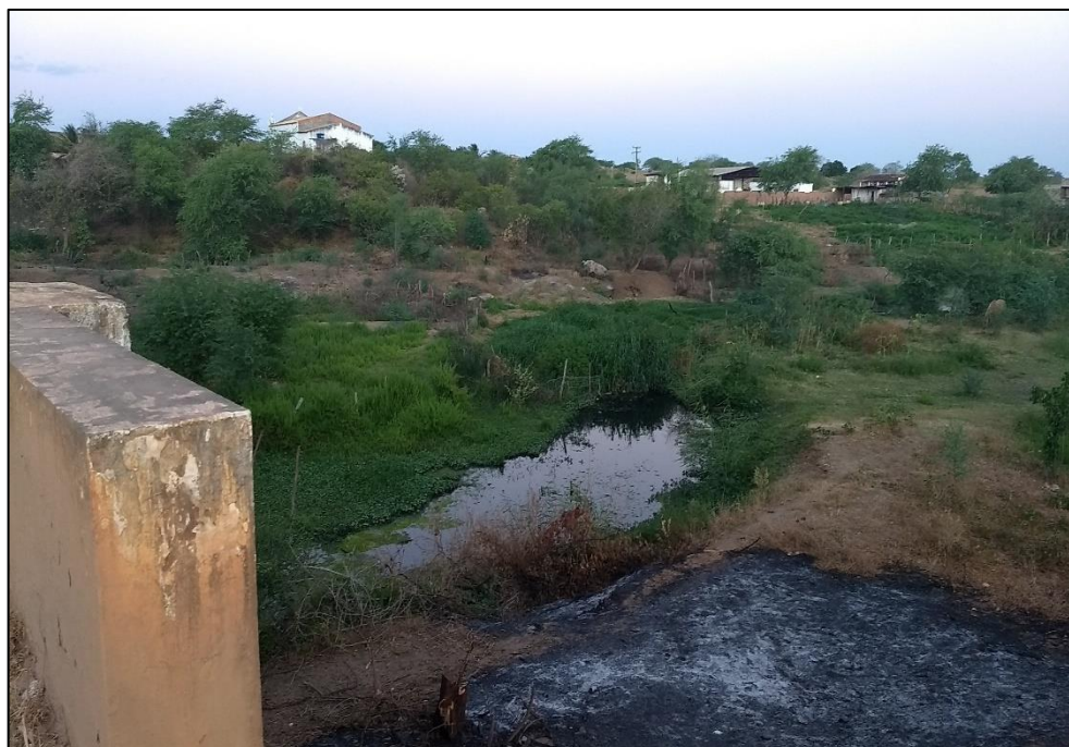
Figura 294 – Rio Vaza-Barris. Fonte: DRZ – Geotecnologia e Consultoria, 2017.
