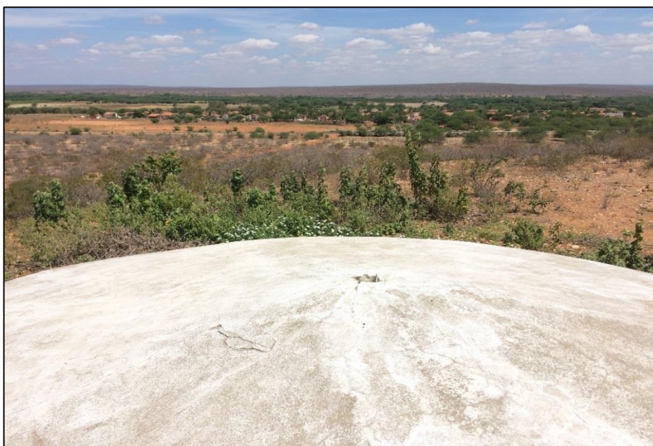
Figura 104 – Vista do distrito do alto do reservatório. Fonte: DRZ – Geotecnologia e Consultoria, 2017.
