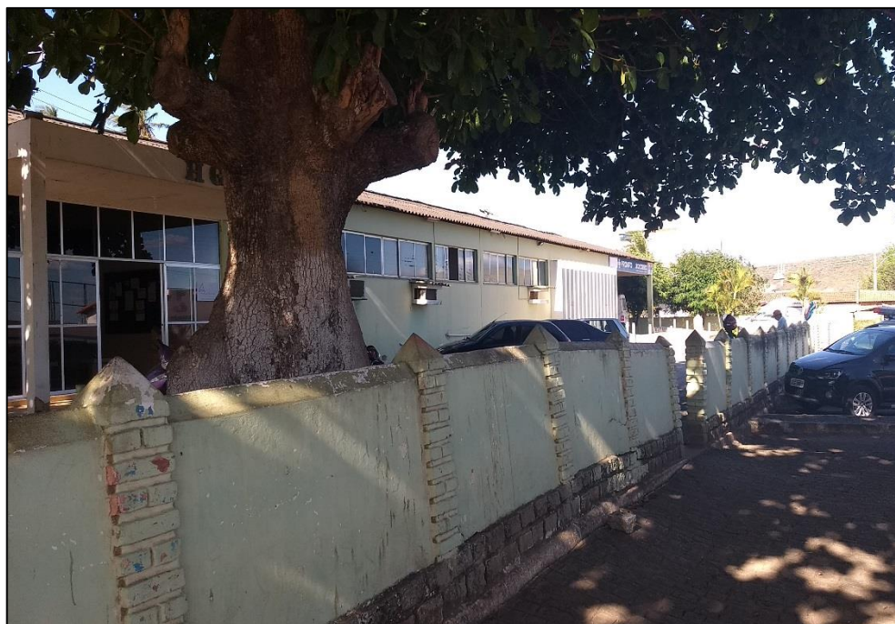
Figura 250 – Hospital Municipal de Jeremoabo. Fonte: DRZ – Geotecnologia e Consultoria, 2017.
