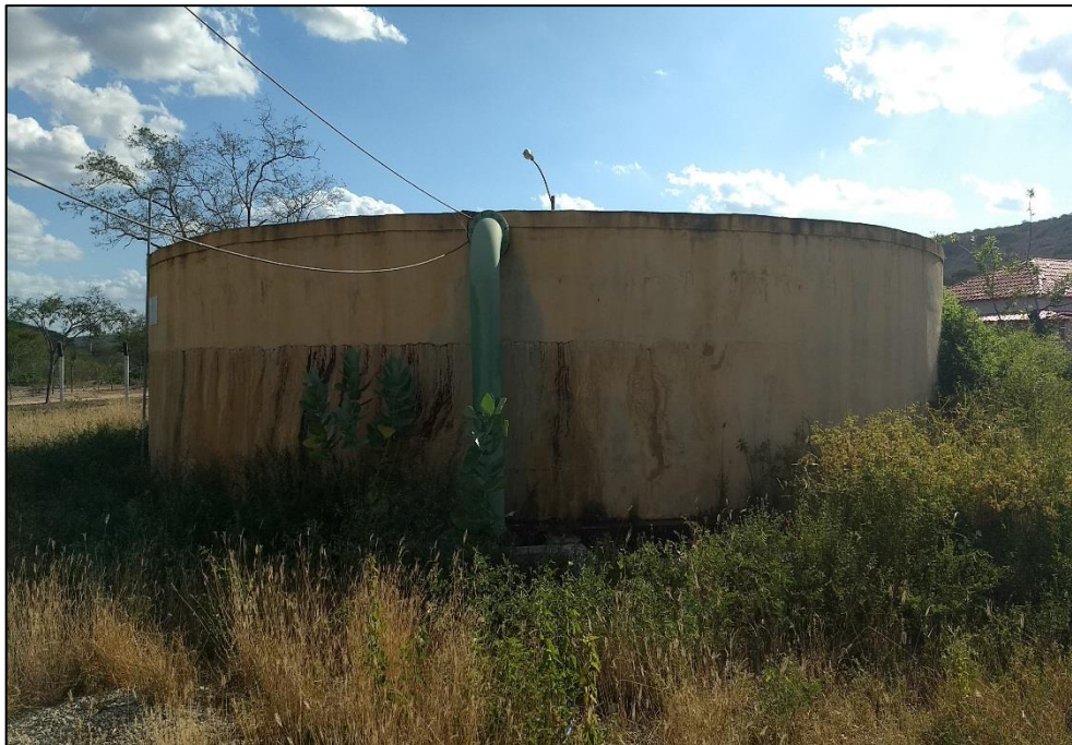
Figura 71 – Caixa de reunião (RAP) de 300 m 3 . Fonte: DRZ – Geotecnologia e Consultoria, 2017.
