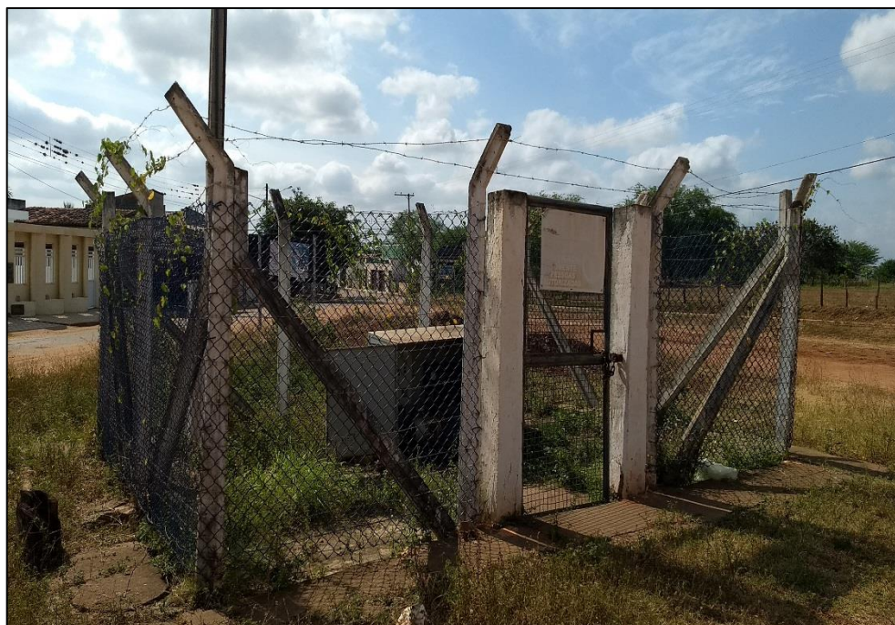
Figura 67 – Cercamento da área do booster . Fonte: DRZ – Geotecnologia e Consultoria, 2017.
