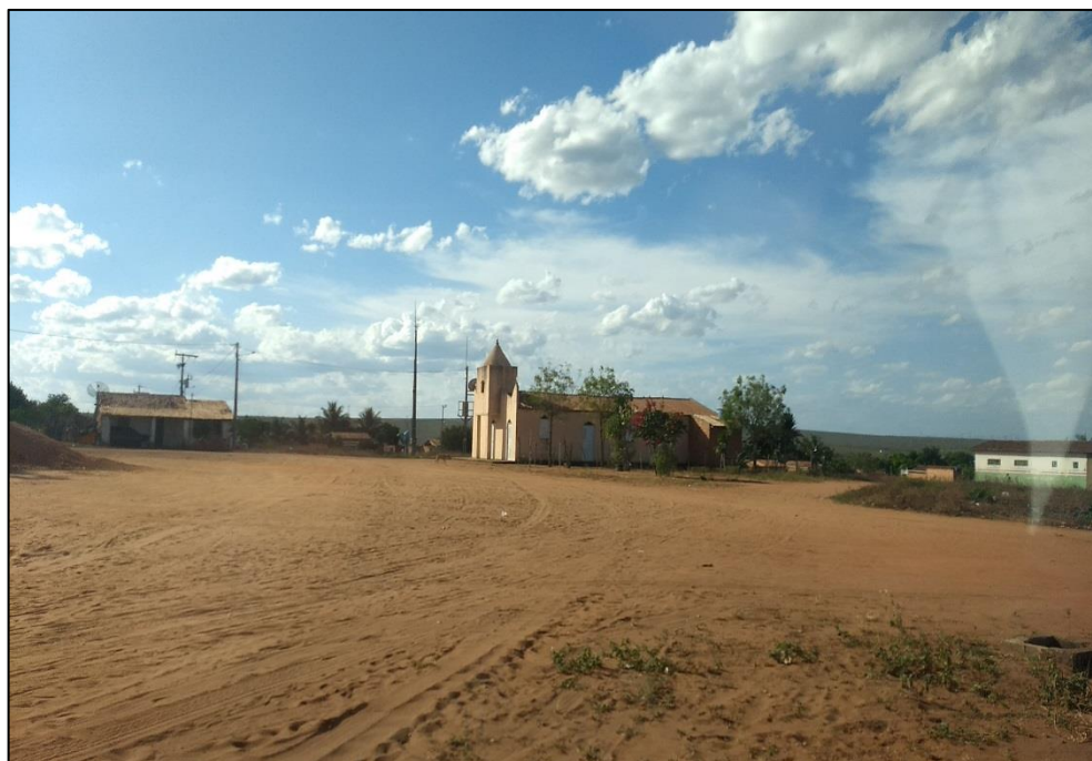
Figura 277 – Ausência de pavimentação na comunidade Caritá (coordenadas UTM 578157.15 E 8869973.37 S). Fonte: DRZ – Geotecnologia e Consultoria, 2017.
