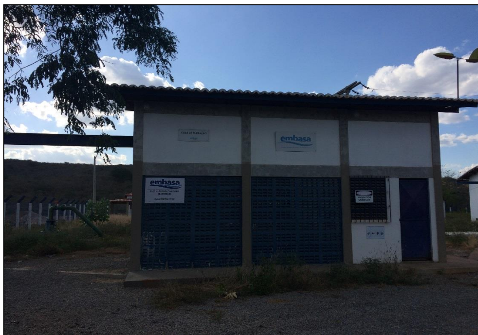
Figura 70 – Casa de cloração existente na área do Poço 01.
