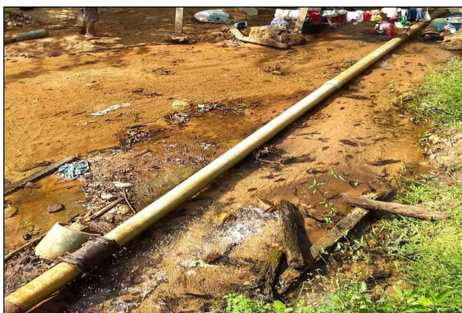
Figura 58 – Adutora de água bruta da captação superficial. Fonte: DRZ – Geotecnologia e Consultoria, 2017.
