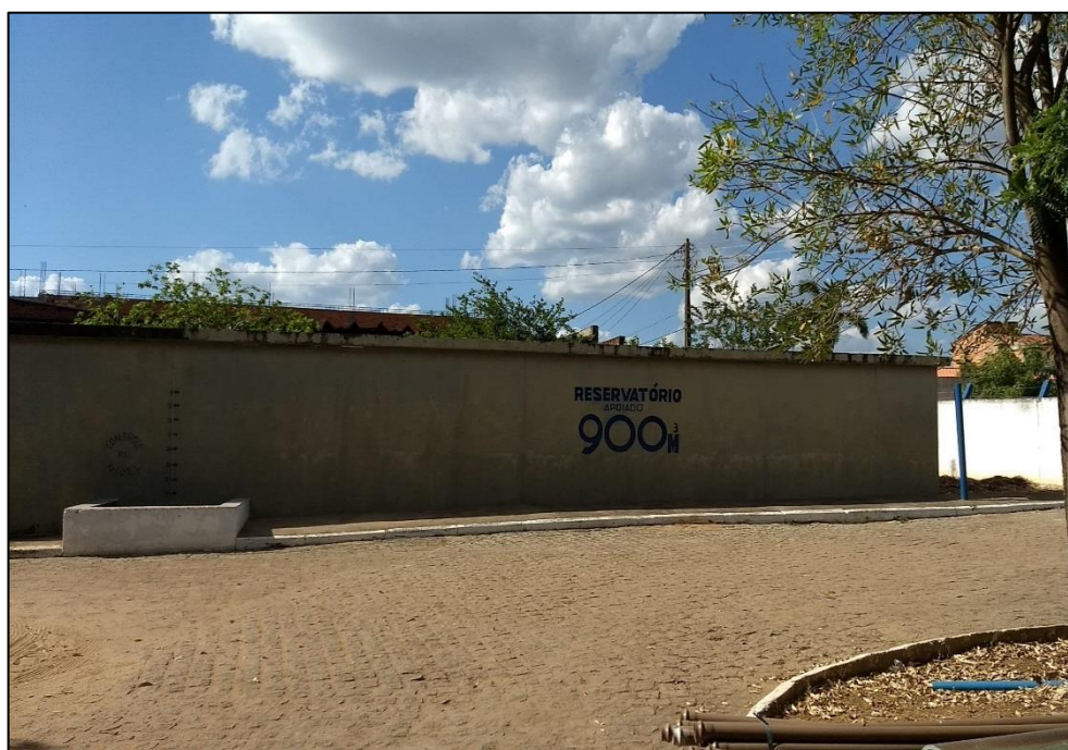
Figura 82 – Reservatório Apoiado (RAP) de 900 m 3 . Fonte: DRZ – Geotecnologia e Consultoria, 2017.
