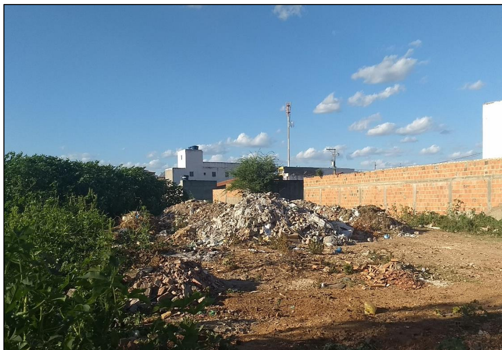
Figura 246 – Disposição de RCC em terreno baldio (coordenadas UTM 571189.74 E 8886287.41 S).
