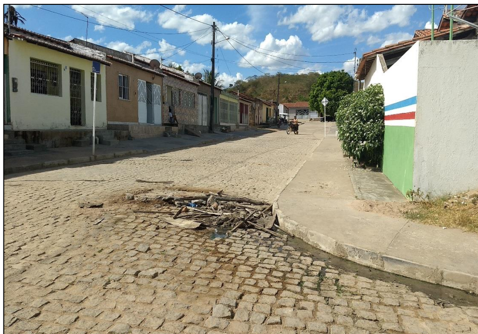
Figura 164 – Lançamento de esgoto na via pública da comunidade Lagoa do Inácio.
