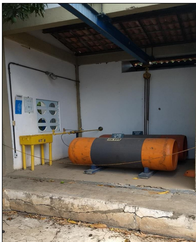
Figura 85 – Local de armazenamento dos cilindros de cloro gás.
