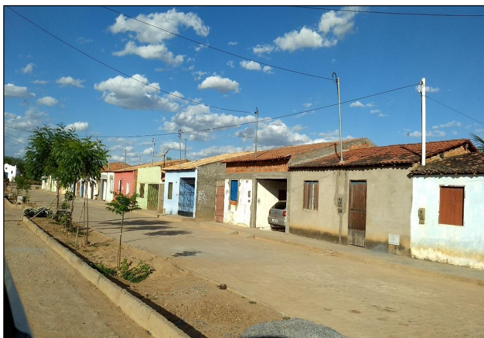
Figura 274 – Pavimentação na comunidade Sítio Velho (coordenadas UTM 586239.76 E 8872311.68 S).
