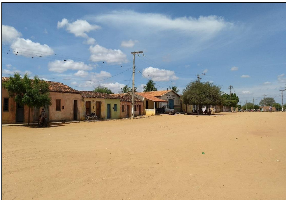
Figura 266 – Ausência de pavimentação no distrito Canché. Fonte: DRZ – Geotecnologia e Consultoria, 2017.
