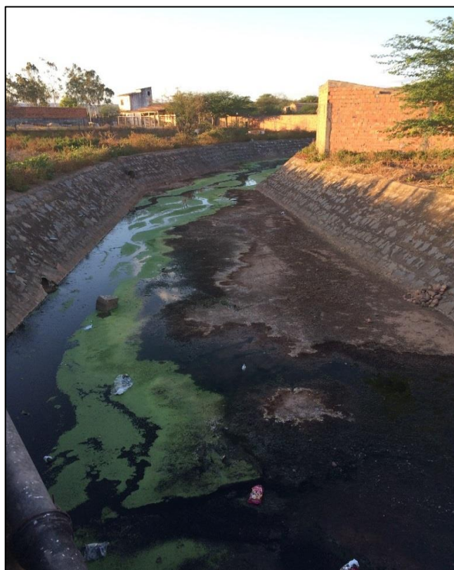
Figura 286 – Canal de drenagem pluvial no município de Jeremoabo (coordenadas UTM 572472.13 E 8885433.33 S). Fonte: DRZ – Geotecnologia e Consultoria, 2017.
