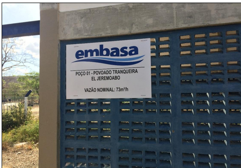
Figura 48 – Placa informativa da vazão de captação do Poço 01.
