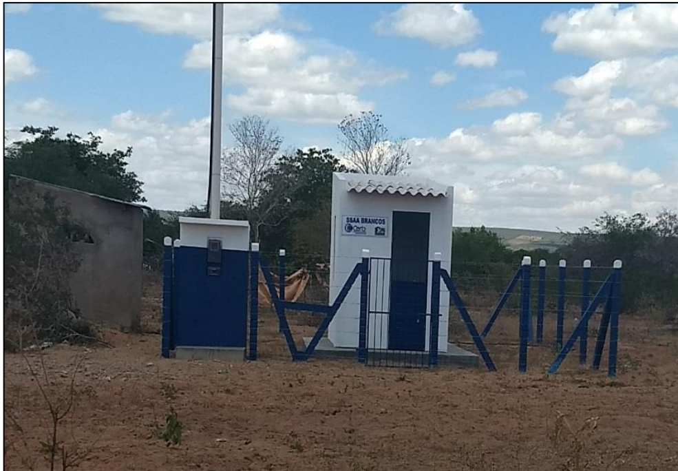
Figura 118 – Área do novo poço da comunidade Brancos. Fonte: DRZ – Geotecnologia e Consultoria, 2017.
