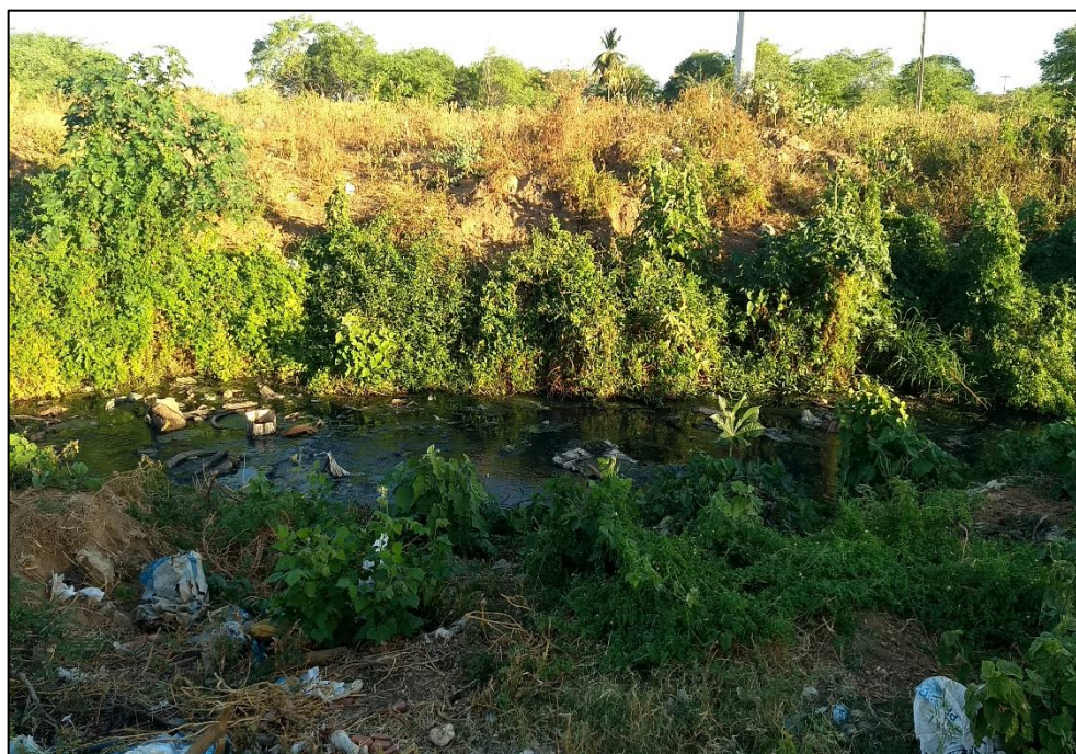
Figura 290 – Acúmulo de esgoto sanitário e resíduos após o encontro dos canais de drenagem (coordenadas UTM 572419.17 E 8885122.58 S). Fonte: DRZ – Geotecnologia e Consultoria, 2017.
