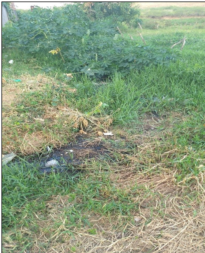
Figura 147 – Lançamento de esgoto in natura em área aberta (coordenadas UTM 571521.35 E 8886765.92 S).
