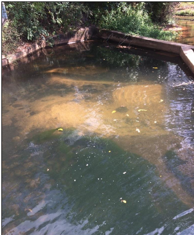
Figura 43 – Problemas de assoreamento na captação superficial. Fonte: DRZ – Geotecnologia e Consultoria, 2017.
