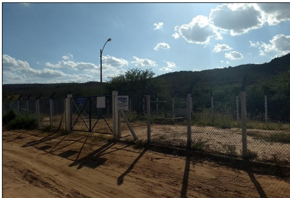
Figura 50 – Área da captação subterrânea do Poço 02. Fonte: DRZ – Geotecnologia e Consultoria, 2017.
