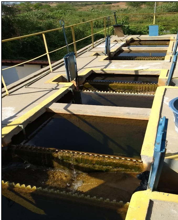
Figura 80 – Filtração da água captada superficialmente. Fonte: DRZ – Geotecnologia e Consultoria, 2017.
