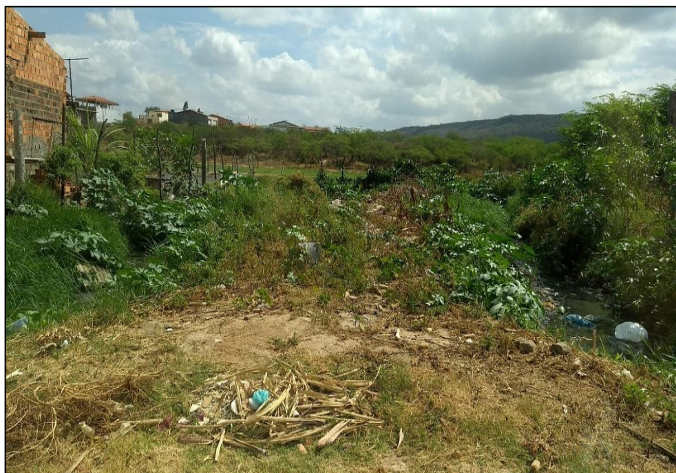
Figura 148 – Lançamento de esgoto em área de várzea, na Avenida do Contorno (coordenadas UTM 571470.89 E 8886842.95 S).
