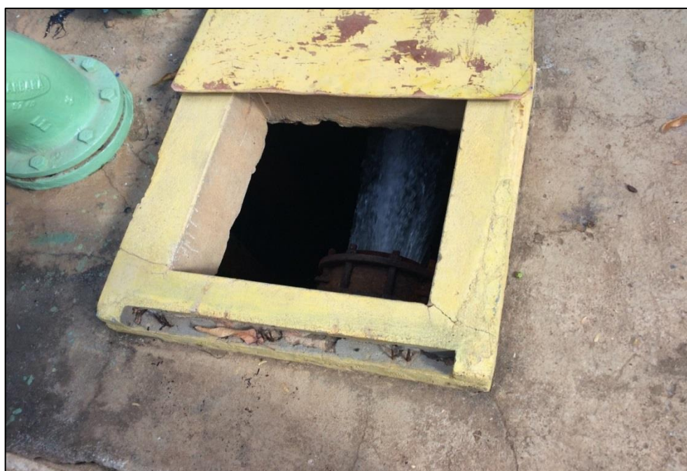
Figura 84 – Tanque de sucção, onde são aplicados os produtos químicos. Fonte: DRZ – Geotecnologia e Consultoria, 2017.
