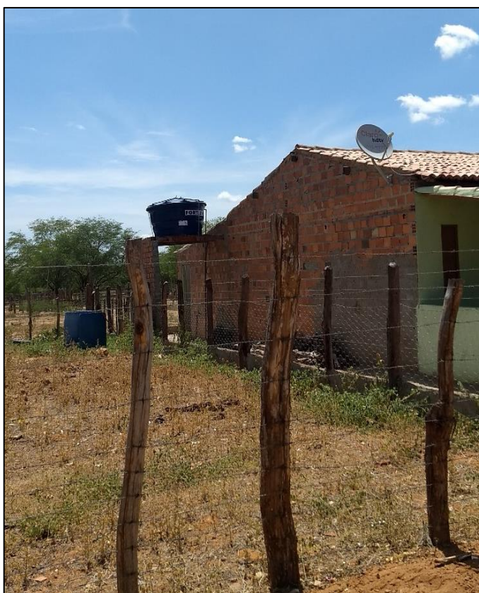
Figura 105 – Reservação individual no distrito Canché. Fonte: DRZ – Geotecnologia e Consultoria, 2017.
