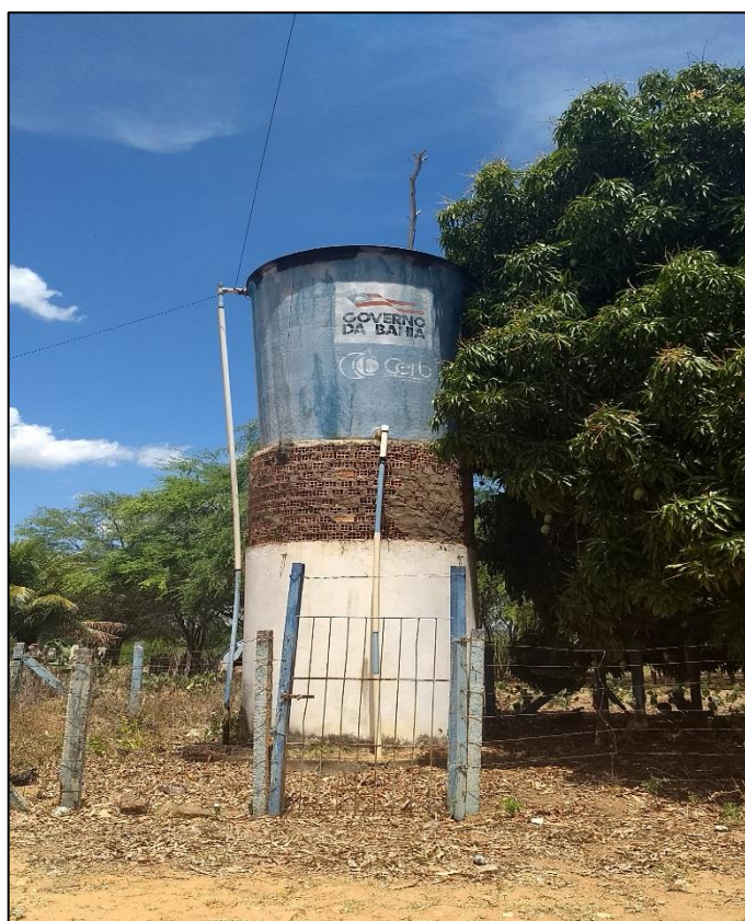
Figura 117 – Reservatório da comunidade Brancos. Fonte: DRZ – Geotecnologia e Consultoria, 2017.
