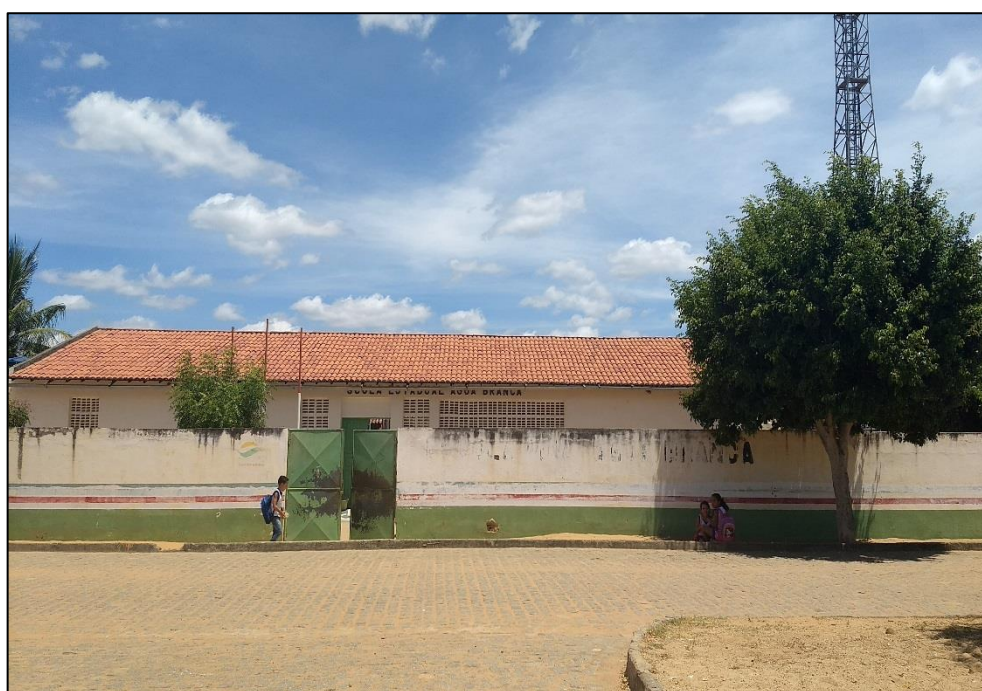
Figura 268 – Pavimentação na comunidade Água Branca (coordenadas UTM 543527.27 E 8893942.14 S).
