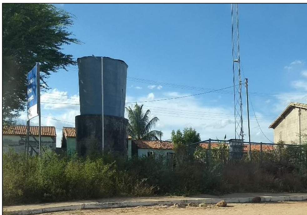
Figura 125 – Reservatório da comunidade Cordão. Fonte: DRZ – Geotecnologia e Consultoria, 2017.
