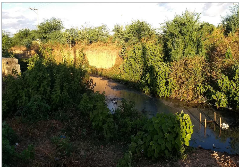
Figura 288 – Final da obra dos canais de drenagem.
