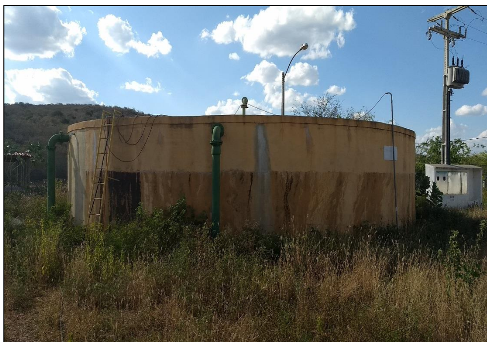
Figura 93 – Reservatório apoiado (RAP) - caixa de reunião, 300 m 3 . Fonte: DRZ – Geotecnologia e Consultoria, 2017.
