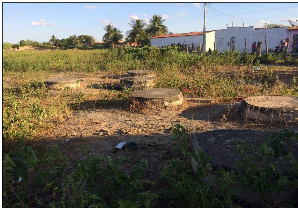
Figura 142 – Antigo sistema de tratamento de esgoto, por fossas. Fonte: DRZ – Geotecnologia e Consultoria, 2017.
