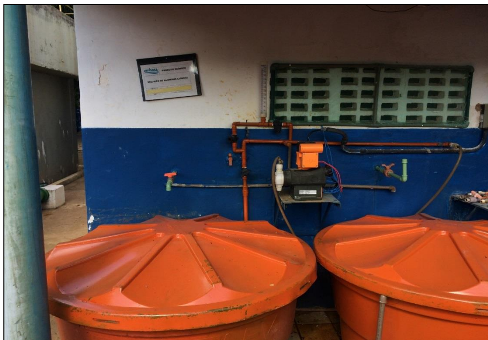
Figura 90 – Aplicação de sulfato de alumínio para tratamento da água. Fonte: DRZ – Geotecnologia e Consultoria, 2017.
