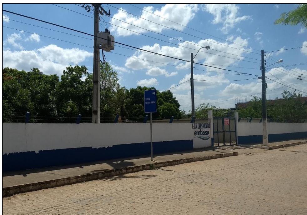
Figura 76 – Estação de tratamento de água de Jeremoabo. Fonte: DRZ Geotecnologia e Consultoria, 2017.
