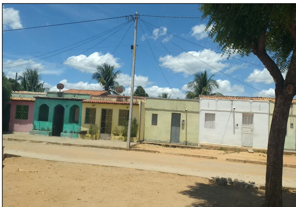
Figura 270 – Pavimentação na comunidade Brejo Grande (coordenadas UTM 551196.74 E 8891676.52 S). Fonte: DRZ – Geotecnologia e Consultoria, 2017.
