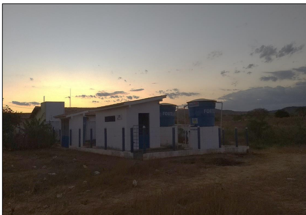
Figura 128 – Área do poço da comunidade Monte Alegre. Fonte: DRZ – Geotecnologia e Consultoria, 2017.
