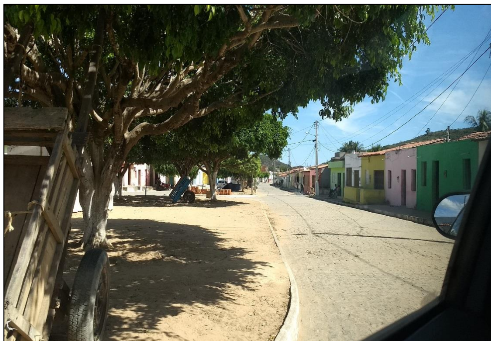
Figura 273 – Pavimentação na comunidade Cirica (coordenadas UTM 556254.45 E 8869715.85 S).
