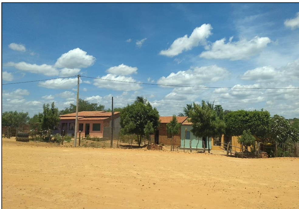
Figura 276 – Ausência de pavimentação na comunidade Brejo Grande (coordenadas UTM 547865.78 E 8891197.67 S).
