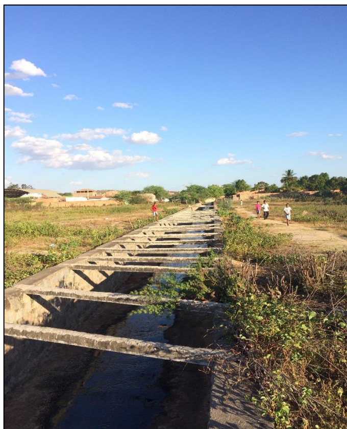
Figura 283 – Canal do Rio Vermelho (coordenadas UTM 571867.05 E 8885560.07 S).
