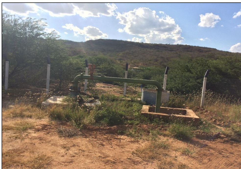
Figura 53 – Poço Tranqueira 02. Fonte: DRZ – Geotecnologia e Consultoria, 2017.
