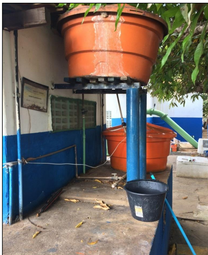
Figura 89 – Aplicação de flúor para tratamento da água. Fonte: DRZ – Geotecnologia e Consultoria, 2017.
