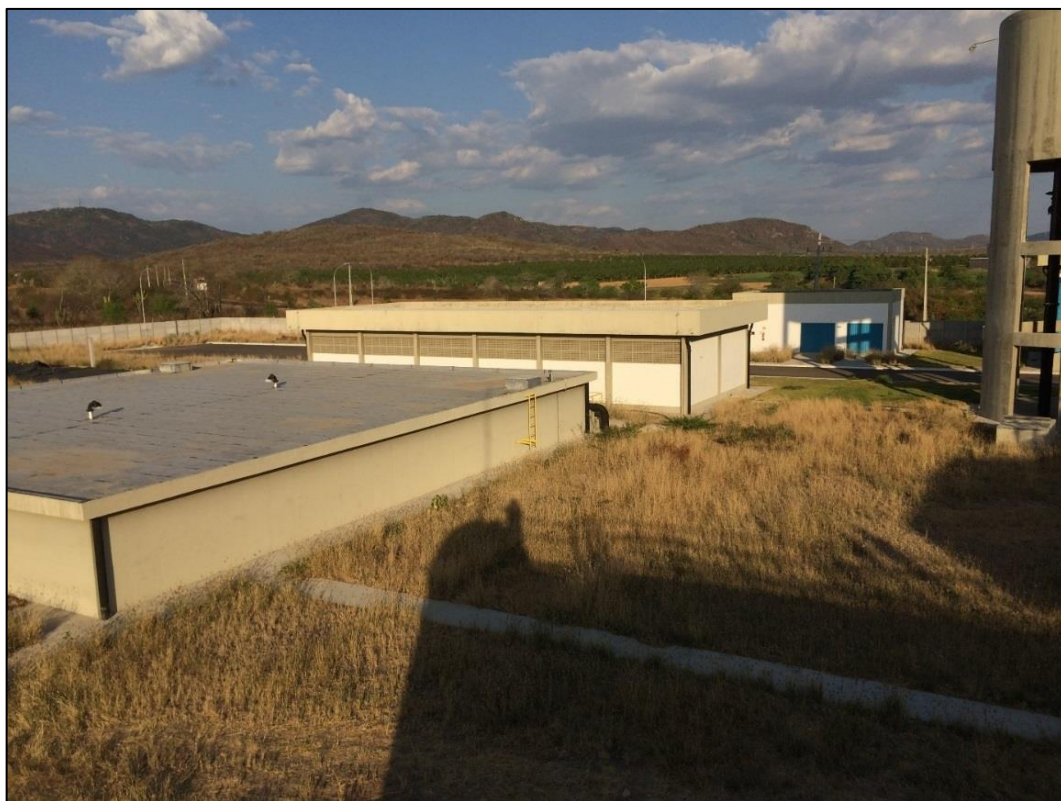
Figura 61 – Reservatório apoiado ETA Alto Sertão. Fonte: DRZ – Geotecnologia e Consultoria, 2017.
