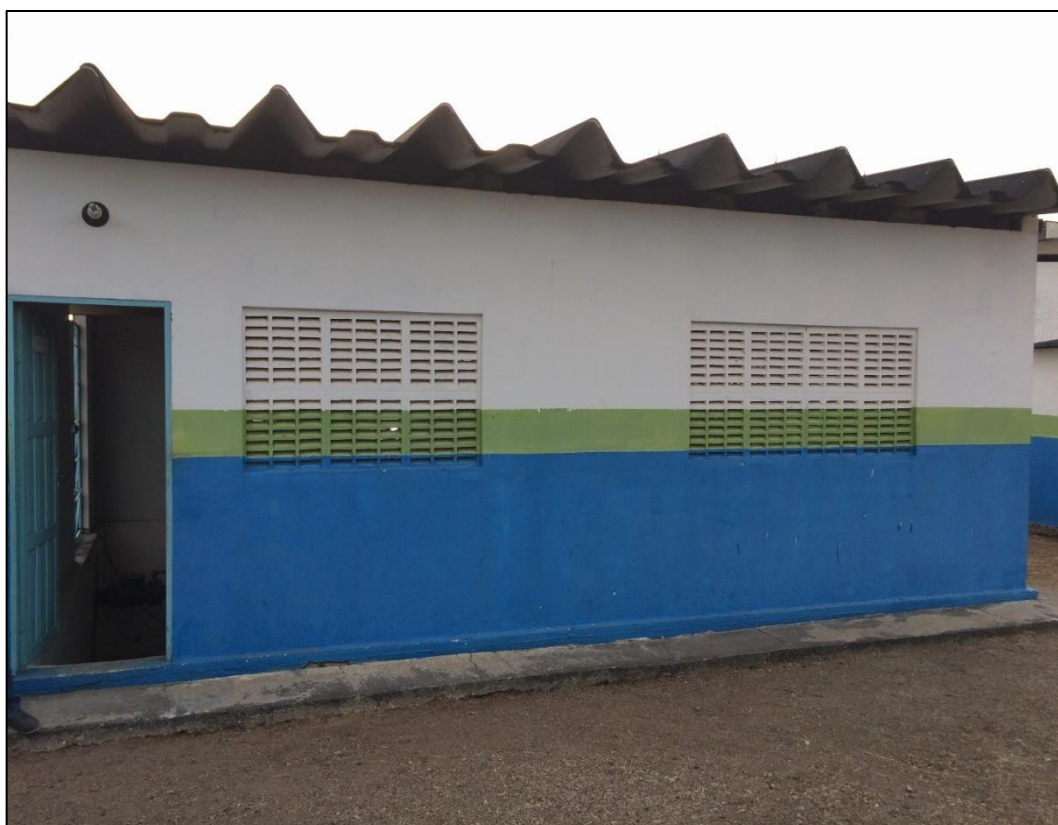
Figura 57 – EEAT da ETA Delmiro - 2. Fonte: DRZ – Geotecnologia e Consultoria, 2017.
