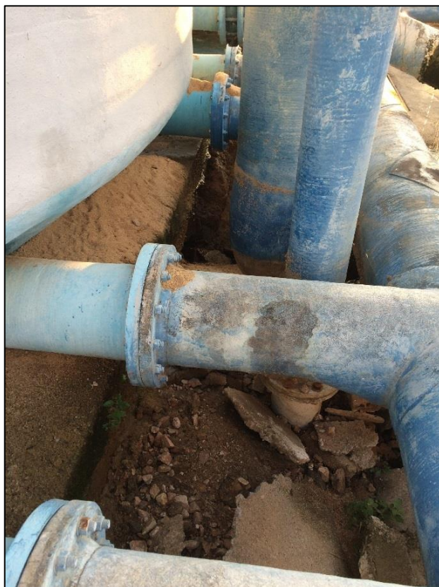
Figura 45 – Solapamento do piso onde estão instalados os filtros (2). Fonte: DRZ – Geotecnologia e Consultoria, 2017.
