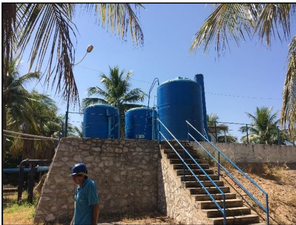
Figura 77 – Vista Frontal - ETA Barragem Leste Fonte: DRZ – Geotecnologia e Consultoria, 2017
