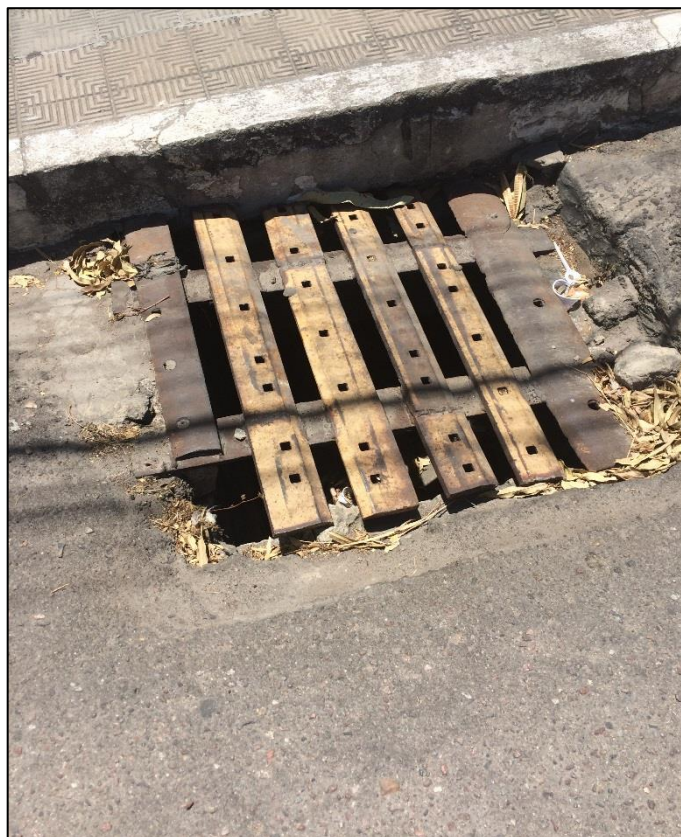
Figura 180 – Boca de lobo com grade. Fonte: DRZ – Geotecnologia e Consultoria, 2017.
