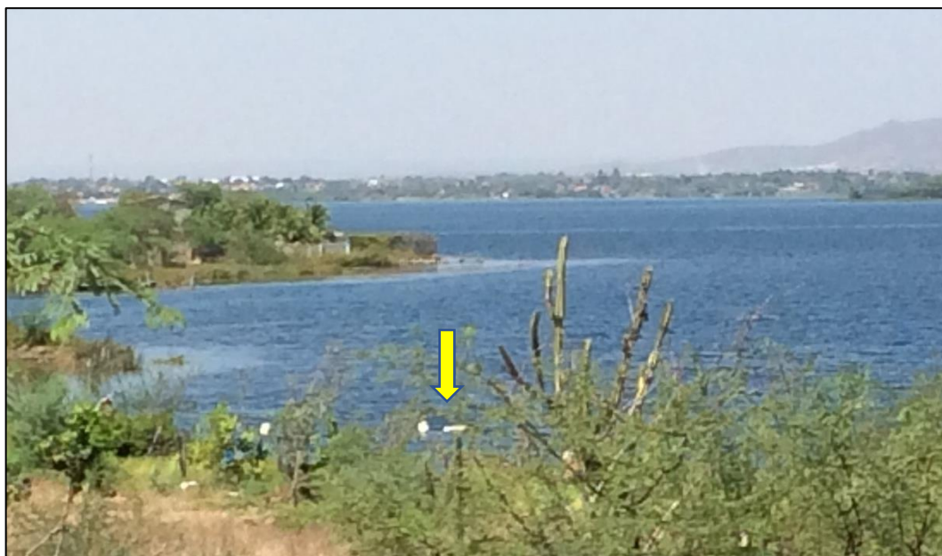
Figura 120 – Captação superficial do povoado São José.
