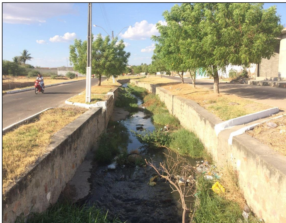
Figura 184 – Canal de drenagem pluvial no município de Delmiro Gouveia. Fonte: DRZ – Geotecnologia e Consultoria, 2017.
