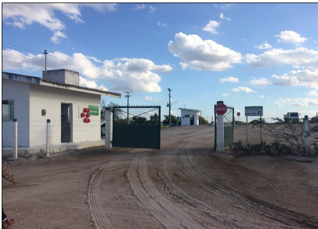
Figura 150 – Portaria do Aterro Sanitário de Olivença. Fonte: DRZ – Geotecnologia e Consultoria, 2017.
