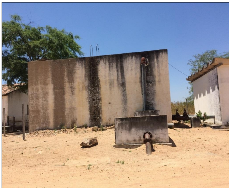
Figura 90 – Reservatório Apoiado Povoado Simimbú Fonte: DRZ – Geotecnologia e Consultoria, 2017.
