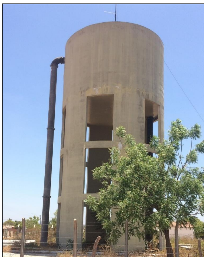
Figura 65 – Reservatório Elevado REL sistema Delmiro Fonte: DRZ – Geotecnologia e Consultoria, 2017.
