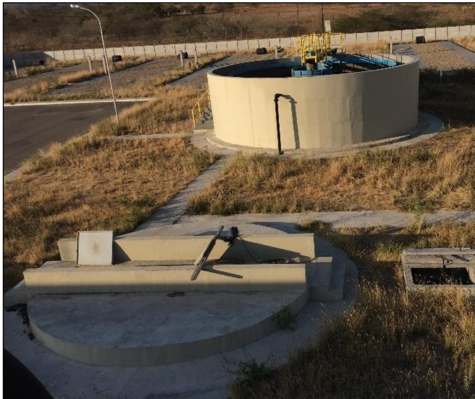
Figura 111 – Tanque de equalização. Fonte: DRZ – Geotecnologia e Consultoria, 2017.
