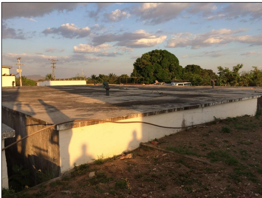
Figura 62 – Reservatório apoiado ETA Delmiro. Fonte: DRZ – Geotecnologia e Consultoria, 2017.
