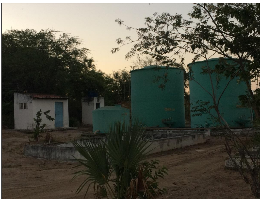
Figura 138 – ETE instalada não ativada. Fonte: DRZ – Geotecnologia e Consultoria, 2017.
