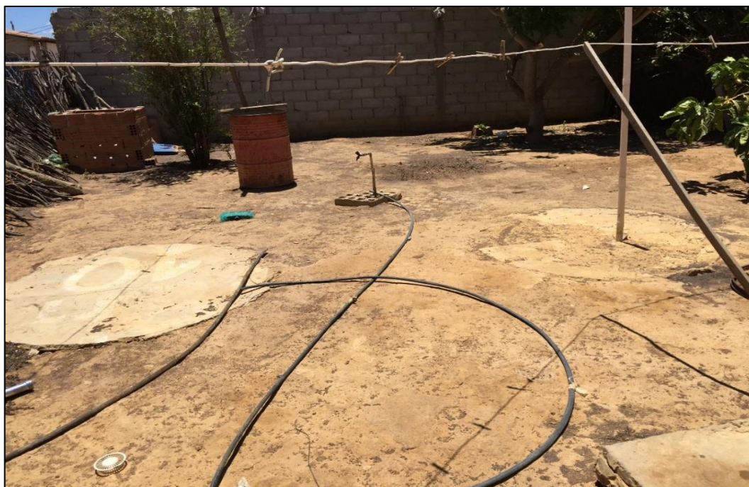
Figura 135 – Fossas sépticas instaladas em casas desprovidas de rede coletora.
