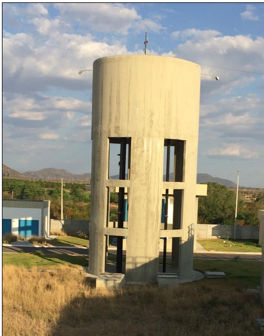
Figura 107 – Reservatório elevado para retrolavagem dos filtros Fonte: DRZ – Geotecnologia e Consultoria, 2017.
