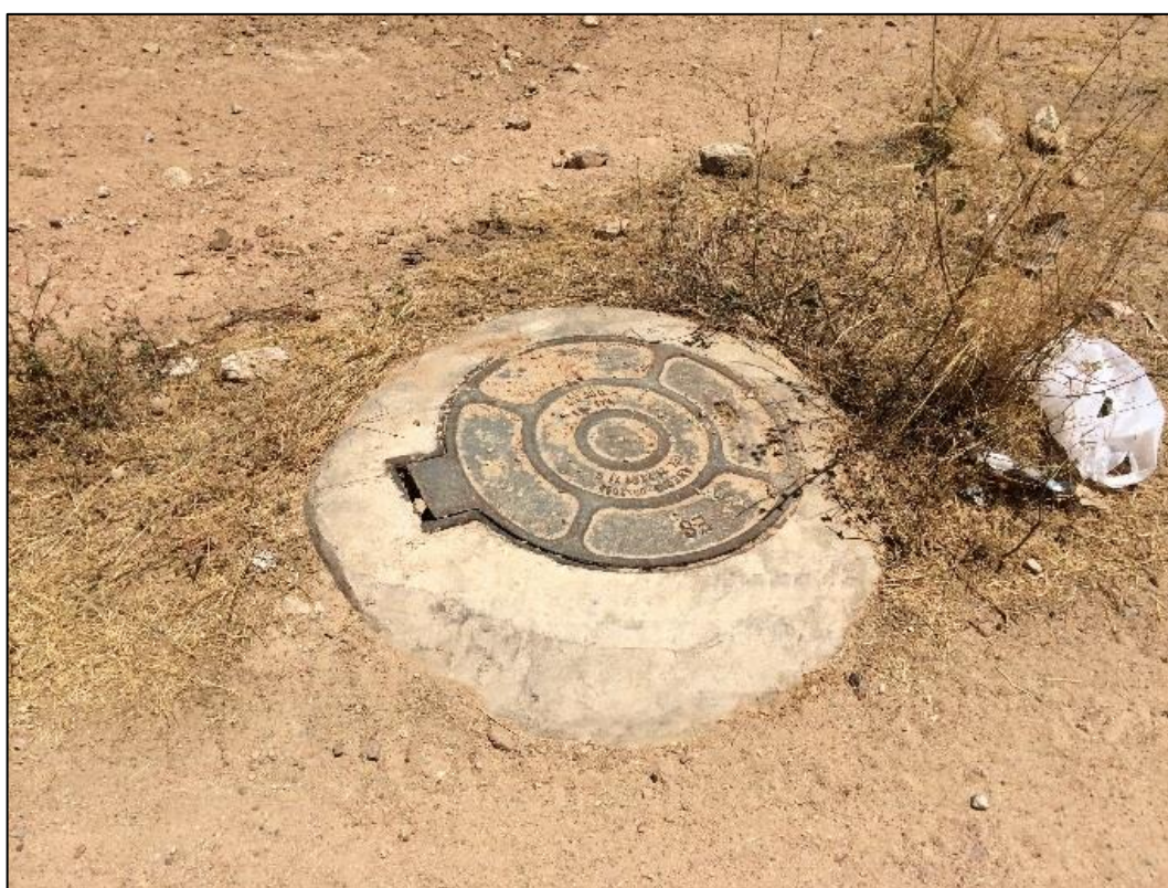
Figura 140 – Poço de Visita do SES no povoado de Siminbú.
