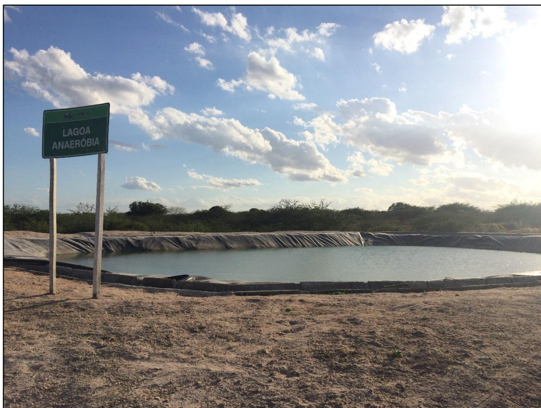
Figura 155 - Lagoa anaeróbica de tratamento de chorume do Aterro Sanitário de Olivença.
