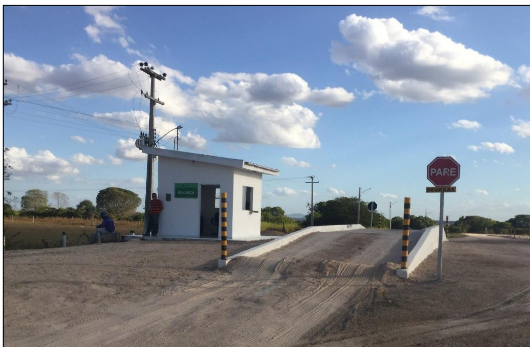
Figura 151 - Balança do Aterro Sanitário de Olivença. Fonte: DRZ – Geotecnologia e Consultoria, 2017.
