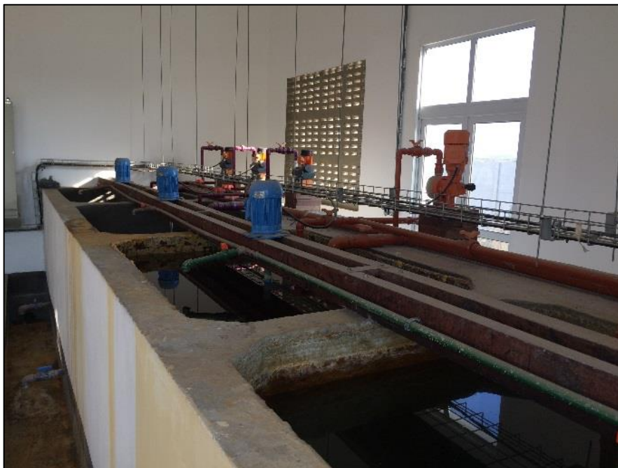
Figura 100 – Tanques para mistura rápida de produtos químicos. Fonte: DRZ – Geotecnologia e Consultoria, 2017.
