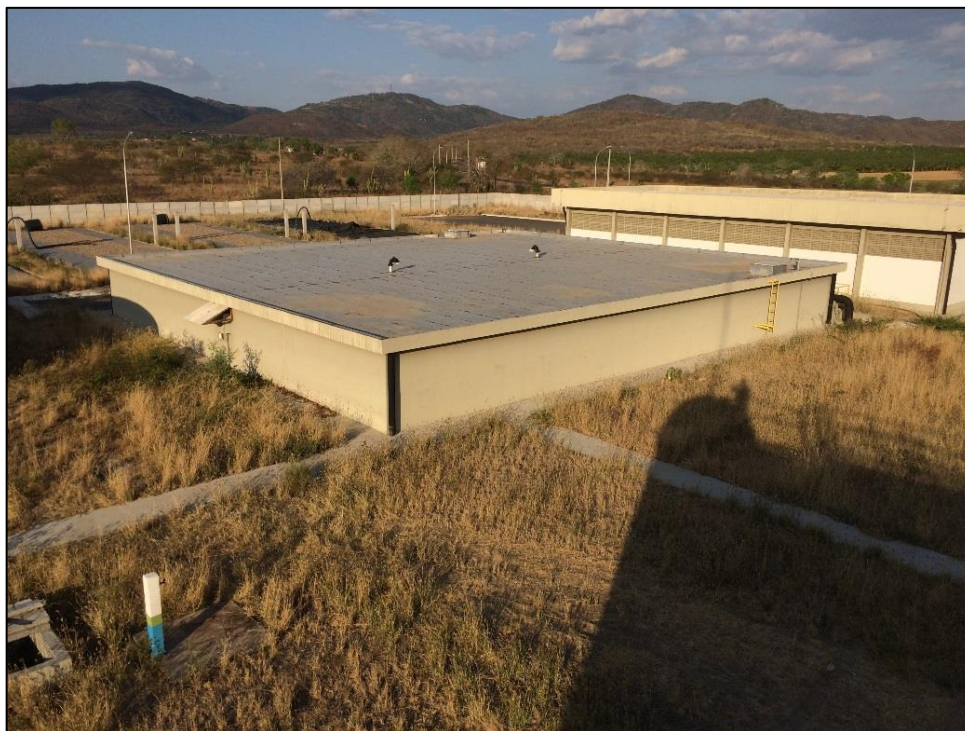
Figura 115 – RAP 200 m 3 ETA Alto Sertão. Fonte: DRZ – Geotecnologia e Consultoria, 2017.
