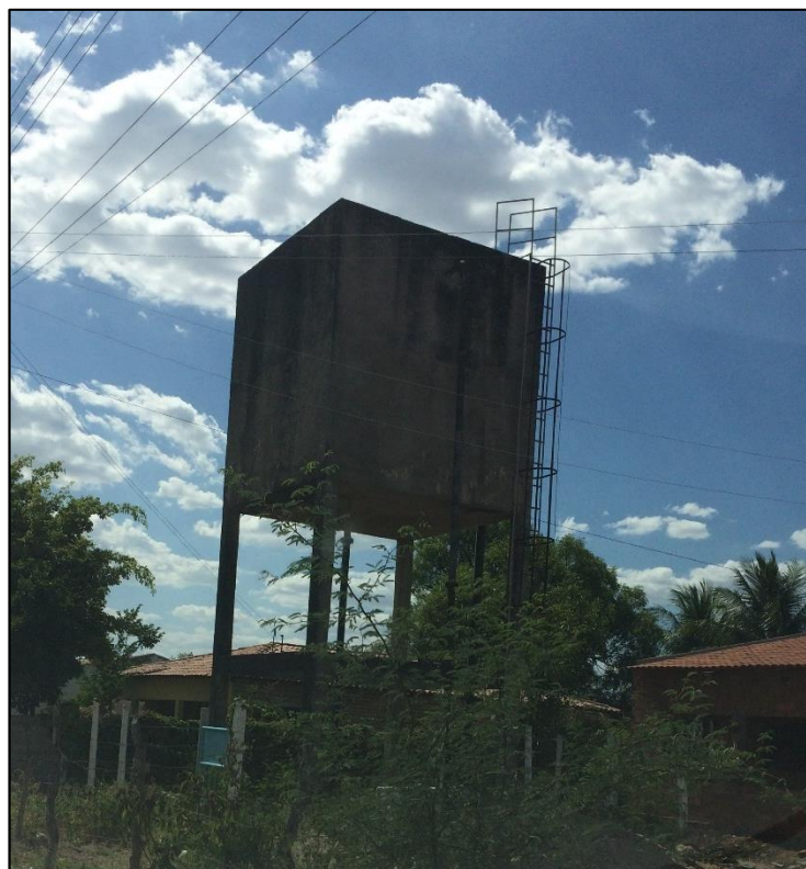
Figura 66- Reservatório Elevado Povoado de Rabeca (desativado). Fonte: DRZ – Geotecnologia e Consultoria, 2017.
