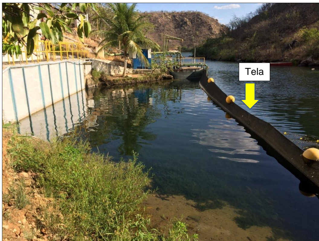
Figura 36 – Rede de proteção do poço de sucção Fonte: DRZ – Geotecnologia e Consultoria, 2017.
