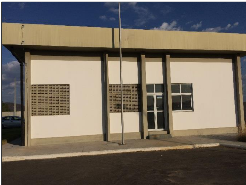
Figura 102 – Depósitos de produtos químicos utilizados no processo de tratamento.
