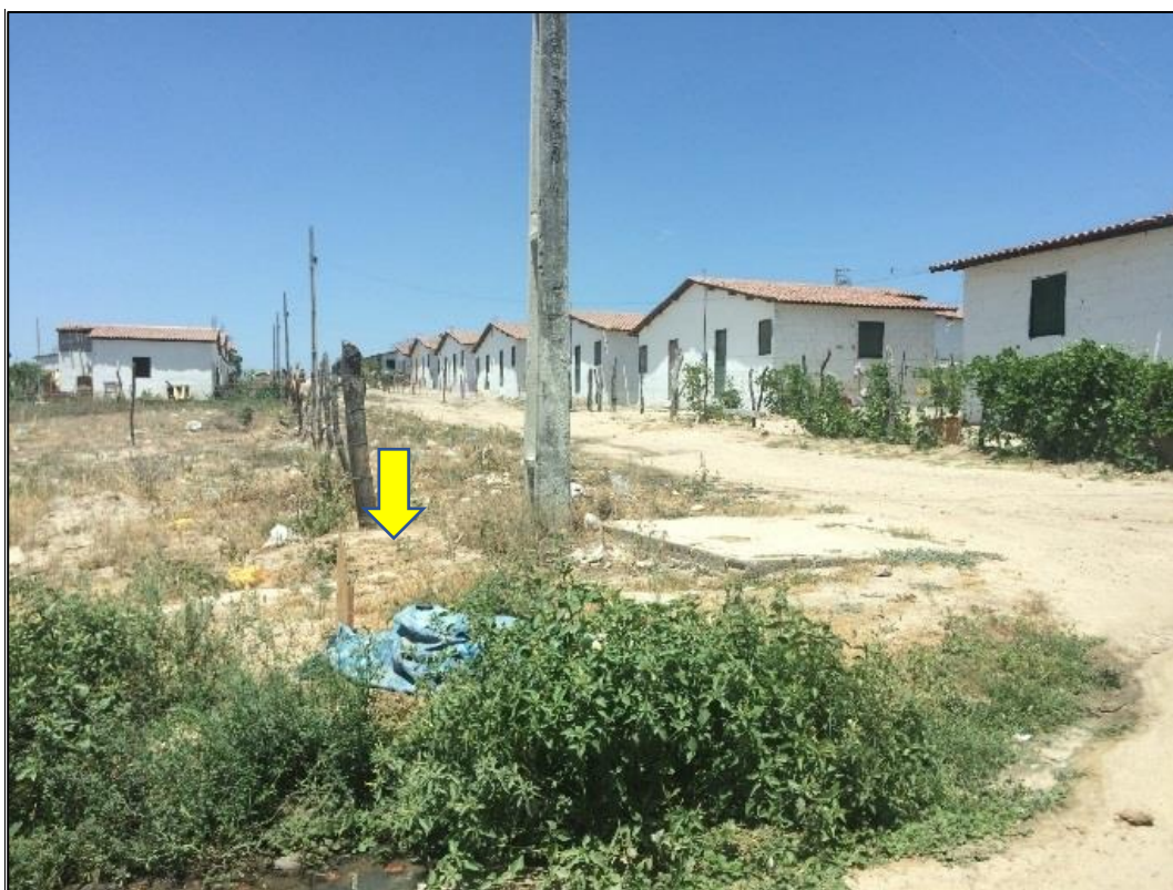
Figura 130 – Lançamento irregular de esgoto diretamente nas vias públicas do distrito Sede.
