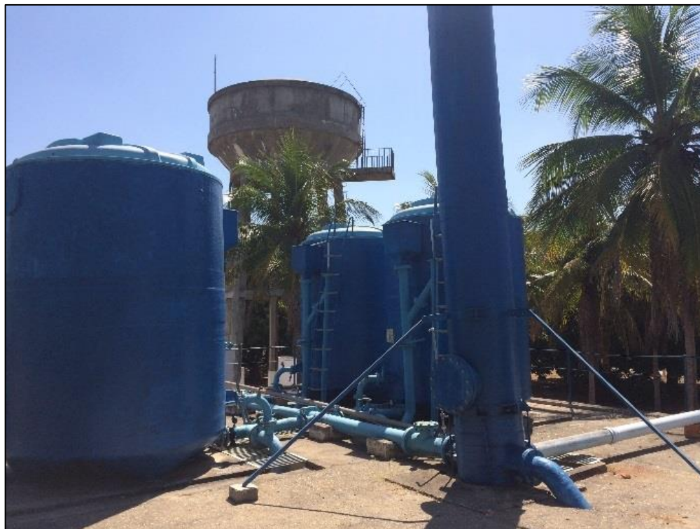
Figura 79 – Estrutura física da ETA Barragem Leste Fonte: DRZ – Geotecnologia e Consultoria, 2017.
