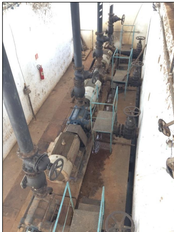
Figura 38 – Motores de adução. Fonte: DRZ – Geotecnologia e Consultoria, 2017.
