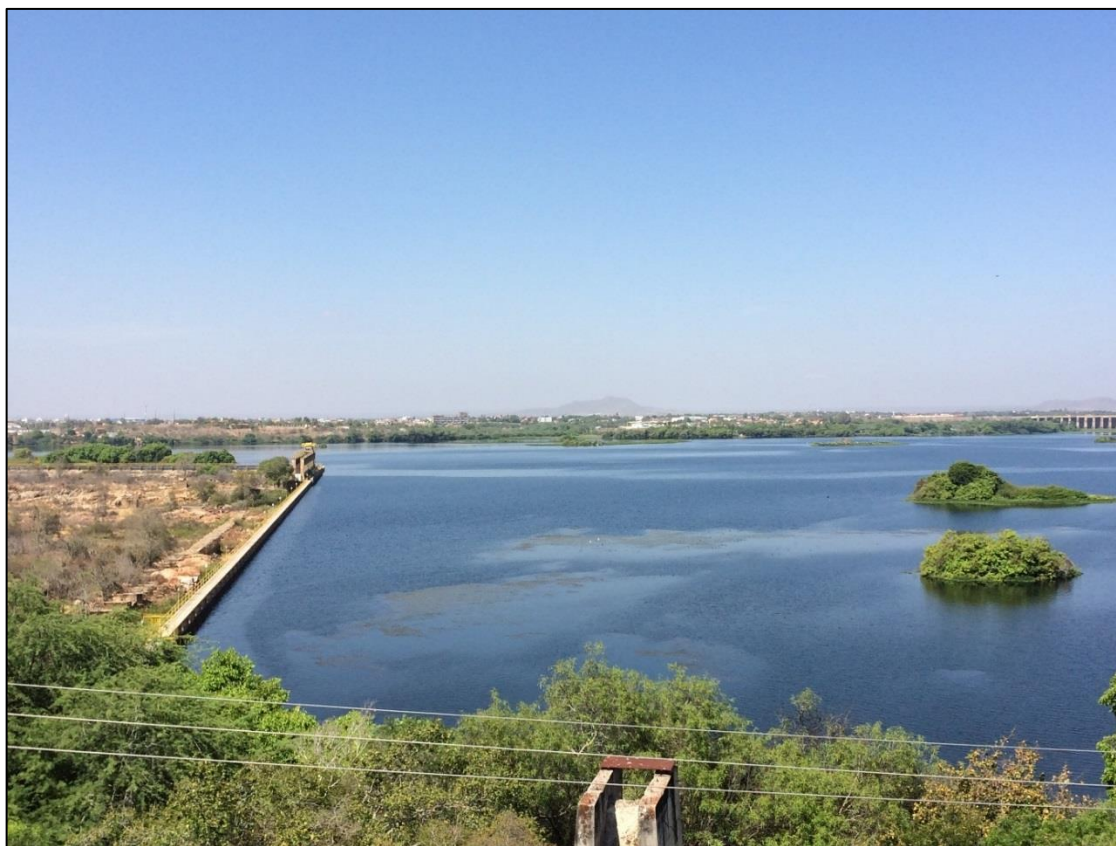
Figura 73 – Manancial superficial de Barragem Leste.
