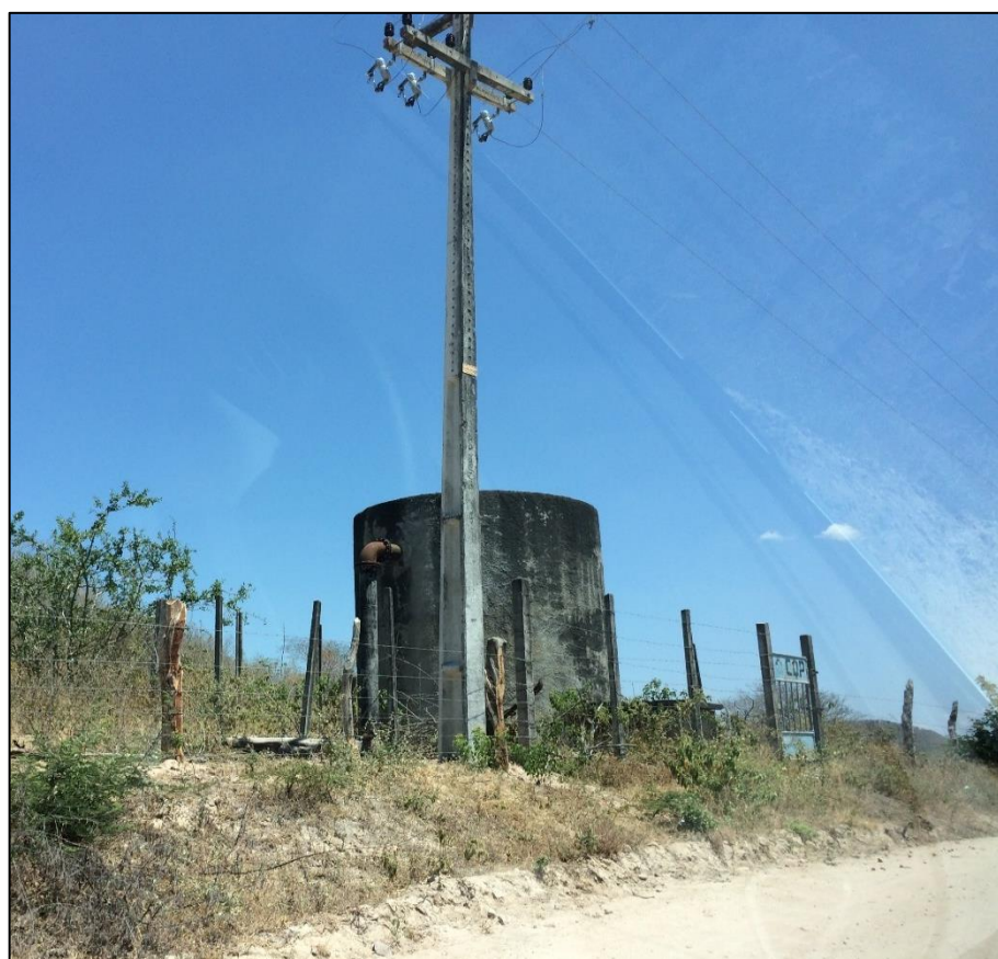
Figura 91 – Reservatório de passagem derivação Simimbú Fonte: DRZ – Geotecnologia e Consultoria, 2017.
