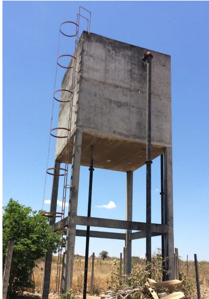
Figura 92 – Reservatório Elevado Alto Bonito Fonte: DRZ - Geotecnologia e Consultoria, 2017.
