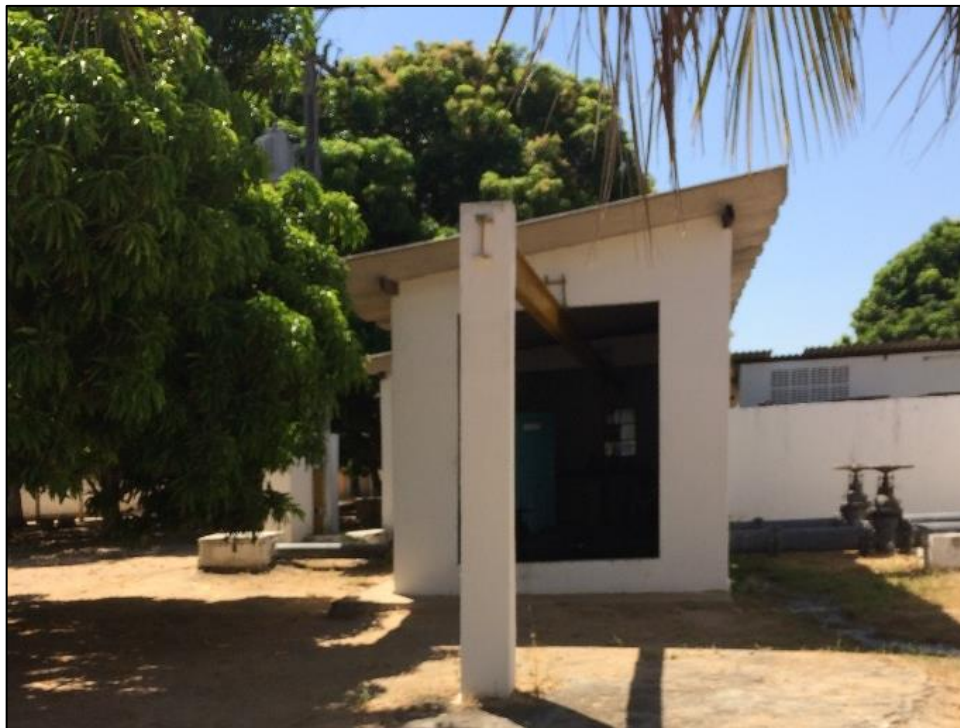
Figura 86 – EEAT de abastecimento do povoado de Jardim Cordeiro. Fonte: DRZ – Geotecnologia e Consultoria, 2017.
