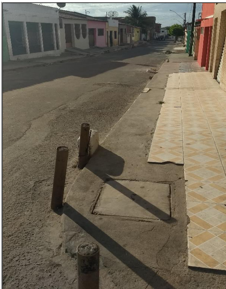
Figura 131 – Rede e ligação de esgoto em algumas áreas pavimentados do município.
