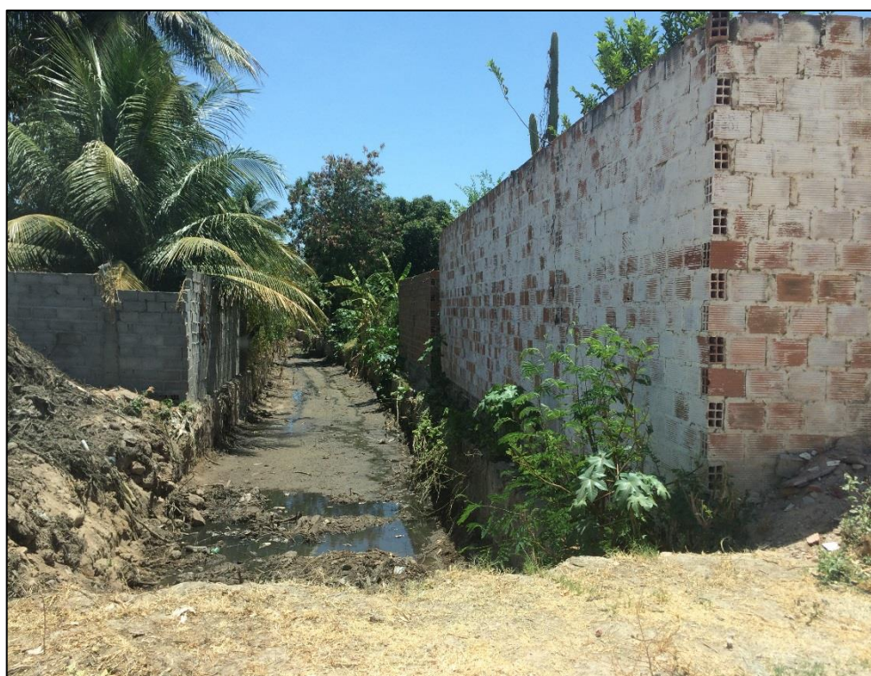
Figura 188 – Canal que direciona água pluvial para o lago. Fonte: DRZ – Geotecnologia e Consultoria, 2017.
