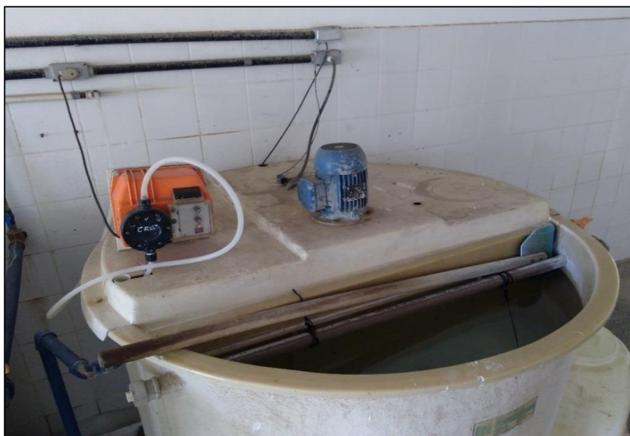
Figura 59 – Aplicação de flúor para tratamento da água. Fonte: DRZ – Geotecnologia e Consultoria, 2017.
