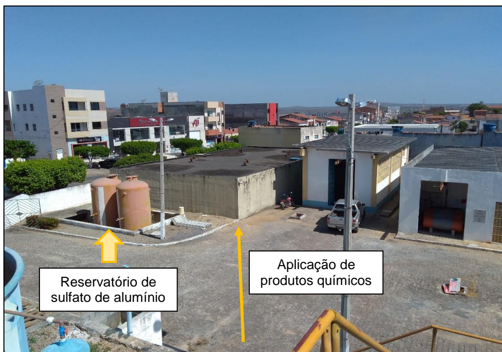
Figura 53 – Aplicação de produtos químicos para tratamento da água. Fonte: DRZ – Geotecnologia e Consultoria, 2017.
