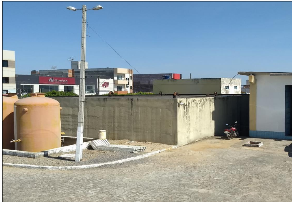
Figura 72 – Reservatório Apoiado (RAP), 1.000 m 3 . Fonte: DRZ – Geotecnologia e Consultoria, 2017.
