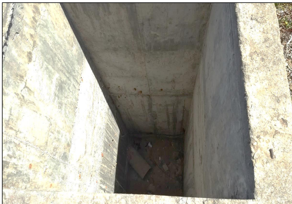
Figura 137 – Descarga de fundo do desarenador da EEE II. Fonte: DRZ – Geotecnologia e Consultoria, 2017.
