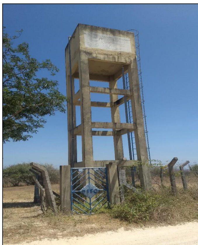
Figura 88 – Quebra carga elevado, 5 m 3 . Fonte: DRZ Geotecnologia e Consultoria, 2017.
