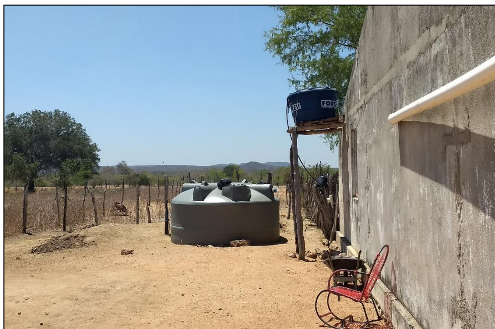
Figura 121 – Cisterna de armazenamento de água. Fonte: DRZ – Geotecnologia e Consultoria, 2017.
