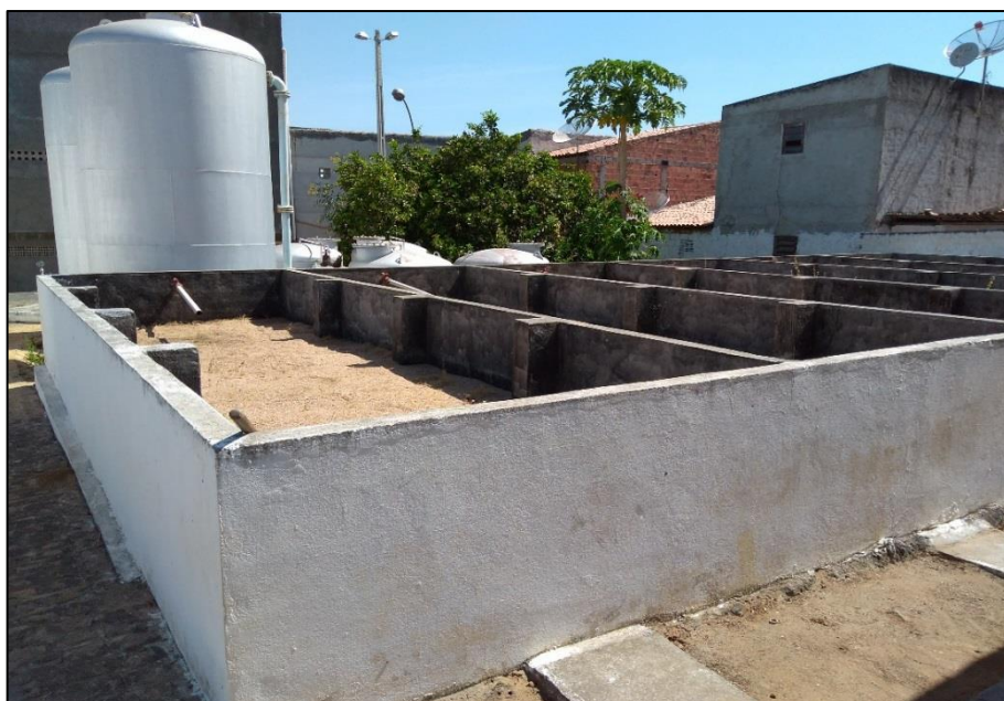
Figura 60 – Leito de secagem do lodo da ETA. Fonte: DRZ – Geotecnologia e Consultoria, 2017.
