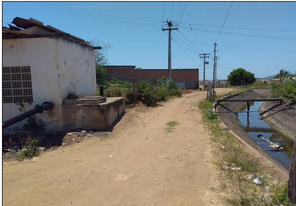
Figura 35 – Ponto de captação superficial no canal do Projeto Califórnia. Fonte: DRZ Geotecnologia e Consultoria, 2017.
