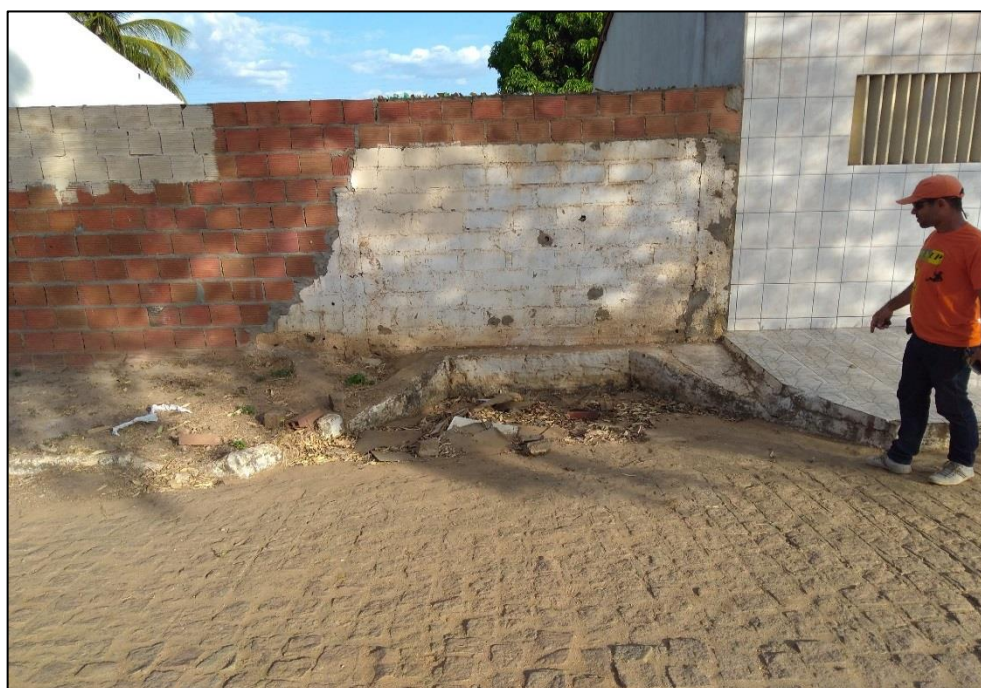
Figura 208 – Estrutura de captação de água pluvial sem manutenção. Fonte: DRZ – Geotecnologia e Consultoria, 2017.
