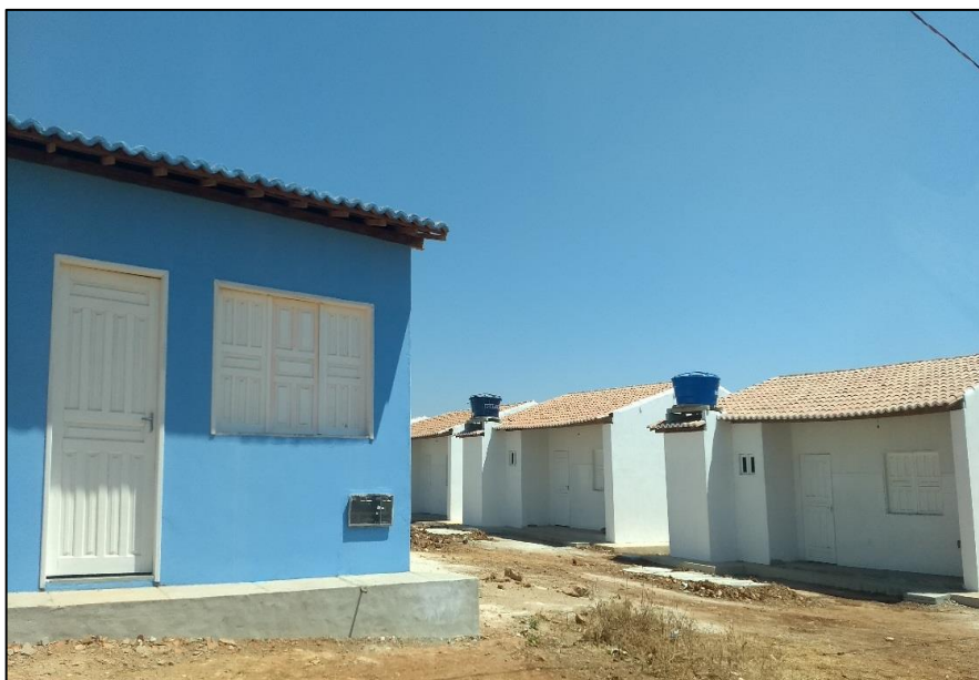
Figura 116 – Reservatório individual na comunidade Quilombola. Fonte: DRZ – Geotecnologia e Consultoria, 2017.
