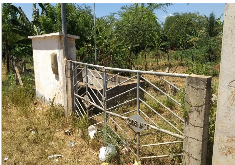
Figura 133 – Estação Elevatória de Esgoto I (EEE I).
