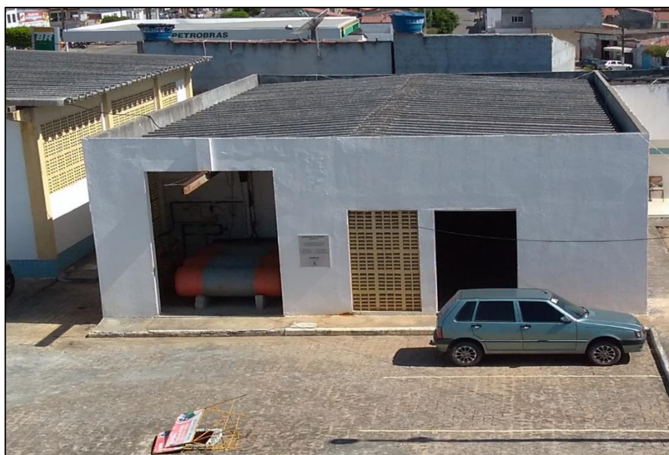
Figura 54 – Salas de armazenamento e aplicação de produtos químicos para o tratamento da água. Fonte: DRZ – Geotecnologia e Consultoria, 2017.
