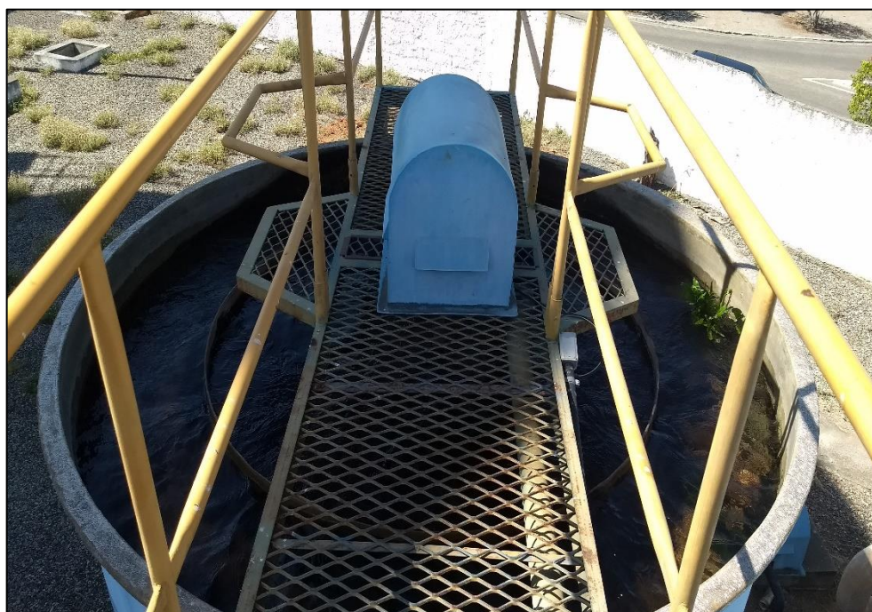
Figura 49 – Agitação da água, após aplicação do sulfato de alumínio. Fonte: DRZ – Geotecnologia e Consultoria, 2017.
