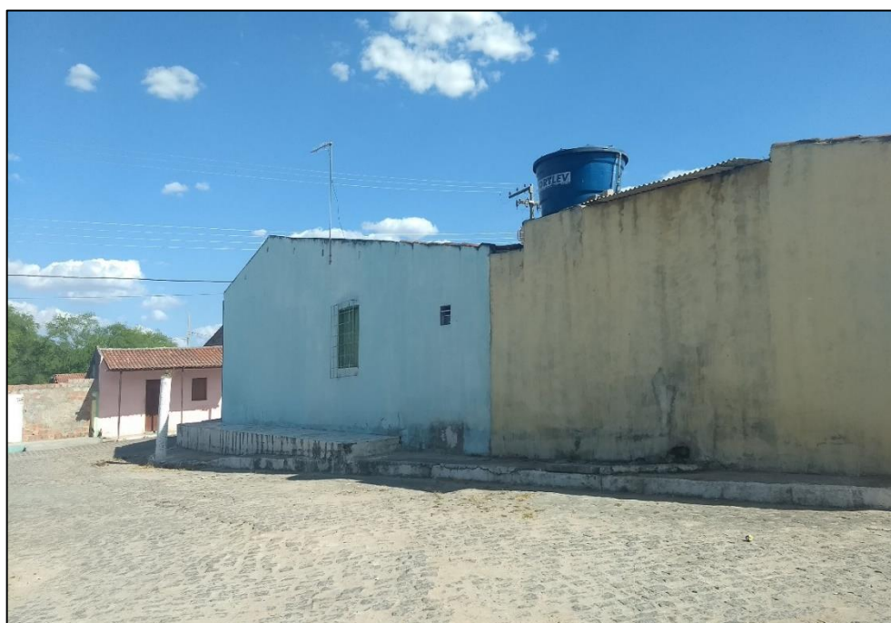
Figura 97 – Reservatório individual na comunidade Capim Grosso.
