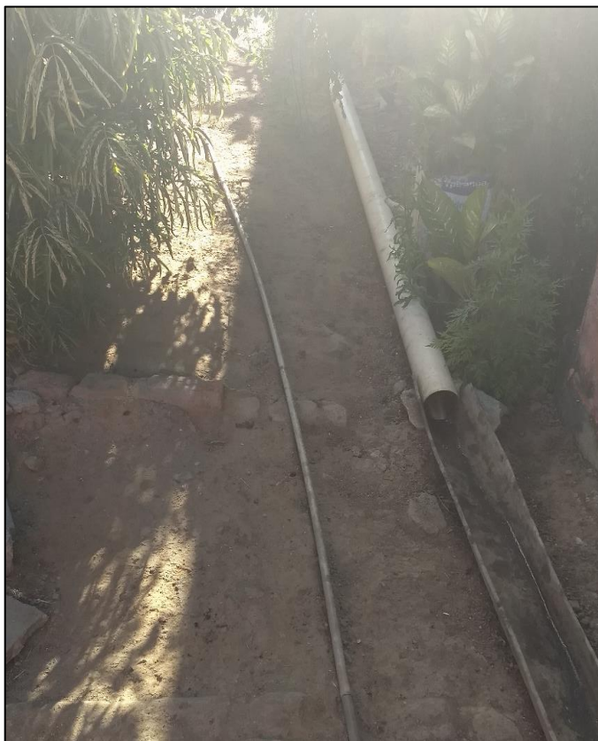
Figura 161 – Tubulação de águas residuais nas residências da comunidade Nova Vida.
