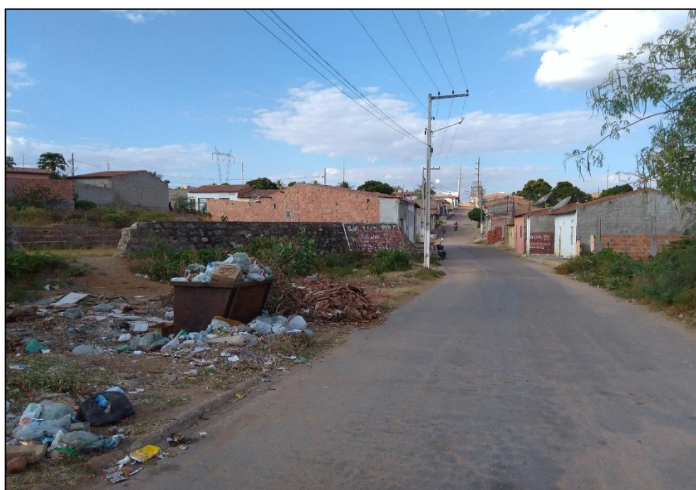
Figura 204 – Rua com histórico de alagamento no município de Canindé de São Francisco. Fonte: DRZ – Geotecnologia e Consultoria, 2017.
