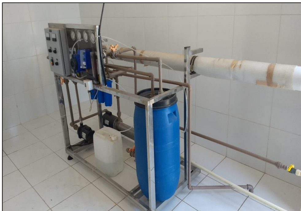
Figura 118 – Aparelho de dessalinização do PAD no Acampamento Caiçara. Fonte: DRZ – Geotecnologia e Consultoria, 2017.
