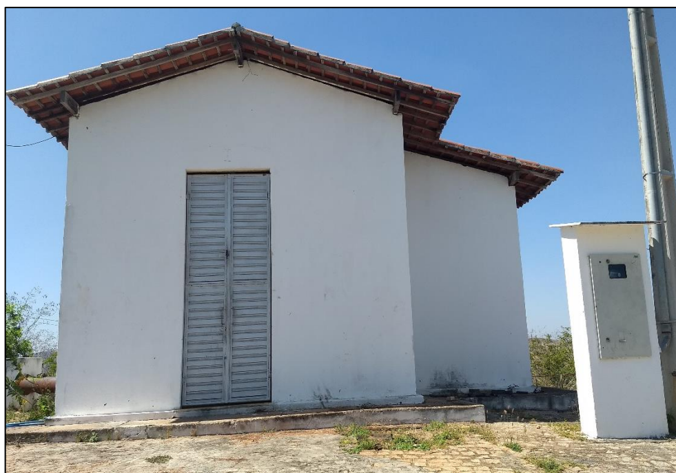
Figura 77 – Estação Elevatória de Água Tratada (EEAT) Pedra D'Água. Fonte: DRZ Geotecnologia e Consultoria, 2017.
