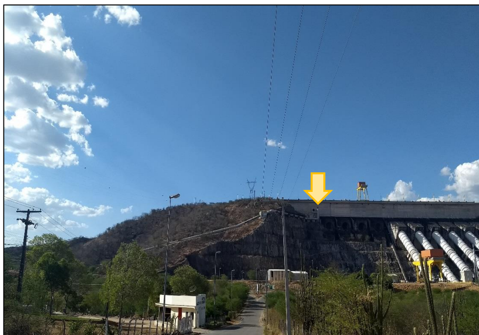
Figura 32 – Ponto de captação superficial no lago da Usina Hidrelétrica de Xingó, Rio São Francisco.
