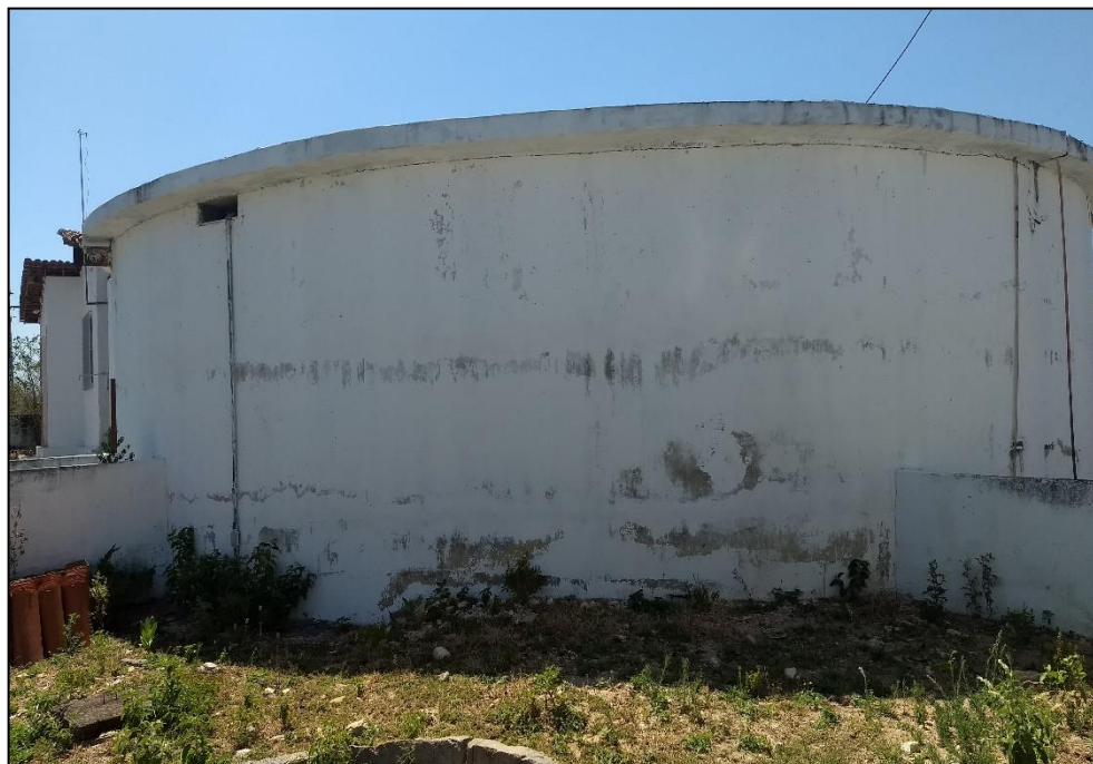
Figura 78 – Reservatório Apoiado (RAP) da EEAT Pedra D'Água, 300 m 3 . Fonte: DRZ Geotecnologia e Consultoria, 2017.
