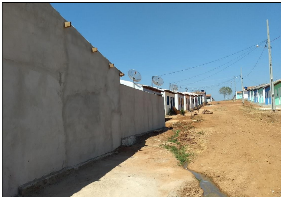
Figura 163 – Escoamento do esgoto gerado nas residências da Comunidade Quilombola.
