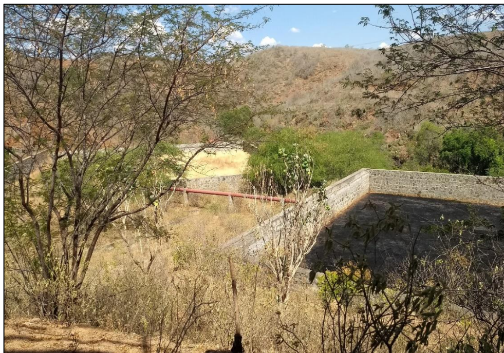
Figura 141 – Lagoas de polimento. Fonte: DRZ – Geotecnologia e Consultoria, 2017.
