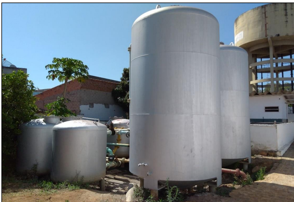
Figura 63 – Estação de Tratamento de Água II. Fonte: DRZ – Geotecnologia e Consultoria, 2017.
