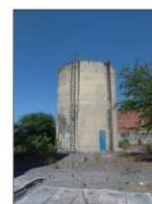
RAP de 200 m 3
