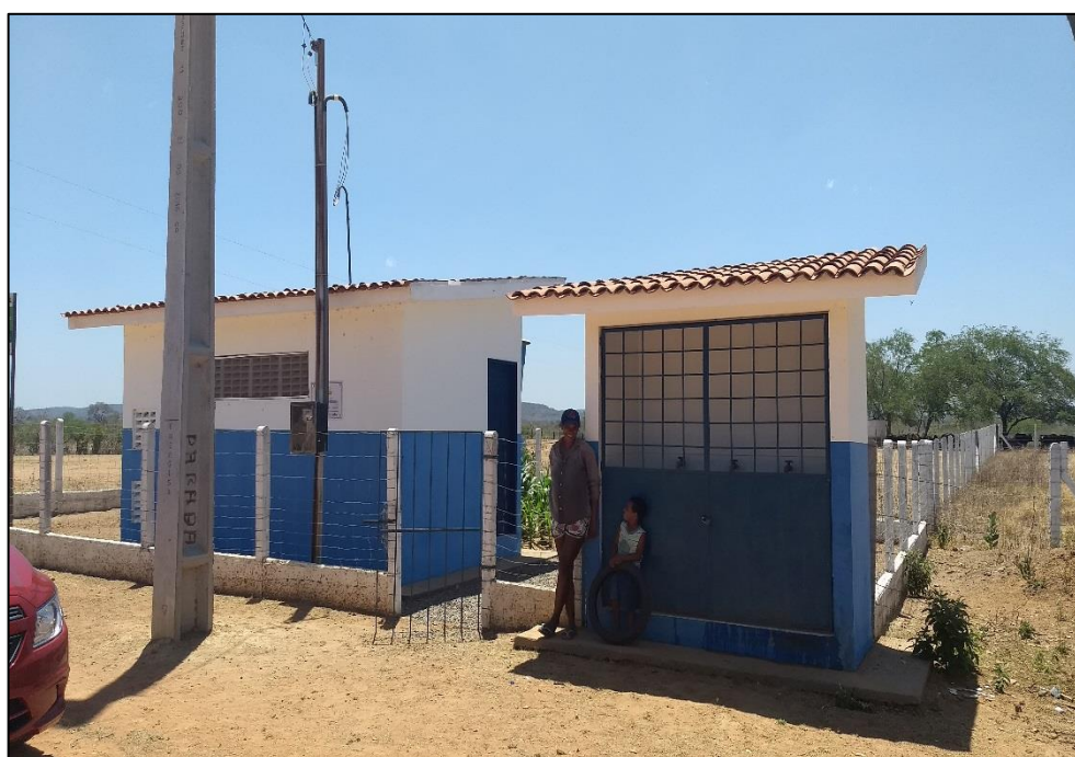
Figura 119 – Sistema de dessalinização do Programa Água Doce no Acampamento Caiçara. Fonte: DRZ – Geotecnologia e Consultoria, 2017.
