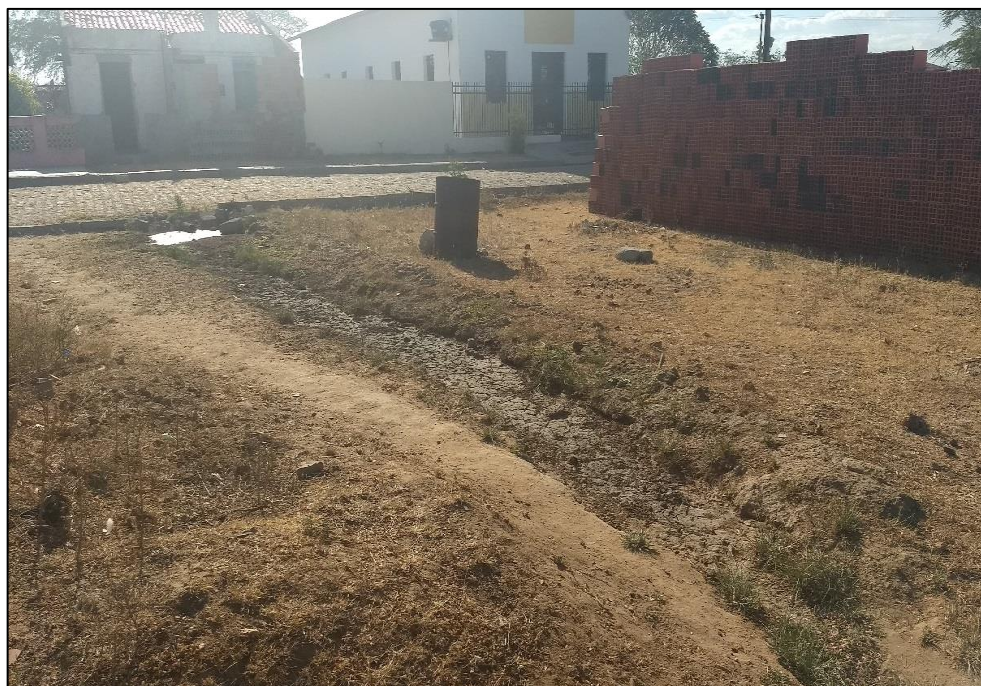
Figura 162 – Lançamento inadequado de água residual na comunidade Nova Vida.
