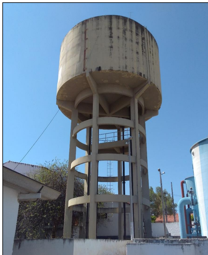
Figura 73 – Reservatório Elevado (REL), 500 m 3 . Fonte: DRZ – Geotecnologia e Consultoria, 2017.
