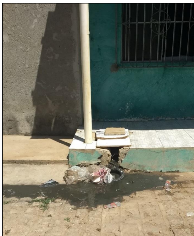
Figura 131 – Lançamento irregular de esgoto na via pública. Fonte: DRZ – Geotecnologia e Consultoria, 2017.
