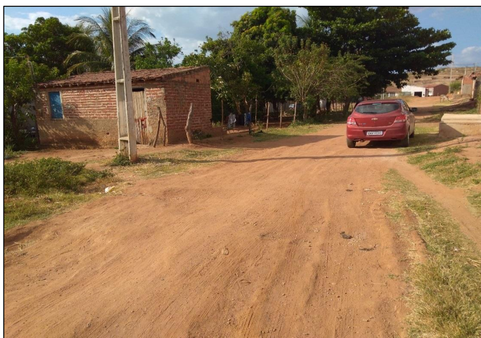
Figura 190 – Exemplo de rua sem pavimentação em Canindé de São Francisco. Fonte: DRZ – Geotecnologia e Consultoria, 2017.
