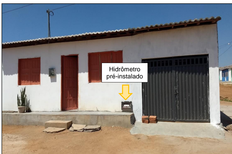
Figura 115 – Hidrômetros pré-instalados na comunidade Quilombola Rua dos Negros.
