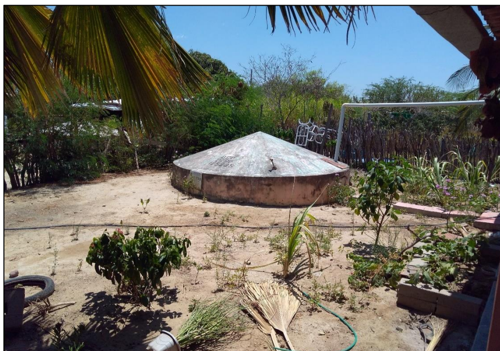
Figura 107 – Cisterna do Assentamento 12 de Março. Fonte: DRZ – Geotecnologia e Consultoria, 2017.
