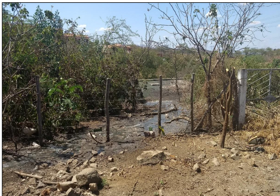
Figura 143 – Entrada da Estação de Tratamento de Esgoto II. Fonte: DRZ – Geotecnologia e Consultoria, 2017.
