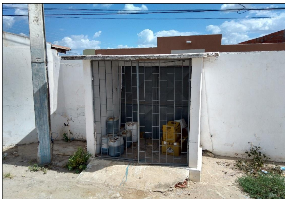
Figura 182 – Local de acondicionamento temporário dos resíduos de serviços de saúde.
