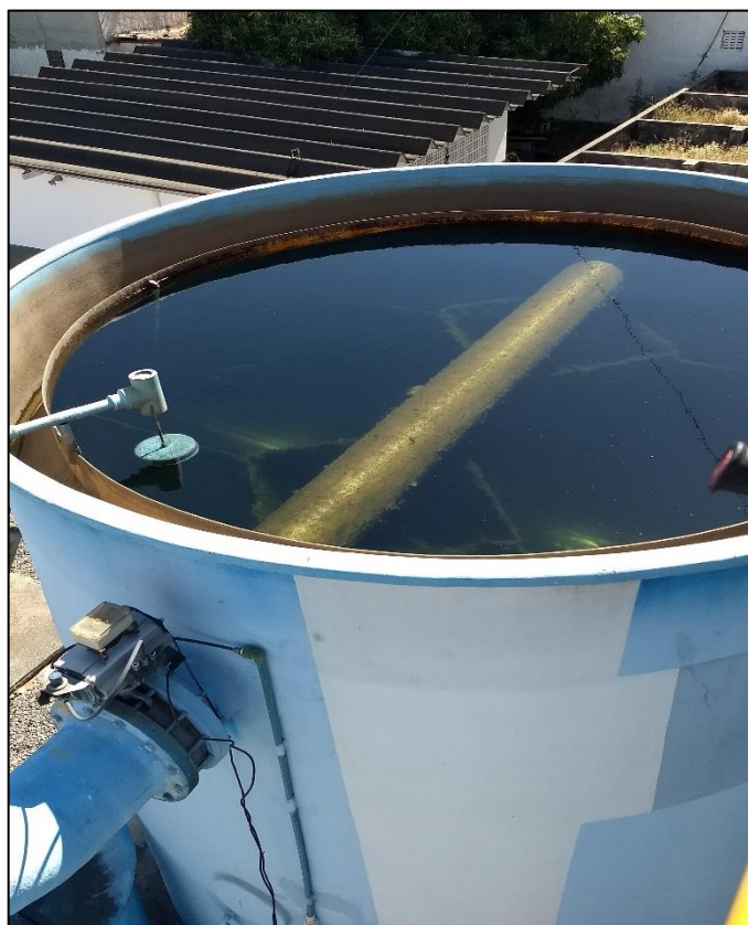
Figura 51 – Etapa de filtração da água na ETA I. Fonte: DRZ – Geotecnologia e Consultoria, 2017.
