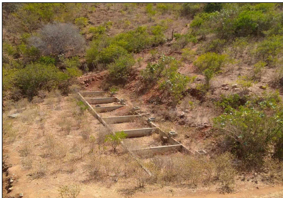
Figura 142 – Leito de secagem. Fonte: DRZ – Geotecnologia e Consultoria, 2017.
