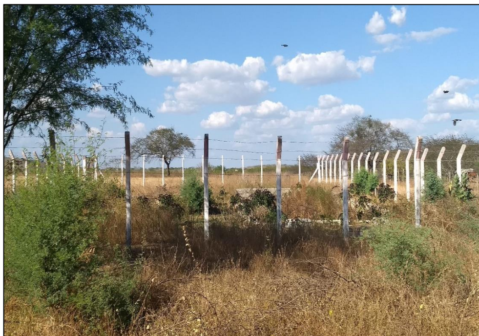
Figura 146 – Sistema de tratamento de esgoto do Povoado Capim Grosso. Fonte: DRZ – Geotecnologia e Consultoria, 2017.
