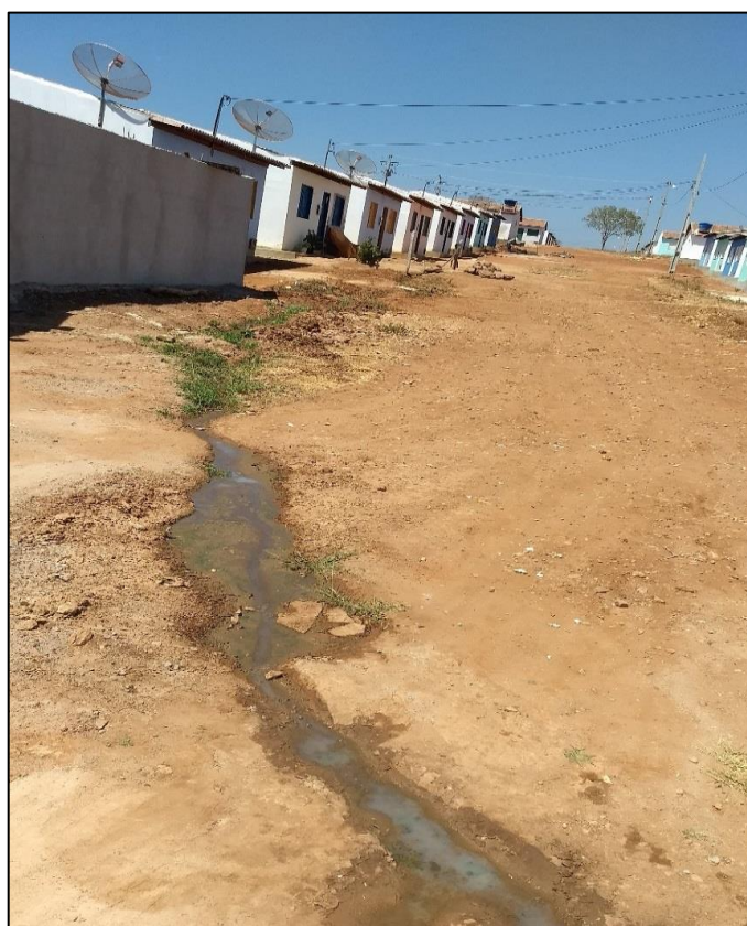
Figura 164 – Lançamento irregular de esgoto à céu aberto na Comunidade Quilombola.
