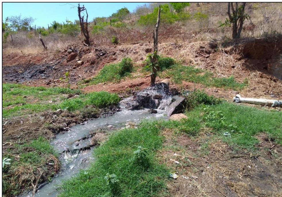
Figura 123 – Lançamento irregular de esgoto. Fonte: DRZ – Geotecnologia e Consultoria, 2017.
