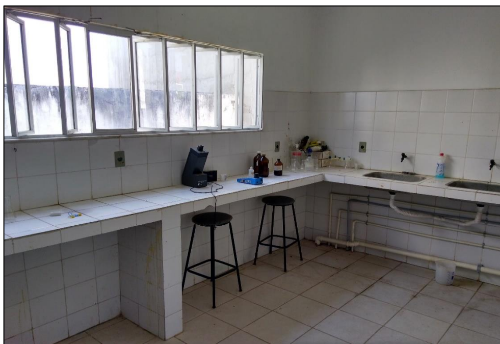
Figura 68 – Laboratório da ETA. Fonte: DRZ – Geotecnologia e Consultoria, 2017.
