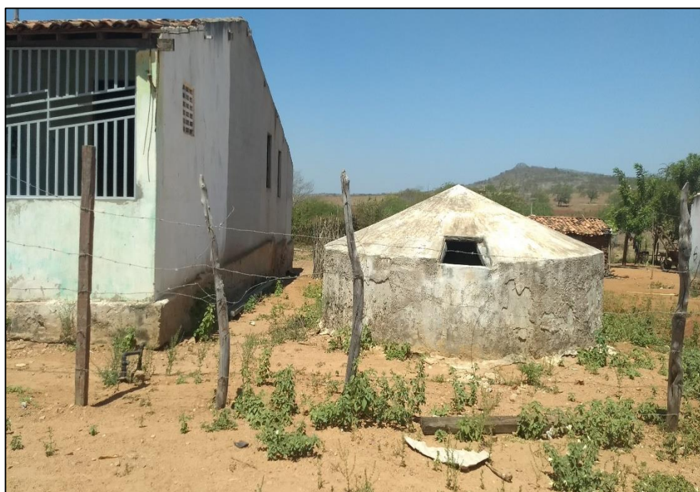
Figura 104 – Cisterna no Assentamento Mandacaru. Fonte: DRZ – Geotecnologia e Consultoria, 2017.
