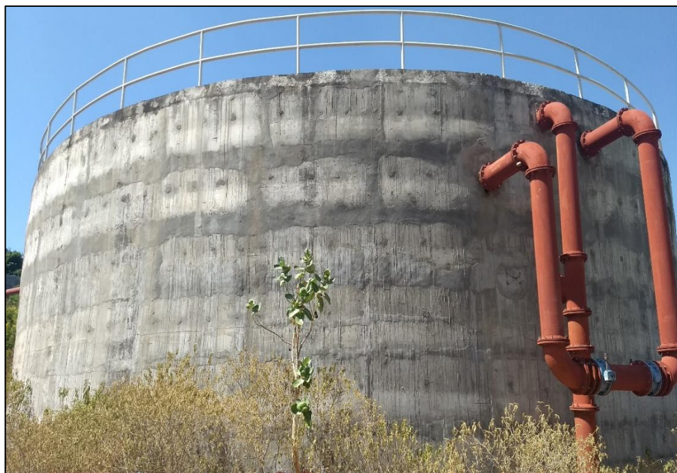
Figura 139 – Reator UASB. Fonte: DRZ – Geotecnologia e Consultoria, 2017.
