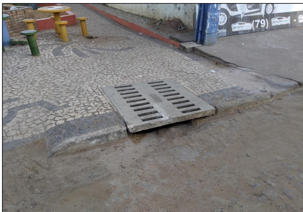
Figura 192 – Bocas de lobo em Canindé de São Francisco. Fonte: DRZ – Geotecnologia e Consultoria, 2017.
