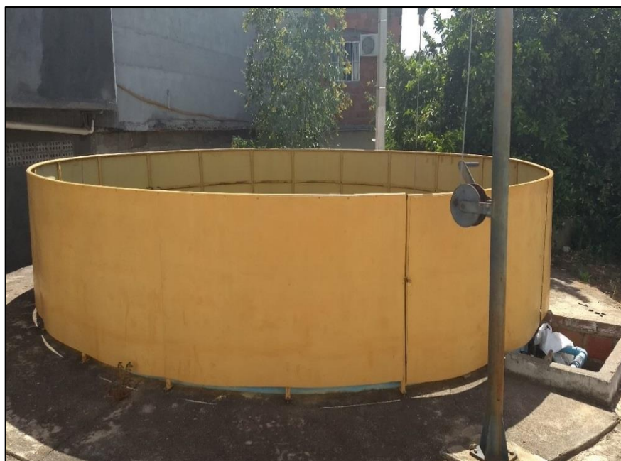
Figura 62 – Tanque de recirculação. Fonte: DRZ – Geotecnologia e Consultoria, 2017.
