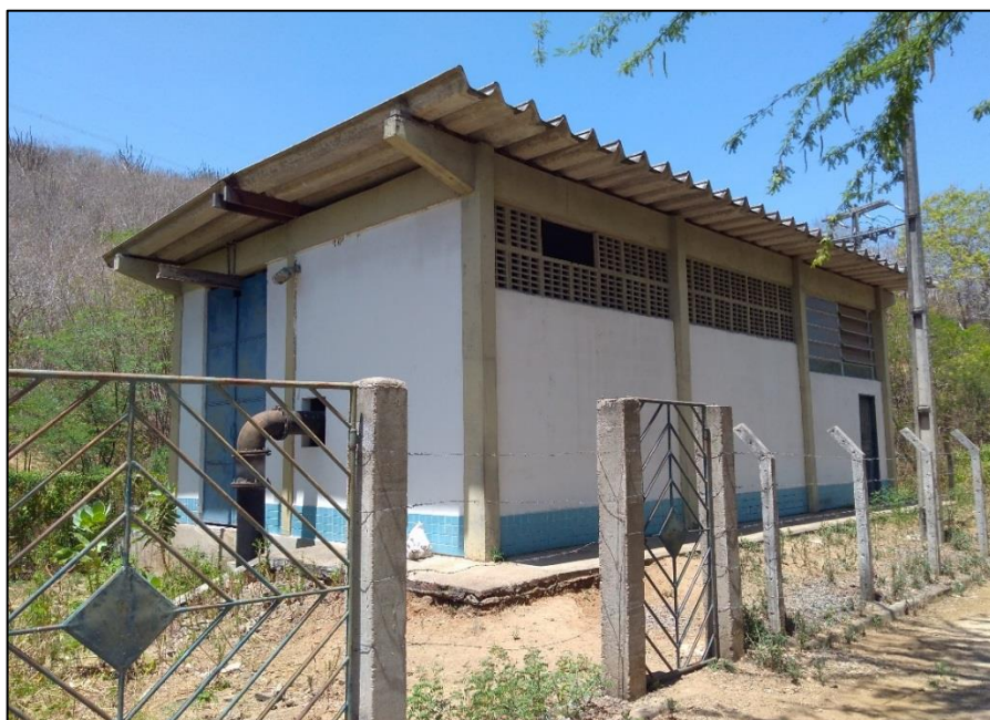
Figura 40 – Estação Elevatória de Água Bruta (EEAB) da água captada no lago da Usina Xingó.
