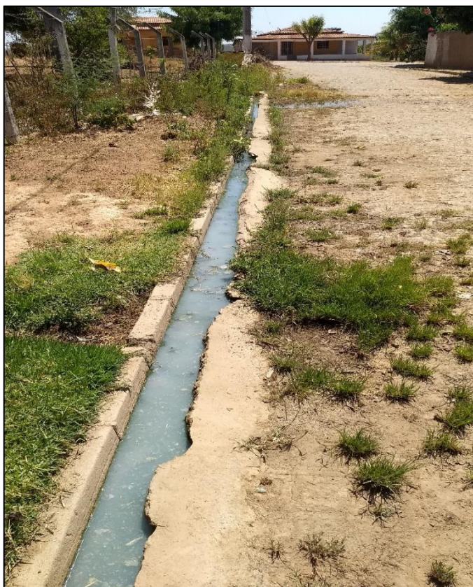
Figura 153 – Efluente canalizado pelas guias da pavimentação no Povoado Curituba.
