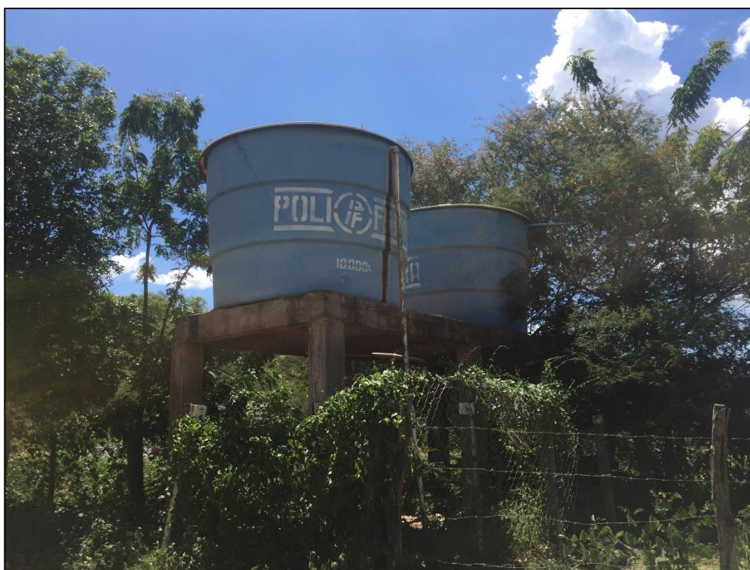
Figura 81 - R1 - Comunidade Olho D'água dos Tanques.
