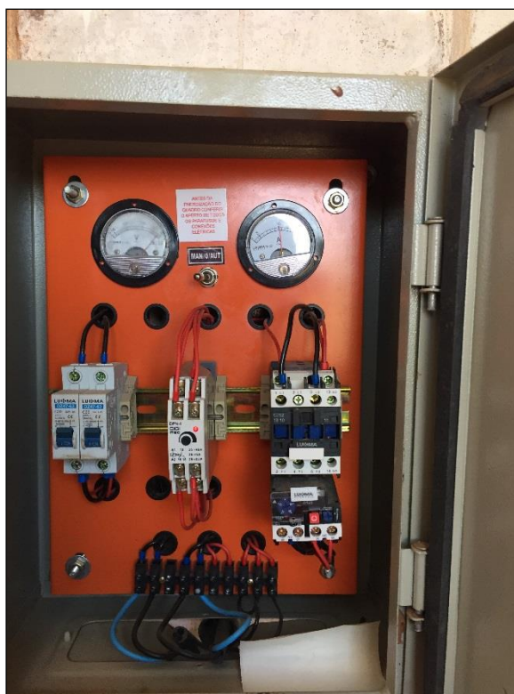
Figura 59 – Poço – Comunidade Boqueirão. Fonte: DRZ – Geotecnologia e Consultoria, 2017.
