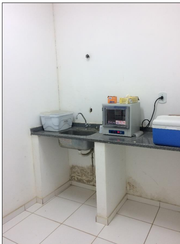
Figura 35 – Laboratório - ETA - distrito Sede. Fonte: DRZ – Geotecnologia e Consultoria, 2017.
