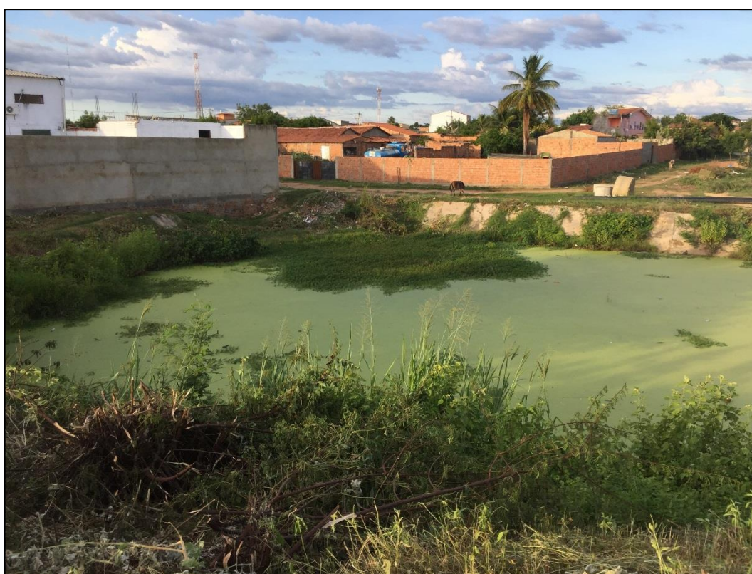
Figura 99 - Reservatório de detenção com acúmulo de efluente de esgoto doméstico.
