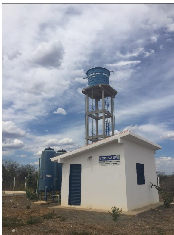
Figura 72 – Casa de comando – Comunidade Novo Horizonte. Fonte: DRZ – Geotecnologia e Consultoria, 2017.
