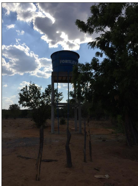
Figura 60 – REL 1 de 10 m 3 – Comunidade Boqueirão. Fonte: DRZ – Geotecnologia e Consultoria, 2017.
