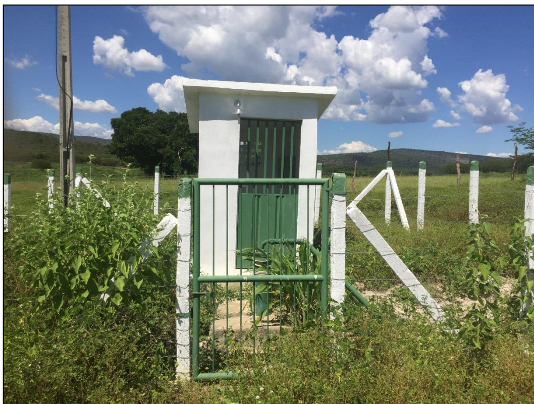
Figura 80 - Poço 3 - Comunidade Olho D'água dos Tanques. Fonte: DRZ – Geotecnologia e Consultoria, 2018.
