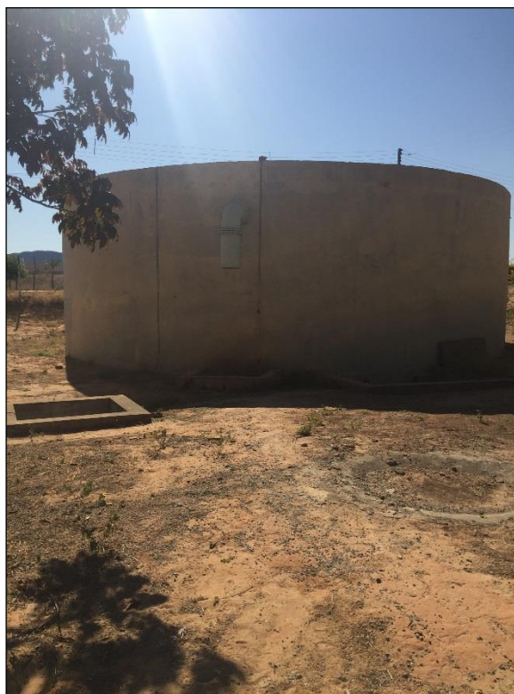
Figura 43 – RAP 500 m 3 – Reservatório ETA. Fonte: DRZ – Geotecnologia e Consultoria, 2017.
