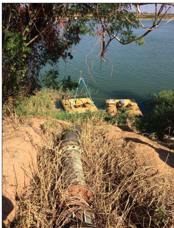
Figura 27 – Captação superficial no rio São Francisco – distrito Sede. Fonte: DRZ – Geotecnologia e Consultoria, 2017.
