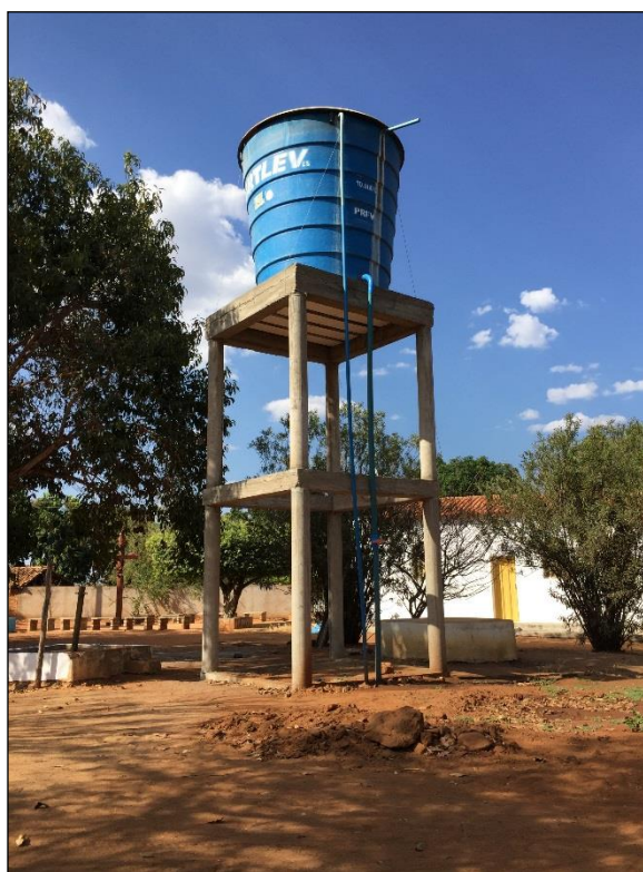
Figura 61 – REL 2 de 10 m 3 – Comunidade Boqueirão. Fonte: DRZ – Geotecnologia e Consultoria, 2017.
