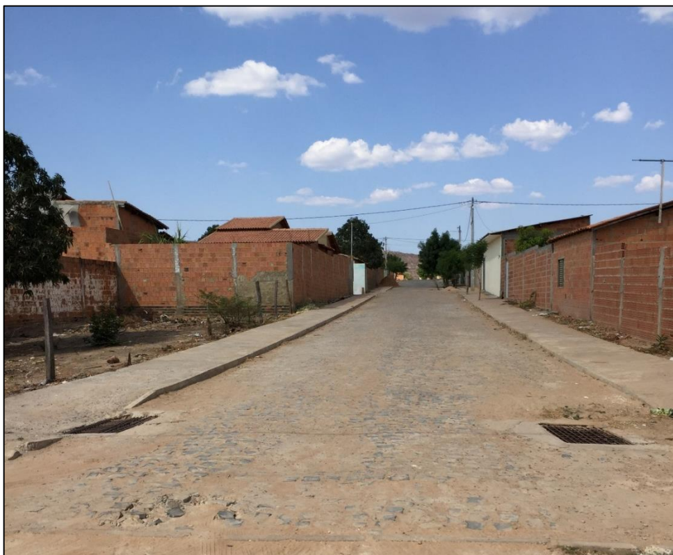
Figura 124 - Estrutura de captação do tipo grelha – distrito Sede. Fonte: DRZ – Geotecnologia e Consultoria, 2017.
