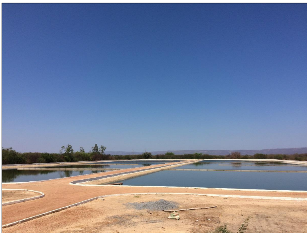
Figura 97 – Lagoas de maturação. Fonte: DRZ – Geotecnologia e Consultoria, 2017.
