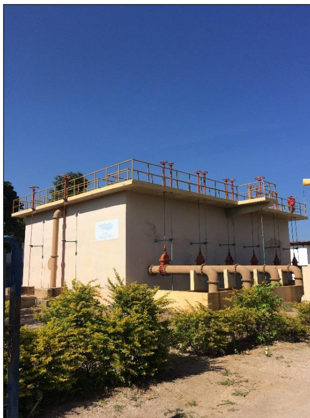
Figura 31 – Vista frontal do prédio da ETA. Fonte: DRZ – Geotecnologia e Consultoria, 2017.
