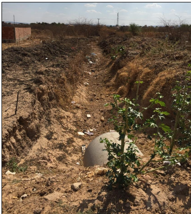
Figura 126 - Ponto de lançamento da água pluvial captada. Fonte: DRZ – Geotecnologia e Consultoria, 2017.
