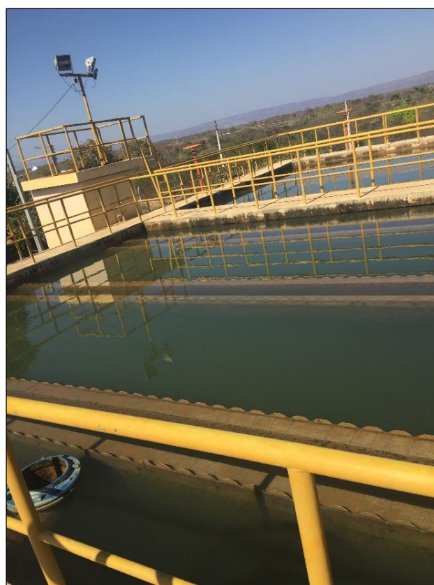
Figura 33 – Floccodecantadores – distrito Sede. Fonte: DRZ – Geotecnologia e Consultoria, 2017.
