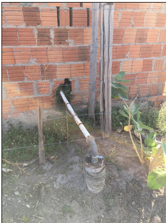
Figura 63 – Captação superficial – Comunidade Canabrava. Fonte: DRZ – Geotecnologia e Consultoria, 2017.
