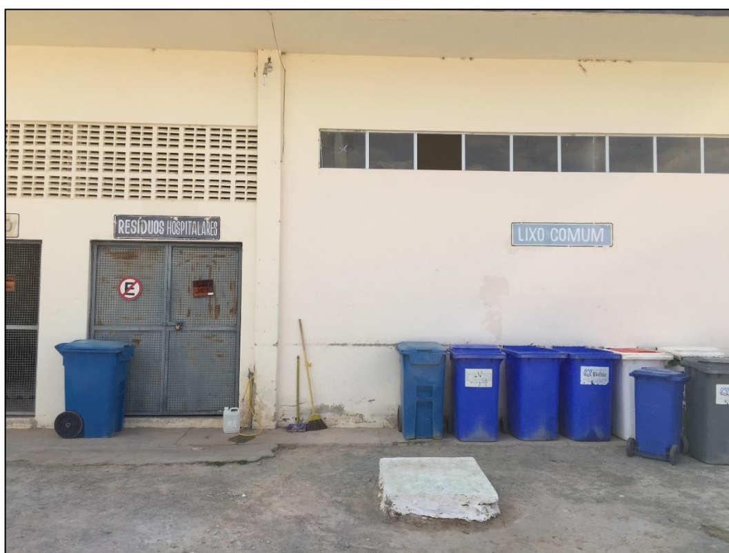
Figura 118 - Local de acondicionamento dos resíduos de serviços de saúde do Hospital Regional de Ibotirama.
