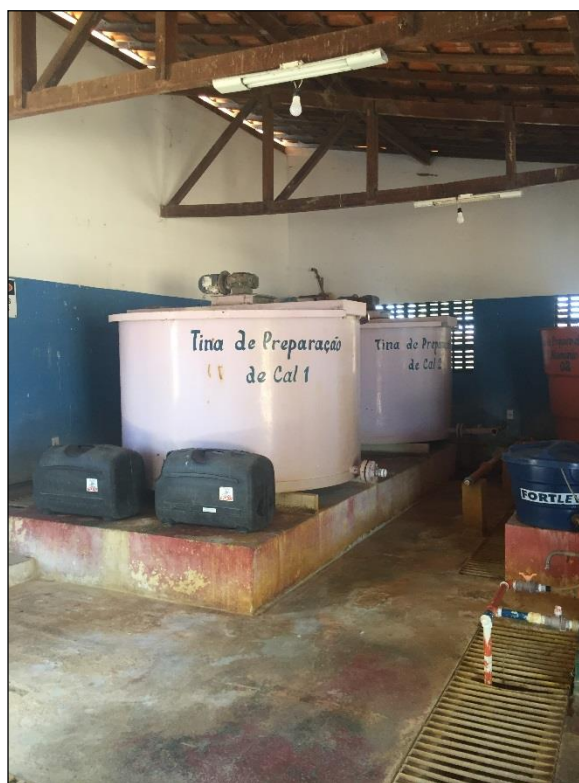
Figura 41 – Misturador de Cal. Fonte: DRZ – Geotecnologia e Consultoria, 2017.
