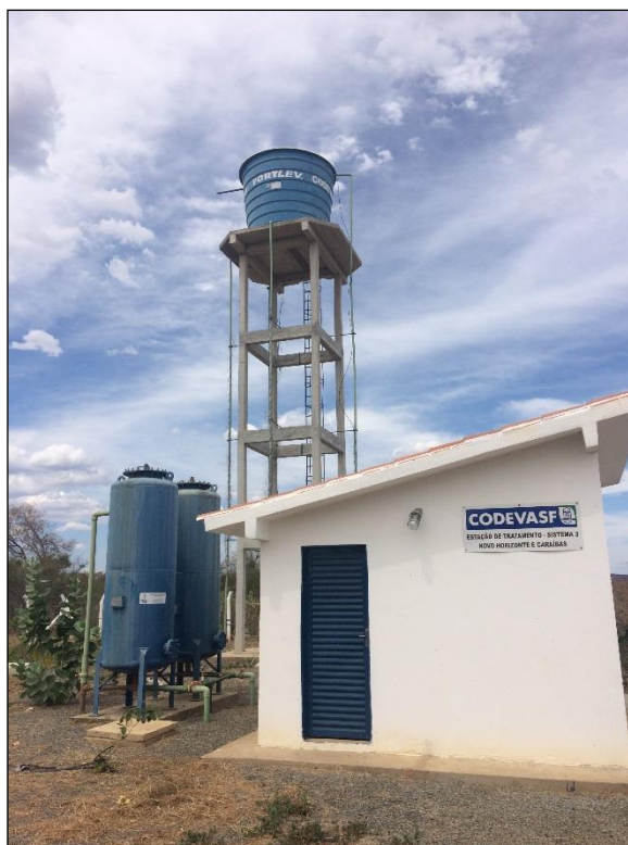
Figura 76 – REL 15 m 3 – Comunidade Novo Horizonte. Fonte: DRZ – Geotecnologia e Consultoria, 2017.
