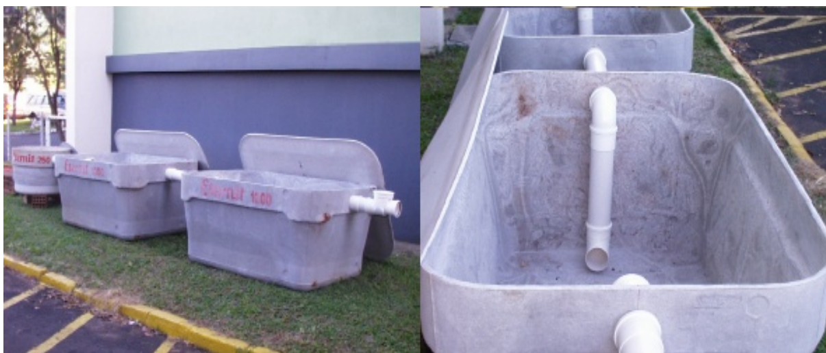
Figura 32 – Biodigestor Montado: Vista Lateral e Vista Superior Fonte: EMBRAPA, 2010.
