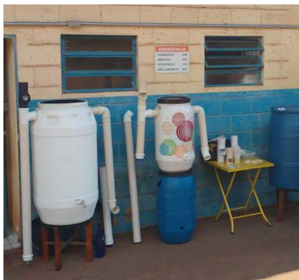
Figura 22 – Captação de água de chuva – Social Fonte: GERASOL, 2018
