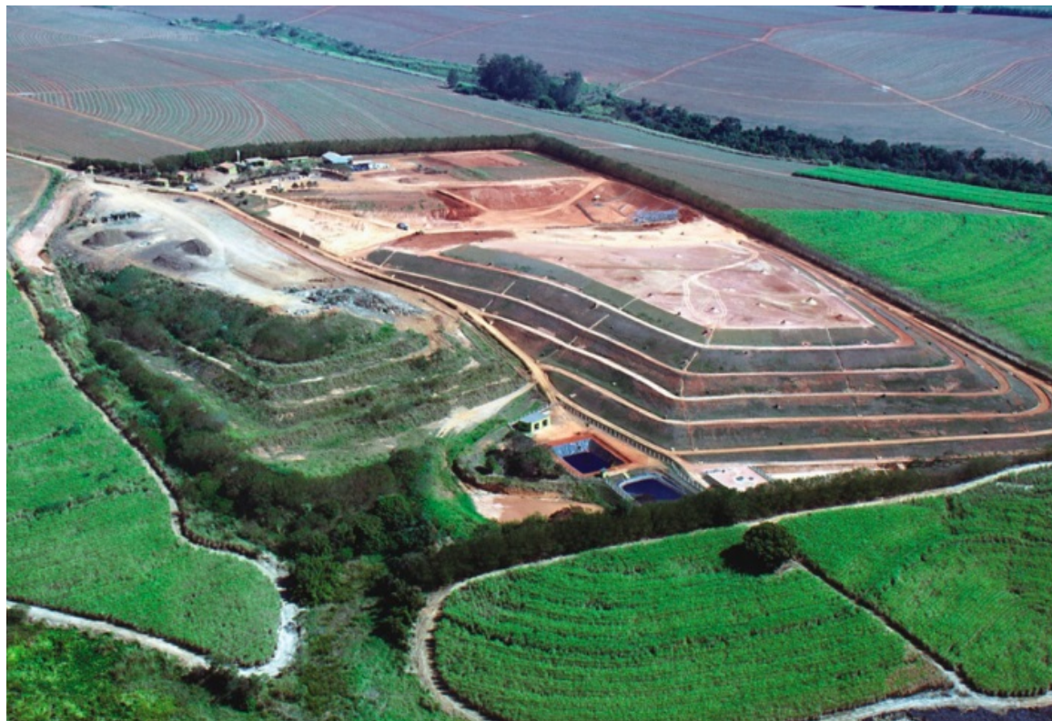
Figura 47 – Aterro Sanitário Fonte: GESOIS, 2018
