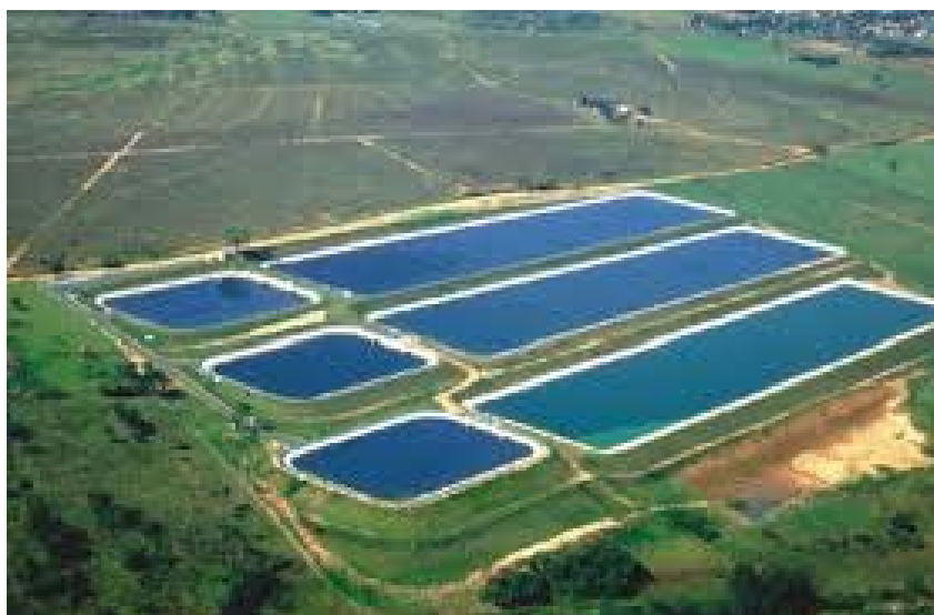
Figura 30 – Lagoas de Estabilização
