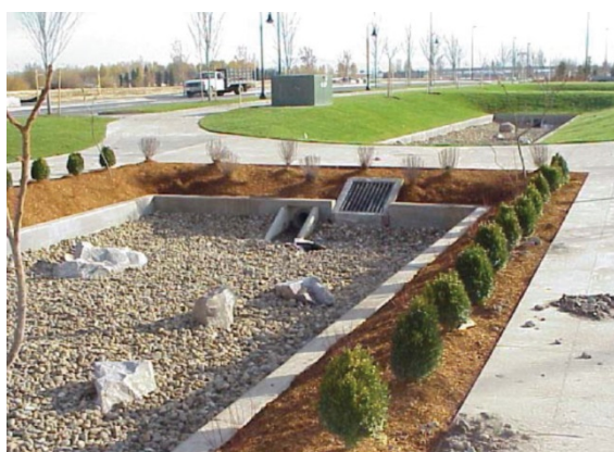
Figura 60 – Bacia de Percolação Fonte: CANHOLLI, 2005
