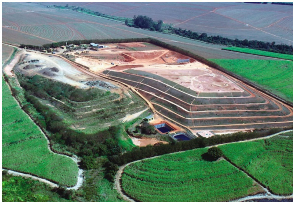
Figura 52 – Aterro Sanitário Fonte: GESOIS, 2018
