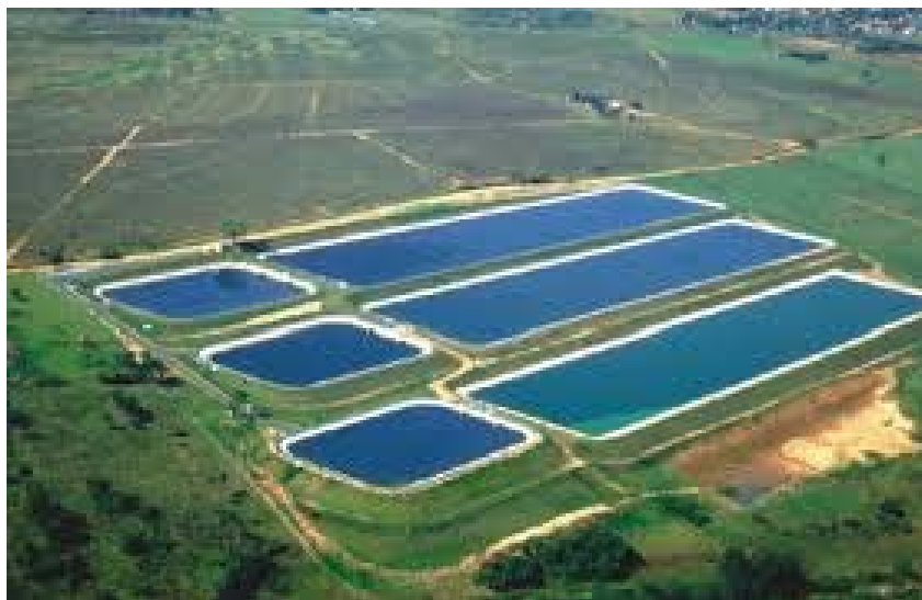
Figura 35 – Lagoas de Estabilização Fonte: USP, 2014
