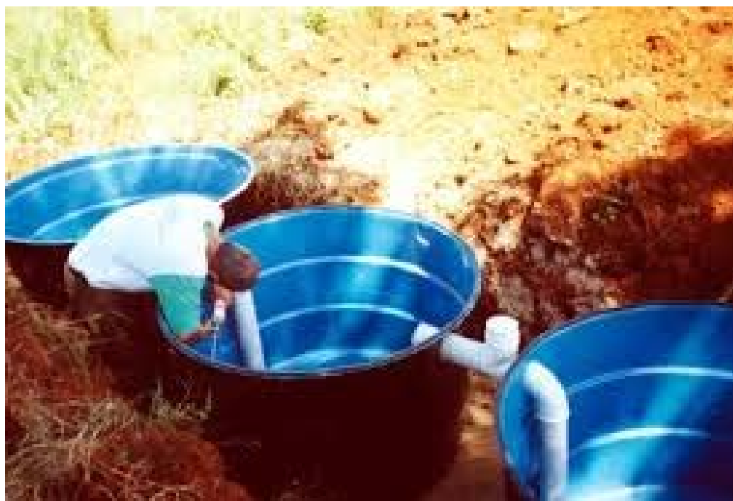
Figura 33 – Fossa Séptica Fonte: EMATER, 2014
