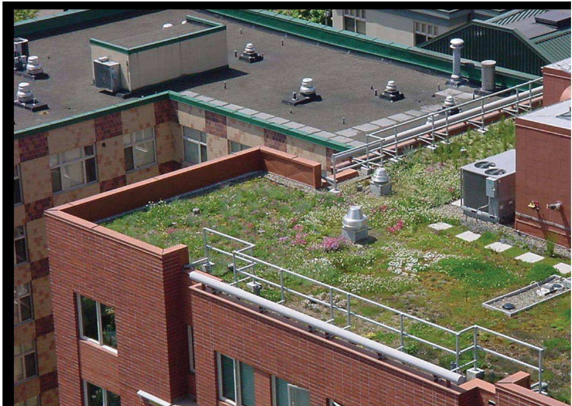
Figura 72 – Telhado Reservatório / Telhado Verde Fonte: PORTLAND, 2002
