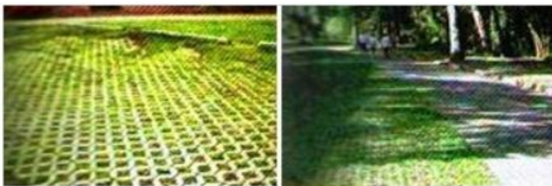
Figura 66 – Pavimento Poroso Parque Ibirapuera Fonte: SÃO PAULO, 1996; PORTLAND, 2002
