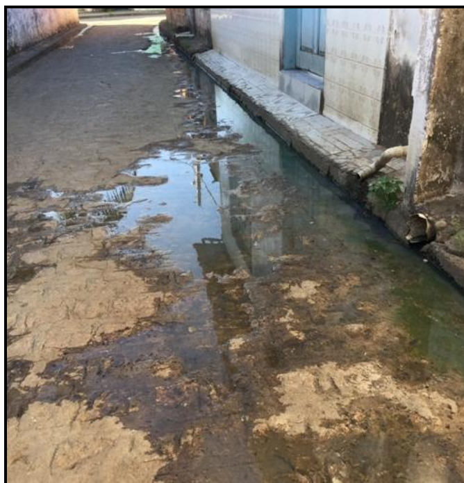
Figura 47 – Ponto de lançamento de esgoto a céu aberto no distrito Pontal do Peba
