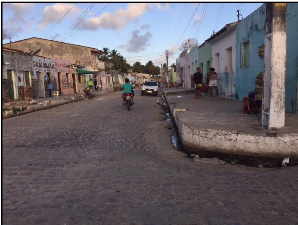
Figura 119 – Rua Antônio Machado Lemos (trecho sujeito a alagamento) Fonte: Premier Engenharia, 2018.
