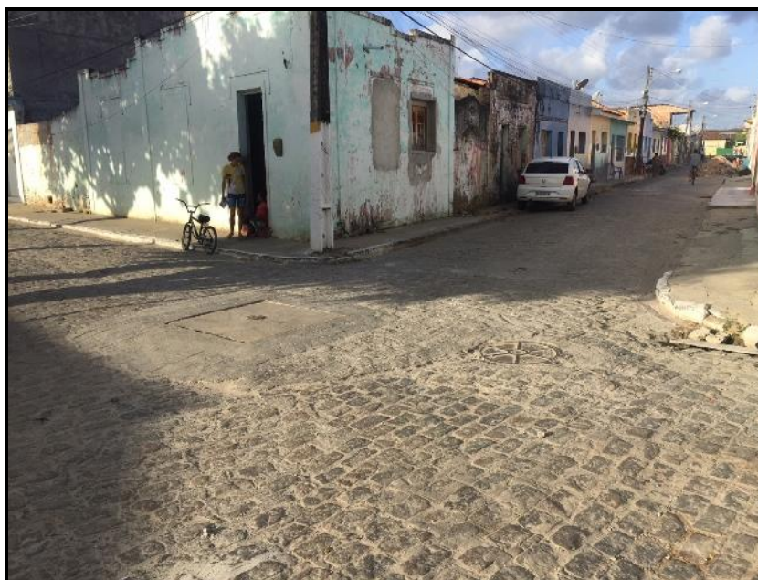
Figura 105 – Rua Joaquim Távora (região afetada por alagamento – vista 1) Fonte: Premier Engenharia, 2018.
