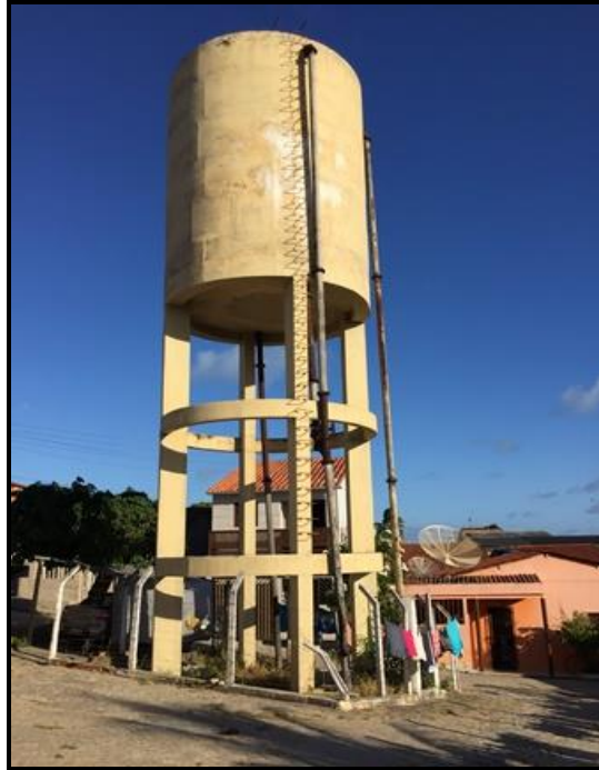
Figura 35 – Reservatório elevado próximo a praia Fonte: Premier Engenharia, 2018.
