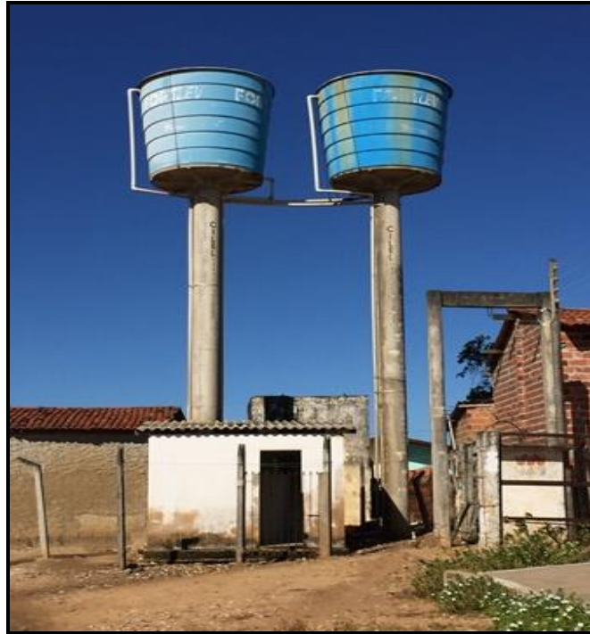
Figura 38 – Reservatórios elevados Fonte: Premier Engenharia, 2018.
