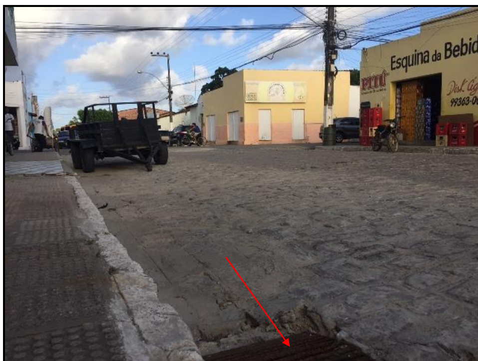
Figura 118 – Avenida Mestra Francelino (detalhe da boca-de-lobo) Fonte: Premier Engenharia, 2018.
