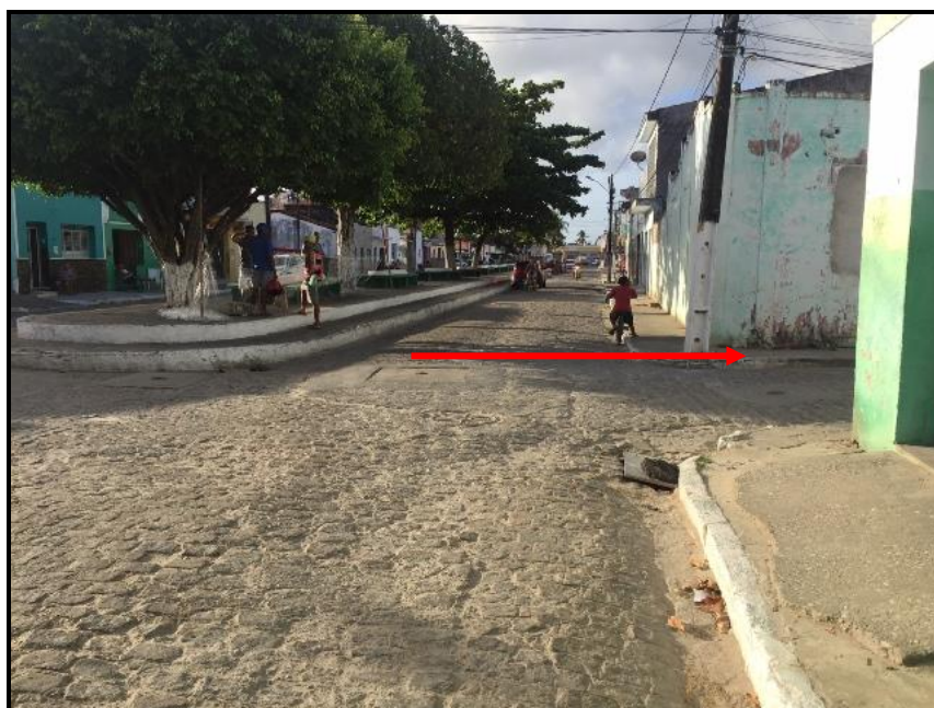
Figura 106 – Rua Joaquim Távora (região afetada por alagamento – vista 2) Fonte: Premier Engenharia, 2018.
