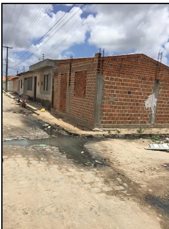
Figura 103 – Lançamento de esgoto em via pública (Rua São Joaquim) Fonte: Premier Engenharia, 2018.
