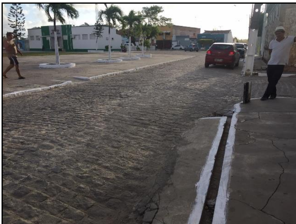
Figura 109 – Praça São Francisco de Borja (vista 1) Fonte: Premier Engenharia, 2018.
