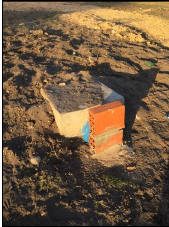
Figura 30 – Nova Captação em instalação - Penedinho Fonte: Premier Engenharia, 2018.
