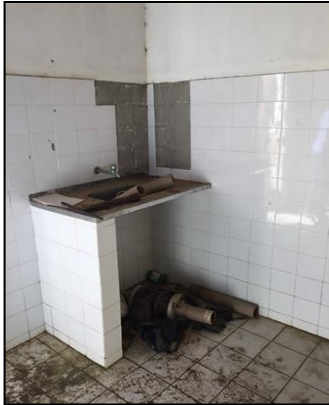
Figura 40– Casa de química desativada Fonte: Premier Engenharia, 2018.
