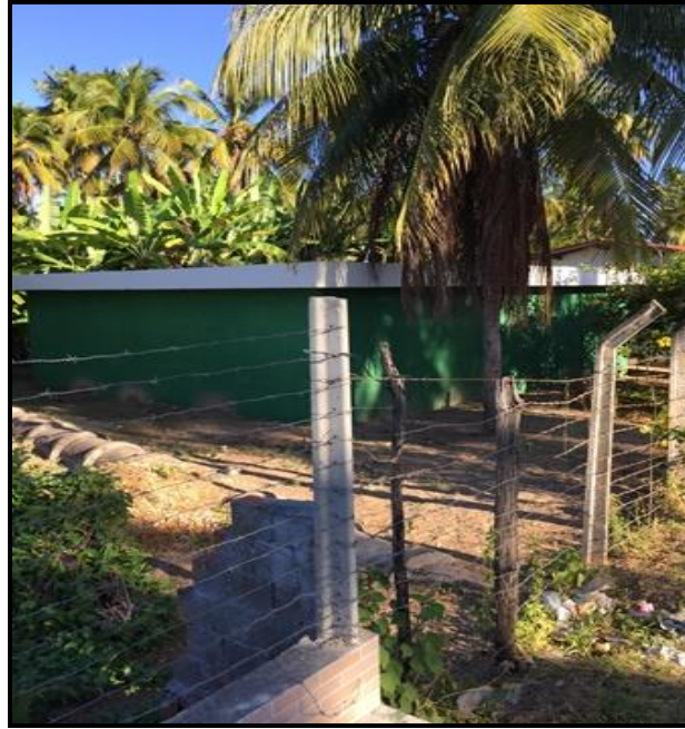
Figura 34– Reservatório apoiado – Pontal do Peba Fonte: Premier Engenharia, 2018.
