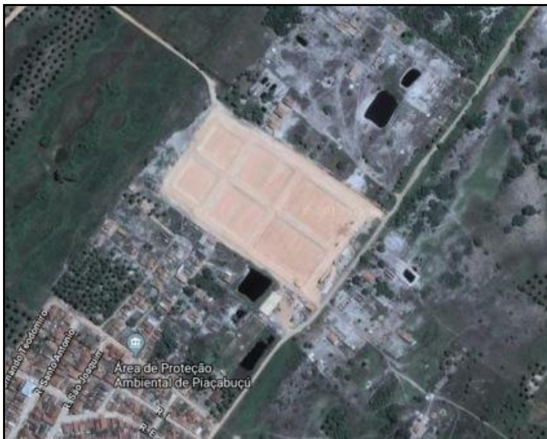
Figura 44– Estação de Tratamento de Esgoto - ETE Fonte – Google Maps, 2018.
