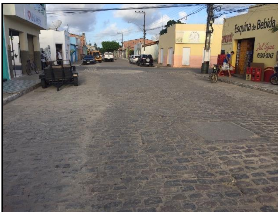
Figura 117 – Avenida Mestre Francelino (trecho sujeito a alagamento) Fonte: Premier Engenharia, 2018.
