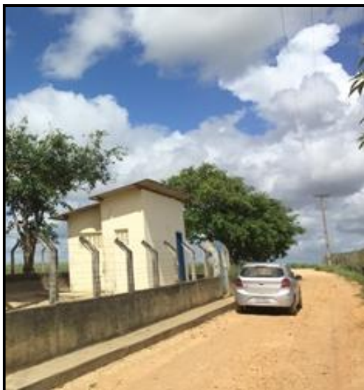
Figura 111 - Casa de Química – Pov. Carapina Fonte: Premier Engenharia, 2018.
