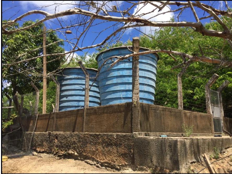
Figura 127 - Reservatórios – Pov. Pesçoço Fonte: Premier Engenharia, 2018.
