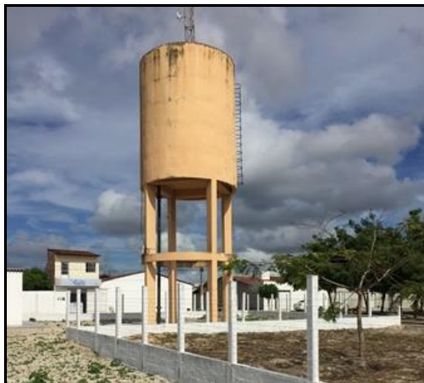
Figura 54 – Reservatório – Conj. Hab. Mata Atlântica I Fonte: Premier Engenharia, 2018.
