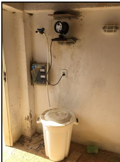
Figura 78 - Casa de Química – Conj Hab. Santo Expedito Fonte: Premier Engenharia, 2018.
