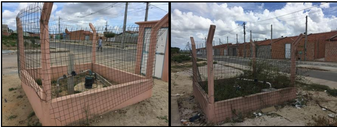
Figura 71 – Poços do Conj. Hab. São Francisco Fonte: Premier Engenharia, 2018.
