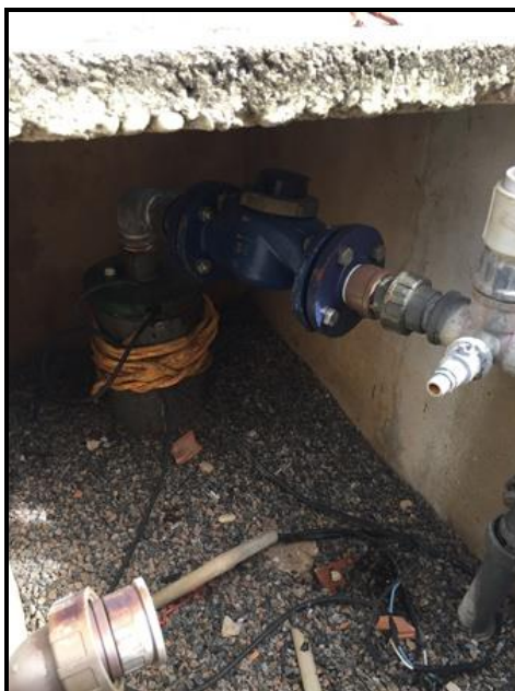
Figura 80 – Poço - Povoado Cooperativa Núcleo I Fonte: Premier Engenharia, 2018.
