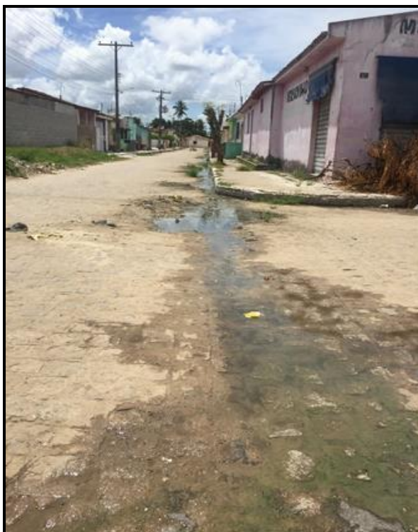
Figura 160 – Lançamento do esgoto a céu aberto Fonte: Premier Engenharia, 2018.
