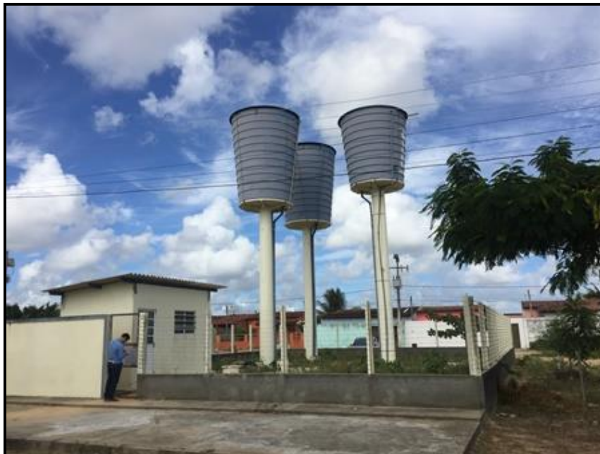
Figura 67 - Reservatórios – Conj. Hab. Marisa Letícia Fonte: Premier Engenharia, 2018.
