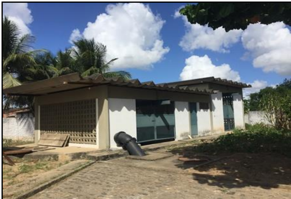
Figura 152 – EEE Final Fonte: Premier Engenharia, 2018.
