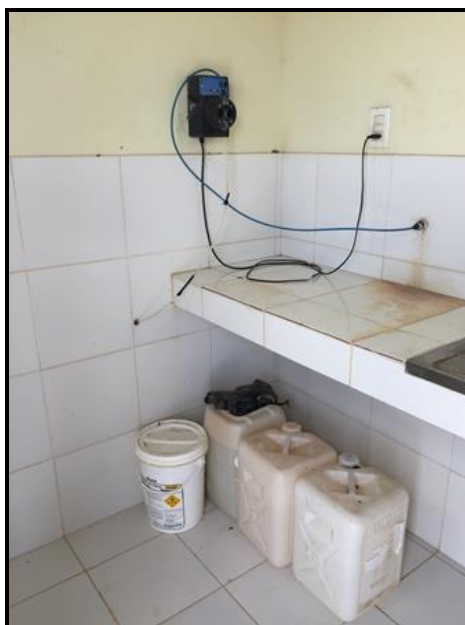
Figura 129 - Casa de Química – Pov Imbira Fonte: Premier Engenharia, 2018.
