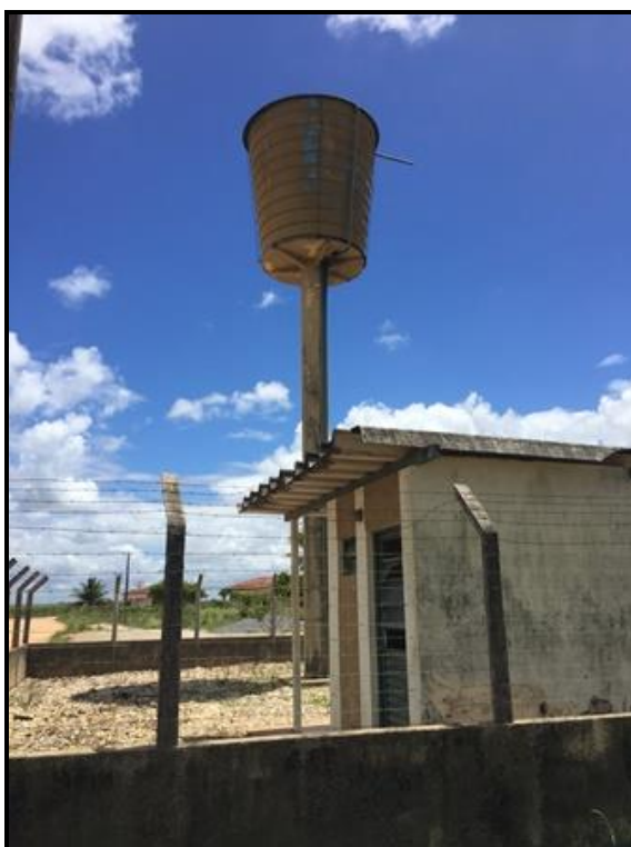
Figura 113- Reservatório – Povoado Prosperidade Fonte: Premier Engenharia, 2018.
