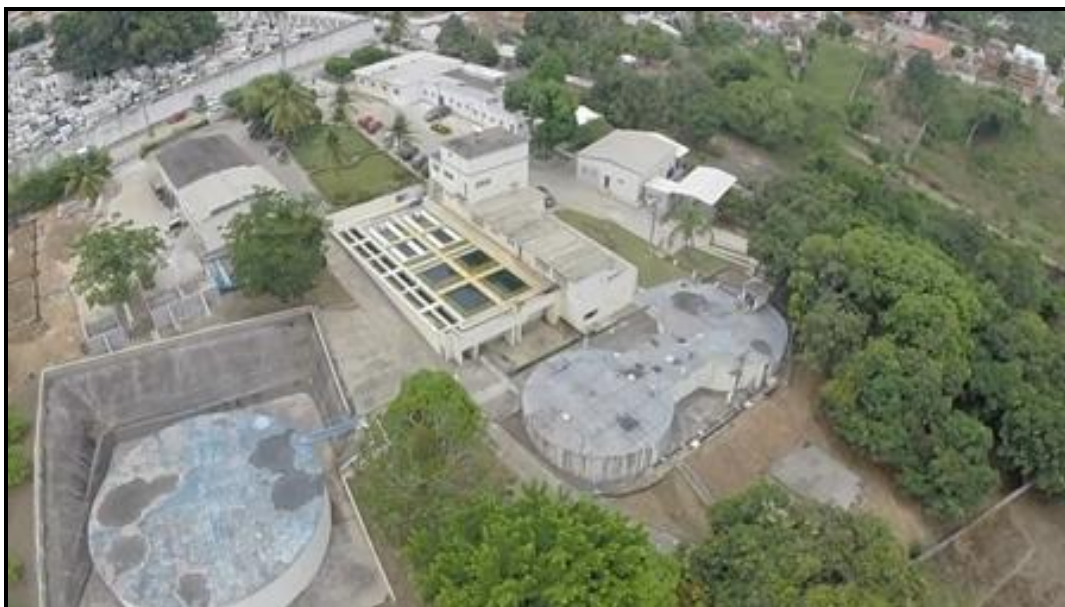
Figura 37 – Vista aérea da ETA Fonte: Premier Engenharia, 2018.
