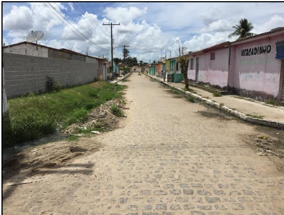
Figura 224 – Bairro Leitoral – ponto mais baixo da rua Fonte: Premier Engenharia, 2018.
