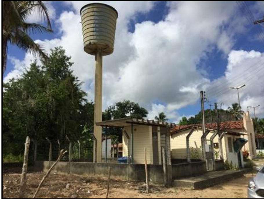
Figura 118 - Reservatório – Pov. Manimbu Fonte: Premier Engenharia, 2018.
