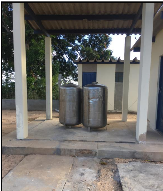
Figura 90 - ETA Compacta – Pov. Tabuleiro dos Negros Fonte: Premier Engenharia, 2018.
