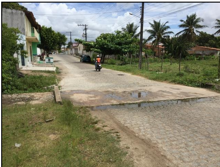
Figura 213 – Rua Jatobá – ponto de alagamento 2 (região afetada) Fonte: Premier Engenharia, 2018.
