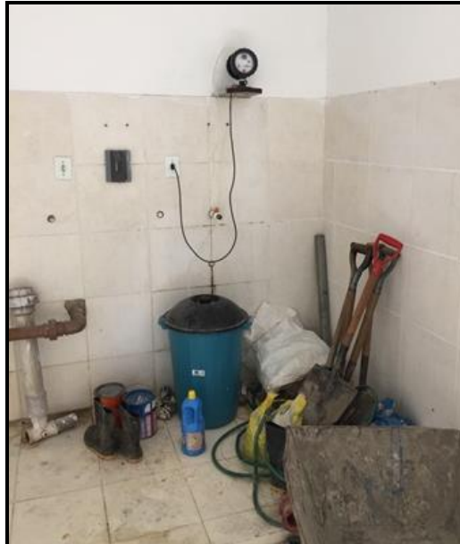
Figura 53 – Casa de Química – Conj. Hab. Mata Atlântica I Fonte: Premier Engenharia, 2018.
