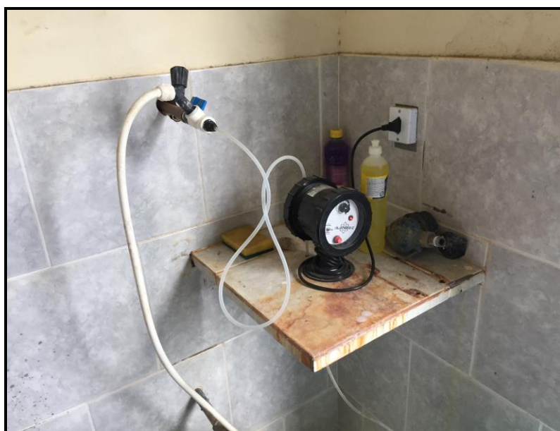
Figura 102- Casa de Química – Pov. Murici Fonte: Premier Engenharia, 2018.
