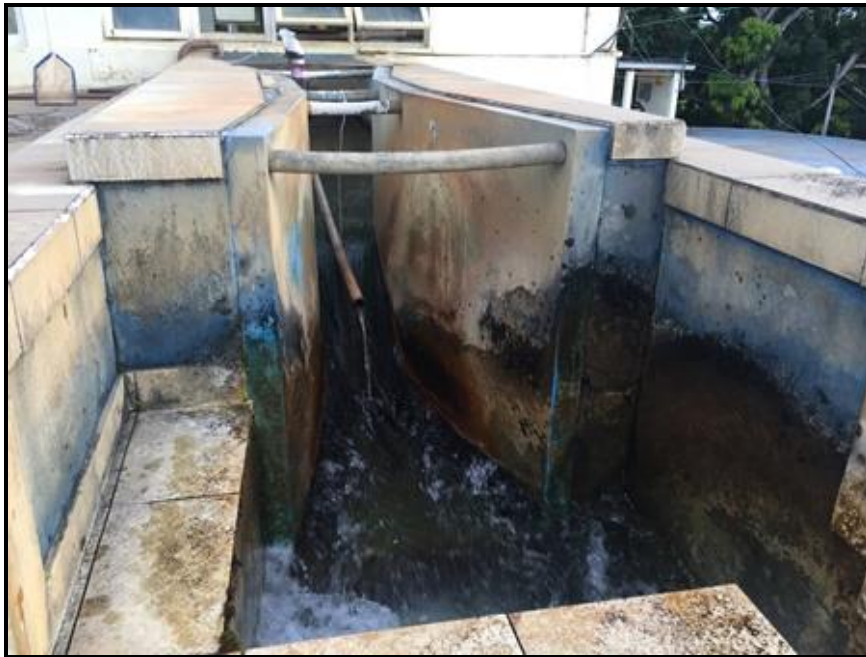
Figura 40 – Adição de Sulfato de Alumínio Fonte: Premier Engenharia, 2018.
