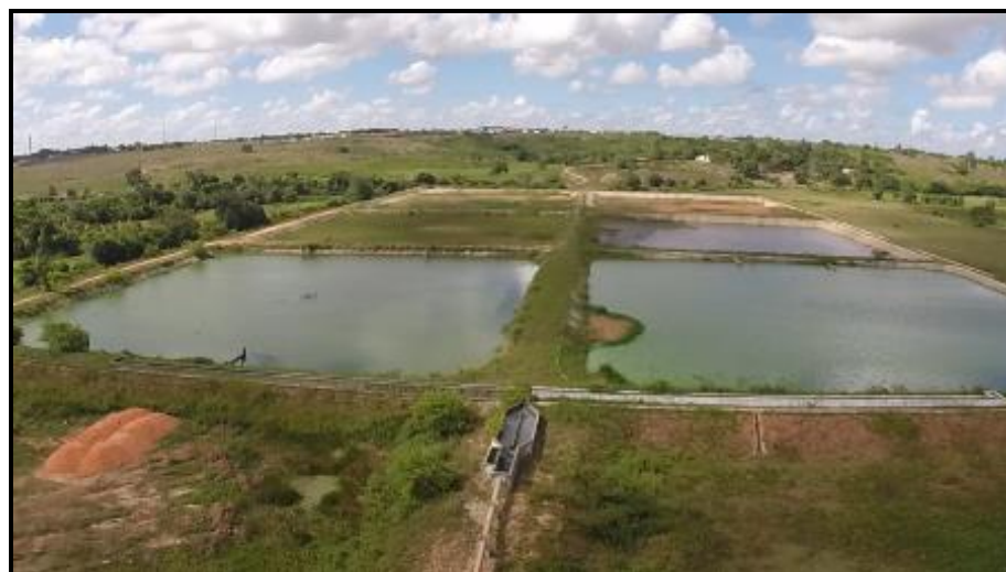
Figura 158 – Estação de Tratamento de Esgoto - ETE Fonte: Premier Engenharia, 2018.
