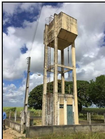
Figura 115 - Casa de Química e Reservatório – Pov. Campo Grande Fonte: Premier Engenharia, 2018.
