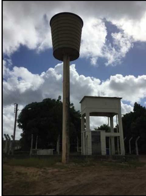
Figura 82 - Reservatório – Pov. Cooperativa Núcleo I Fonte: Premier Engenharia, 2018.
