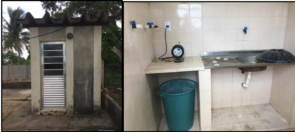
Figura 85 - Casa de Química – Pov. Cerquinha das Laranjas Fonte: Premier Engenharia, 2018.
