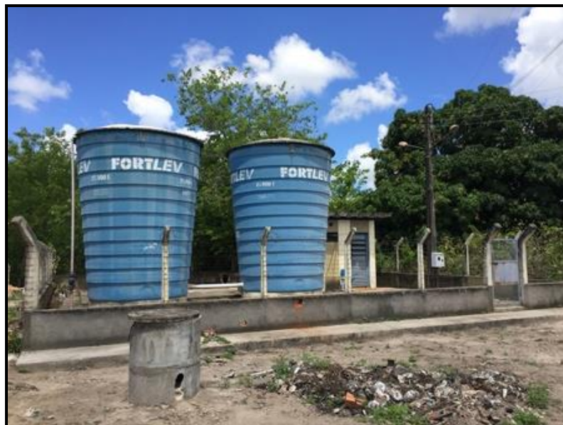
Figura 121 - Reservatórios – Pov. Palmeira Alta Fonte: Premier Engenharia, 2018.
