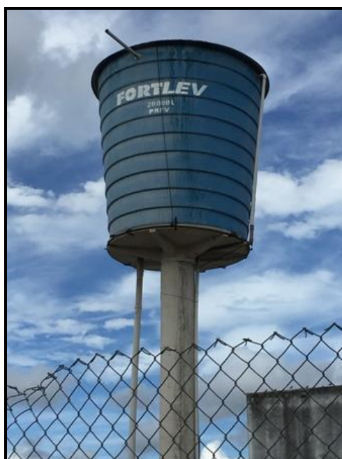
Figura 70 - Reservatório – Conj. Hab. Vale do Marituba Fonte: Premier Engenharia, 2018.
