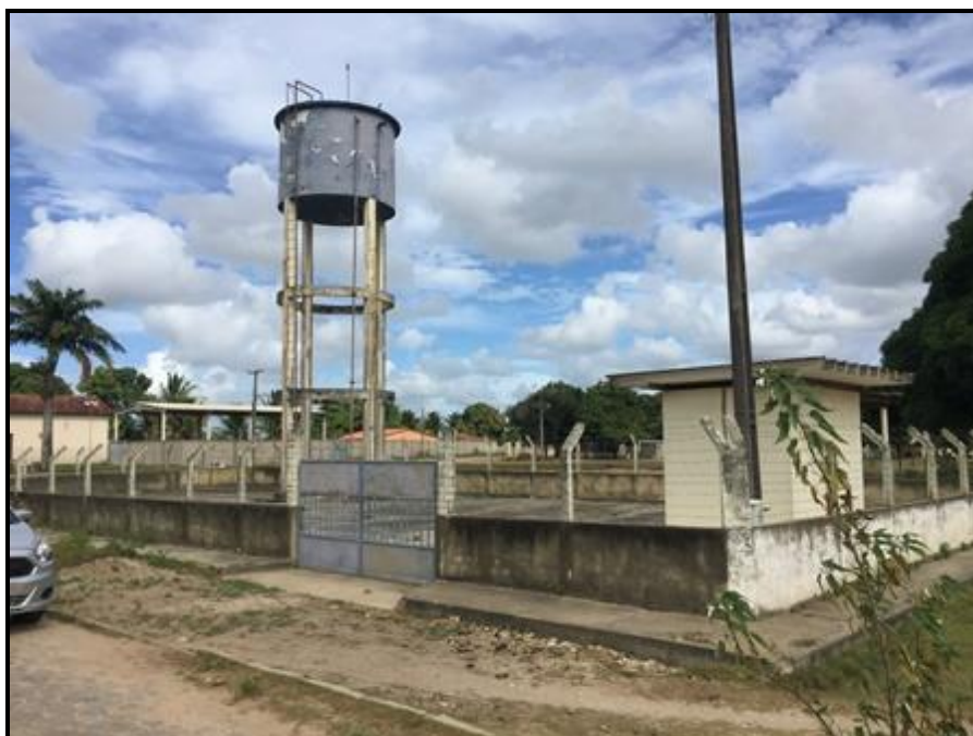
Figura 89 - Reservatório – Pov. Cooperativa Núcleo II Fonte: Premier Engenharia, 2018.
