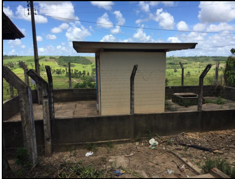
Figura 126 - Casa de Química – Pov. Pescoço Fonte: Premier Engenharia, 2018.
