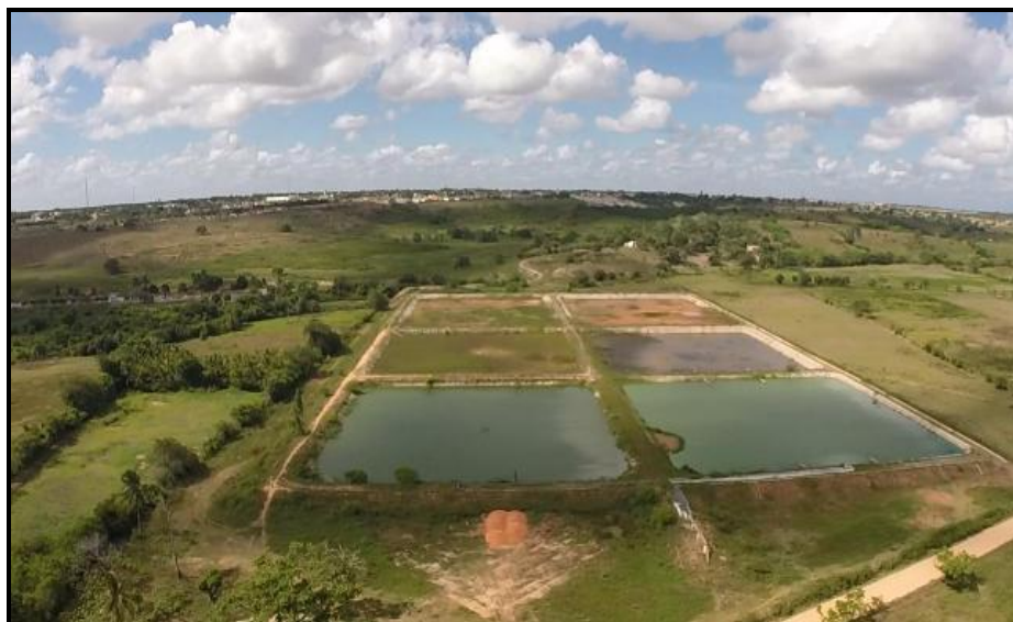
Figura 157 – Estação de Tratamento de Esgoto - ETE Fonte: Premier Engenharia, 2018.
