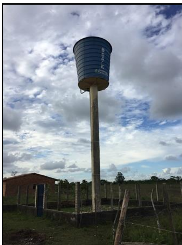
Figura 144- Reservatório – Povoado Sítio Nazário Fonte: Premier Engenharia, 2018.
