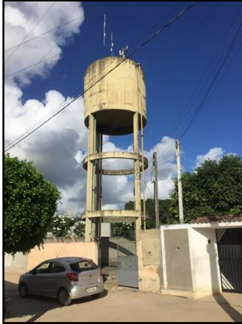
Figura 100 - Reservatório – Pov. Campo Redondo Fonte: Premier Engenharia, 2018.
