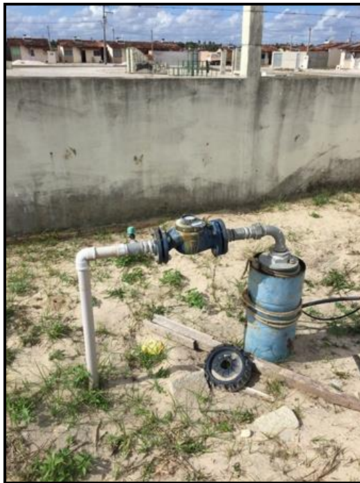
Figura 62 - Poços Conj. Hab. Velho Chico II Fonte: Premier Engenharia, 2018.
