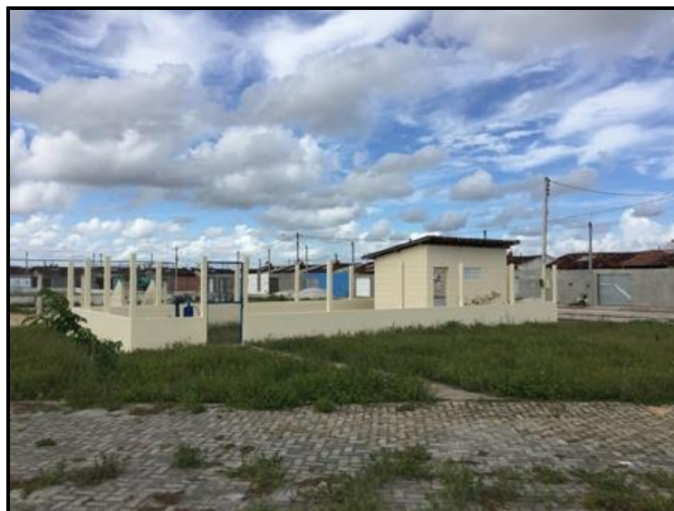
Figura 58 – Sistema – Conj. Hab. Velho Chico I Fonte: Premier Engenharia, 2018.
