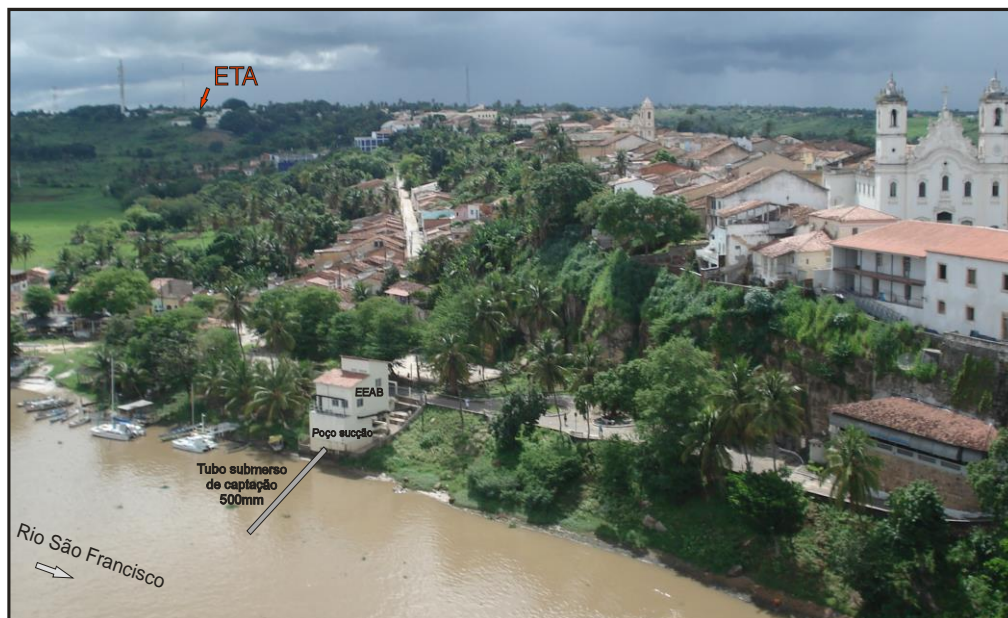
Figura 31 – Foto Aérea da Captação Fonte: Intersan Projetos de Engenharia, 2013.
