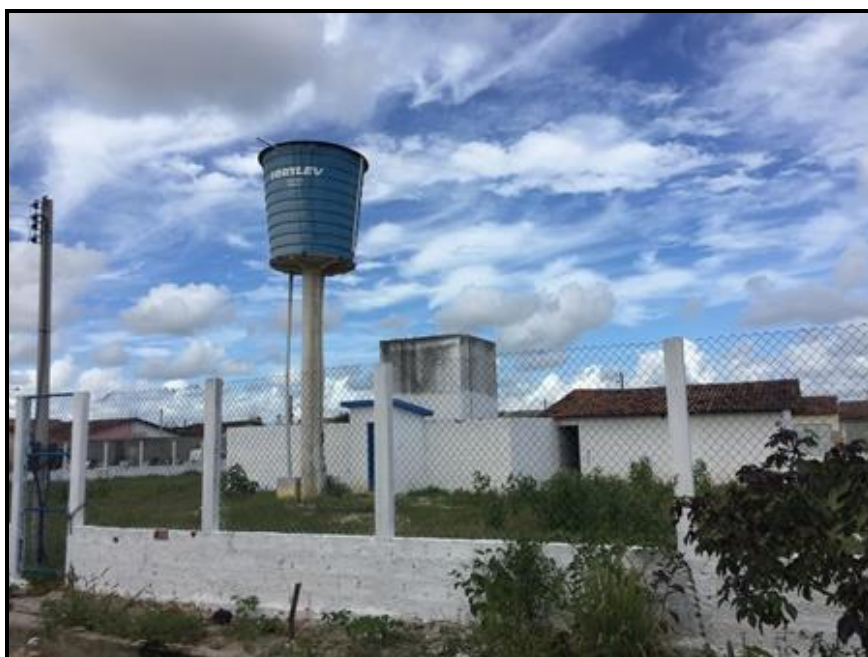
Figura 68 – Local onde está instalado o poço – Conj. Hab. Vale do Marituba Fonte: Premier Engenharia, 2018.
