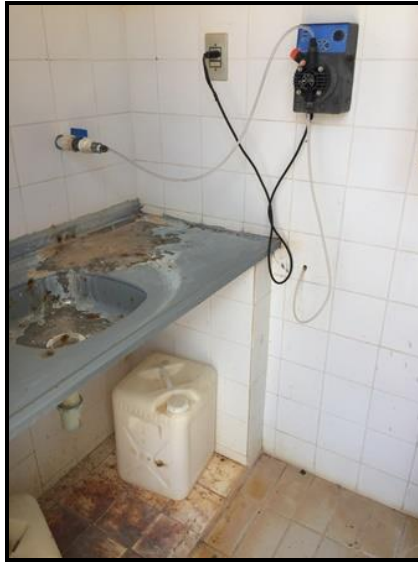
Figura 123 - Casa de Química – Pov. Castanho Grande Fonte: Premier Engenharia, 2018.
