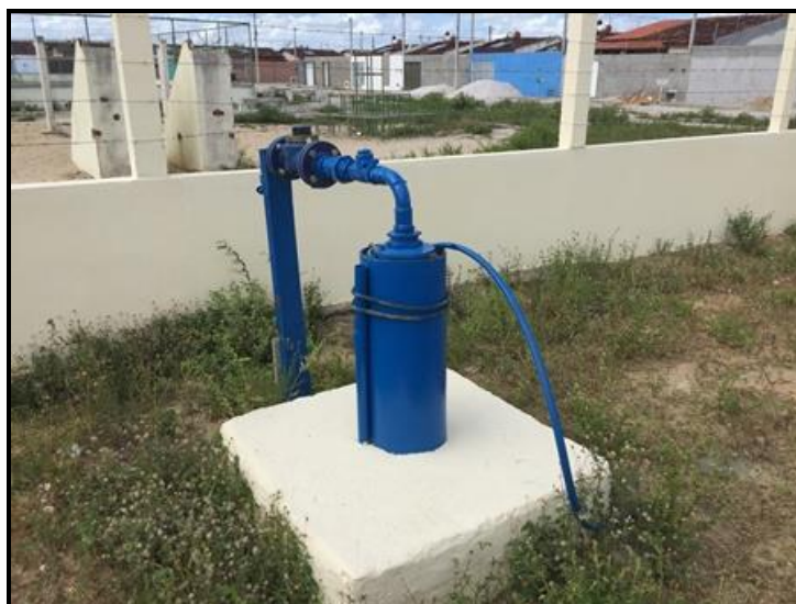
Figura 59 – Poços Conj. Hab. Velho Chico I Fonte: Premier Engenharia, 2018.
