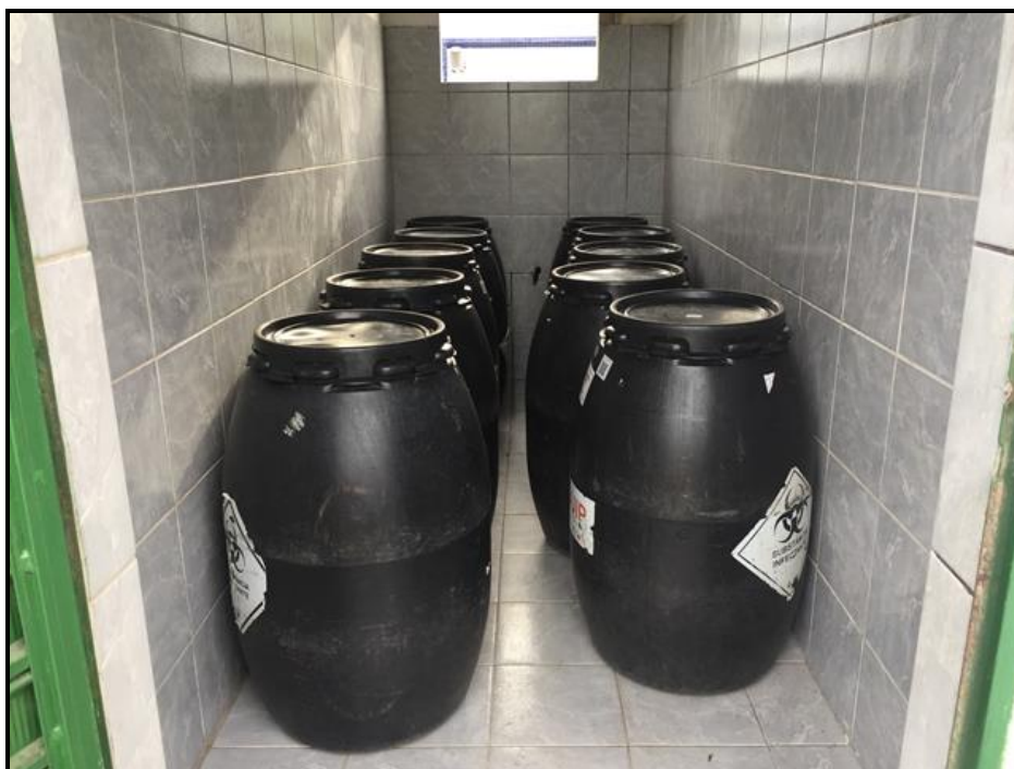
Figura 180 – Local de armazenamento da UPA de Penedo (vista interna) Fonte: Premier Engenharia, 2018.
