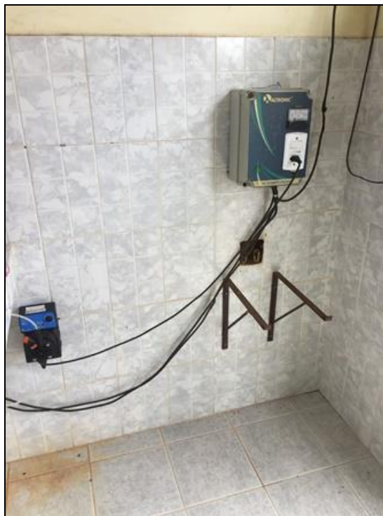
Figura 138 - Casa de Química – Pov. Espigão Fonte: Premier Engenharia, 2018.
