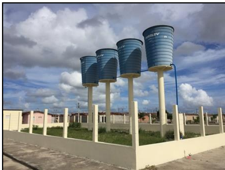
Figura 57 - Reservatórios – Conj. Hab. Mata Atlântica II Fonte: Premier Engenharia, 2018.
