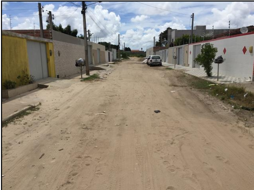
Figura 221 – Conj. Hab. Ouro Verde – ausência de rede de drenagem Fonte: Premier Engenharia, 2018.
