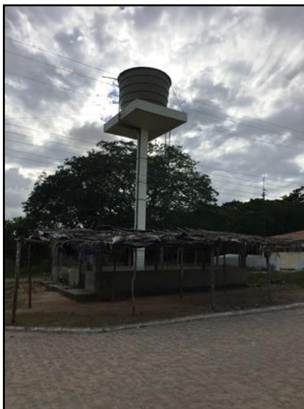
Figura 105- Reservatório – Povoado Capela Fonte: Premier Engenharia, 2018.
