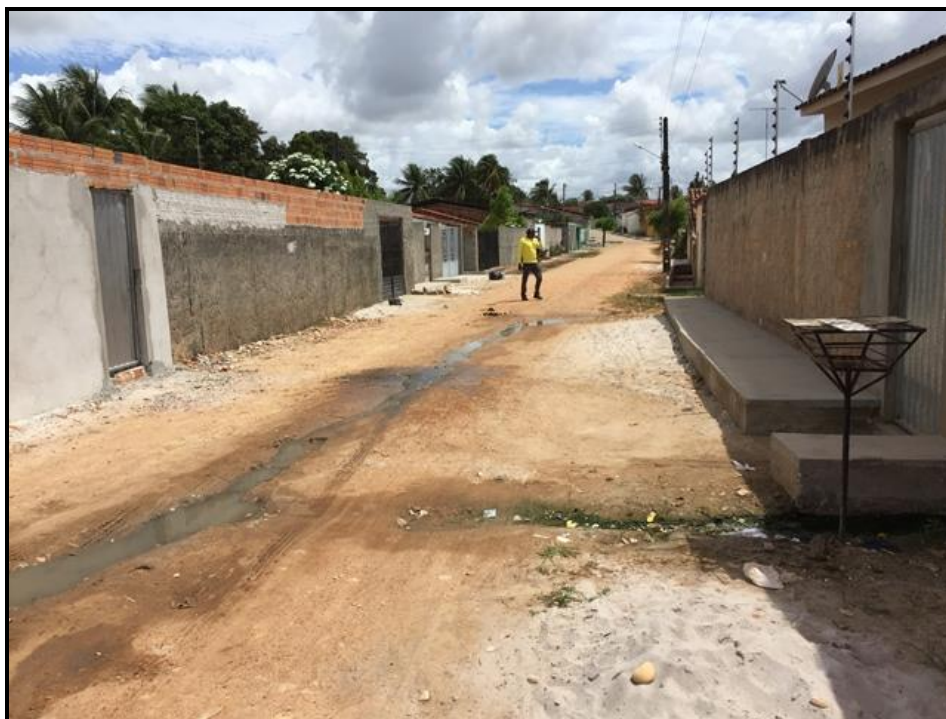
Figura 222 – Bairro Santa Isabel – rua sem rede de drenagem Fonte: Premier Engenharia, 2018.
