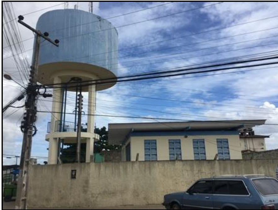
Figura 76 - Reservatórios – Conj. Hab. Rosseti Andrade Fonte: Premier Engenharia, 2018.
