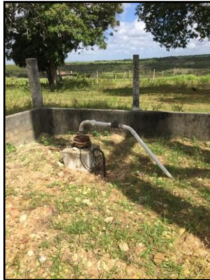
Figura 114 – Poço - Povoado Campo Grande Fonte: Premier Engenharia, 2018.
