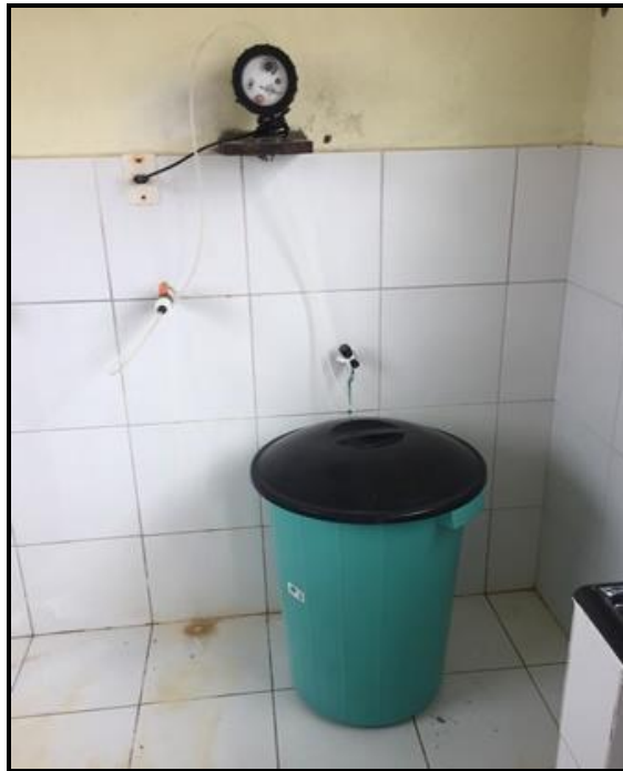
Figura 66 - Casa de Química – Conj Hab. Marisa Letícia Fonte: Premier Engenharia, 2018.
