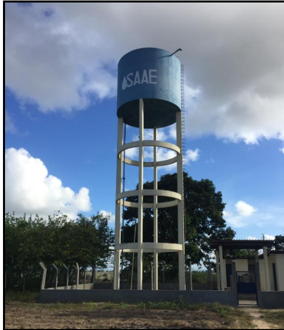
Figura 91 - Reservatório – Pov. Tabuleiro dos Negros Fonte: Premier Engenharia, 2018.
