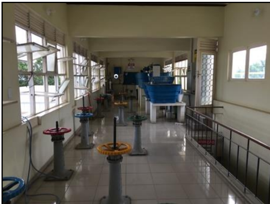
Figura 45 - Registro de Manobra de Lavagem dos Filtro e Dosadores de produtos químicos
