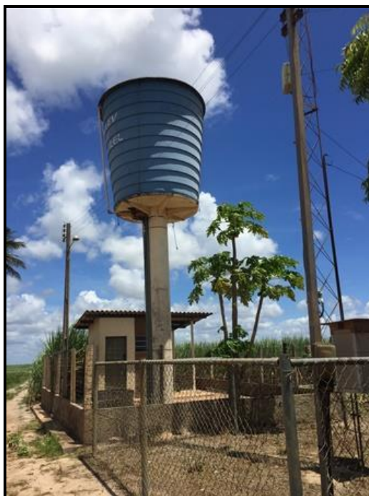
Figura 135 - Casa de Química e Reservatório – Pov. Conrado II Fonte: Premier Engenharia, 2018.
