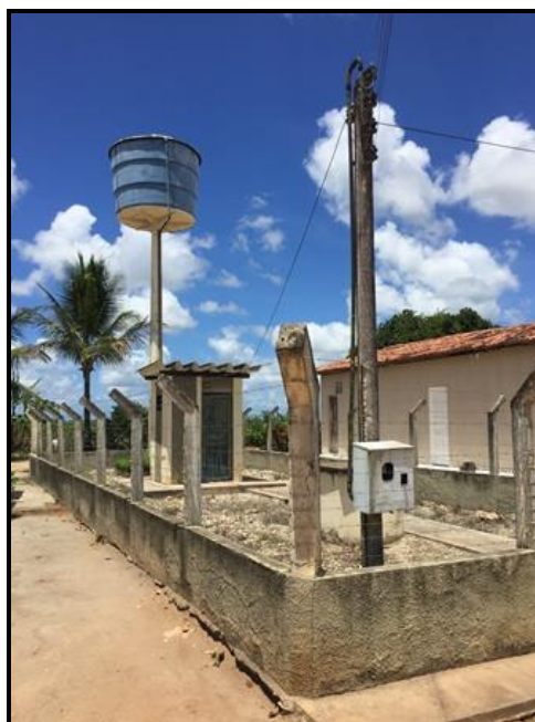
Figura 124 - Reservatório – Pov. Castanho Grande Fonte: Premier Engenharia, 2018.
