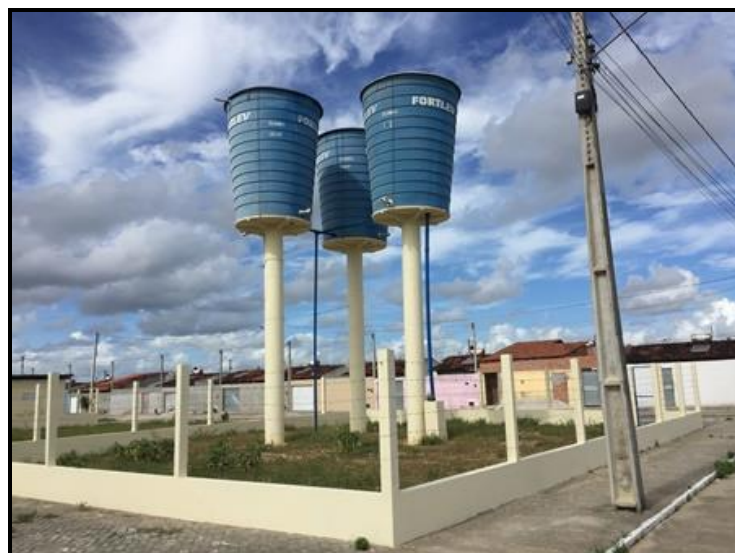
Figura 61 - Reservatórios – Conj. Hab. Velho Chico I Fonte: Premier Engenharia, 2018.
