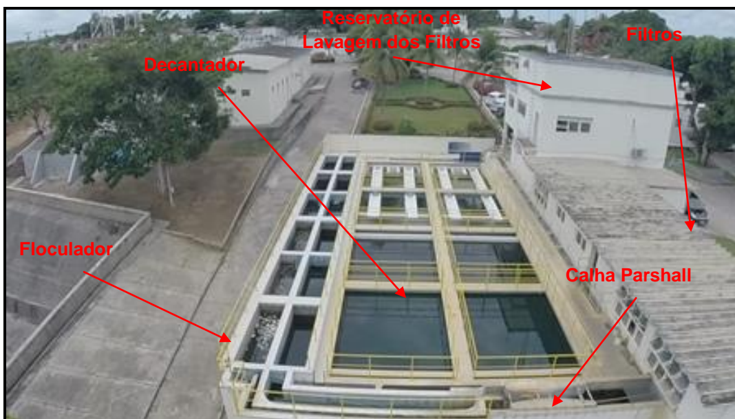
Figura 38 – Unidades de Tratamento que compõem a ETA Fonte: Premier Engenharia, 2018.
