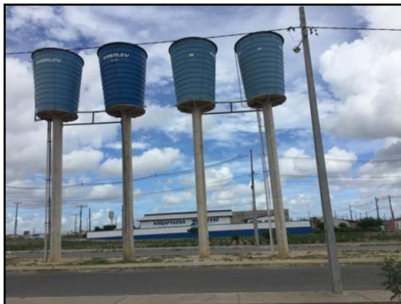
Figura 72 - Reservatórios – Conj. Hab. São Francisco Fonte: Premier Engenharia, 2018.
