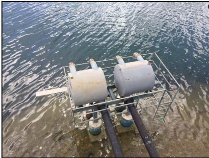
Figura 33 – Dispositivo para captar água diretamente no leito do rio Fonte: Premier Engenharia, 2018.
