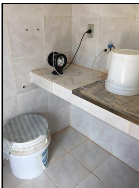
Figura 132 - Casa de Química – Pov. Conrado I Fonte: Premier Engenharia, 2018.
