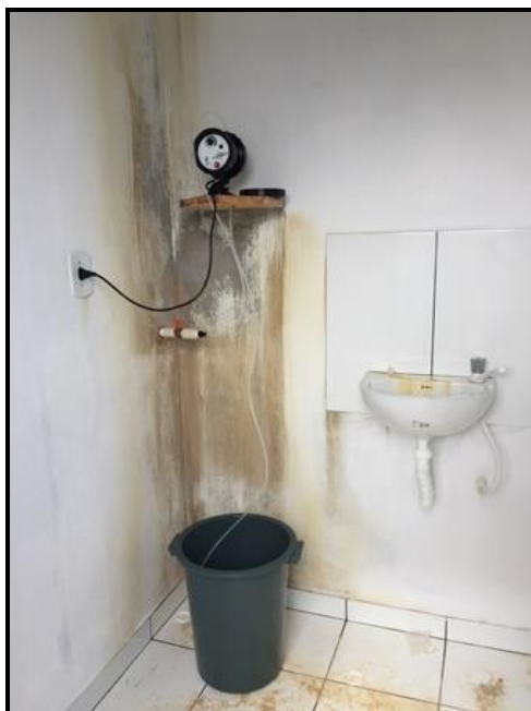
Figura 69 - Casa de Química – Conj Hab. Vale do Marituba Fonte: Premier Engenharia, 2018.
