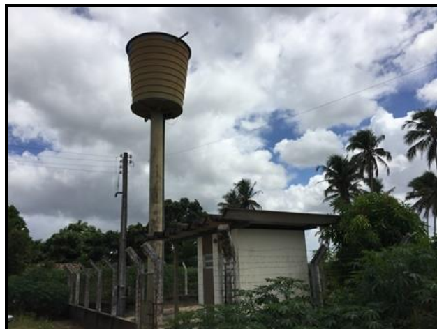
Figura 137 - Casa de Química e Reservatório – Pov. Santa Margarida Fonte: Premier Engenharia, 2018.
