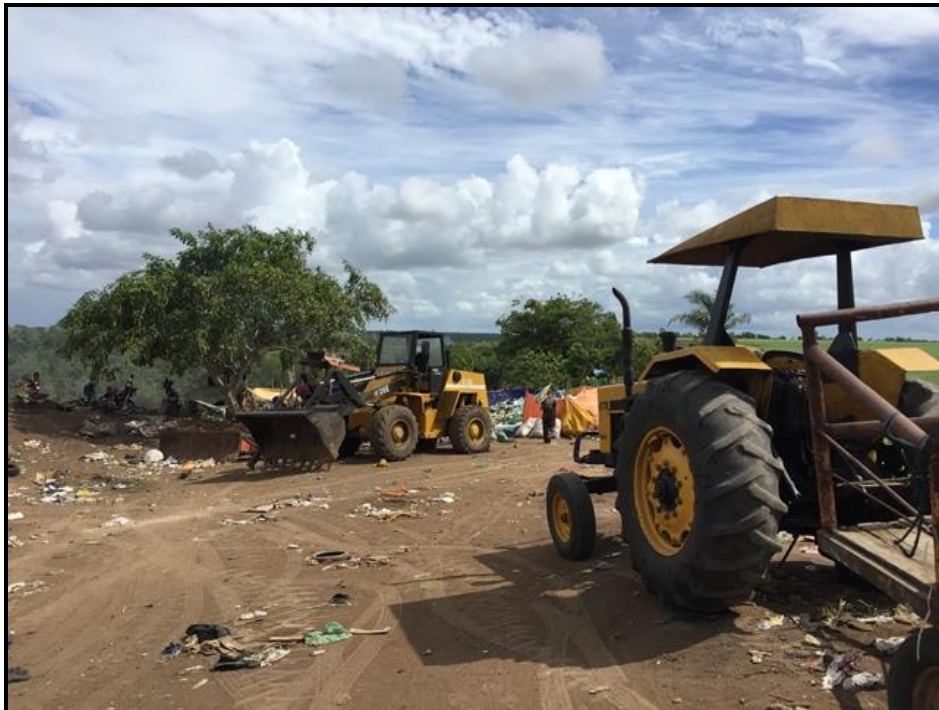
Figura 204 – Lixão em Penedo (maquinários) Fonte: Premier Engenharia, 2018.
