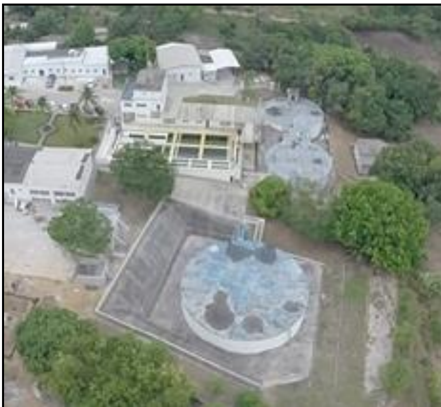
Figura 47 – Vista aérea dos Reservatórios Fonte: Premier Engenharia, 2018.
