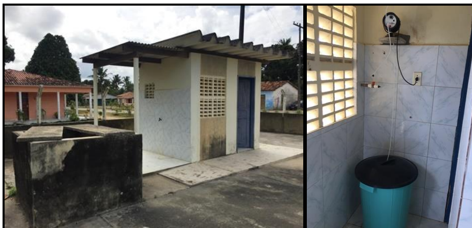
Figura 88 - Casa de Química – Pov. Cooperativa Núcleo II Fonte: Premier Engenharia, 2018.
