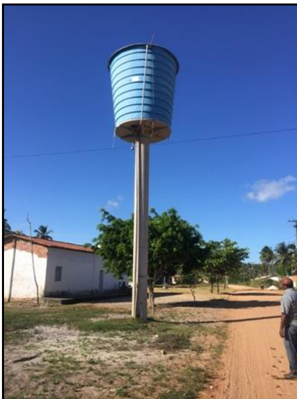
Figura 62 – Reservatório – Povoado Campinas Fonte: Premier Engenharia, 2018.
