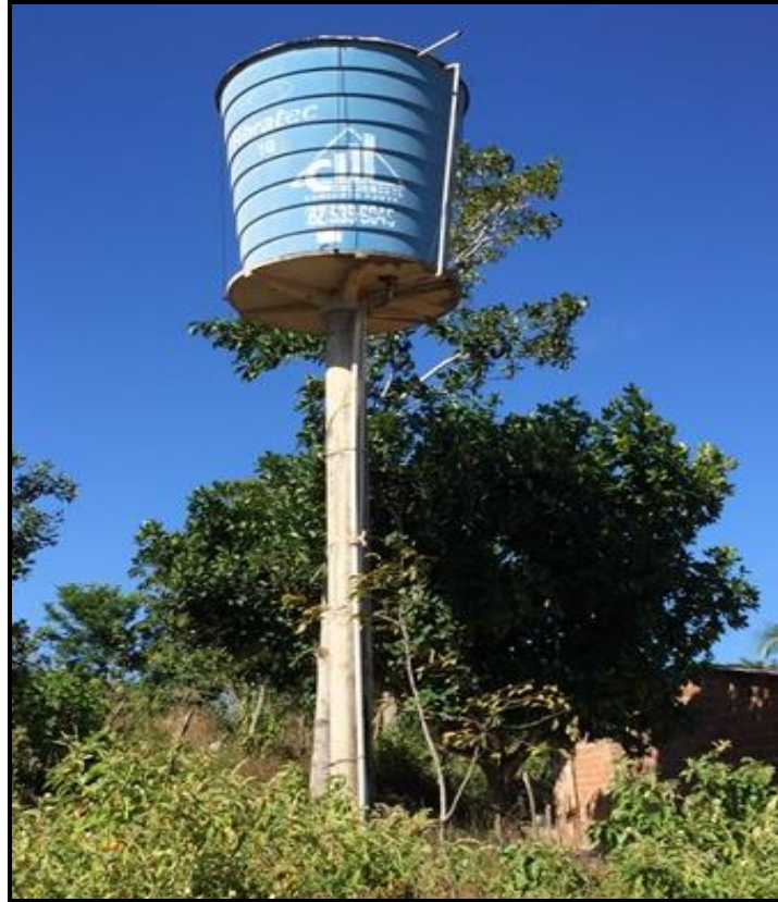
Figura 51 – Reservatório Elevado – Povoado Santana Fonte: Premier Engenharia, 2018.
