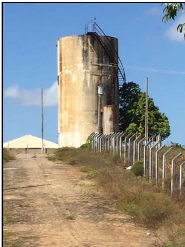
Figura 38 – Tratamento – Sistema 2 – Ponta do Mangues Fonte: Premier Engenharia, 2018.
