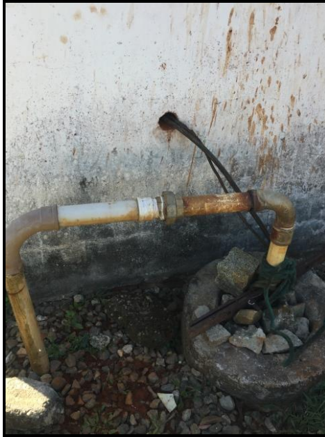
Figura 59 – Poço – Povoado Fazenda Nova Fonte: Premier Engenharia, 2018.
