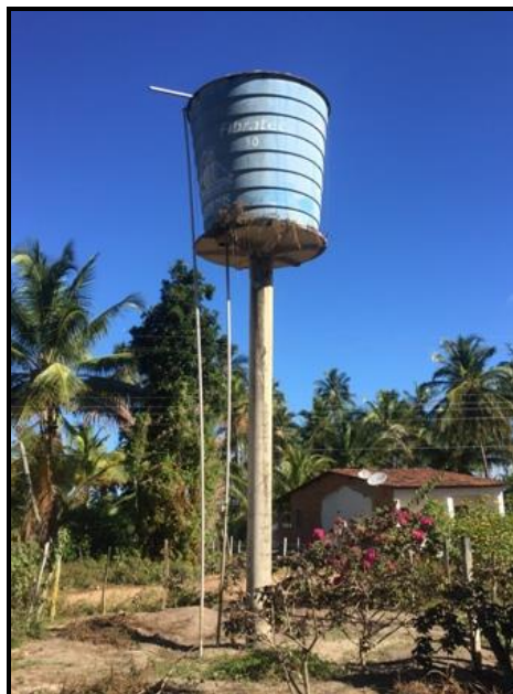
Figura 57 – Reservatório 1 – Povoado Geme Fonte: Premier Engenharia, 2018.
