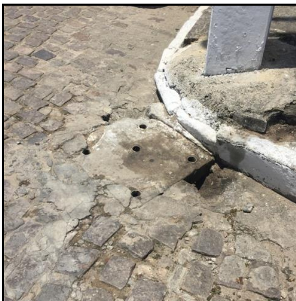
Figura 76 – Poço de visita localizado na Rua Antônio Travassos Fonte – Premier Engenharia, 2018.
