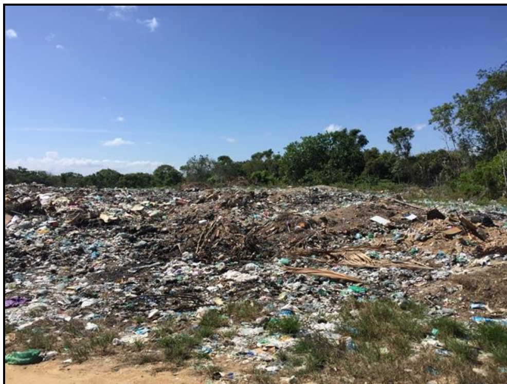
Figura 116 – Lixão em Pacatuba Fonte: Premier Engenharia, 2018.
