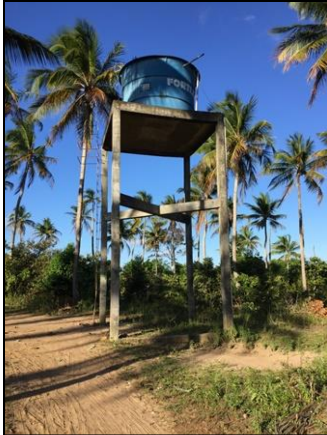
Figura 66 – Reservatório – Povoado Tabuleiro do Garcia Fonte: Premier Engenharia, 2018.
