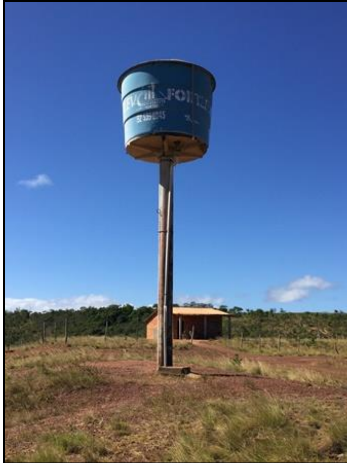
Figura 47 – Reservatório – Povoado Lagoa Grande Fonte: Premier Engenharia, 2018.
