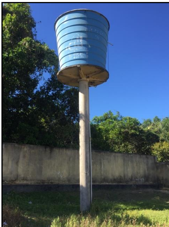
Figura 55 – Reservatório – Povoado Porto Santana Fonte: Premier Engenharia, 2018.
