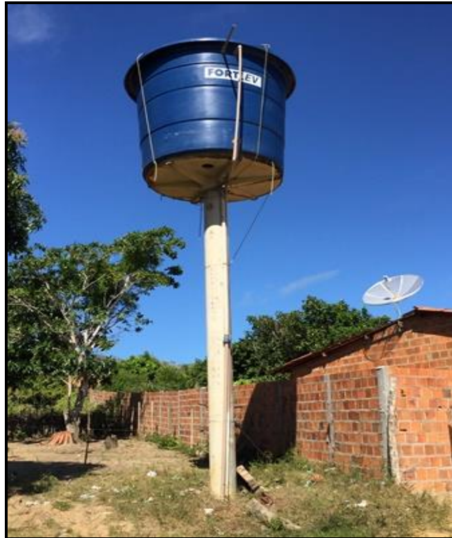
Figura 49 – Reservatório Elevado – Povoado Golfo Fonte: Premier Engenharia, 2018.
