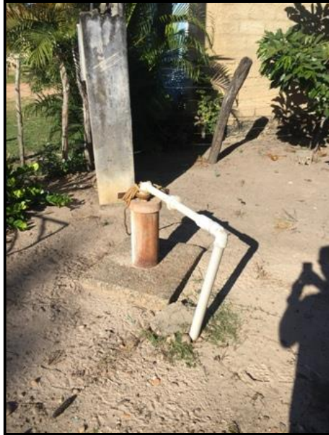
Figura 63 – Poço – Povoado Cobra D'água Fonte: Premier Engenharia, 2018.
