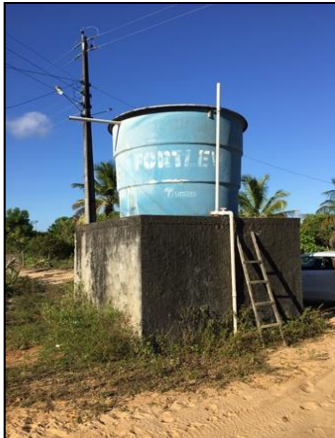
Figura 67 – Reservatório – Povoado Rancho Fonte: Premier Engenharia, 2018.
