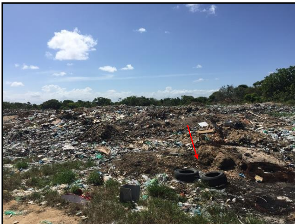
Figura 109 – Disposição de pneus na área do lixão municipal Fonte: Fonte: Premier Engenharia, 2018.
