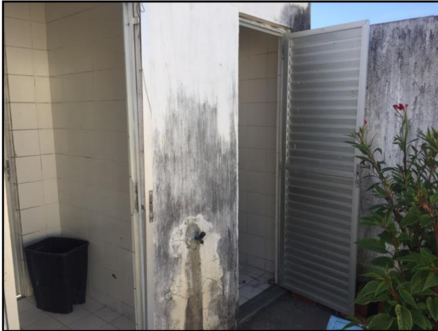
Figura 97 – Local de armazenamento da CSF do Centro (vista externa) Fonte: Premier Engenharia, 2018.
