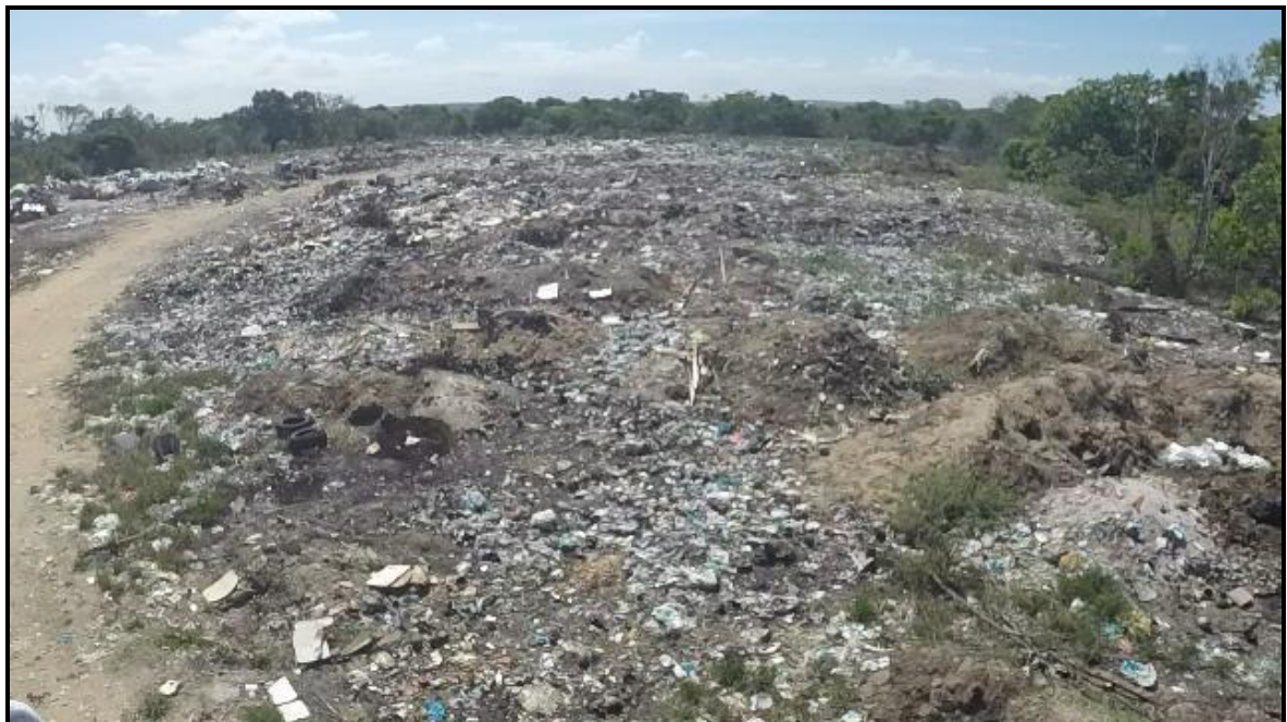
Figura 102 – Lixão de Pacatuba (vista aérea 1) Fonte: Premier Engenharia, 2018.
