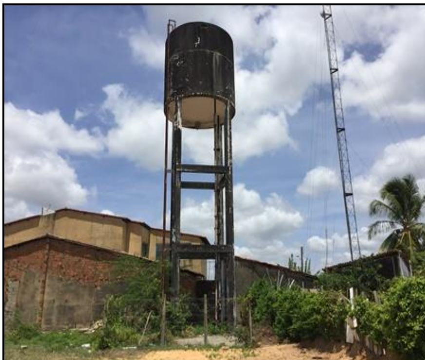
Figura 40 – Reservatório Elevado do Sistema 1 – Sede do município Fonte: Premier Engenharia, 2018.
