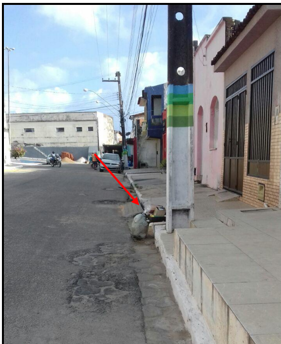
Figura 93 – Sacos de lixo armazenados na calçada e na sarjeta Fonte: Premier Engenharia, 2018.
