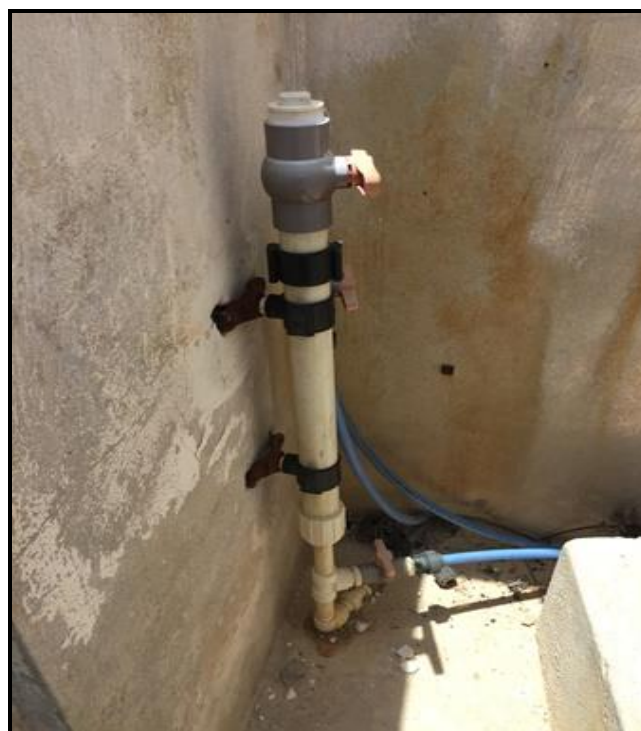
Figura 37 – Tratamento – Sistema 3 – Estiva do Raposo Fonte: Premier Engenharia, 2018.
