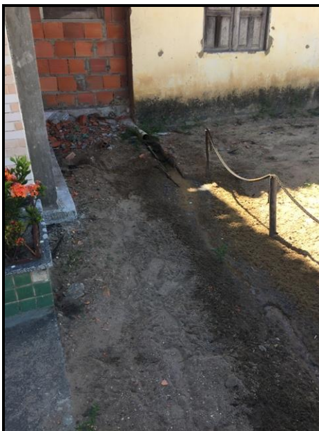
Figura 81 – Ponto de lançamento de esgoto a céu aberto localizado na Rod. José Machado Tojal Fonte – Premier Engenharia, 2018.
