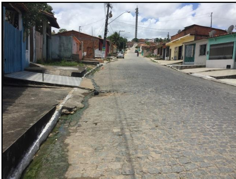
Figura 79 – Ponto de encontro do esgoto localizado na Rua João Batista de Melo
