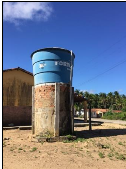
Figura 53 – Reservatório – Povoado Cruíri Fonte: Premier Engenharia, 2018.
