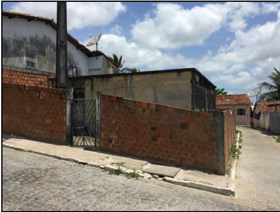
Figura 39 – Reservatório Apoiado do Sistema 1 – Sede do município Fonte: Premier Engenharia, 2018.
