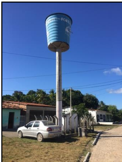
Figura 60 – Reservatório – Povoado Fazenda Nova Fonte: Premier Engenharia, 2018.
