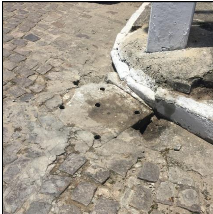
Figura 123 – Dispositivo de captação de água pluvial (modelo 2) Fonte: Premier Engenharia, 2018.
