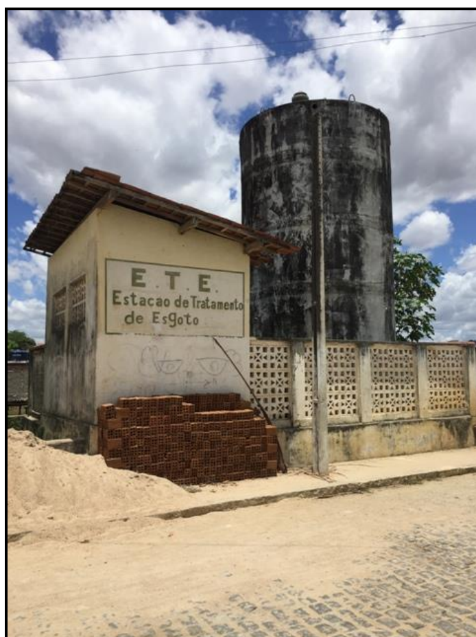
Figura 65 – Estação de Tratamento de Esgoto - ETE
