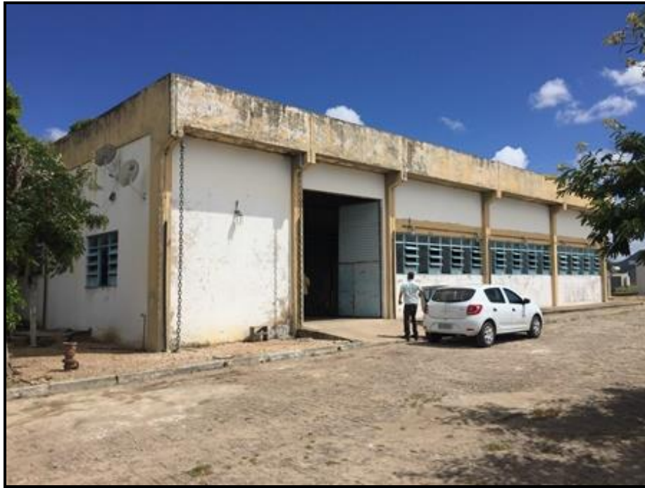
Figura 35 – Vista externa da ERAB-2 Fonte: Premier Engenharia, 2018
