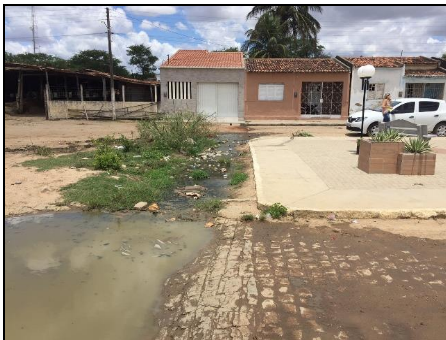
Figura 125 – Área Problema 4: inexistência de drenagem no local Fonte: Premier Engenharia, 2018.
