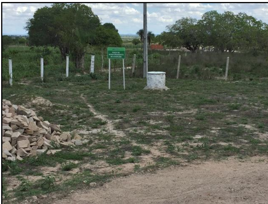
Figura 98 – Poços de monitoramento do chorume
