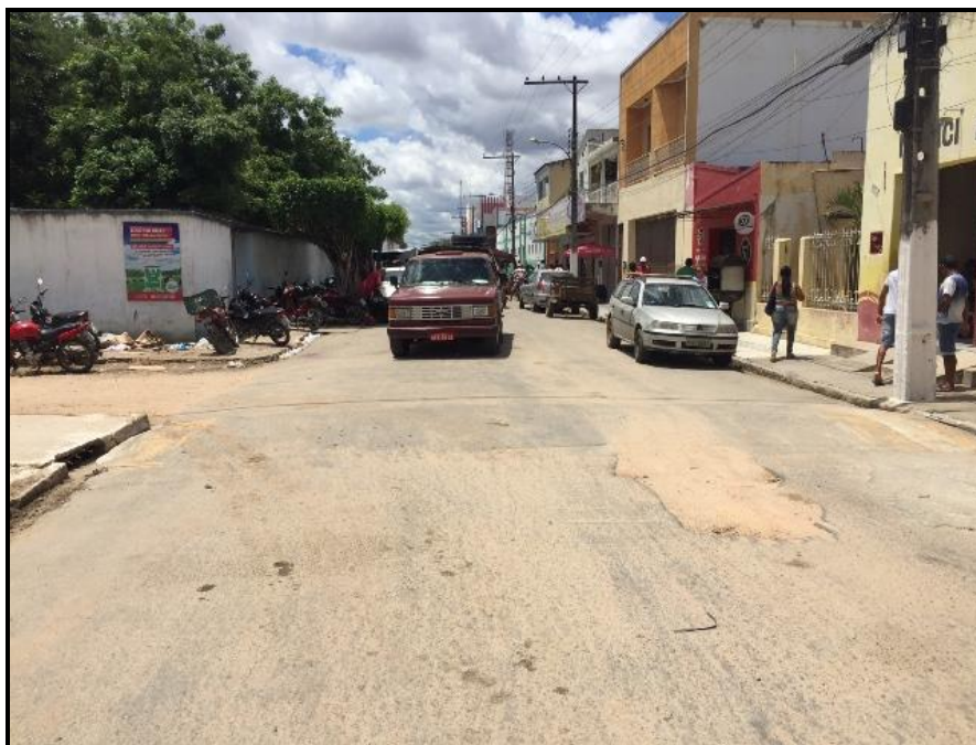
Figura 119 – Área Problema 1: rua afetada por alagamento Fonte: Premier Engenharia, 2018.
