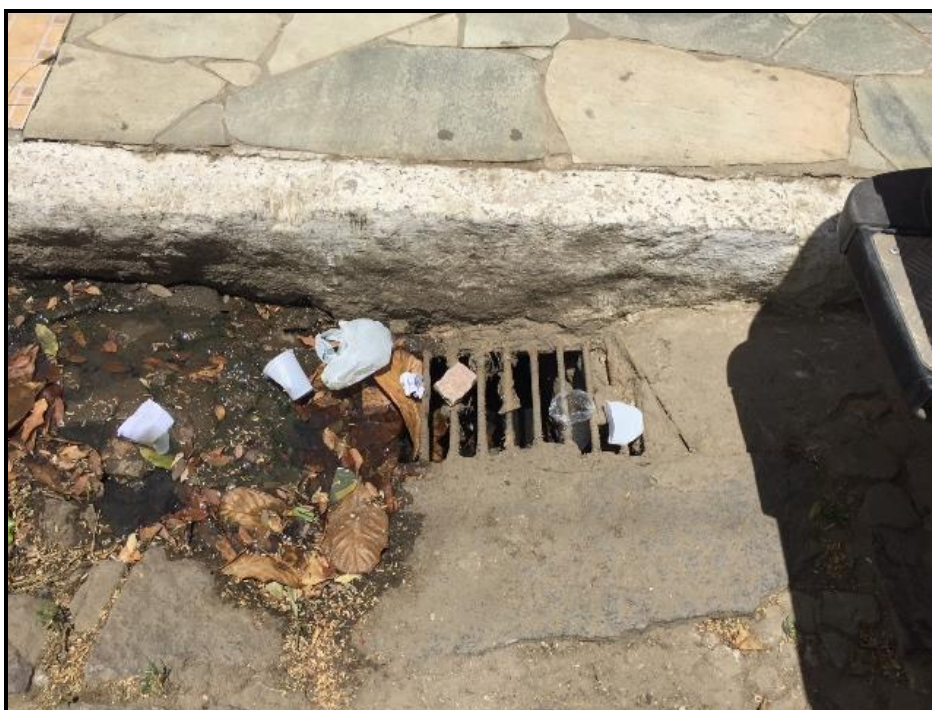
Figura 124 – Área Problema 3: presença de lixo envolta a boca-de-lobo Fonte: Premier Engenharia, 2018.
