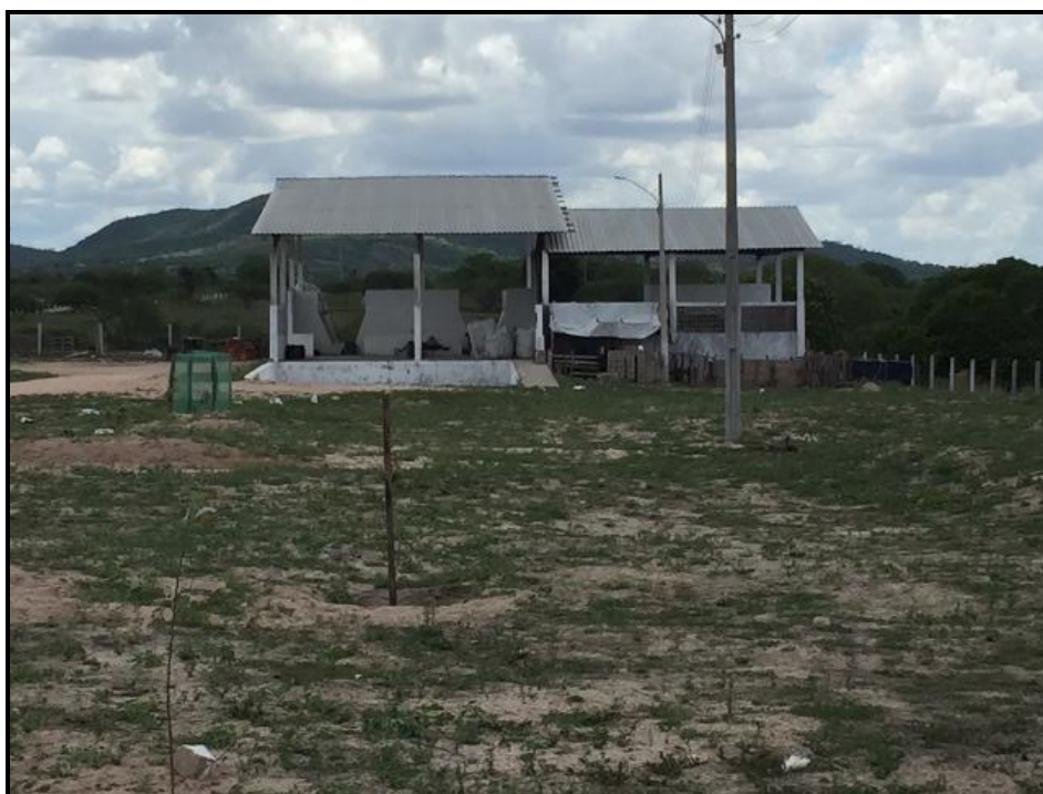
Figura 97 – Área de triagem para recicláveis Fonte: Premier Engenharia, 2018.
