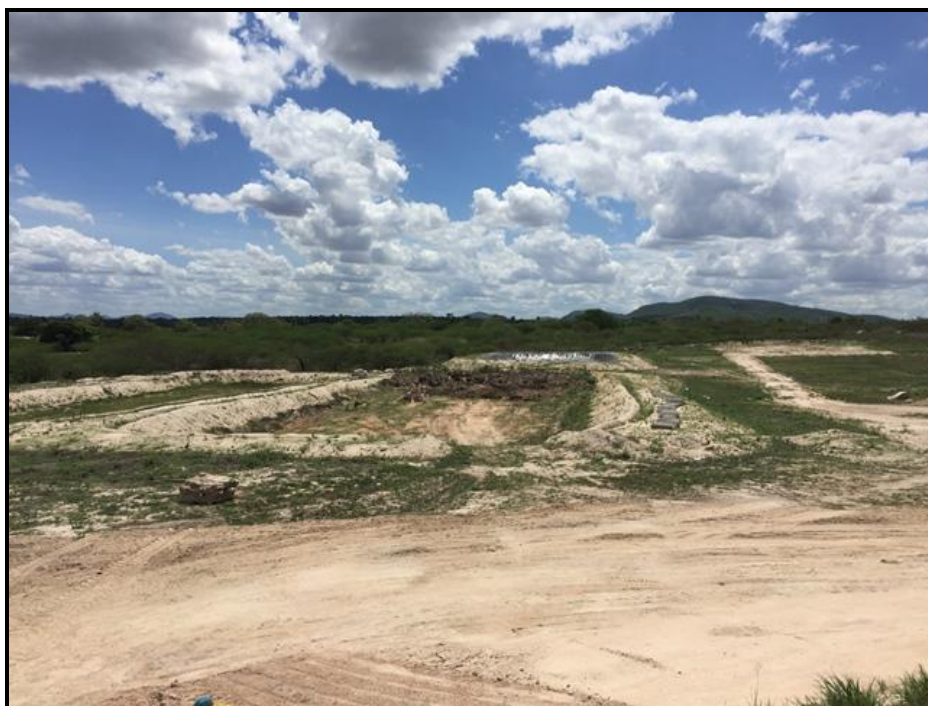
Figura 95 – Sistema de lagoas (tratamento do percolado) Fonte: Premier Engenharia, 2018.
