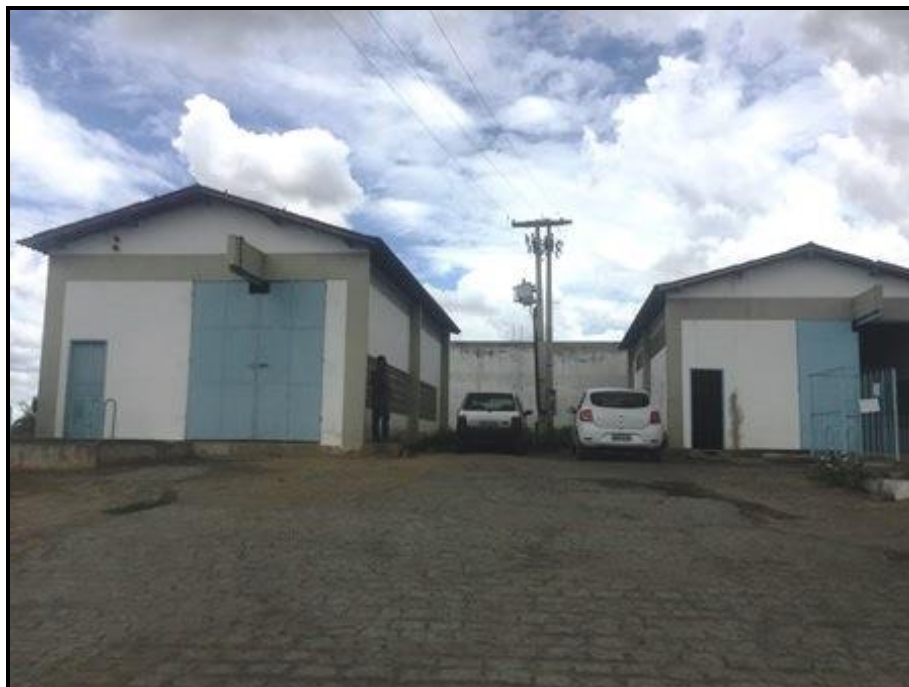
Figura 46 – Vista Frontal do R-03 e das ERAT-2 e 3 Fonte: Premier Engenharia, 2018
