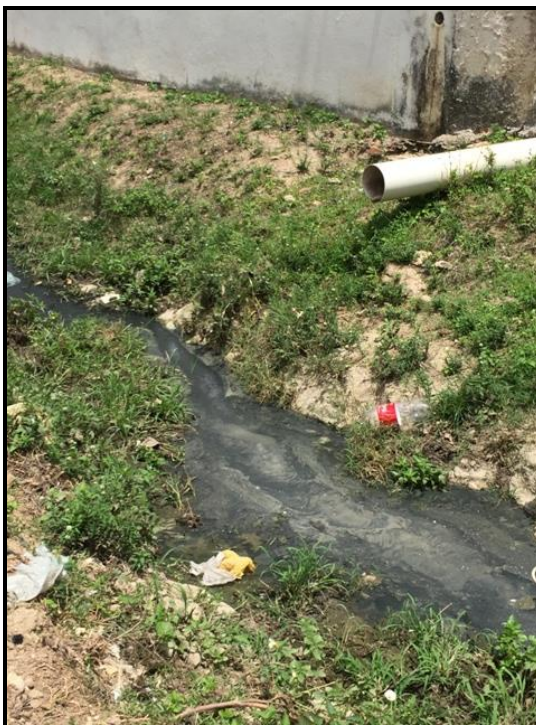
Figura 117 – Presença de lixo e despejo doméstico no trecho do córrego na Rua Olavo Mendes Fonte: Premier Engenharia, 2018.
