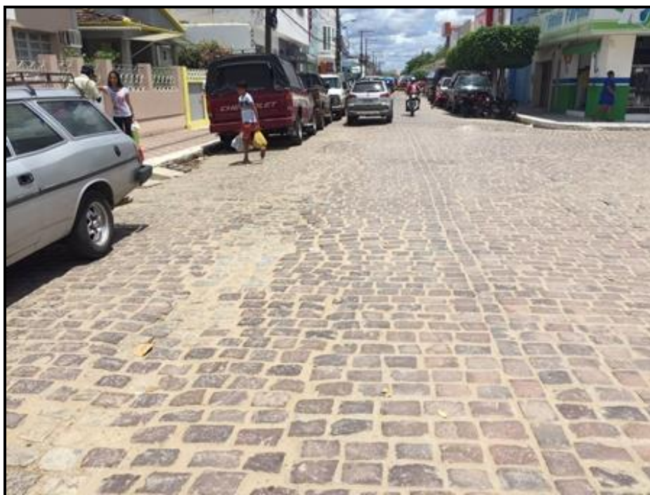
Figura 123 – Área Problema 3: rua afetada por alagamento Fonte: Premier Engenharia, 2018.
