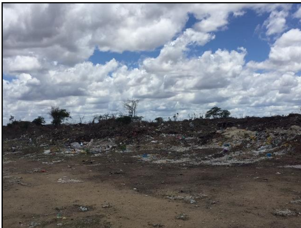
Figura 105 – Área de antigo lixão de Major Izidoro (vista parcial) Fonte: Premier Engenharia, 2018.
