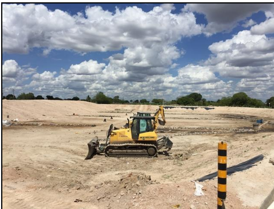
Figura 99 – Trator esteira para compactação dos resíduos
