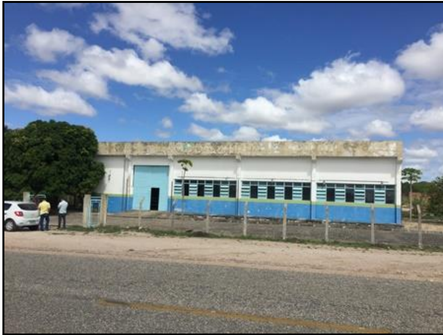
Figura 43 - Vista externa da ERAT-1 Fonte: Premier Engenharia, 2018
