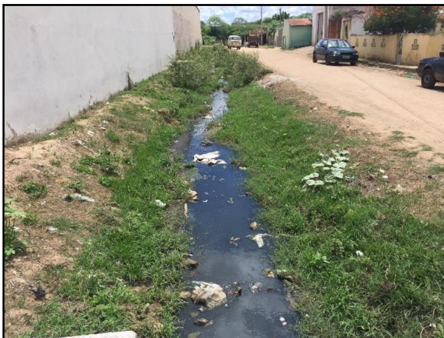
Figura 120 – Área Problema 1: ausência de limpeza nesse trecho do córrego Fonte: Premier Engenharia, 2018.
