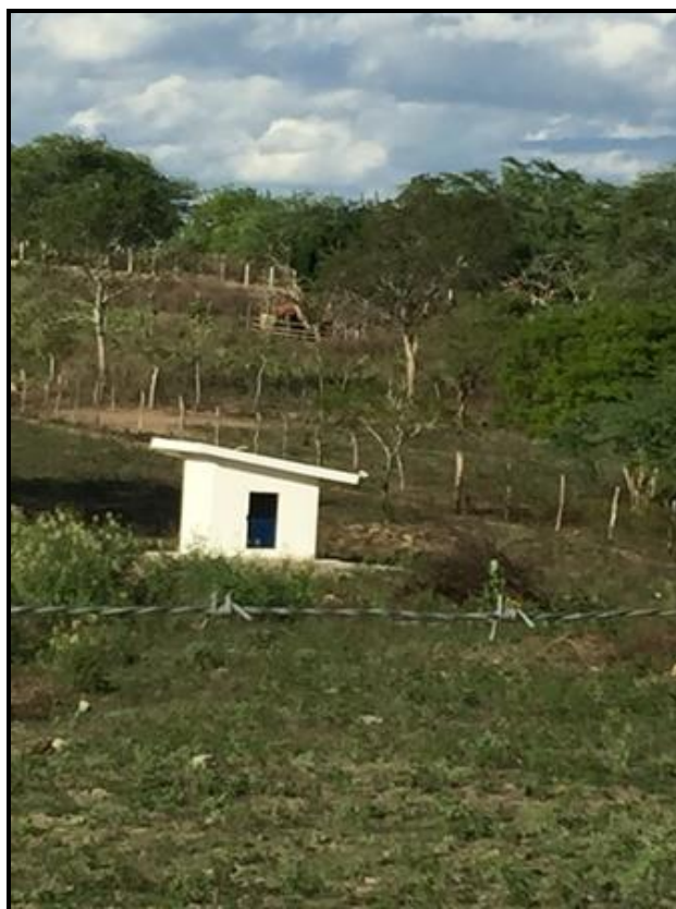
Figura 55 – Poço do Sistema de Dessalinização Comunidade Cajarana Fonte: Premier Engenharia, 2018
