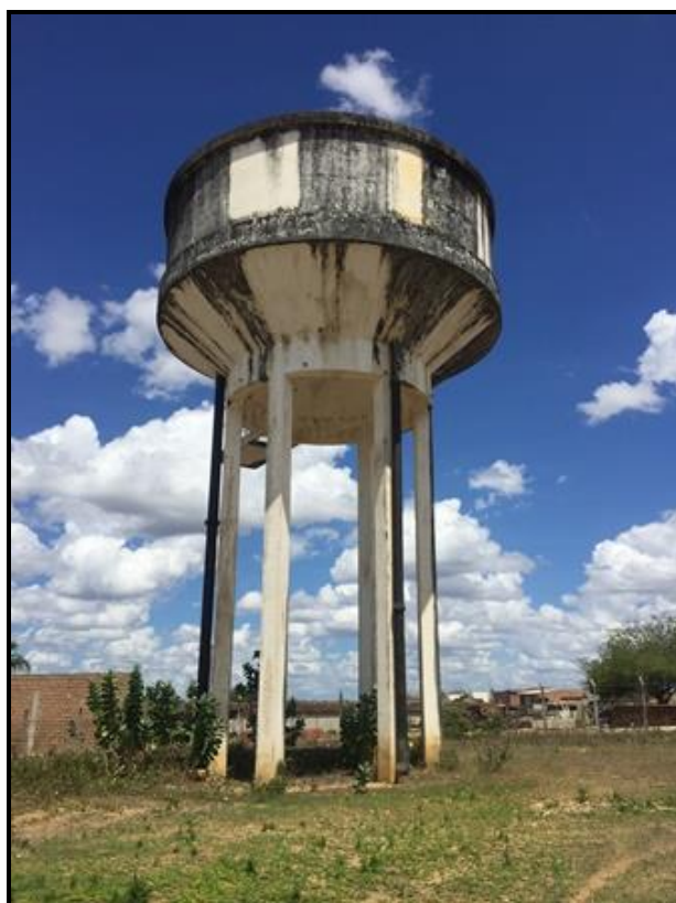
Figura 61 – Reservatório localizado na Sede do município Fonte: Premier Engenharia, 2018.
