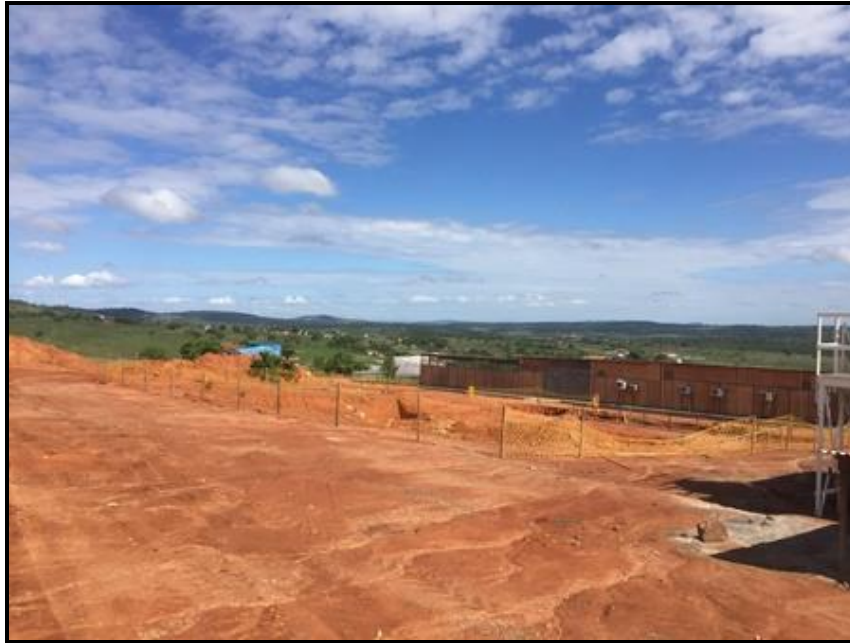
Figura 39 – ETA Convencional em construção Fonte: Premier Engenharia, 2018
