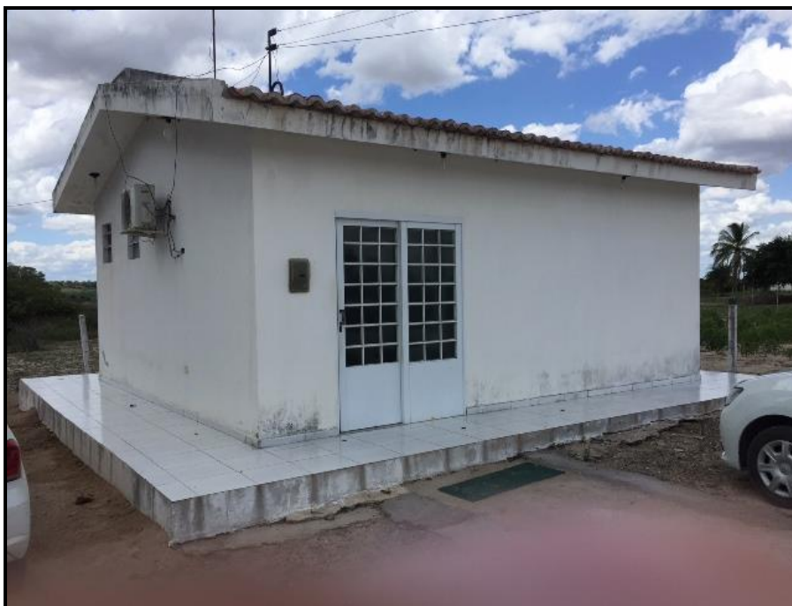
Figura 96 – Escritório administrativo anexo ao aterro sanitário Fonte: Premier Engenharia, 2018.
