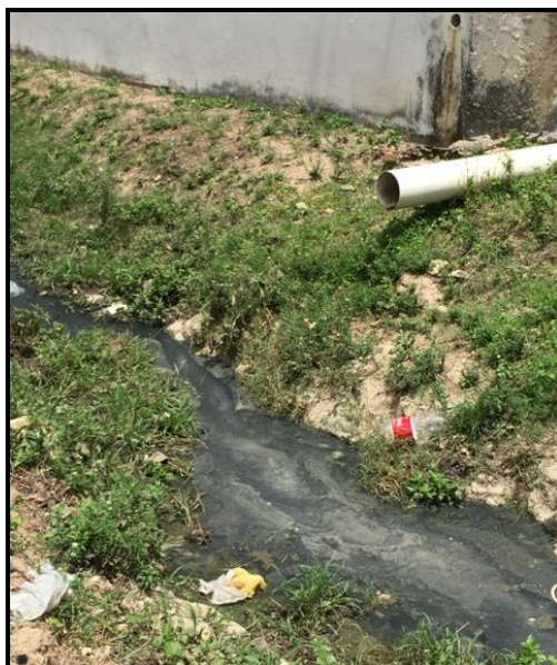
Figura 68 – Ponto de lançamento de esgoto a céu aberto localizado na Rua Sargento Benevides V. Monte Fonte – Premier Engenharia, 2018.
