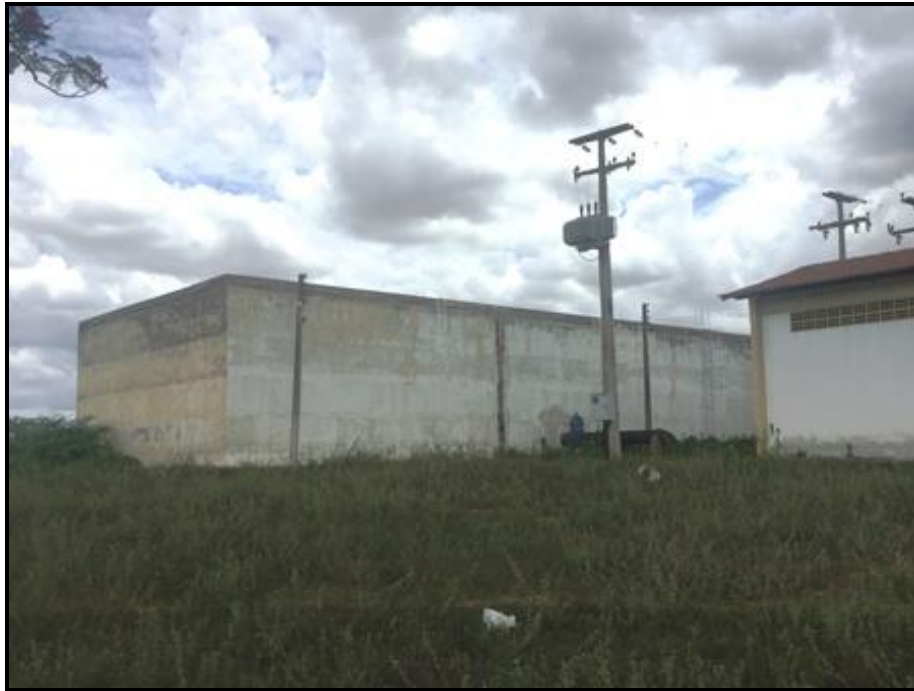
Figura 50 – Reservatório R-03 – Batalha Fonte: Premier Engenharia, 2018
