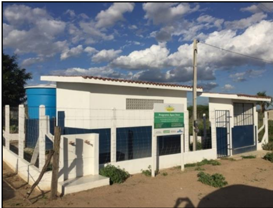
Figura 56 – Unidade de Dessalinização – Comunidade Cajarana Fonte: Premier Engenharia, 2018
