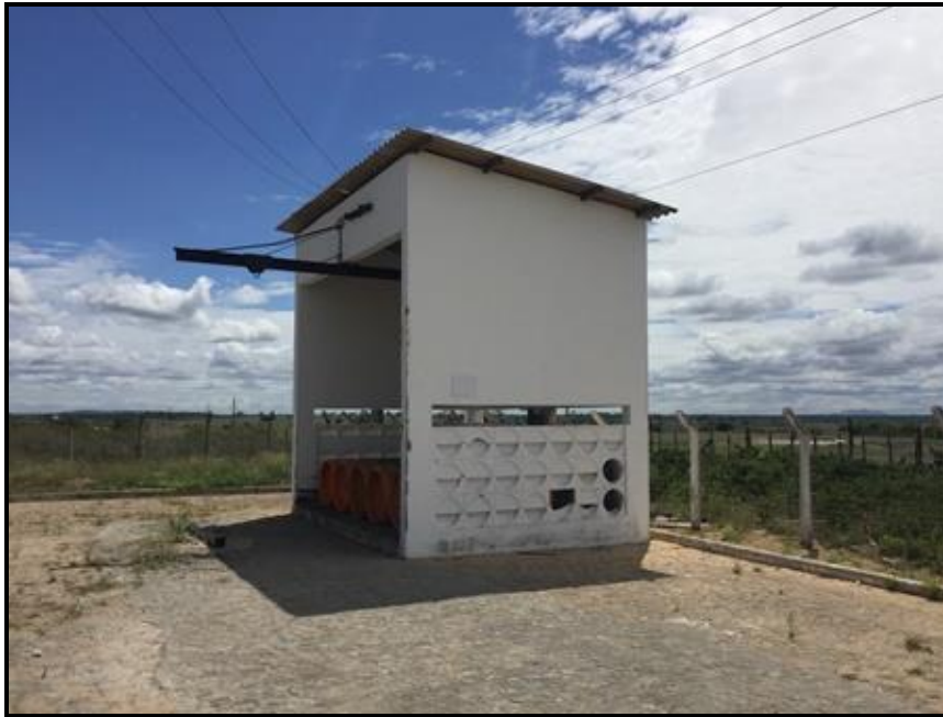
Figura 40 – Vista externa do Tratamento Fonte: Premier Engenharia, 2018
