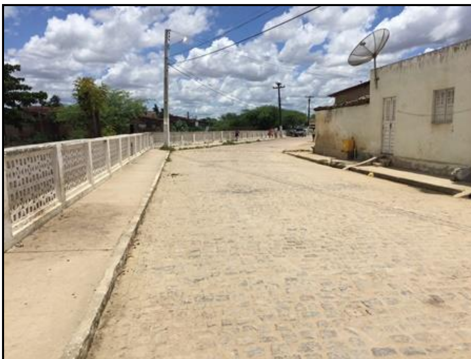
Figura 121 – Área Problema 2: trecho da rua suscetível a alagamento Fonte: Premier Engenharia, 2018.
