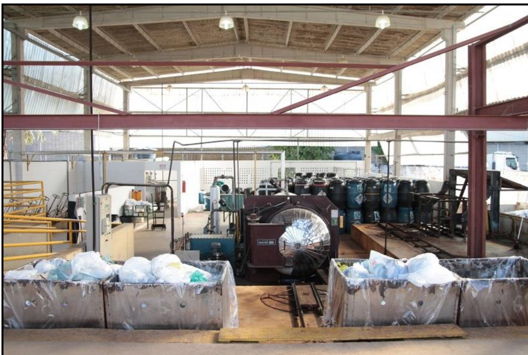
Figura 103 – Local de tratamento dos RSS na sede da Empresa SERQUIP Fonte: SERUIP, 2017.
