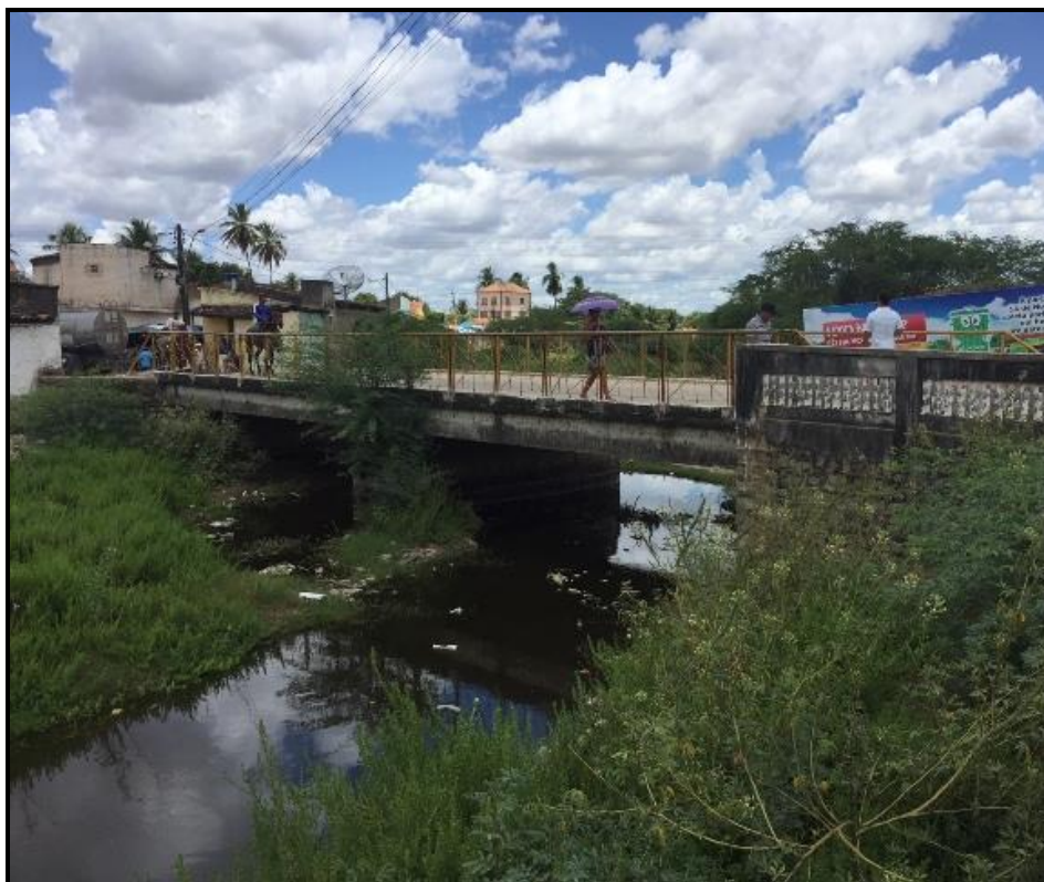
Figura 112 – Ponte sobre o Riacho do Sertão Fonte: Premier Engenharia, 2018.
