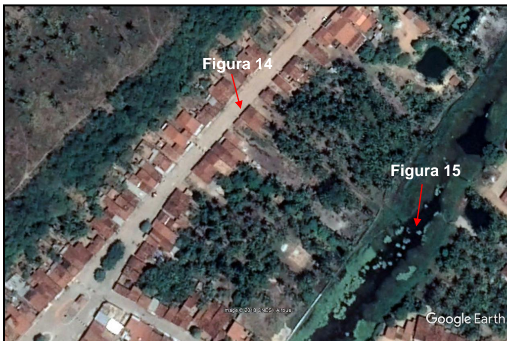
Figura 55 – Vista aérea englobando o ponto de lançamento e o Rio Conduípe (Figura 14 e Figura 15) Fonte – Premier Engenharia, 2018.
