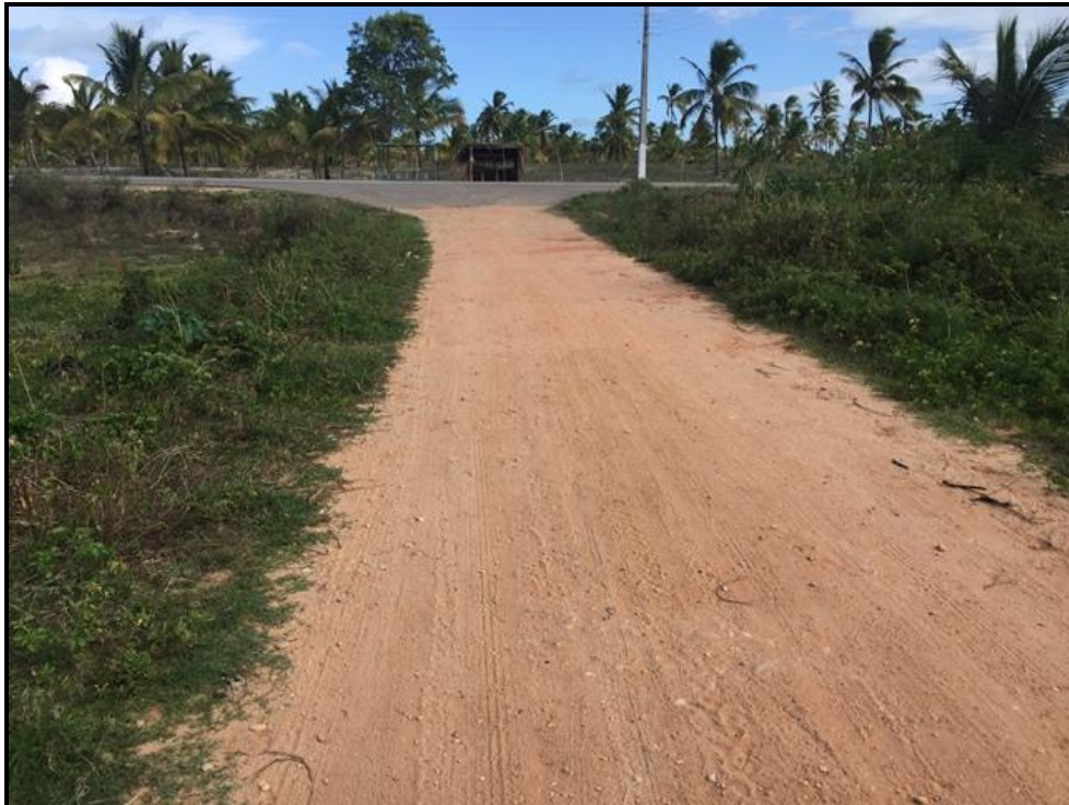
Figura 105 – Área Problema 6: inexistência de drenagem na localidade (vista sentido Rodovia AL-101)
