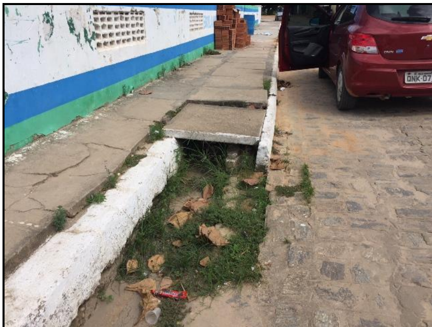
Figura 89 – Captação de água pluvial na Rua Domingos André Fonte: Premier Engenharia, 2018.
