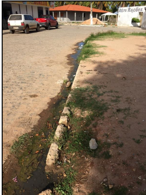
Figura 56 – Ponto de lançamento de esgoto a céu aberto localizado na Rua Vereador Claudionor de Jesus Fonte – Premier Engenharia, 2018.
