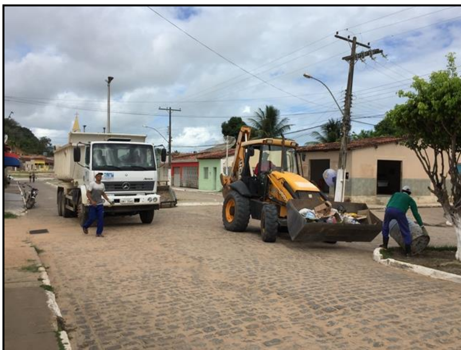
Figura 71 – Execução da coleta convencional em Feliz Deserto Fonte: Premier Engenharia, 2018.
