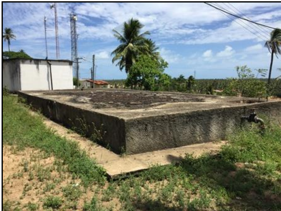
Figura 39 – Reservatório Semi-enterrado (R2) – ao lado do cemitério Fonte – Premier Engenharia, 2018.
