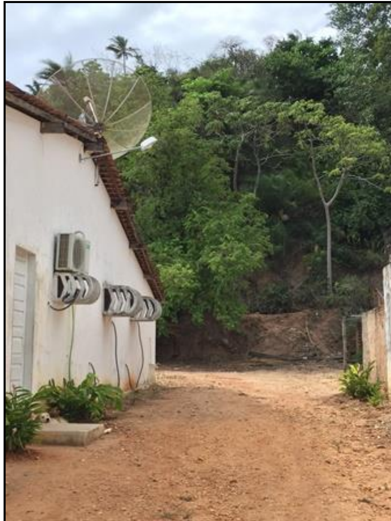
Figura 135 – Área sujeita a deslizamento Fonte: Premier Engenharia, 2018.
