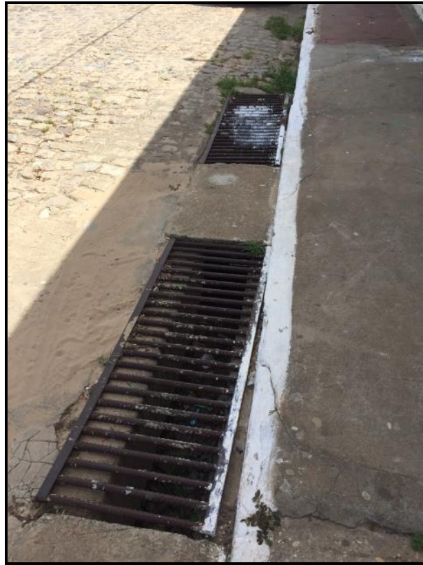
Figura 88 – Boca-de-lobo da Praça Domingos Mendes Fonte: Premier Engenharia, 2018.
