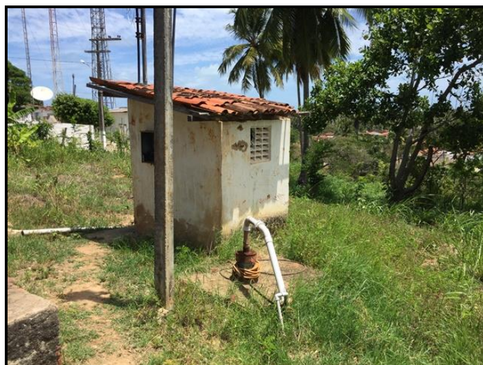
Figura 32 –Poço Domingos Mende II Fonte – Premier Engenharia, 2018.
