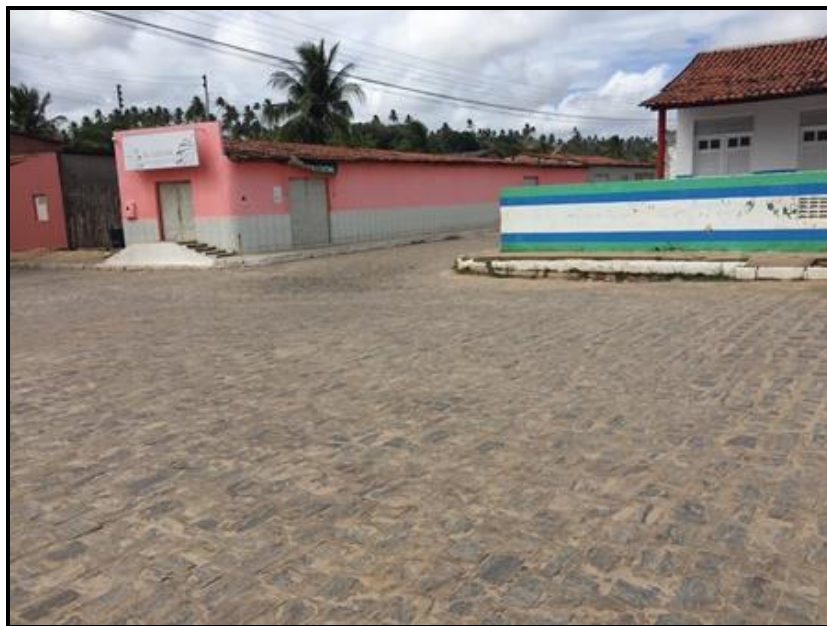
Figura 97 – Área Problema 2: cruzamento afetado por alagamento Fonte: Premier Engenharia, 2018.
