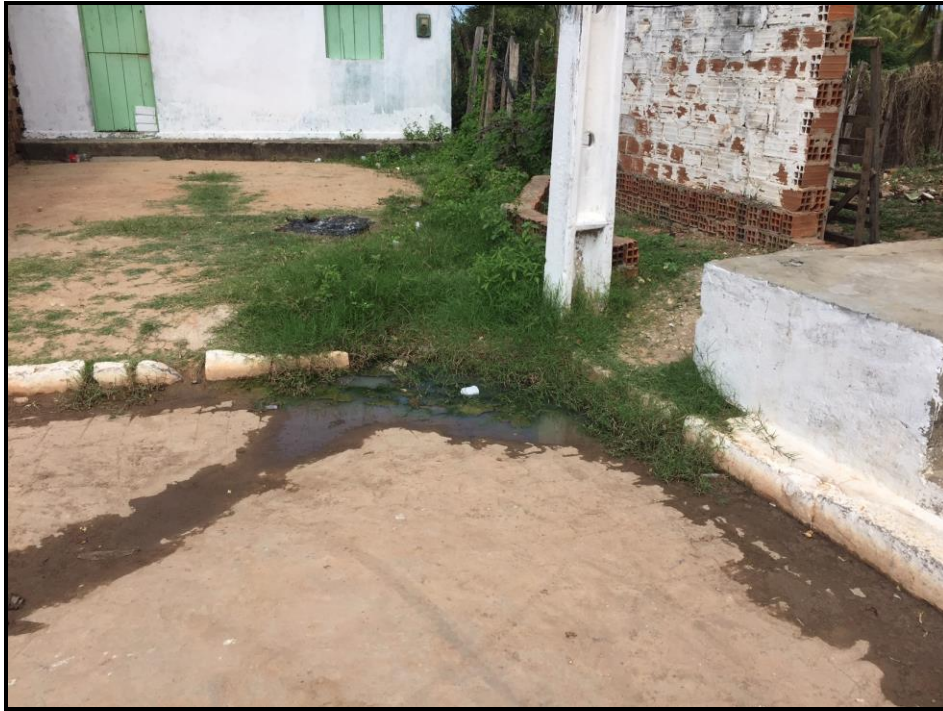
Figura 102 – Área Problema 4: acúmulo de água em decorrência do não escoamento
