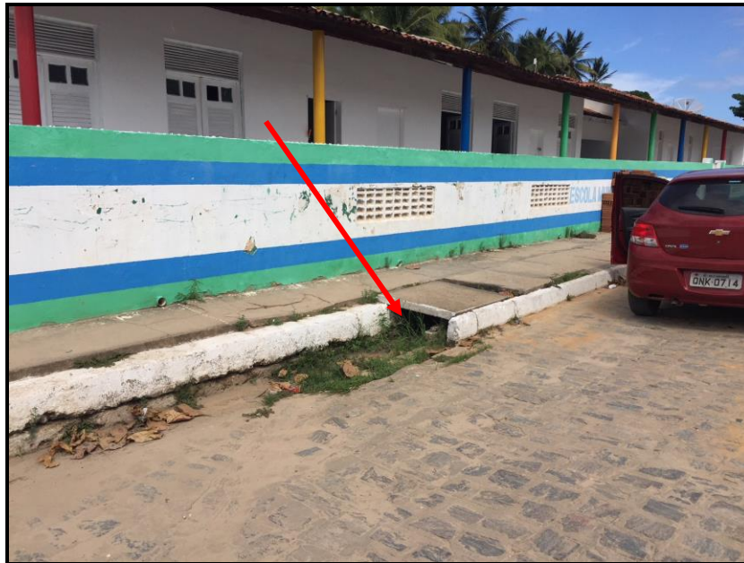
Figura 98 – Área Problema 2: detalhe do dispositivo de captação Fonte: Premier Engenharia, 2018.
