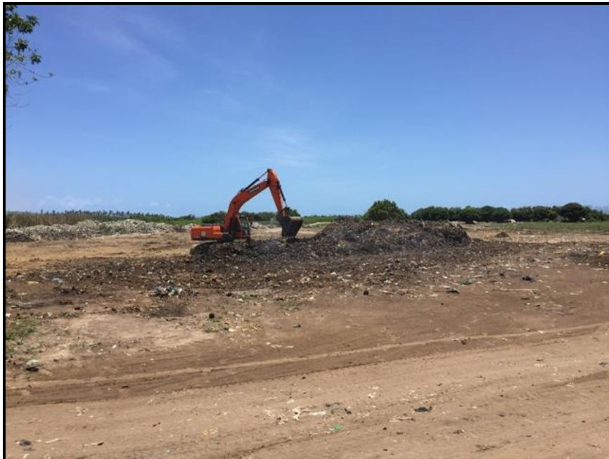
Figura 86 – Lixão de Coruripe (tratoesteira) Fonte: Premier Engenharia, 2018.
