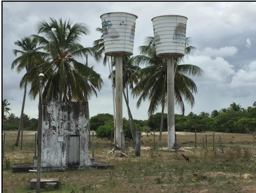
Figura 48 – Reservatórios Povoado Flexeiras Fonte – Premier Engenharia, 2018.
