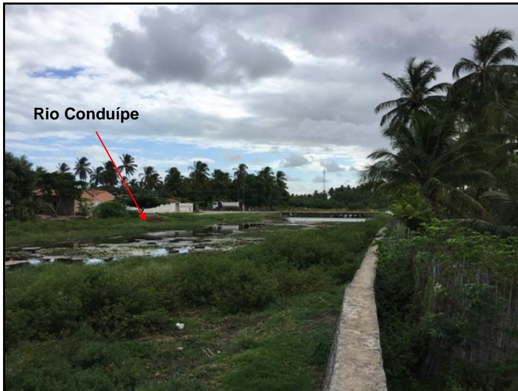
Figura 54 – Rio Conduípe que recebe esgoto sem nenhum tratamento Fonte – Premier Engenharia, 2018.
