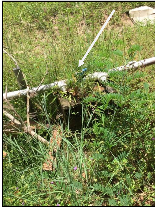
Figura 31 – Registro - Poço Domingos Mendes I Fonte – Premier Engenharia, 2018.
