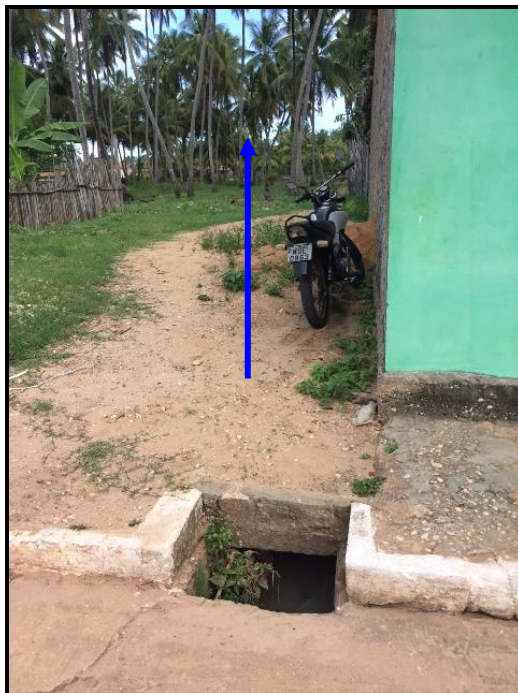
Figura 94 – Caminho dos dejetos até o Rio Conduípe Fonte: Premier Engenharia, 2018.
