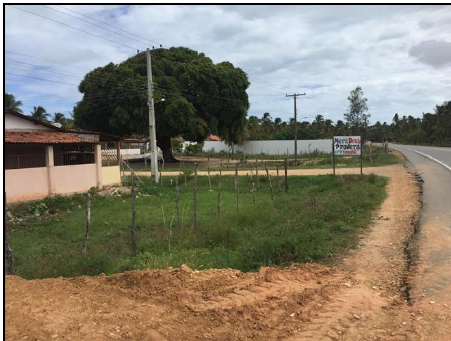
Figura 109 – Área Problema 8: área afetada por alagamento (margem esquerda da AL-101 sentido Feliz Deserto-Piaçabuçu)
