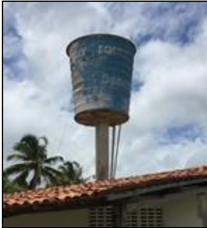
Figura 45 – Reservatório Povoado Pontes Fonte – Premier Engenharia, 2018.
