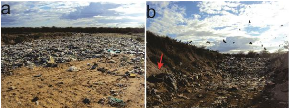
Figura 10.36 – Aterro simplificado do município de Barra; (a) presença de resíduos descobertos; (b) Resíduos dispostos em valas sem proteção impermeabilizante.
