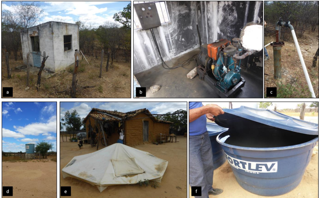
Figura 7.33 – Abastecimento de água em Poções: (a) Casa da bomba (b) bomba (c) poço de 132 m de profundidade (d) Reservatório de 10 m 3 (3) cisterna de lona (f) reservatório de 1000 L para água distribuída pelo carro-pipa
