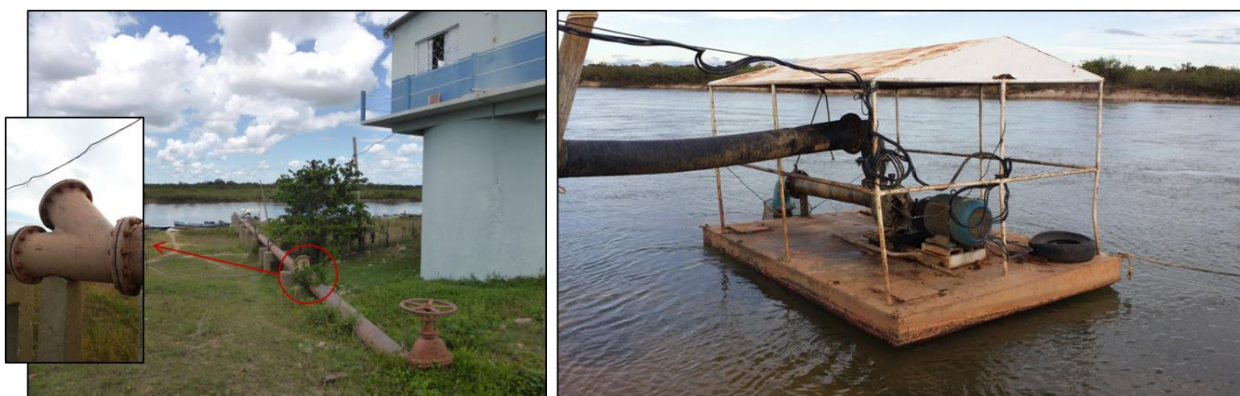
Figura 7.11 – Captação flutuante de água no Rio Grande
