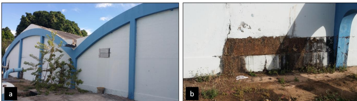
Figura 7.12 – (a) Reservatório que alimenta os filtros russos. (b) Infiltração no reservatório
