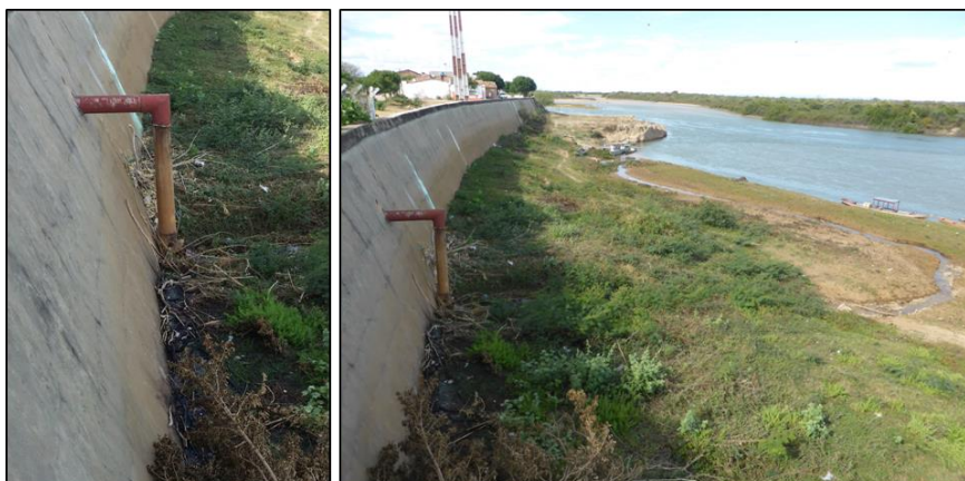
Figura 7.19 – Expurgo da água de lavagem de filtros da ETA
