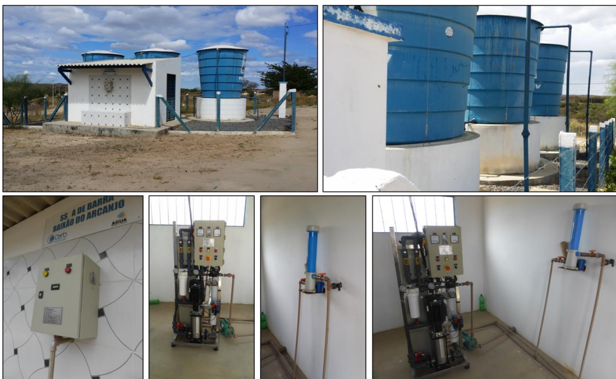
Figura 7.30 – SAC Baixões do Arcanjo, com dessalinizador
