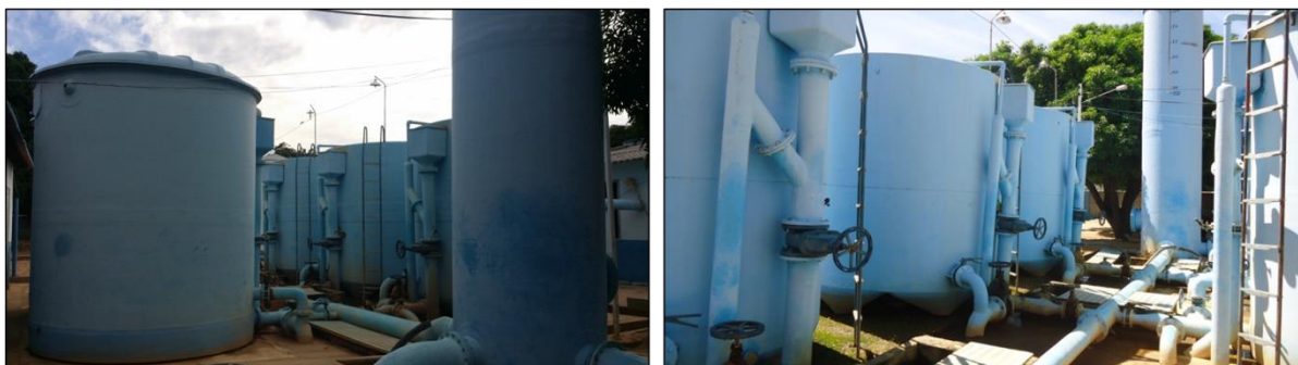
Figura 7.12 – (a) Reservatório que alimenta os filtros russos. (b) Infiltração no reservatório
