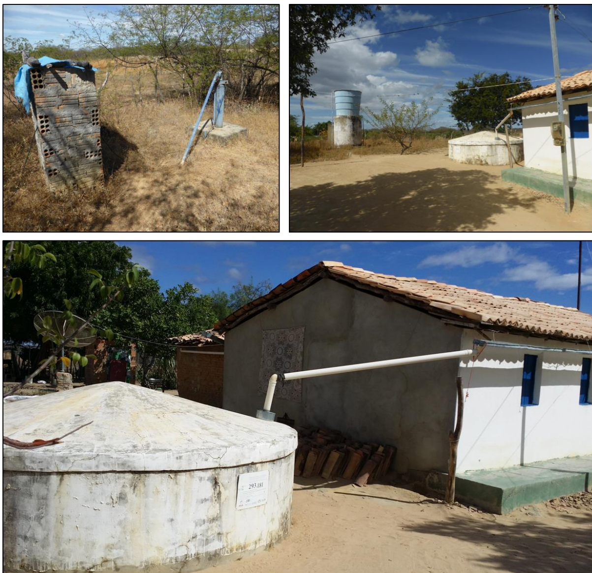
Figura 7.32 – Abastecimento de água em Pratos Finos através de poço profundo e captação de água da chuva por meio de cisternas
