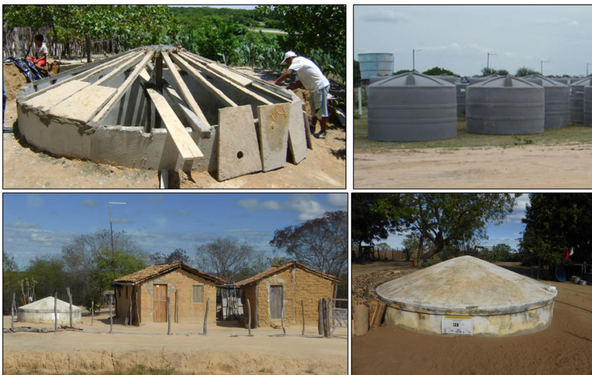
Figura 7.31 – Captação de água de chuva através de cisternas
