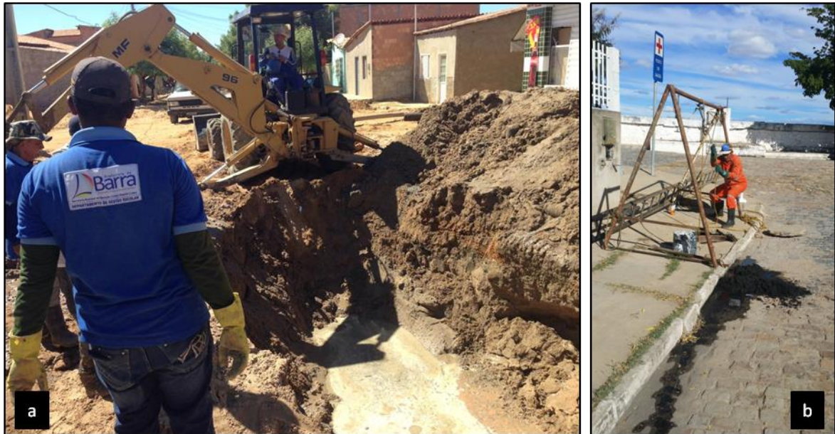
Figura 8.15 – (a) reparo da rede de esgoto na rua Subestação 3; (b) limpeza da rede de esgoto
