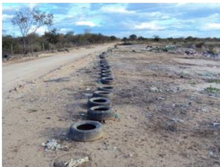
Figura 10.38 – Pneus inservíveis utilizados para definir o trajeto da estrada de acesso ao aterro
