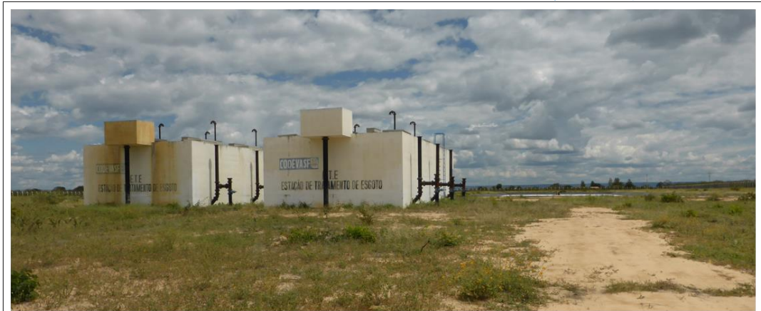
ESTAÇÃO DE TRATAMENTO DE ESGOTO SANITÁRIO
