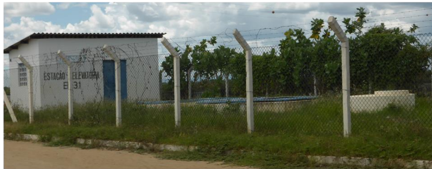
ESTAÇÃO ELEVATÓRIA DE ESGOTO
