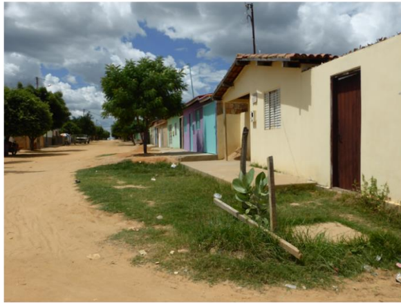
BAIRRO SAGRADA FAMÍLIA – PONTO CRÍTICO NA DRENAGEM URBANA
