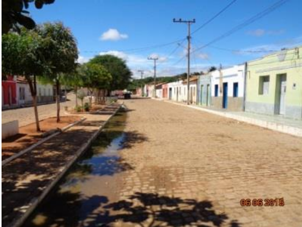
Figura 9 – Ausência de dispositivos de microdrenagem e acúmulo de água no pavimento – à esquerda Distrito de Canabrava e à direita Povoado de Santa Cruz
