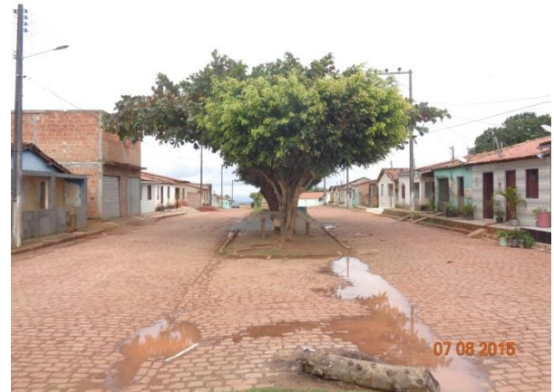
Figura 9 – Ausência de dispositivos de microdrenagem e acúmulo de água no pavimento – à esquerda Distrito de Canabrava e à direita Povoado de Santa Cruz
