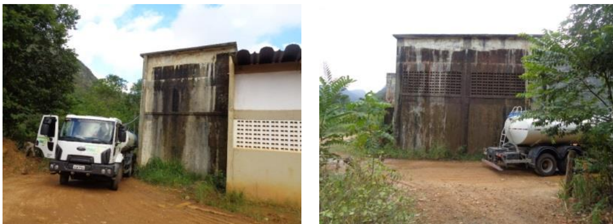
Figura 8 – Caminhão pipa abastecendo no reservatório de 80 m 3
