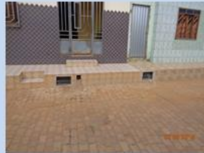
Instalação de hidrômetros
