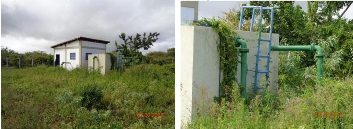
Figura 34 – EEAB 2 – detalhe para a vegetação invadindo a área do prédio
