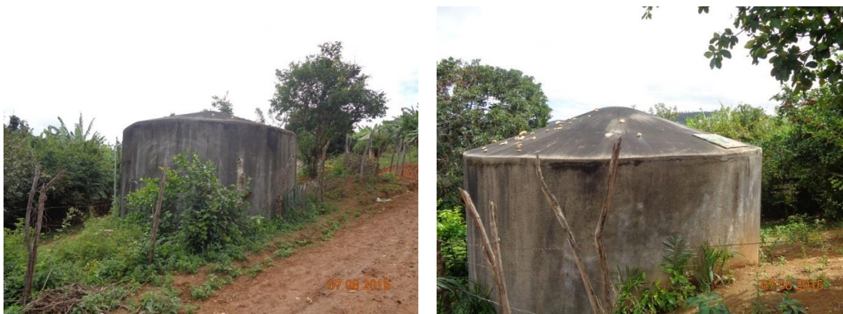
Figura 66 – Reservatório do povoado de Barroirão de Cima
