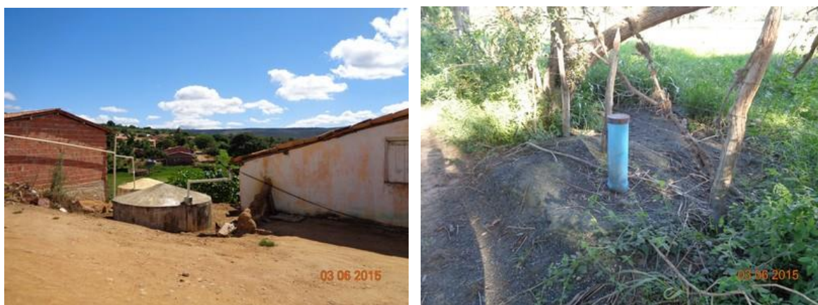
Figura 47 – Cisternas no povoado de Ponto Alegre e poço perfurado aguardando equipamentos
