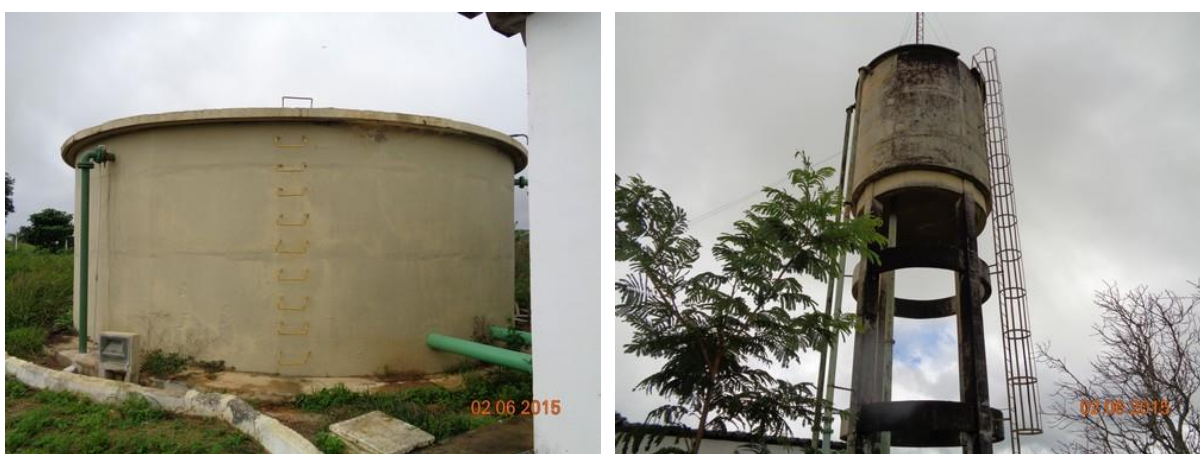
Figura 38 – RAP – capacidade de 150 m 3 e REL – capacidade de 70 m 3
