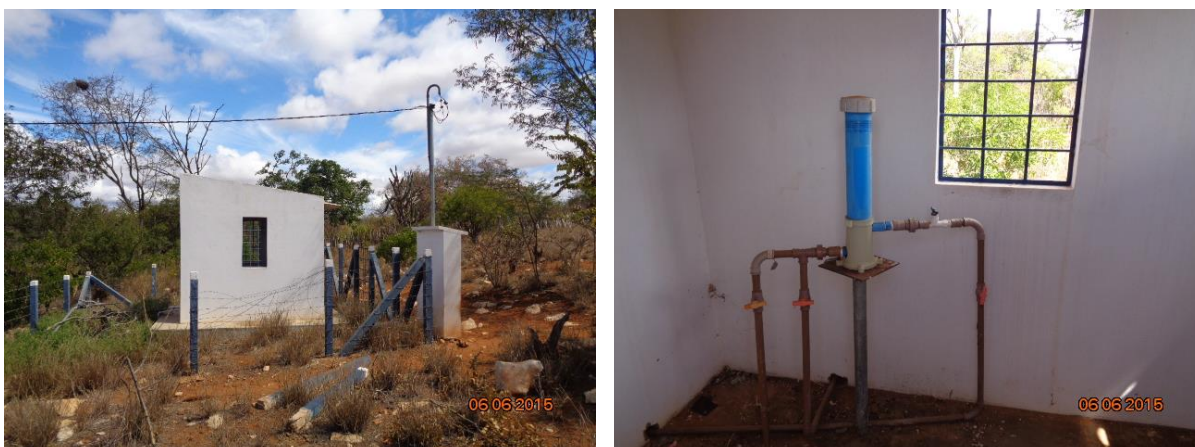
Figura 51 – Poço no Povoado de Vereda
