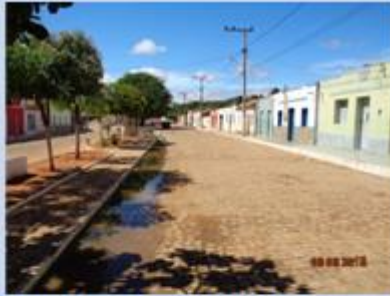
Ausência de dispositivos de microdrenagem e acúmulo de água no pavimento à esquerda Distrito de Canabrava e à direita Povoado de Santa Cruz
