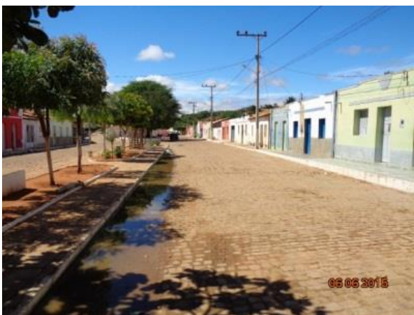
Figura 117 – Ausência de dispositivos de microdrenagem e acúmulo de água no pavimento – à esquerda Distrito de Canabrava e à direita Povoado de Santa Cruz
