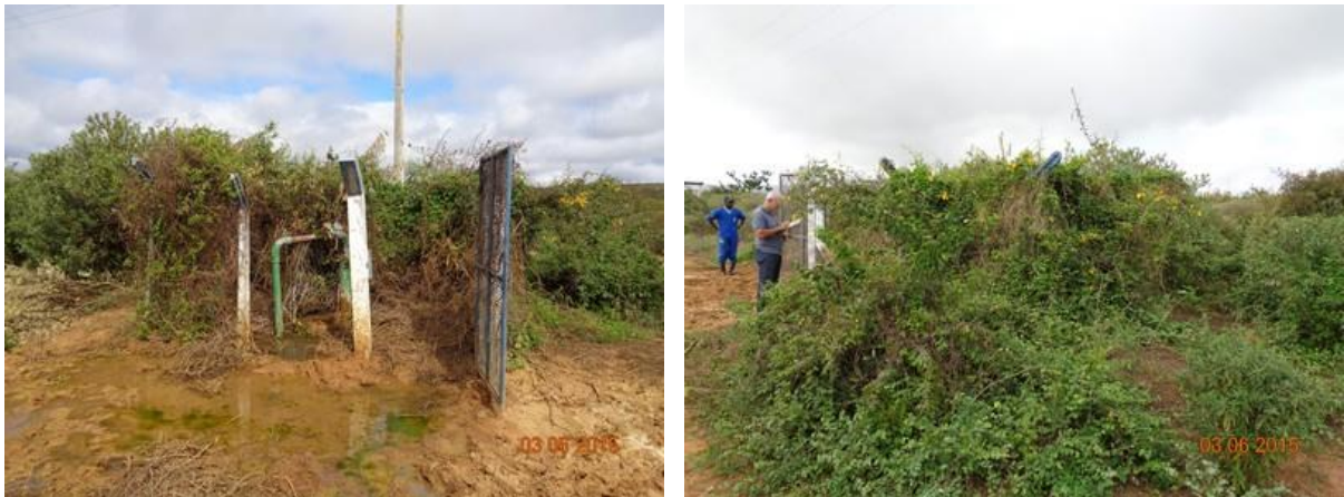
Figura 29 – Poço 1 apresentando vazamento e tomado por vegetação
