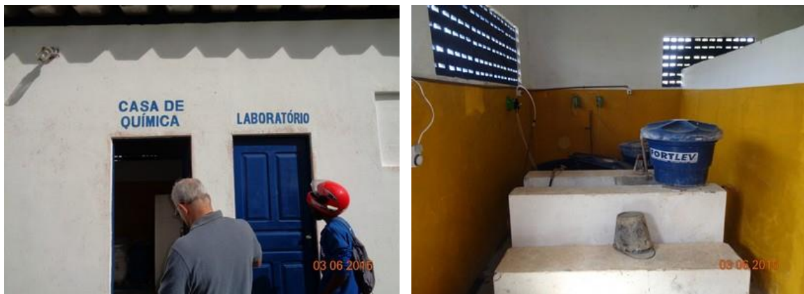
Figura 36 – Casa de química da ETA Mirangaba
