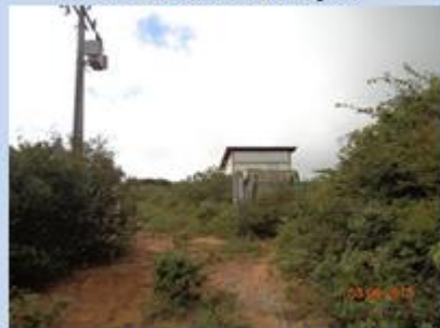
Área da EEAB 1 tomada por vegetação
