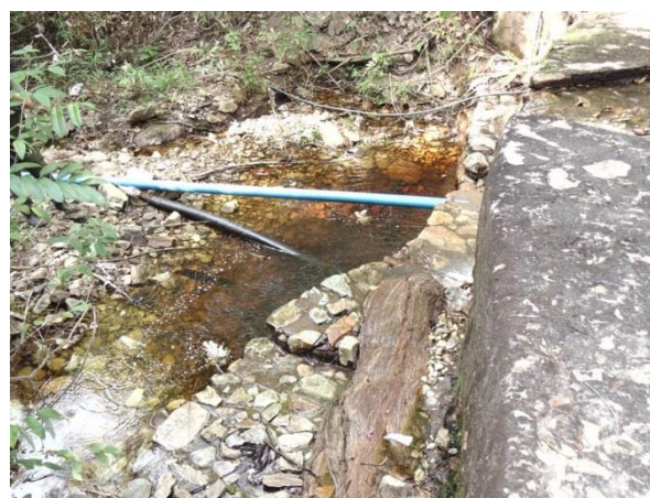
Figura 84 – Barragem para captação de água bruta
