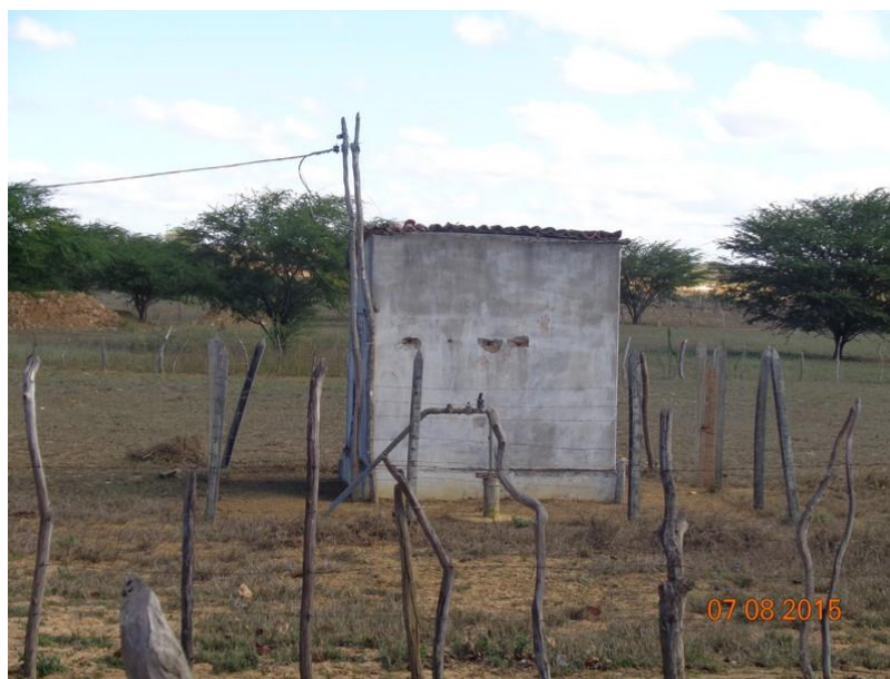
Figura 75 – Poço do 2º sistema
