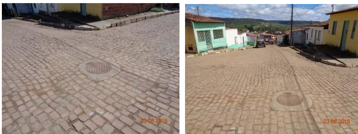
Figura 88 - PV da rede coletora na sede de Mirangaba
