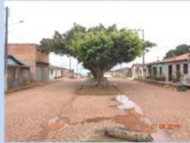
Ausência de dispositivos de microdrenagem e acúmulo de água no pavimento à esquerda Distrito de Canabrava e à direita Povoado de Santa Cruz
