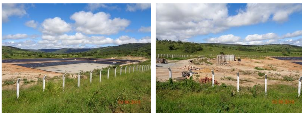
Figura 89 - Local das obras de instalação da ETE
