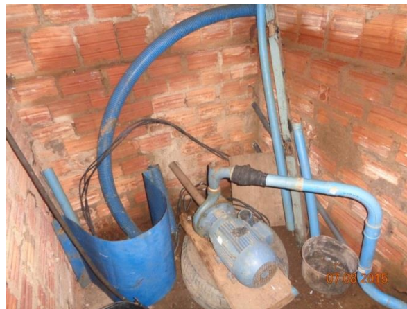
Figura 77 – Flutuante e bomba
