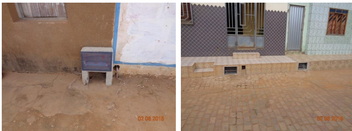
Figura 43 – Instalação de hidrômetros
