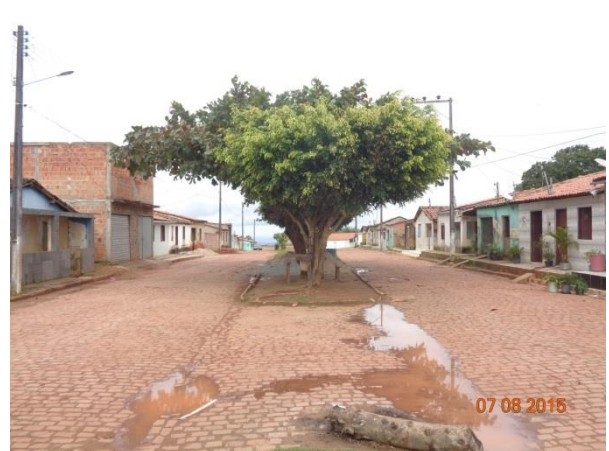
Figura 117 – Ausência de dispositivos de microdrenagem e acúmulo de água no pavimento – à esquerda Distrito de Canabrava e à direita Povoado de Santa Cruz
