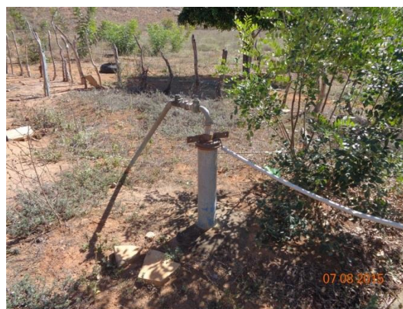
Figura 71 – Poço tubular profundo
