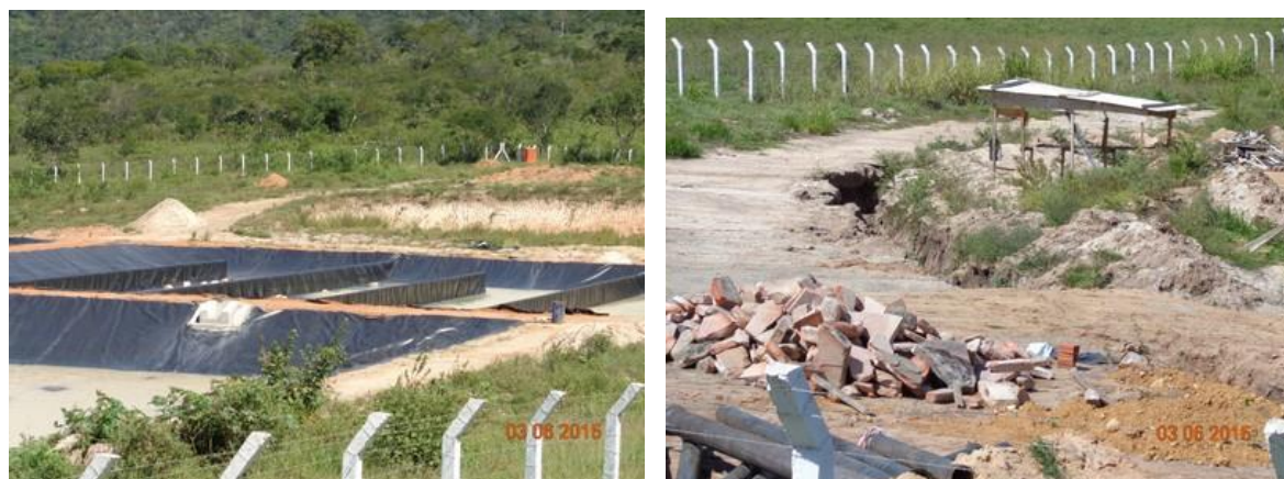
Figura 90 – Vista do sistema de tratamento em implantação
