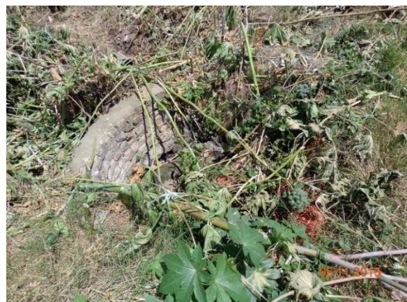
Figura 111 – Poços de visita – à esquerda com a tampa coberta por concreto e à direita estrutura danificada
