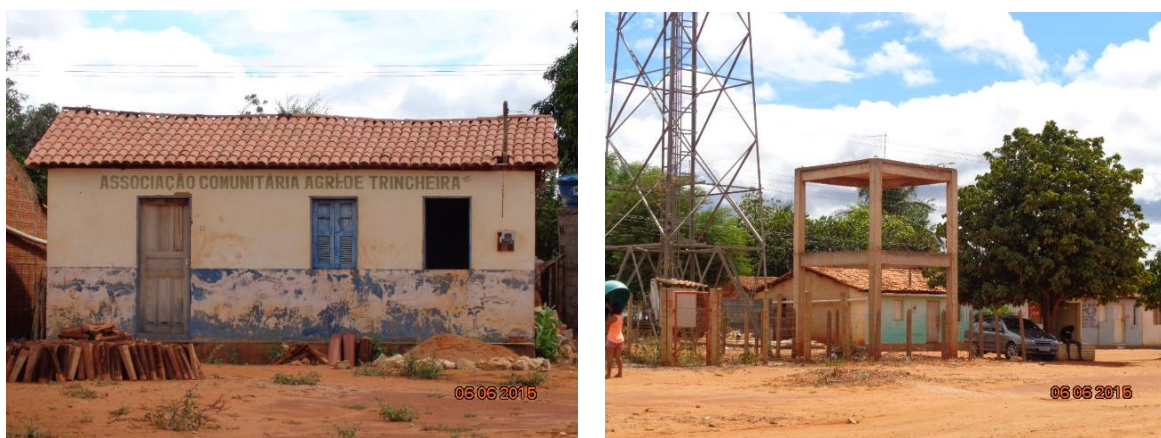
Figura 54 – Sede da associação e local onde estava o reservatório
