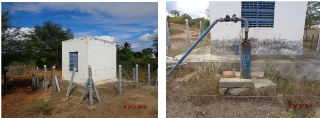
Figura 57 – Poço tubular profundo de Junco
