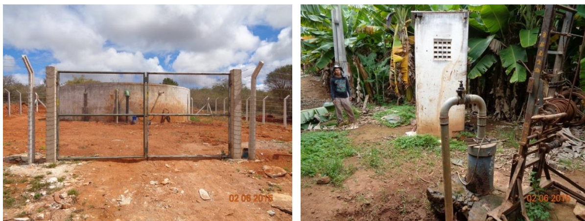
Figura 41 – RAP de 150\text{ m}^3 e poço tubular profundo
