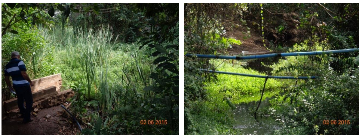
Figura 40 – Captação superficial no Rio Branco e rede de distribuição
