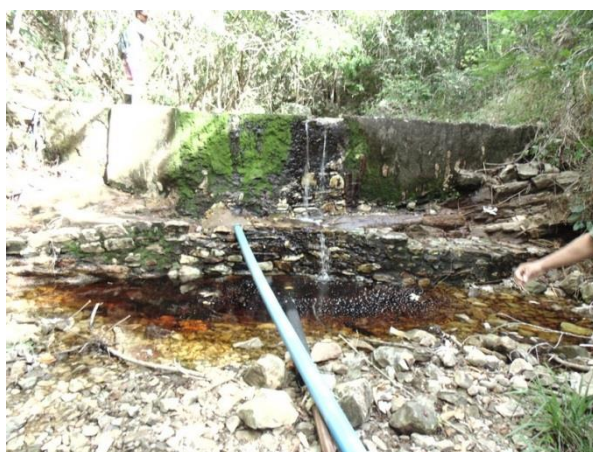
Figura 84 – Barragem para captação de água bruta
