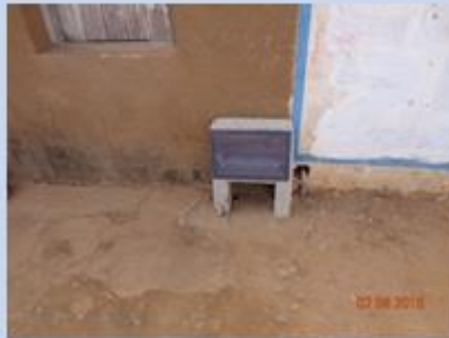
Instalação de hidrômetros
