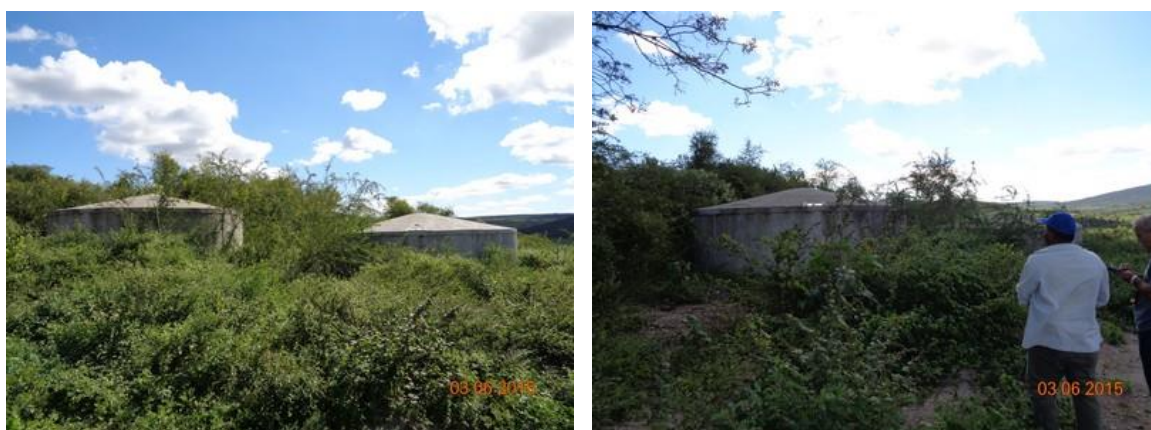
Figura 46 – Reservatórios de 200 m 3 fora de uso
