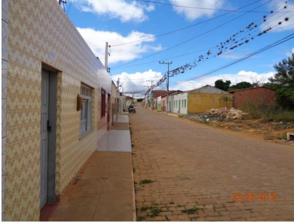
Figura 116 – Ausência de dispositivos de microdrenagem – à esquerda Distrito de Taquarandi e à direita Povoado de Campo Grande
