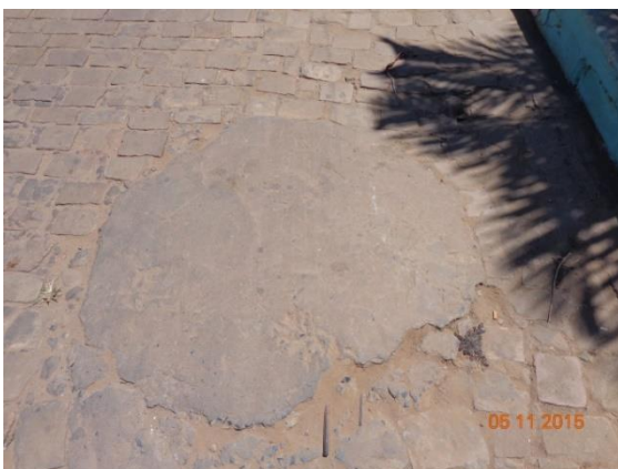
Figura 111 – Poços de visita – à esquerda com a tampa coberta por concreto e à direita estrutura danificada
