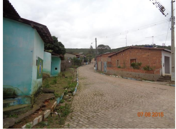
Figura 116 – Ausência de dispositivos de microdrenagem – à esquerda Distrito de Taquarandi e à direita Povoado de Campo Grande
