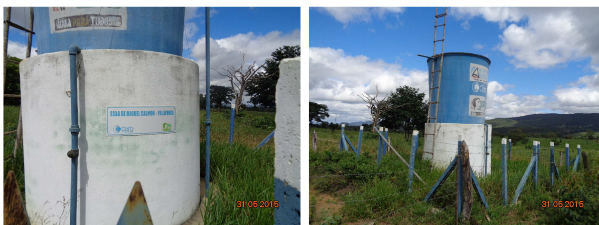
Figura 75 – Reservatório de 10 m 3
