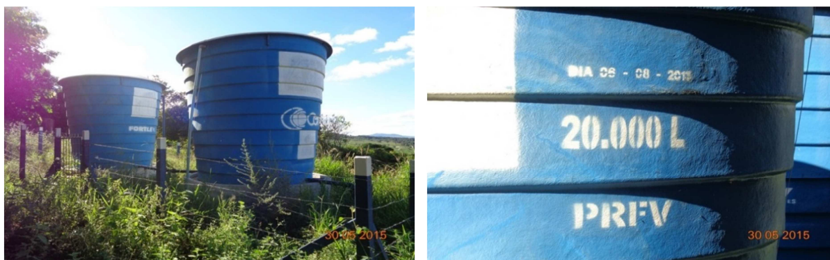
Figura 65 – Reservatórios apoiado de 20m 3
