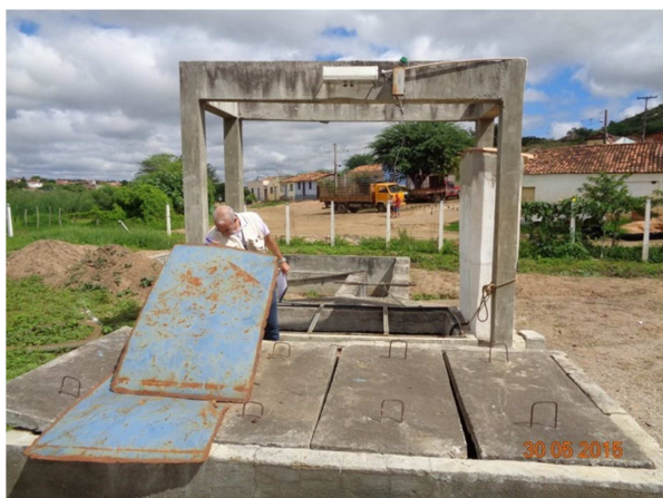
Figura 92 – Placa com restrição da entrada, mas não há cadeado no portão
