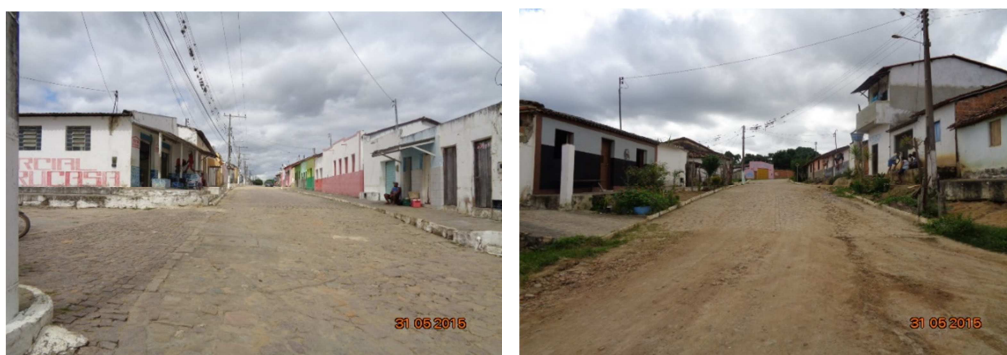
Figura 117 – Rua com e sem pavimentação no distrito de Tapiranga sem nenhum sistema de coleta de águas pluviais
