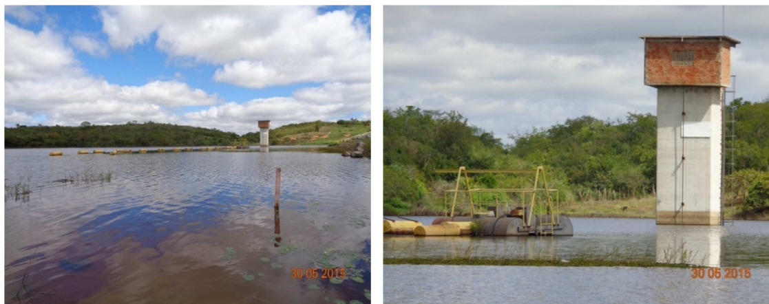
Figura 40 – Captação por flutuantes no lago da barragem
