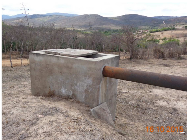
Figura 94 – Caixa de chegada do esgoto e adução para a ETE
