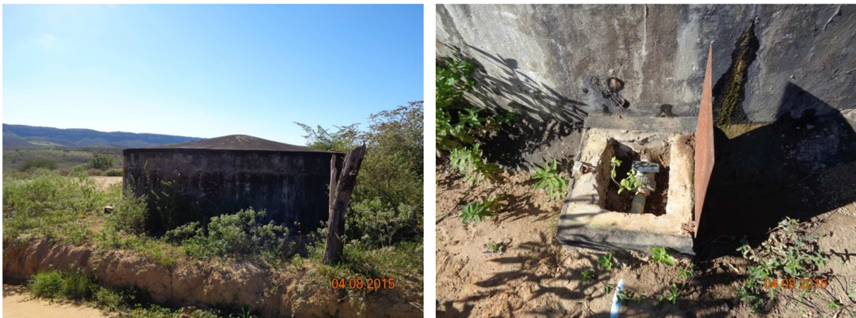
Figura 83 – Reservatório do Povoado de Santa Terezinha
