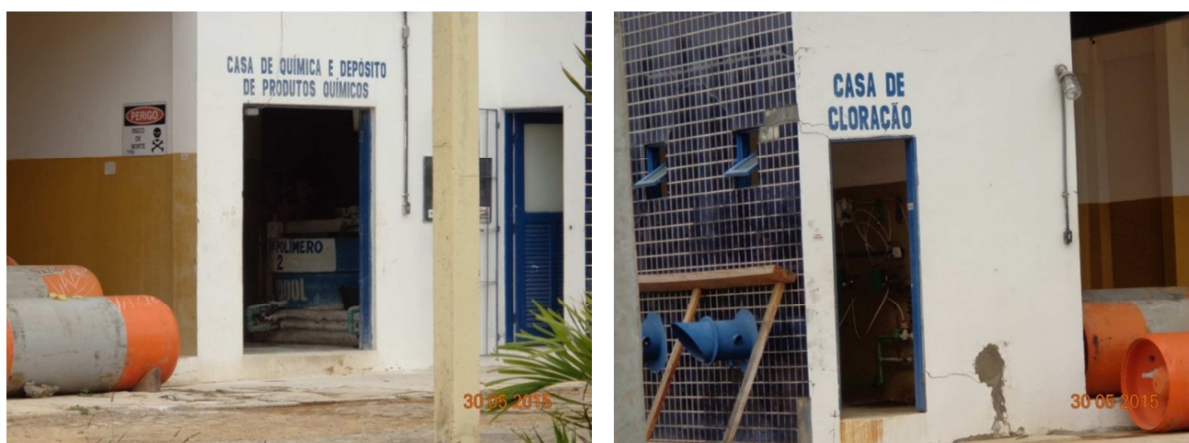
Figura 44 – ETA do França – unidades de tratamento
