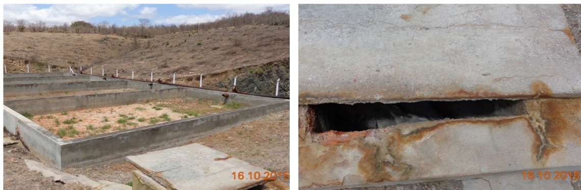
Figura 97 – Leito de secagem do lodo
