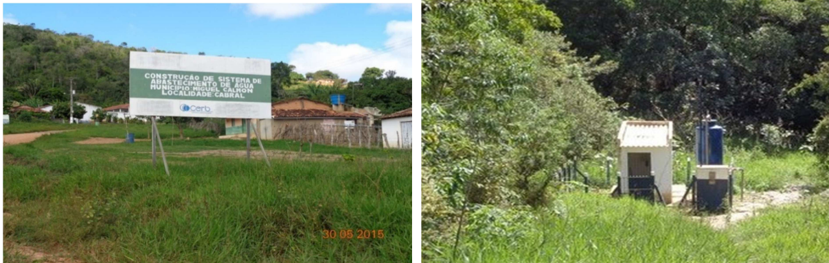
Figura 66 – Placa sobre a construção do sistema e local de tratamento
