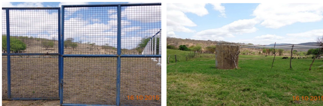
Figura 98 – Portão de entrada e local da saída do esgoto após tratamento
