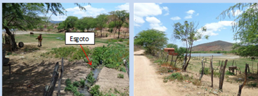
Esgoto "In Natura" da EEE 01 – Pedreira a céu aberto seguindo para a lagoa
