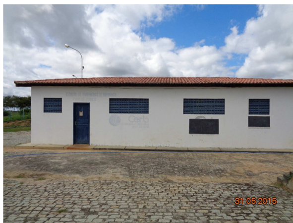
Figura 55 – ETA Pedras Altas – SAA Tapiranga
