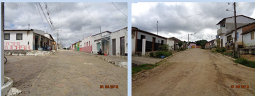
Rua com e sem pavimentação no distrito de Tapiranga sem nenhum sistema de coleta de águas pluviais
