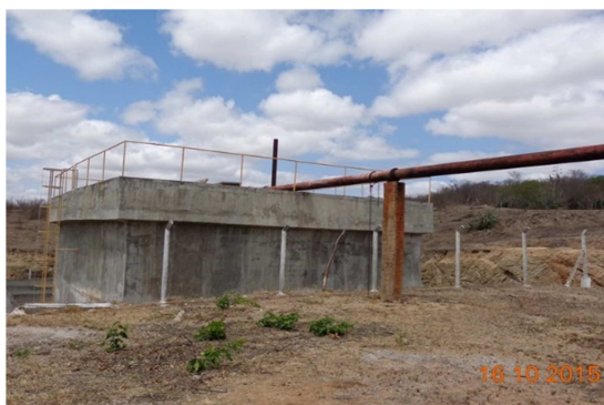
Figura 95 – Digestor anaeróbio de fluxo ascendente
