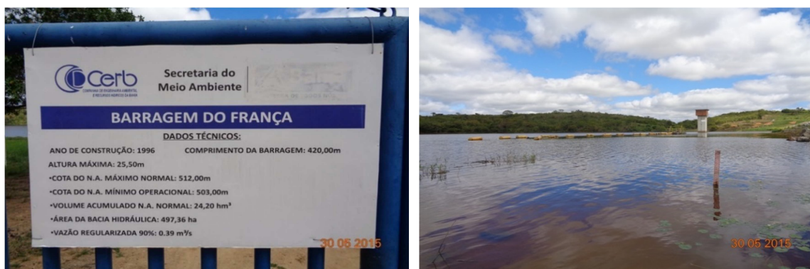
Figura 39 – Placa de indicação e portão de acesso da barragem
