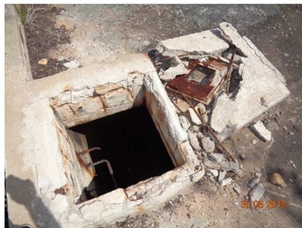
Figura 50 – Reservatórios e tampa de inspeção quebrada
