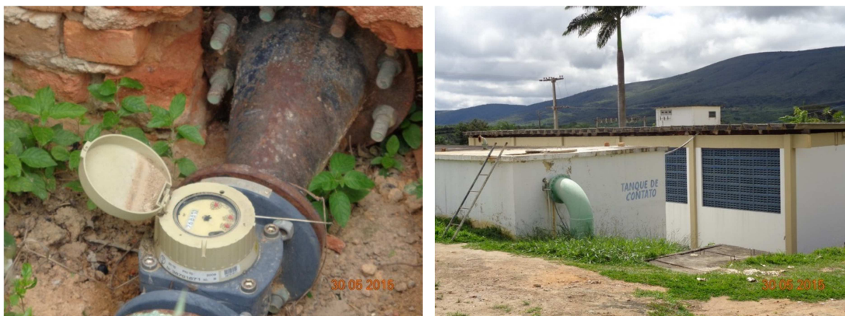
Figura 47 – Macromedição e tanque de contato
