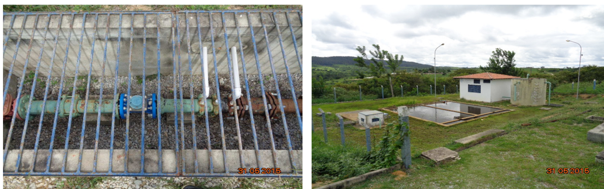
Figura 57 – Unidades de tratamento
