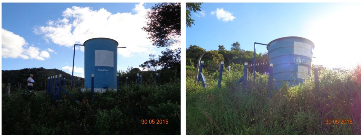
Figura 61 – RAP de 20 m 3 e de 10 m 3 do sistema captação subterrâneo
