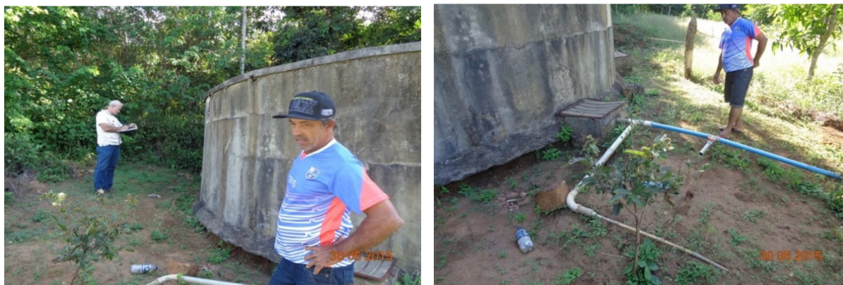
Figura 64 – Reservatório apoiado de 100m 3
