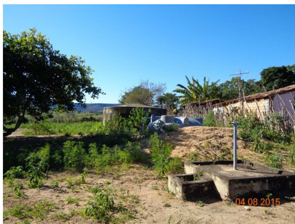
Figura 84 – Reservatório do Povoado da Palmeira
