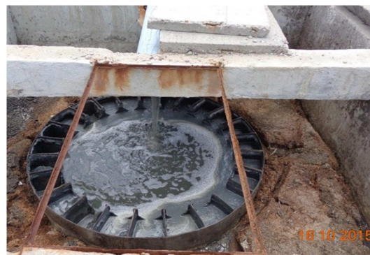
Figura 95 – Digestor anaeróbio de fluxo ascendente
