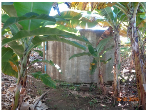
Figura 63 – Reservatório que recebe água da barragem
