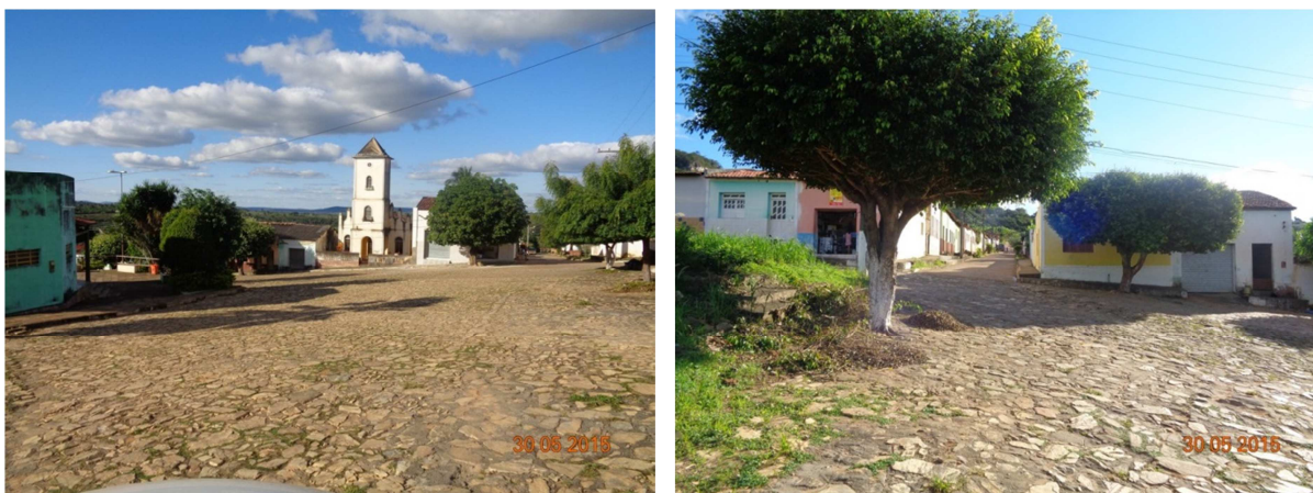
Figura 118 – Ausência de dispositivos de microdrenagem – distrito de Itapura
