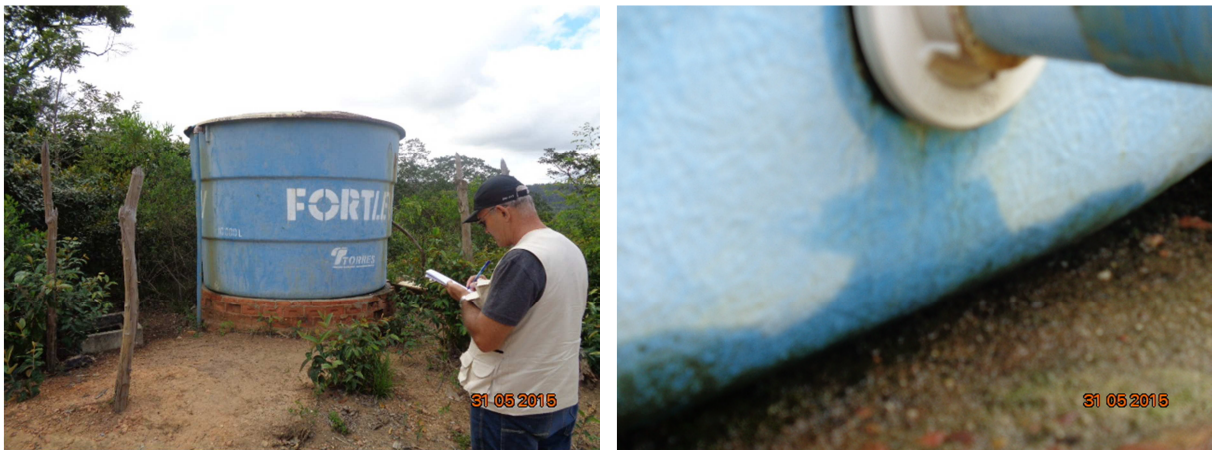
Figura 73 – Reservatório de 10 m 3
