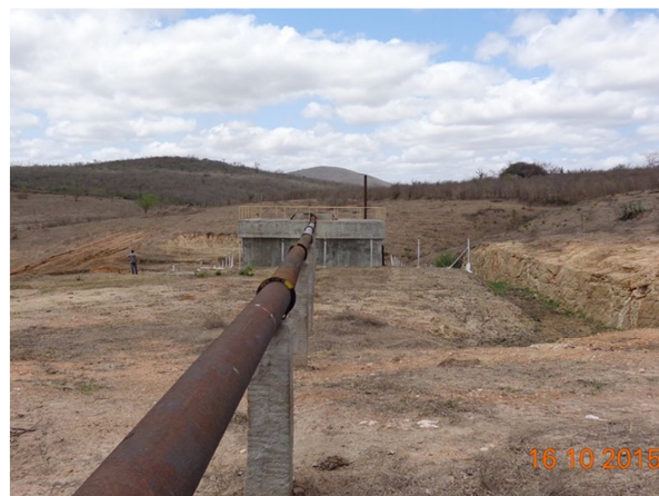
Figura 94 – Caixa de chegada do esgoto e adução para a ETE
