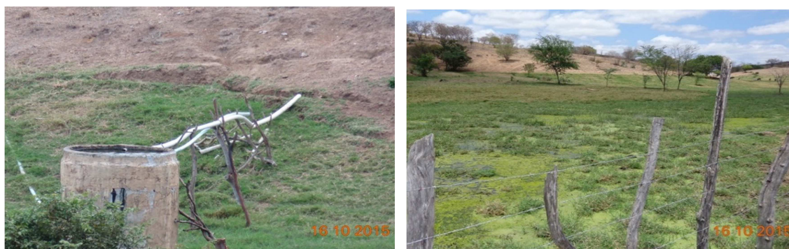
Figura 100 – Tubulações clandestinas coletando o esgoto tratado para uso na agricultura e terrenos à jusante que recebe o esgoto de vazamentos completamente verde
