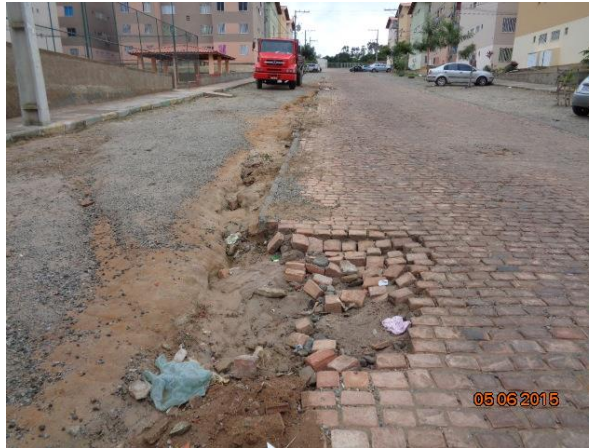
Figura 180 – Ruas na sede de Jacobina sem sistema de microdrenagem – à esquerda sinais de erosão causada pelo escoamento superficial das águas das chuvas e à direita empoçamento
