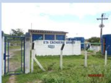
Entrada da ETA
