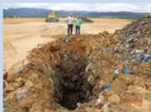
Instalação dos drenos de gás e queimadores
