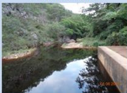
barragem do Rio do Ouro
