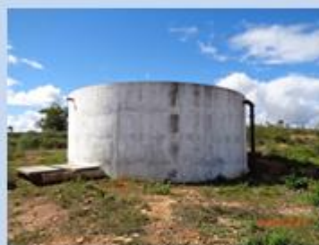
reservatório apoiado (RAP), circular, de concreto, com capacidade aproximada de 120 m 3 ,
