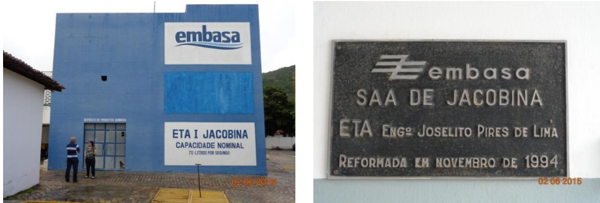
Figura 44 – Fachada e placa de identificação da ETA 1
