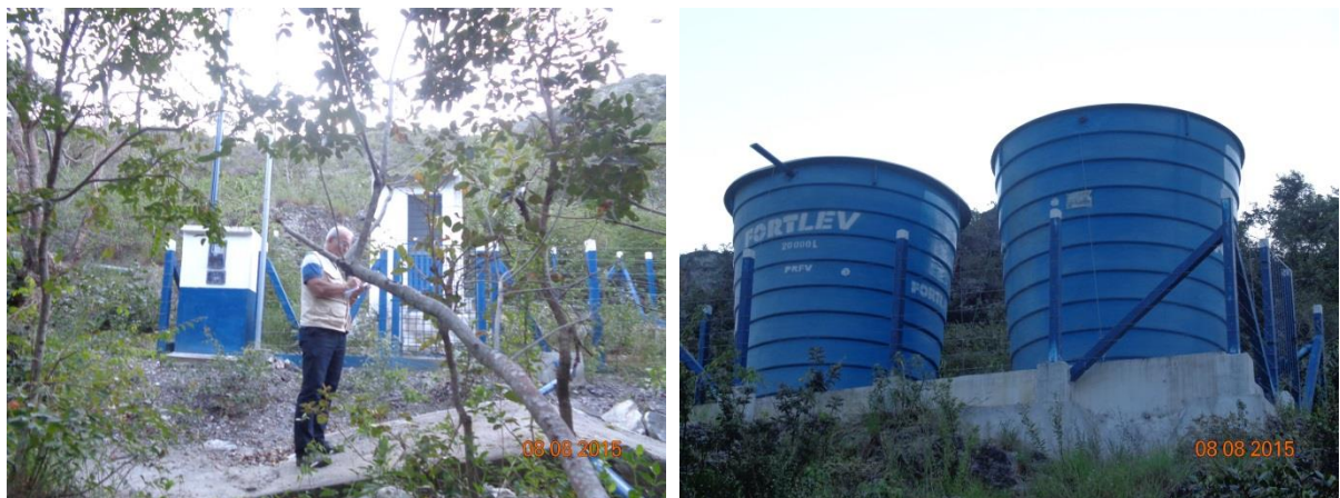
Figura 109 – EEAB e RAPs de 20 m 3
