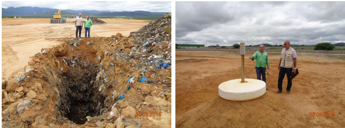
Figura 155 – Instalação dos drenos de gás e queimadores
