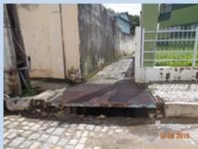
Rua J. J. Seabra onde existe uma galeria fechada
