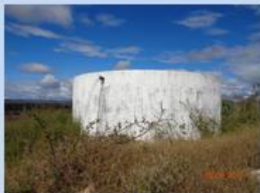
Reservatório (RAP), circular, de concreto, com capacidade aproximada de 150 m 3
