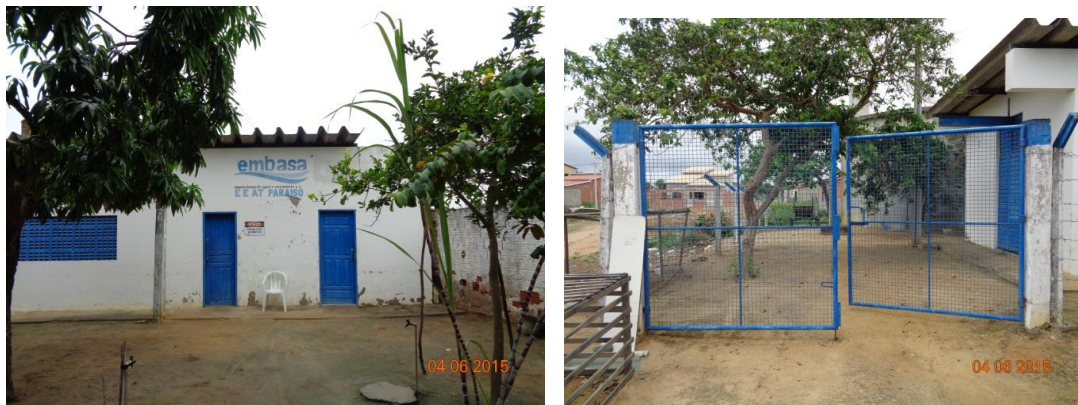
Figura 71 – EEAT localizada no povoado de Paraíso
