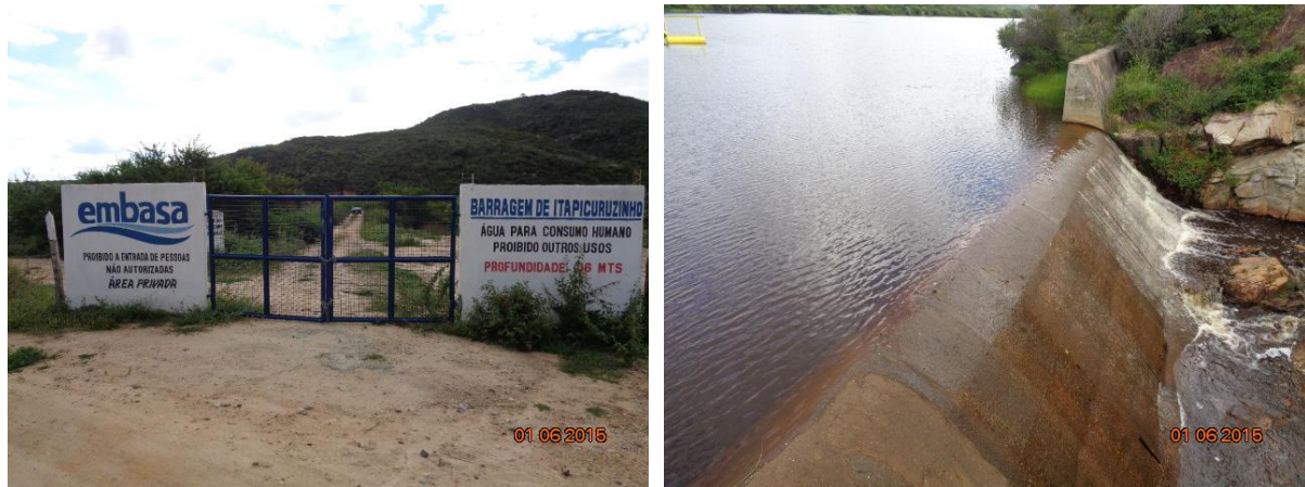
Figura 37 – Entrada da barragem e área do lago do Itapicuru
