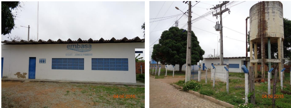
Figura 70 – EEAT localizada no distrito de Junco
