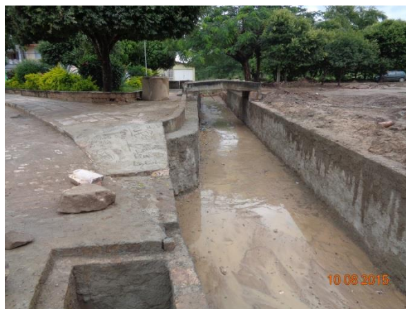
Figura 171 – Término da galeria e início do canal
