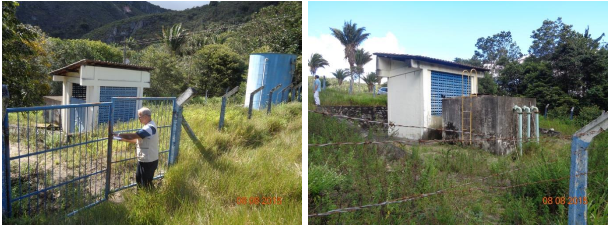
Figura 95 – Entrada do reservatório e EEAB
