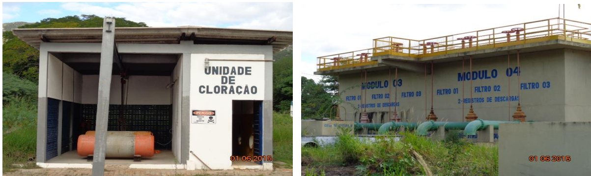
Figura 50 – ETA 2 – Unidade de Cloração e filtros
