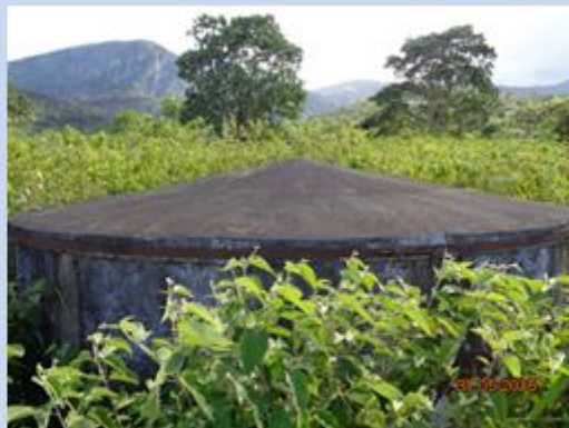
RAP 60 m 3 localizado em Itaitú Fonte: GERENTEC, 2015
