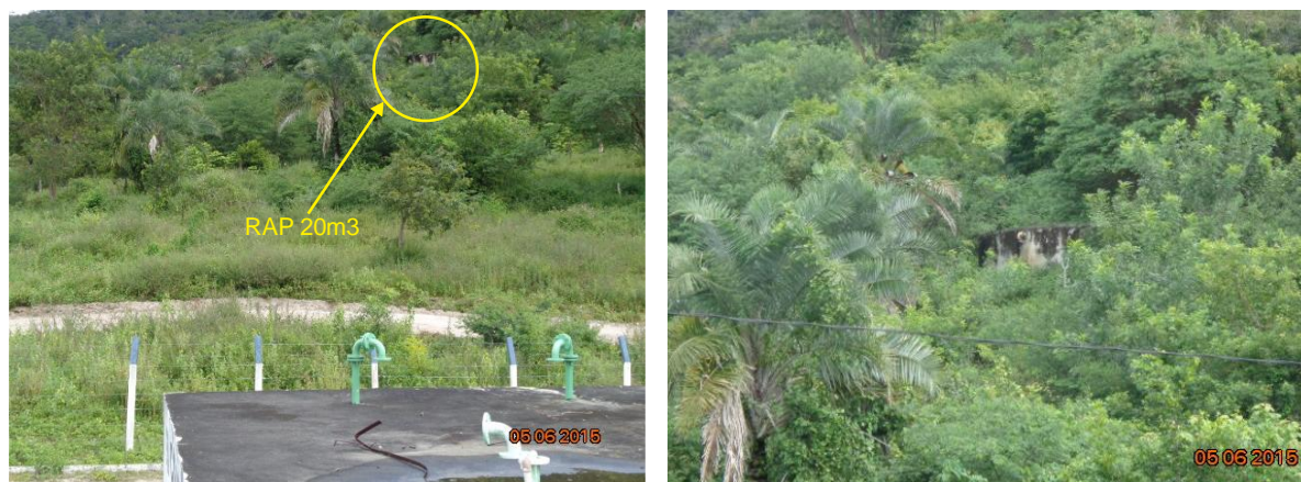
Figura 66 – Reservatório de 20 m 3 (visto da área da ETA)
