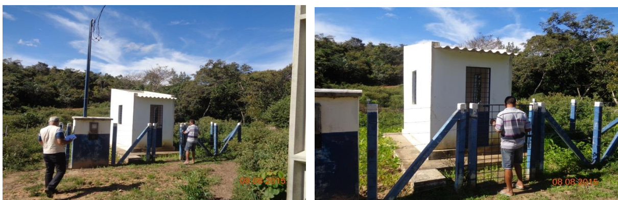
Figura 98 – Casa de força do poço artesiano
