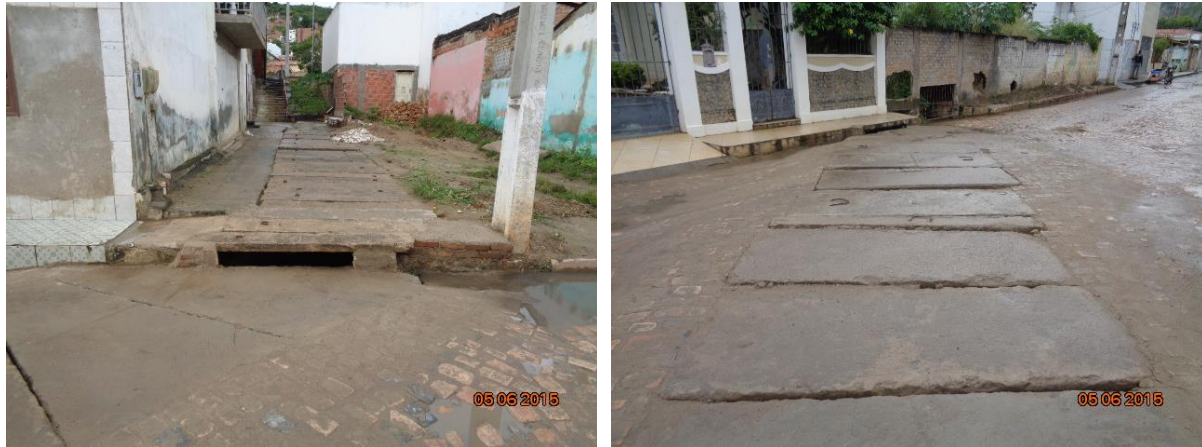
Figura 177 – Trechos do canal fechado do Bairro dos Índios
