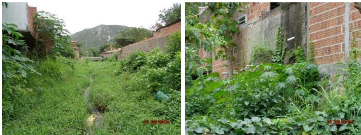
Figura 169 – Situação do Riacho Bananeira no perímetro urbano de Jacobina
