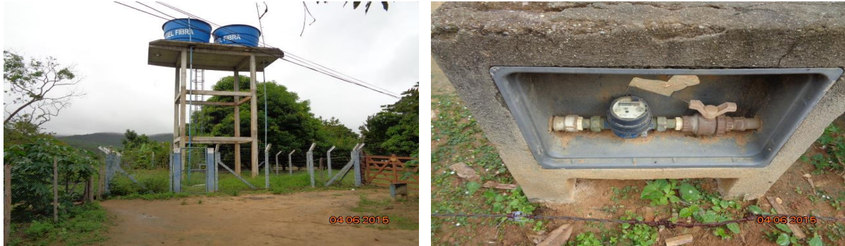
Figura 88 – Dois REL 10m 3 (cada) e hidrômetro no Povoado da Palmeirinha – Distrito de Itapeipu
