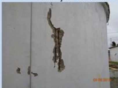
RAP 250 m 3 em Junco
