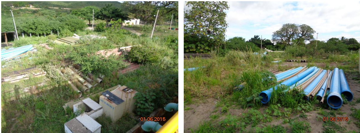
Figura 53 – ETA 2 – Materiais dispersos no terreno sem proteção
