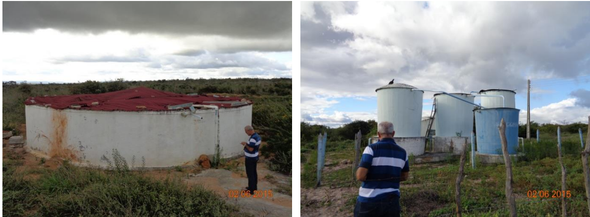
Figura 94 – RAP caixa de passagem e RAP de distribuição do SAA de Lajes do Batata
