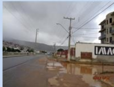
sinais de empçoamento
