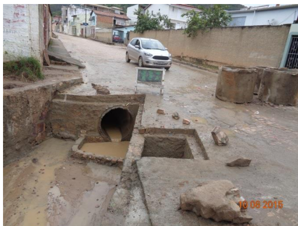
Figura 171 – Término da galeria e início do canal
