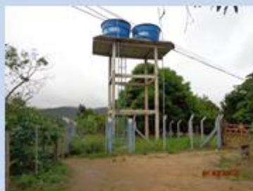
Dois REL 10m 3 (cada) e hidrômetro no Povoado da Palmeirinha – Distrito de Itapeipu.
