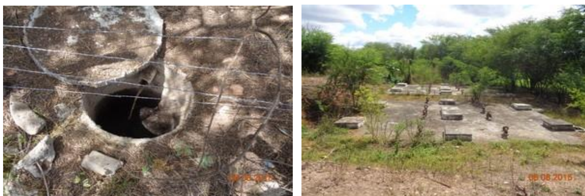
Figura 127 – Caixa de chegada do esgoto e vista da ETE
