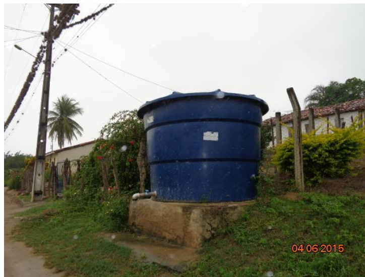
Figura 89 – RAP 5m 3 no Povoado da Várzea da Laje – Distrito de Itapeipu
