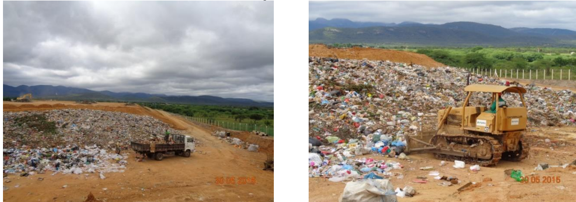
Figura 157 – Área do lixão que está recebendo os resíduos sólidos do município de Jacobina
