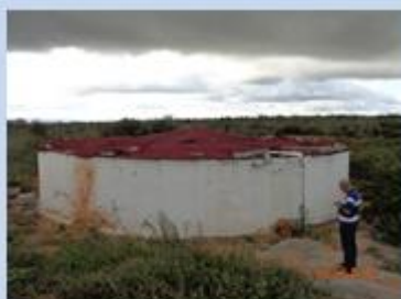
RAP caixa de passagem
