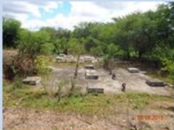
vista da ETE
