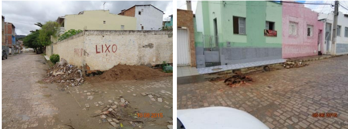
Figura 146 – Lançamento RCC na sede de Jacobina – Bairro dos Índios
