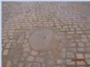
PV da rede coletora
