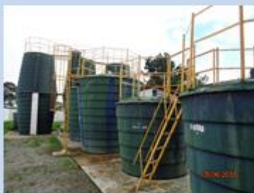
ETE condomínio Lagoa Dourada
