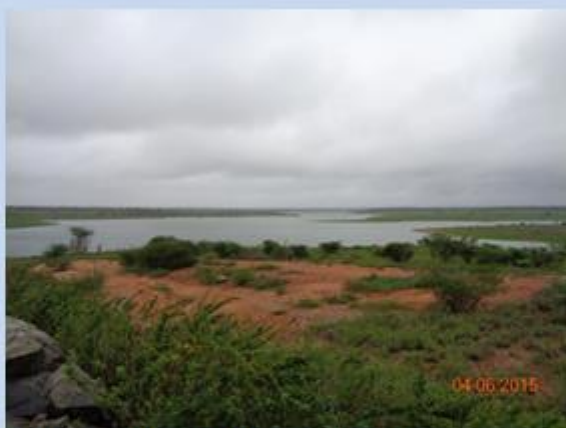
Lago da Barragem de S. J. do Jacuípe Fonte: GERENTEC, 2015
