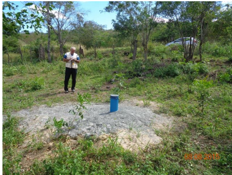
Figura 101 – Poço artesiano perfurado pela CERB no povoado de Araújo
