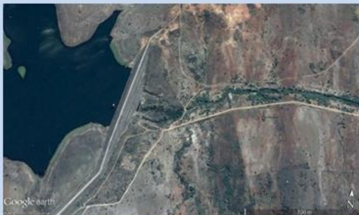
Vista da Barragem do Rio Jacuípe
