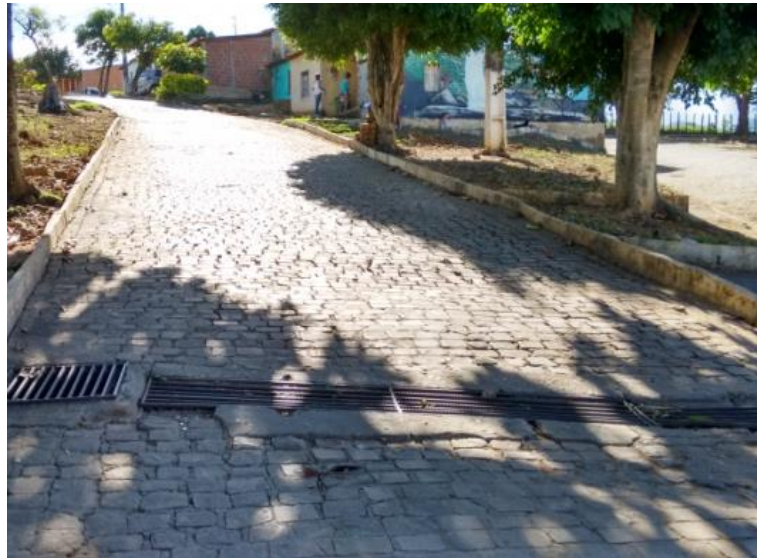
Figura 184 – Rua em paralelepípedo no distrito de Itaitu com presença de grelhas para coleta de águas pluviais
