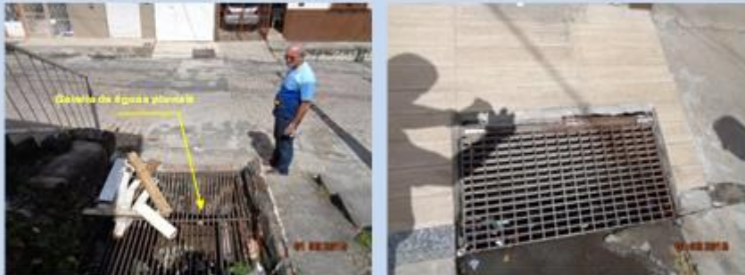
Detalhes da galeria e boca de lobo na calçada
