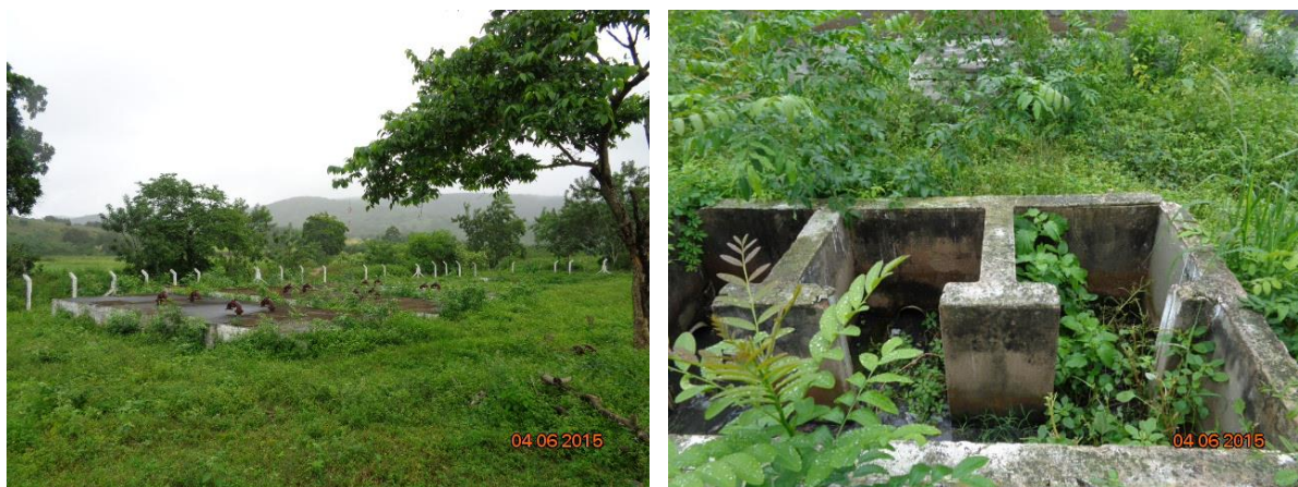
Figura 134 – Estrutura da ETE abandonada
