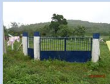
entrada da ETE
