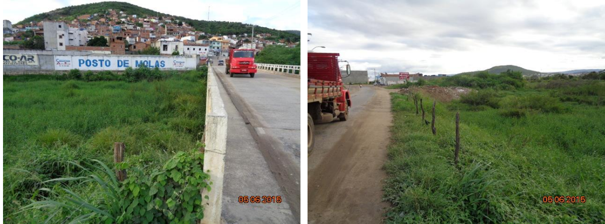
Figura 165 – Ponte sobre o Rio Itapicuru-mirim na sede de Jacobina – Avenida Paulo Souto
