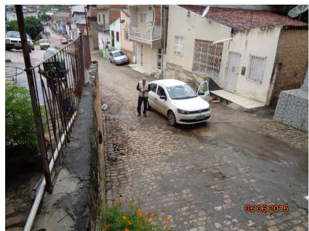
Figura 176 – Canal de drenagem elevado e capeado para evitar transbordamento para as ruas (à esquerda) e galeria fechada no Bairro dos Índios que capta as águas vindas da serra (à direita)
