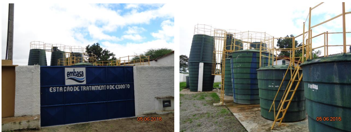
Figura 121 – Portão de entrada e sistema de tanques da ETE
