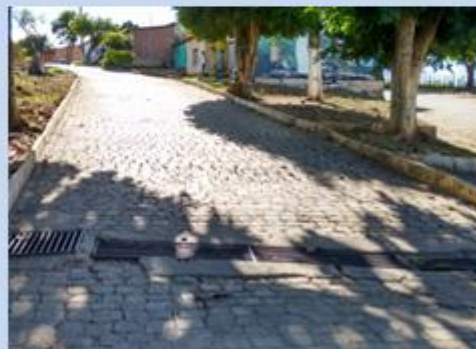
Rua em paralelepípedo no distrito de Itaitu com presença de grelhas para coleta de águas pluviais
