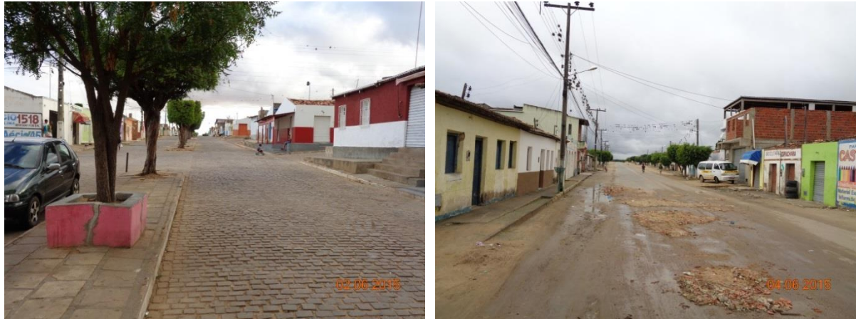
Figura 186 – Ausência de dispositivos de microdrenagem – à esquerda povoado de Lages do Batata e à direita povoado de Paraíso
