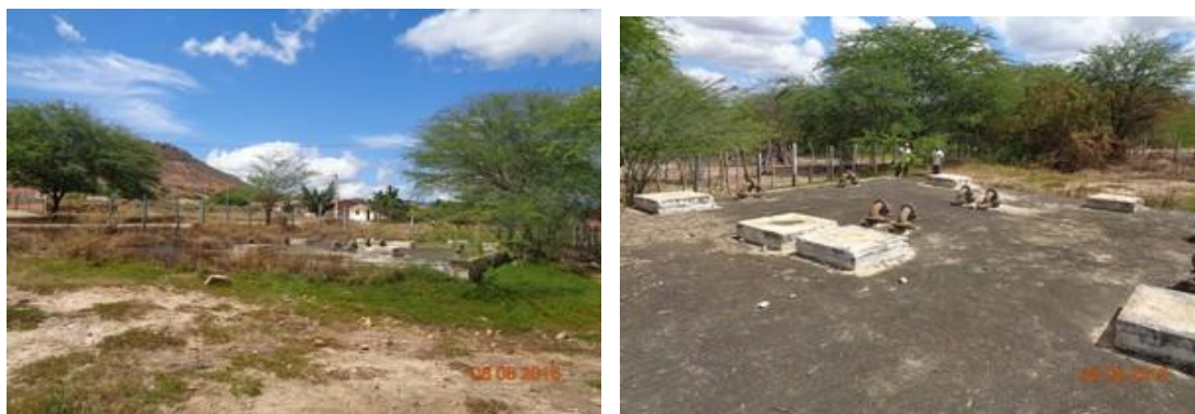
Figura 130 – Vista da ETE Olhos D'Água
