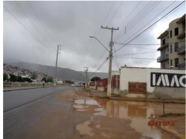
Figura 180 – Ruas na sede de Jacobina sem sistema de microdrenagem – à esquerda sinais de erosão causada pelo escoamento superficial das águas das chuvas e à direita empoçamento
