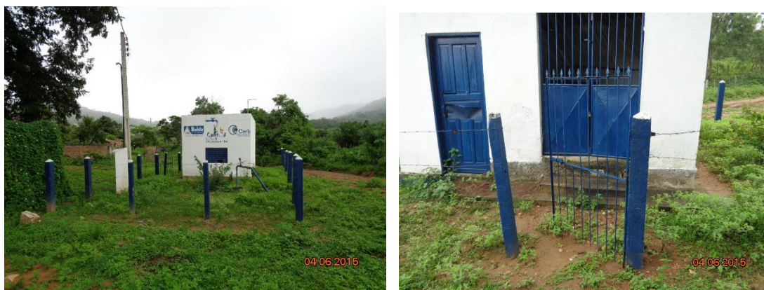
Figura 81 – Poço artesiano – Distrito de Itapeipú
