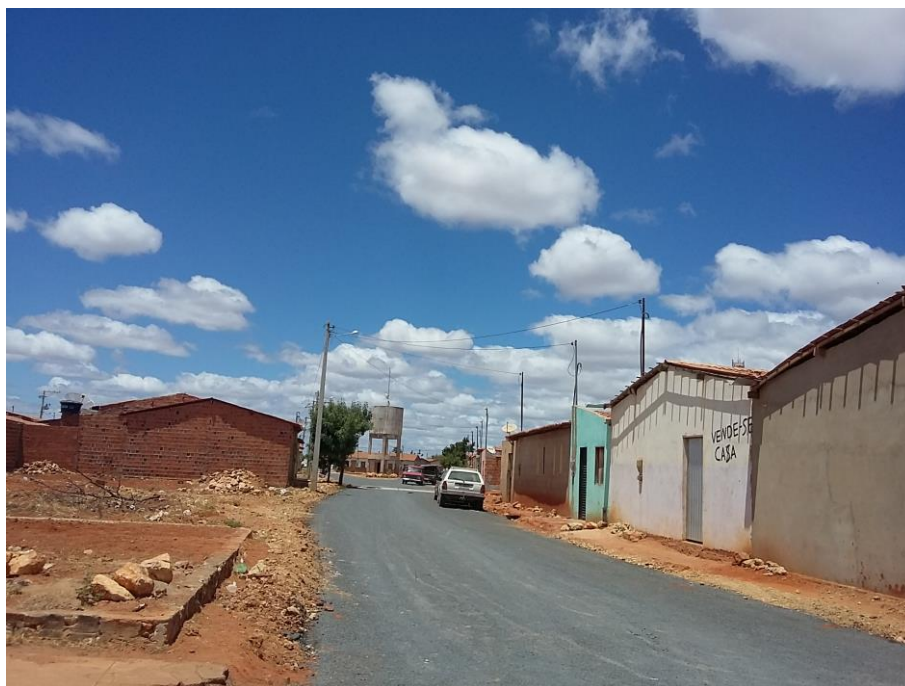
Figura 3.9 – Rua sem sistema de drenagem em Itaguaçu da Bahia.
