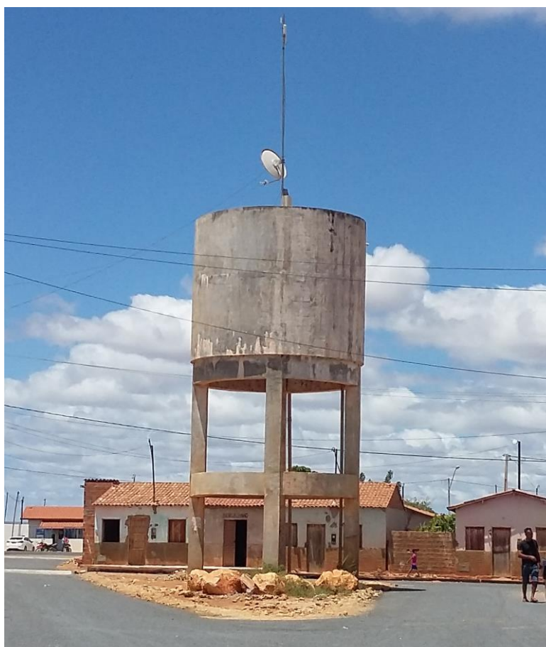
Figura 3.6 – Reservatório de água Município de Itaguacu da Bahia.
